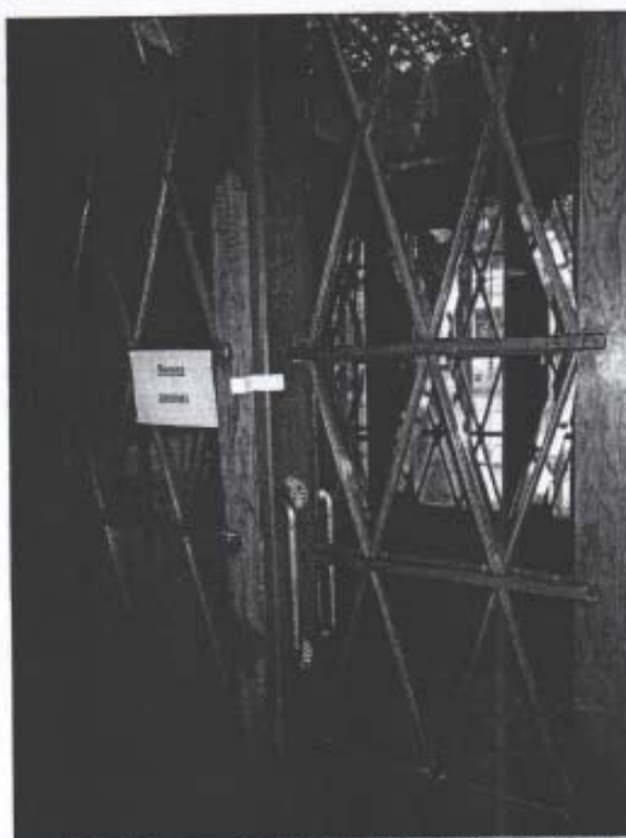
Входной тамбур пом. 9-Н. Съемка 17.07.2012. В.Ю. Белая
