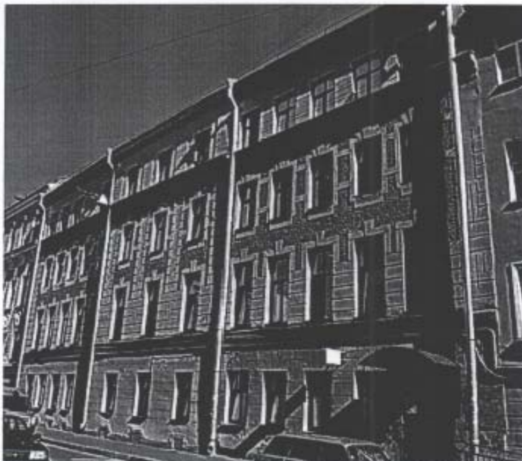
Лицевой фасад по Красноградскому пер. Общий вид. Съемка 17.07.2012. В.Ю.Белая
