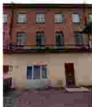
4. Вид на западный фасад.
