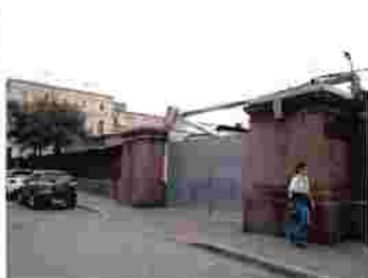
3. Вид на центральный воротный проезд.
