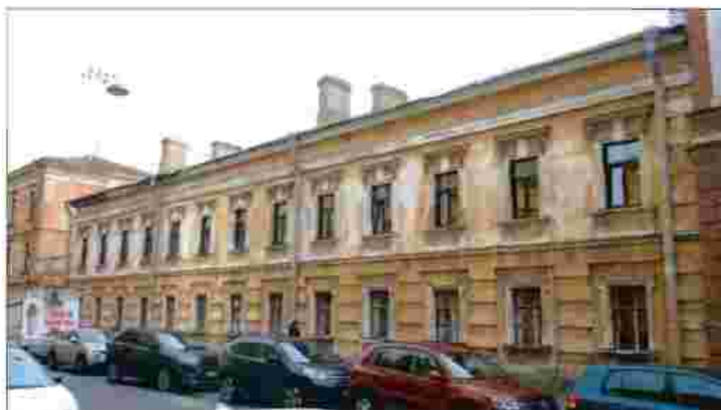
18. Объект культурного наследия. Лицевой фасад двухэтажного корпуса по ул. Почтамейской. Вид с запада.
