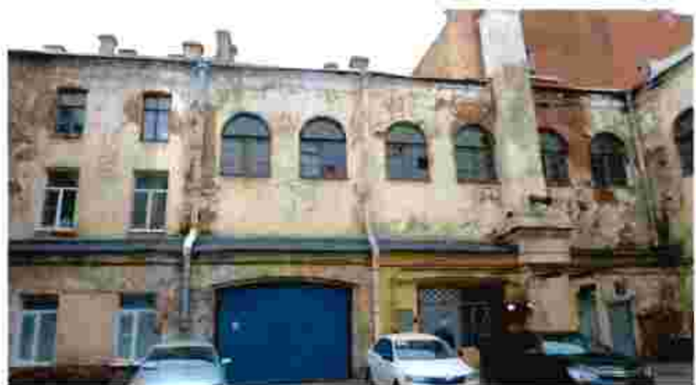
9. Юго-западный двор. Вид с севера.
