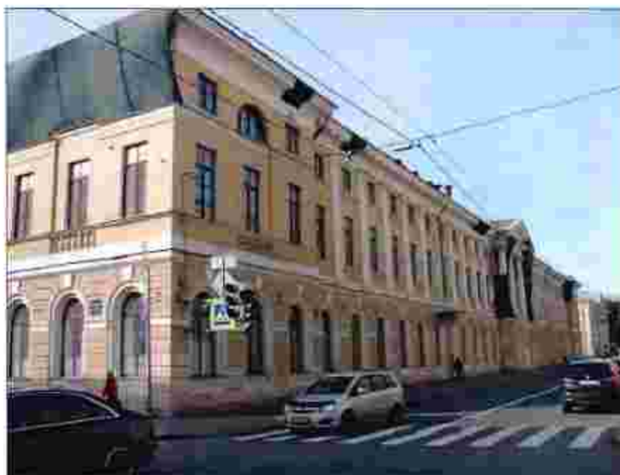
2. Восточный лицевой фасад. Вид с юго-востока.
