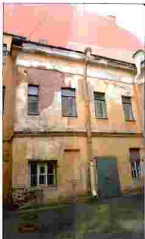
13. Западный фасад объекта культурного наследия, выходящий в северо-восточный двор.
