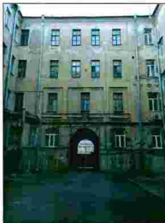
6. Северный дворовый фасад корпуса по ул. Якубовича.
