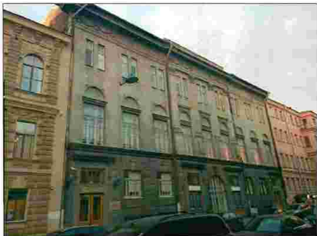
1. Общий вид с юга (литерной фасад по ул. Почтамтской).
