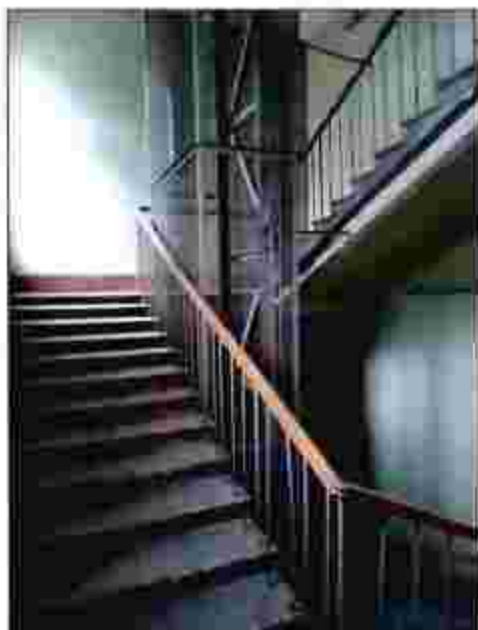
14. Лестница в западном корпусе по ул. Якубовича.
