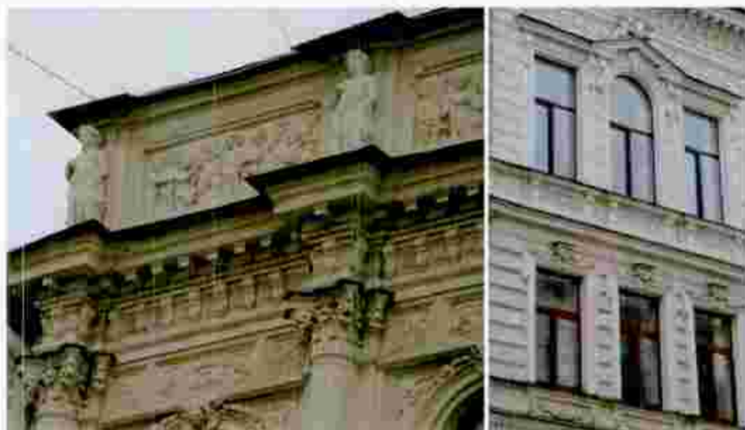
8. Общий вид на восточный дворовой фасад объекта культурного наследия. (01.02.2024 г.)
