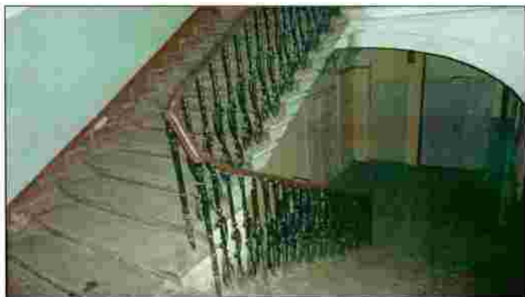
12. Лестница (5 ЛК). Корпус по ул. Якубовича.
