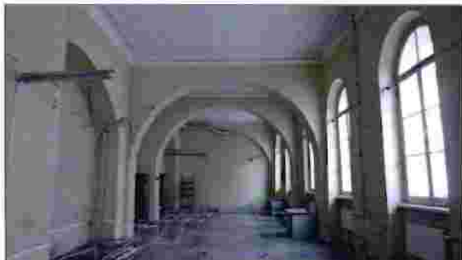
10. Перекрытие на арках. Первый этаж.
