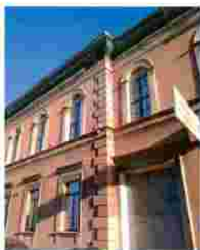
3. Фрагмент западного фасада. Воротный проем.
