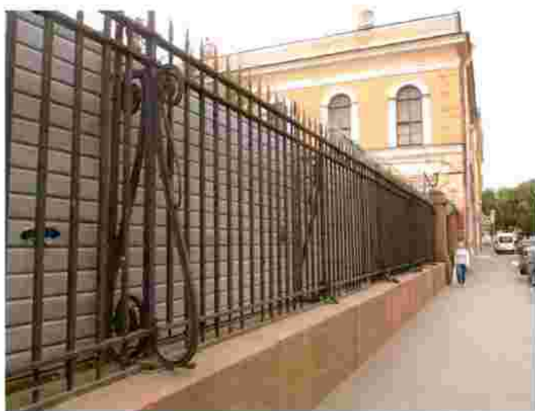
1. Вид на объект культурного наследия. Северный воротный проезд.
