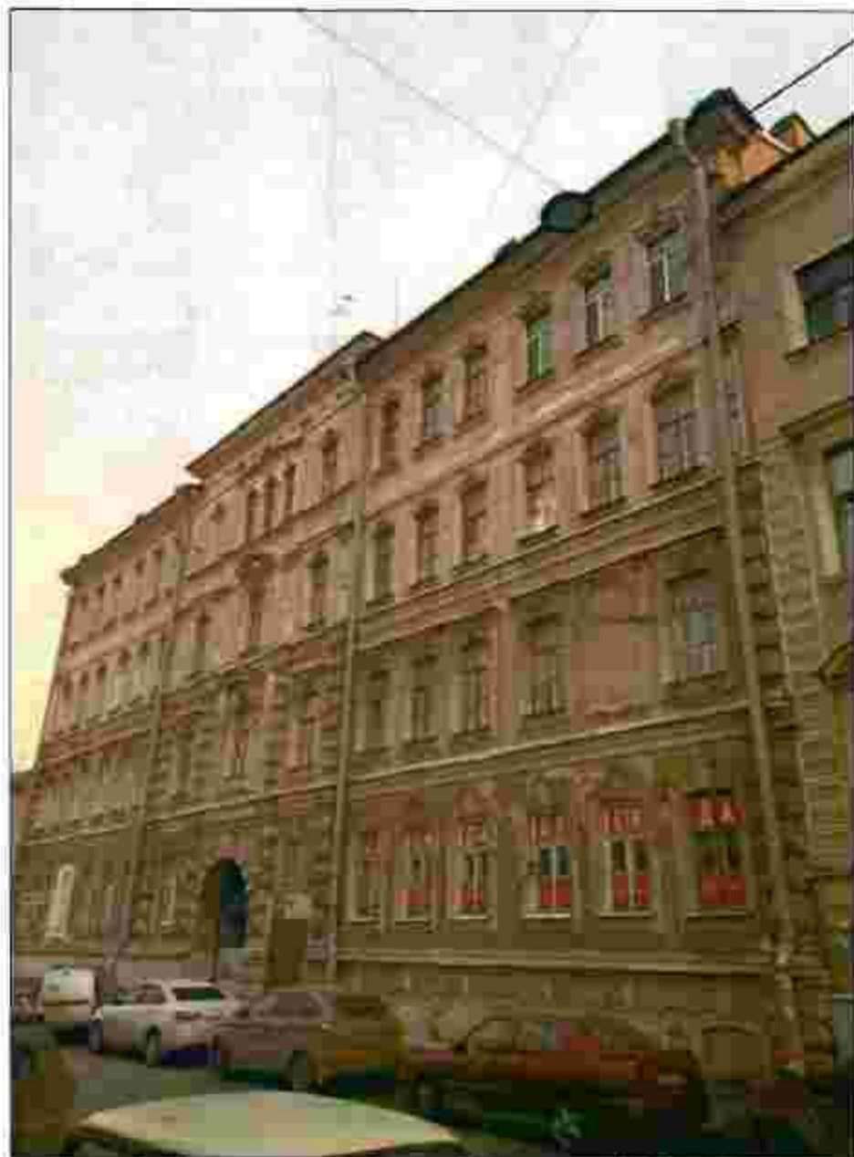
2. Общий вид с севера (лицевой фасад по ул. Якубовичи).
