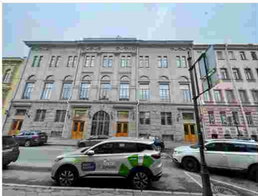
25. Вид на главный фасад объект культурного наследия регионального значения «Здание Управления городского телефона и телеграфа» по адресу: Почтамтская ул., 15; ул. Якубовича, 18;
