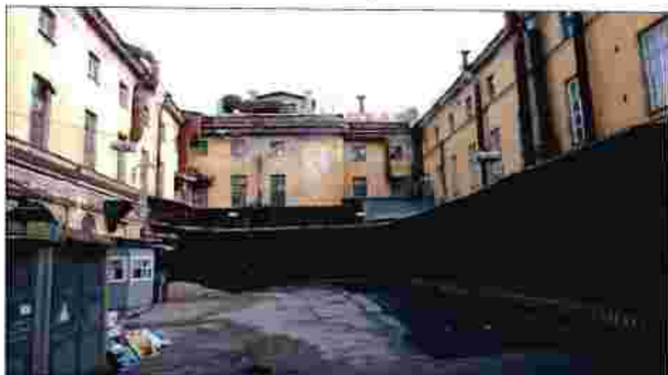
5. Дворовые фасады. Вид с запада.
