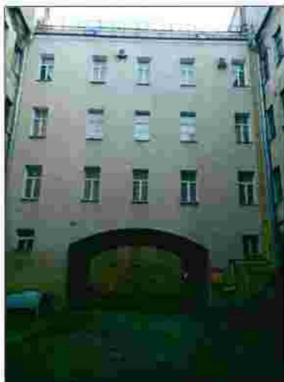
5. Поперечный дворовый корпус. Вид с северо-запада.
