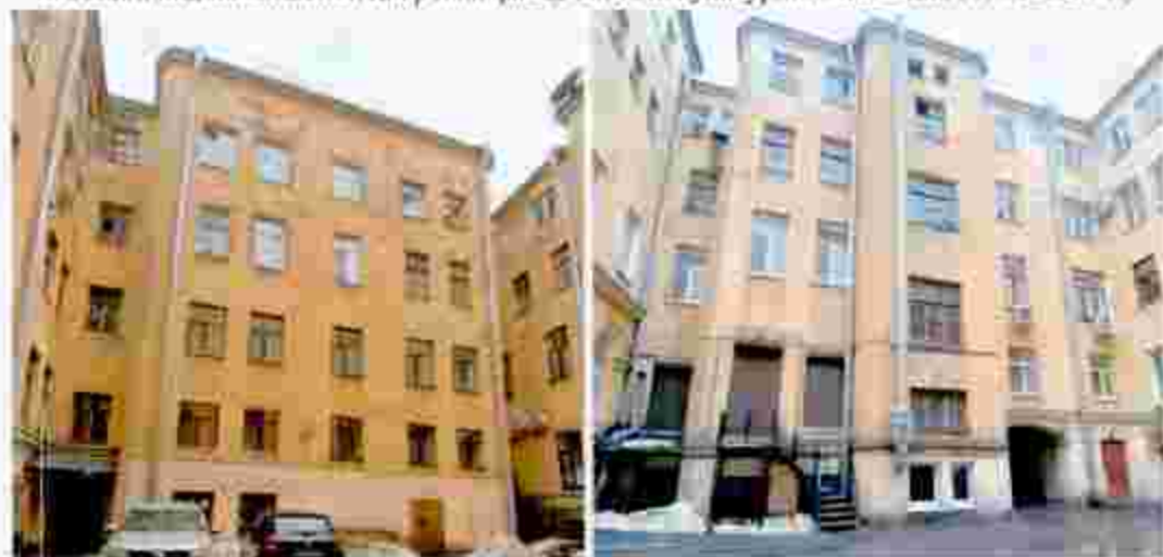
9. Общий вид на западный дворовой фасад объекта культурного наследия (01.02.2024 г.)
