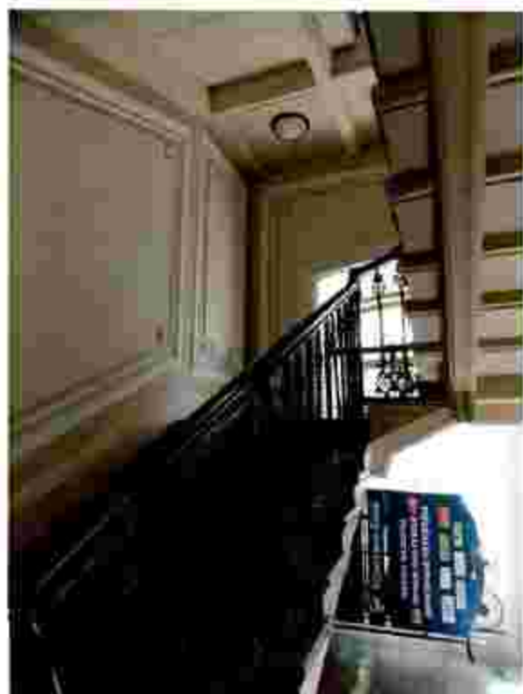
6. Парадная лестница. Помещение 8Н (37)
