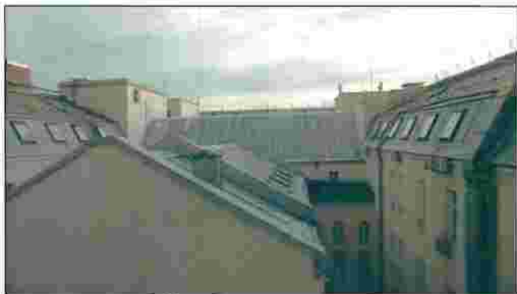
7. Кровля. Вид с северо-запада.
