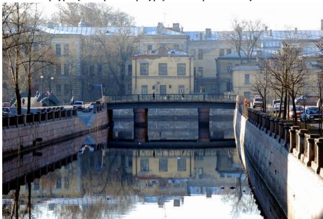
33. Вид с Крюкова кан. 2008 г. — Александровская больница в память 19 февраля 1861 г. - Психоневрологический диспансер (по наб. Фонтанки) // Citywalls.ru – архитектурный сайт Петербурга [Электронный ресурс]. URL: https://www.citywalls.ru/house2217.html .
