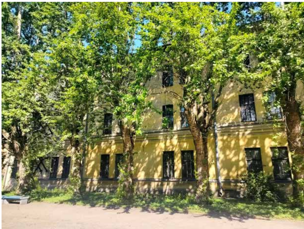
Фото 13. Фрагмент дворового фасада объекта культурного наследия регионального значения «Главное здание с 6 флигелями, два здания кухни и прачечной», входящего в состав объекта культурного наследия регионального значения «Александровская больница для рабочего населения в память 19-го февраля 1861 г. Комплекс с территорией, садом, оградами и постаментом от несохранившегося бюста имп. Александра II»
