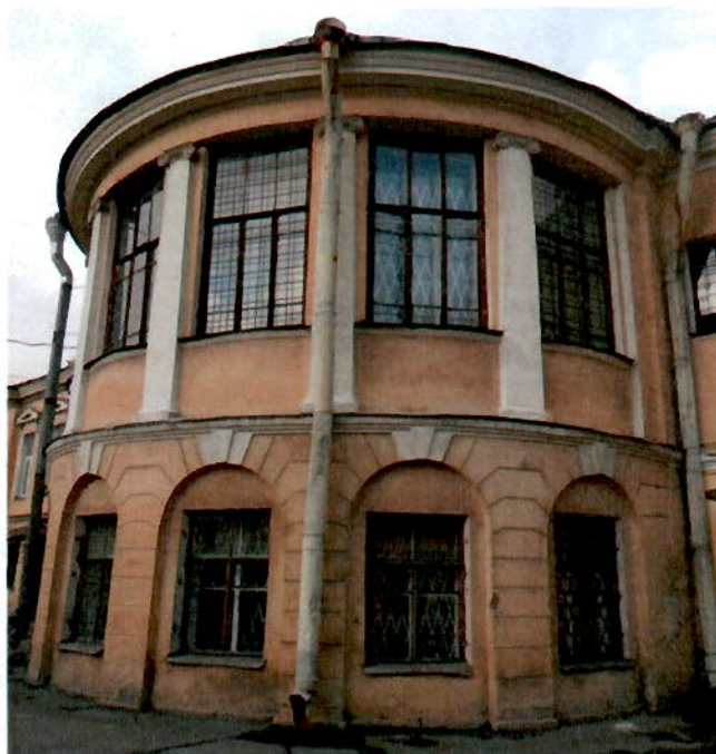
9. Фрагмент южного лицевого фасада здания.
