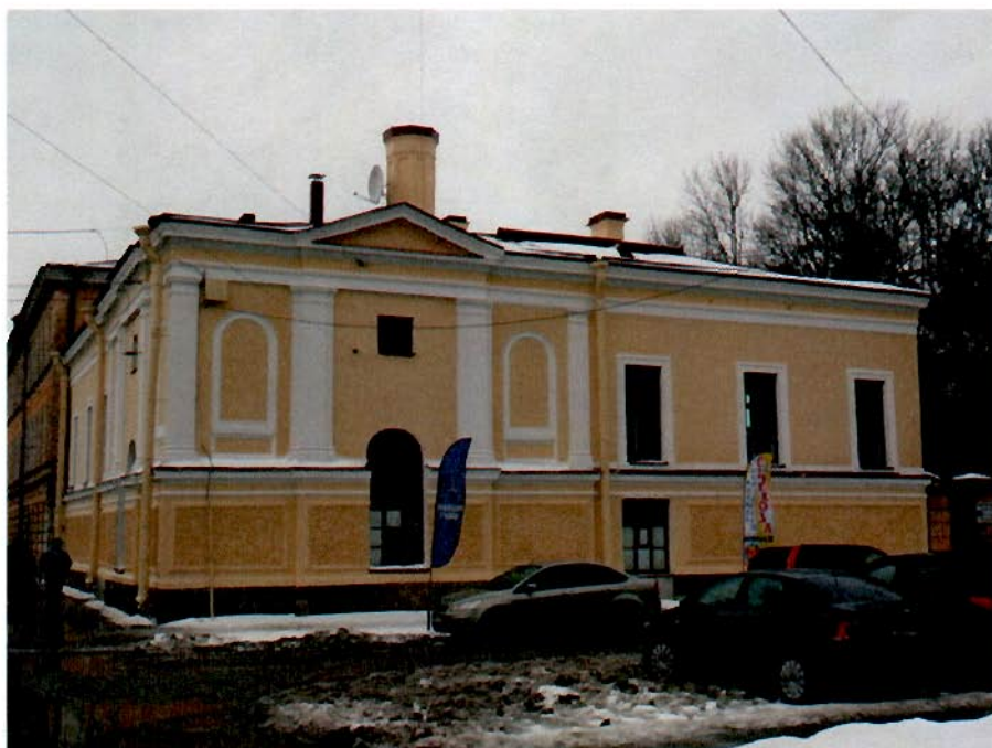
14. Восточный лицевой фасад здания.
