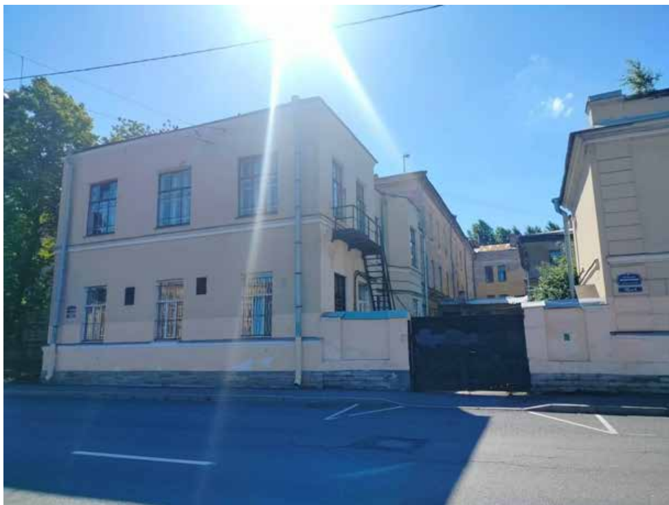
Фото 5. Фрагмент лицевого фасада объекта культурного наследия регионального значения «Главное здание с 6 флигелями, два здания кухни и прачечной», входящего в состав объекта культурного наследия регионального значения «Александровская больница для рабочего населения в память 19-го февраля 1861 г. Комплекс с территорией, садом, оградами и постаментом от несохранившегося бюста имп. Александра II»
