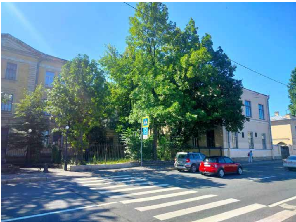
Фото 3. Фрагмент лицевого фасада объекта культурного наследия регионального значения «Главное здание с 6 флигелями, два здания кухни и прачечной», входящего в состав объекта культурного наследия регионального значения «Александровская больница для рабочего населения в память 19-го февраля 1861 г. Комплекс с территорией, садом, оградами и постаментом от несохранившегося бюста имп. Александра II»
