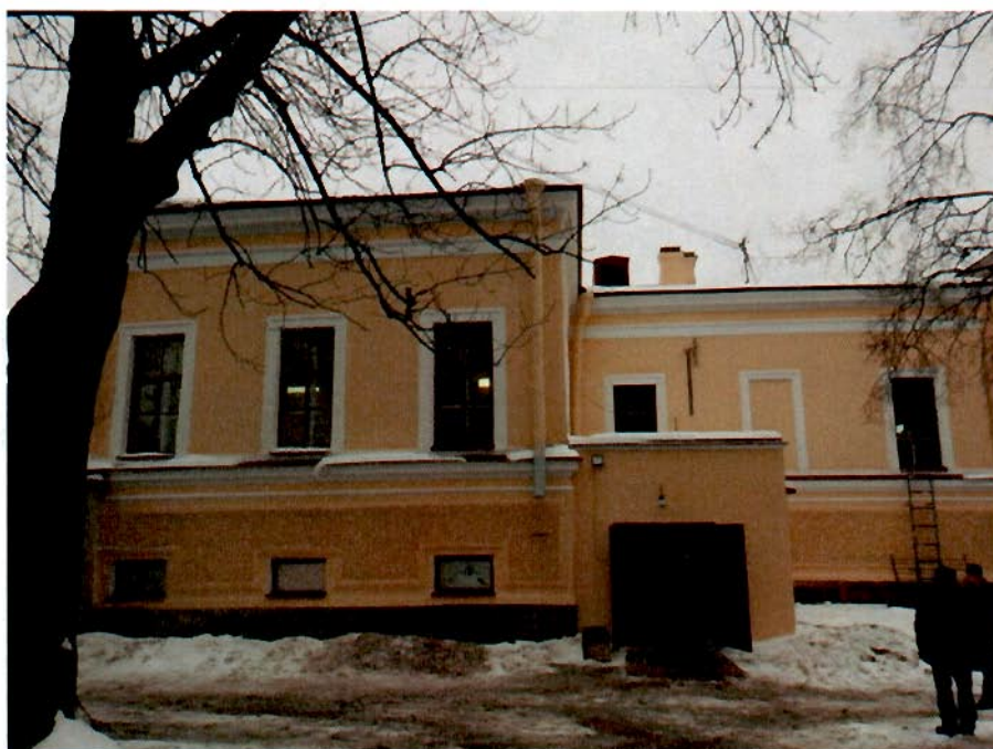
15. Северный дворовый фасад здания.
