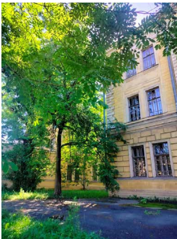
Фото 2. Фрагмент лицевого фасада объекта культурного наследия регионального значения «Главное здание с 6 флигелями, два здания кухни и прачечной», входящего в состав объекта культурного наследия регионального значения «Александровская больница для рабочего населения в память 19-го февраля 1861 г. Комплекс с территорией, садом, оградами и постаментом от несохранившегося бюста имп. Александра II»
