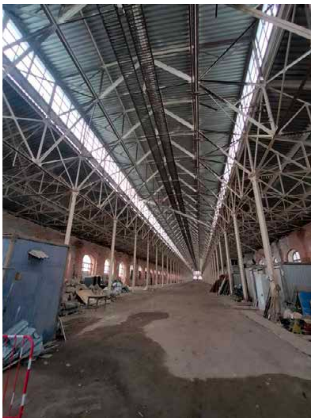
Фото 3. Интерьер объекта культурного наследия регионального значения «Сарай для императорских поездов Варшавского вокзала»
