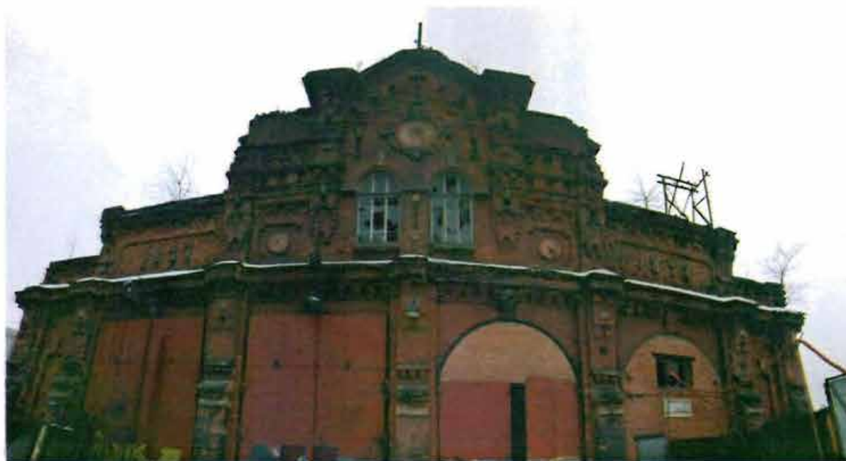
2. Северо-западный торцевой фасад.
