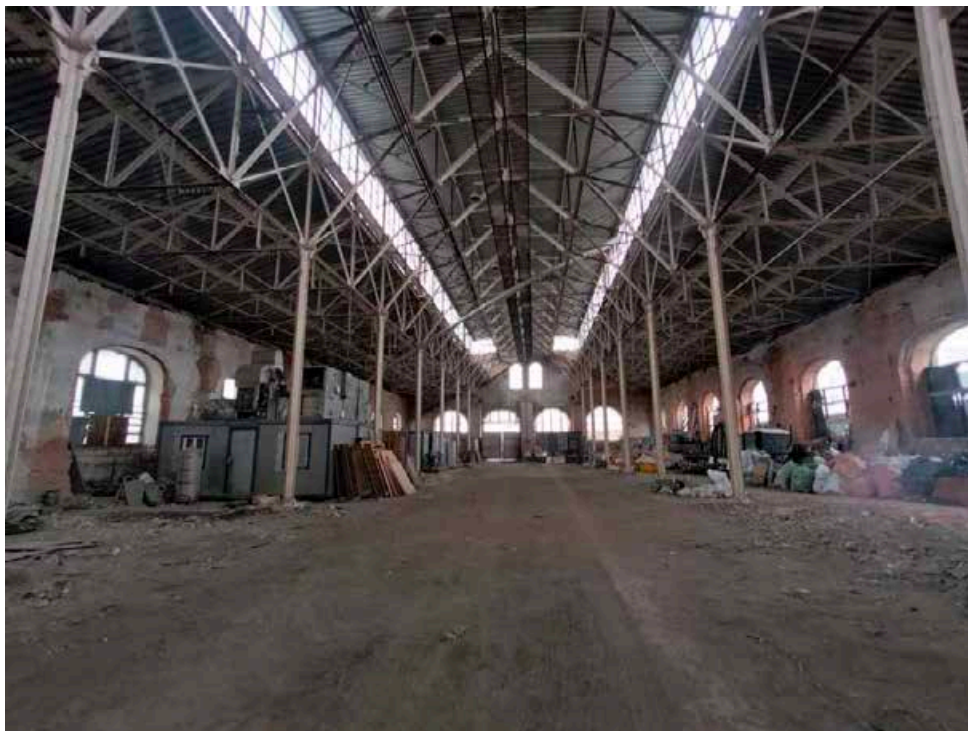
Фото 5. Интерьер объекта культурного наследия регионального значения «Сарай для императорских поездов Варшавского вокзала»
