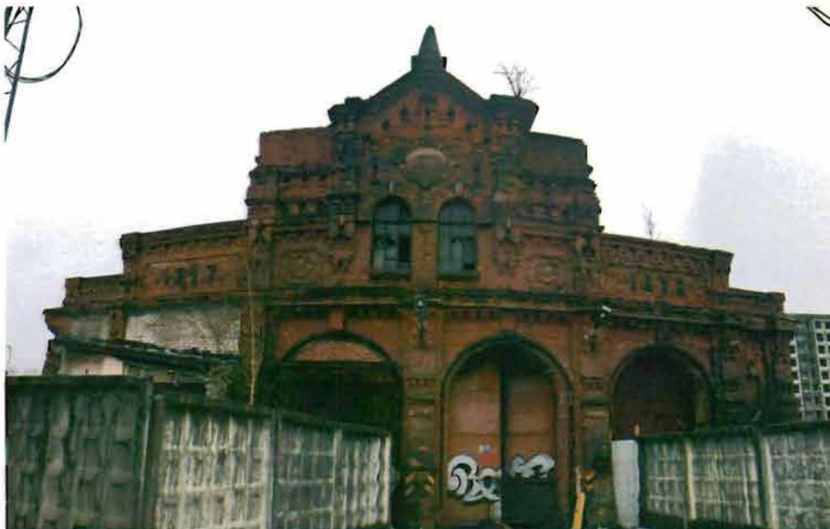
1. Юго-восточный торцевой фасад.
