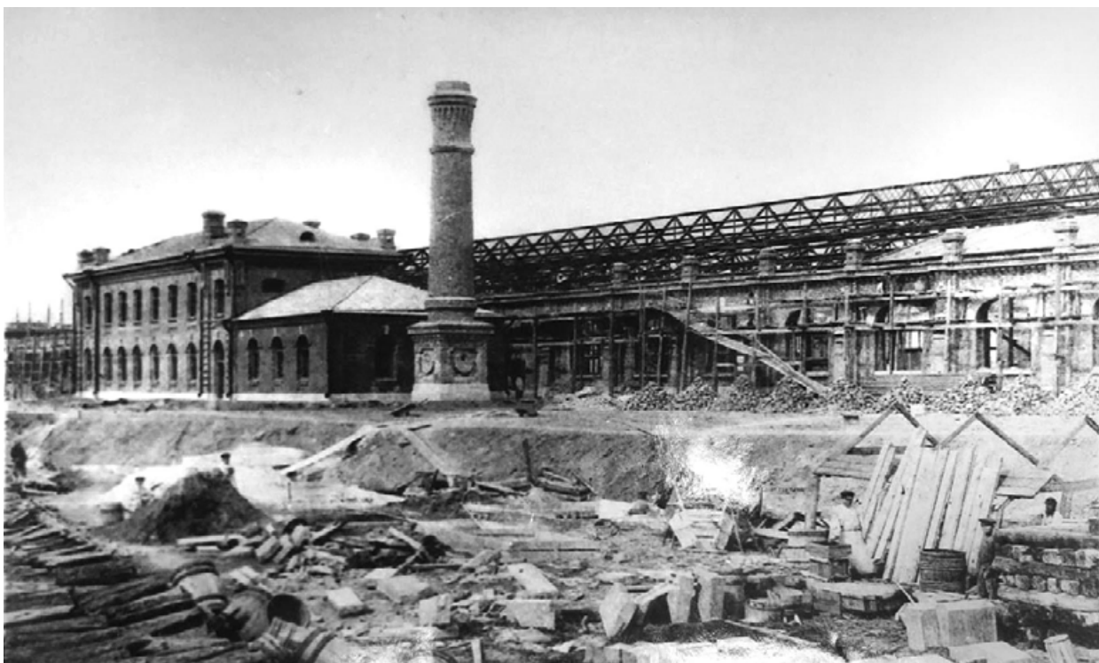
21. «Общий вид сарая для Императорских поездов и пристройки к нему. Приготовление цементно-бетонных облицовочных камней». 1897-1898 гг. // Акт по результатам государственной историко-культурной экспертизы... 2013 г. Приложение № 2, илл. 32.
