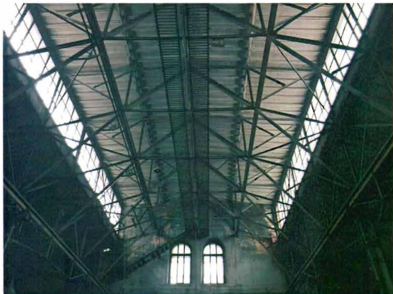
6. Металлические фермы перекрытия.
