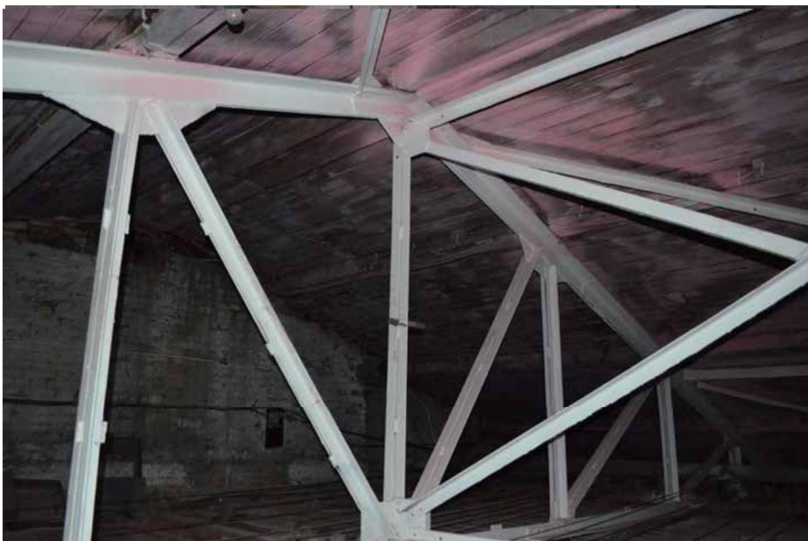
Фото 4. Объект культурного наследия федерального значения «Казармы с конюшнями», входящего в состав «Казармы лейб-гвардии конного полка» (г. Санкт-Петербург, Большая Морская ул., 67; Труда ул., 8-10; Якубовича ул., 26; Конногвардейский пер., 3-5). Чердачное пространство. Дата съемки:01.03.2024
