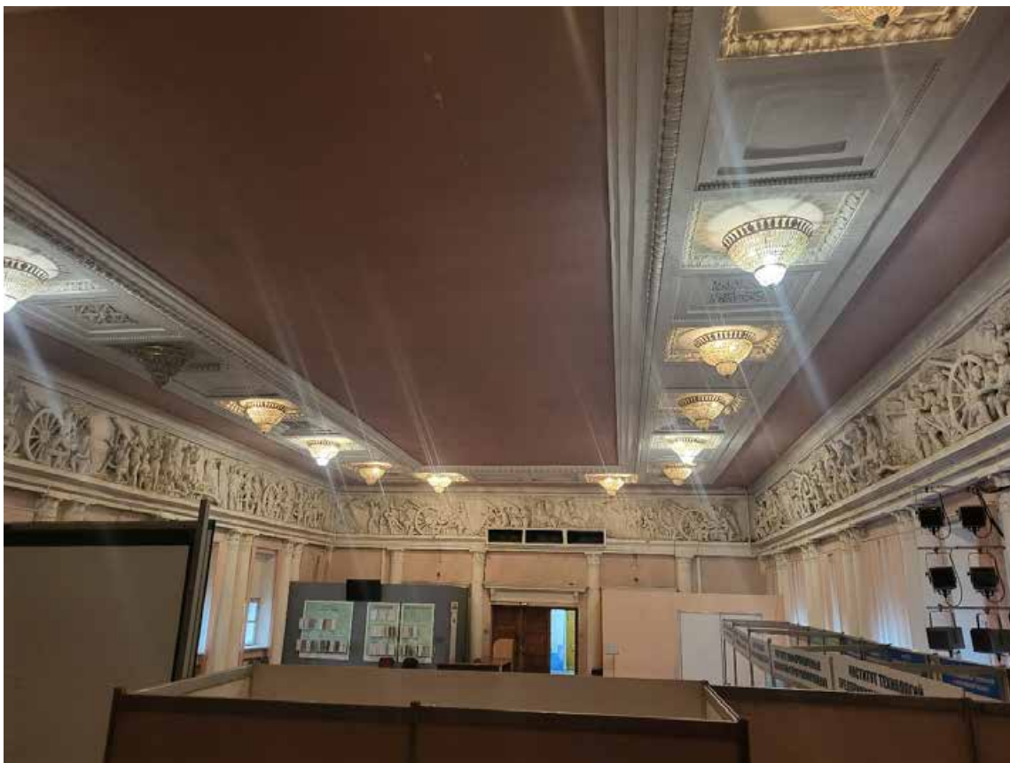
Фото 4. Объект культурного наследия федерального значения «Казармы с конюшнями», входящего в состав «Казармы лейб-гвардии конного полка» (г. Санкт-Петербург, Большая Морская ул., 67; Труда ул., 8-10; Якубовича ул., 26; Конногвардейский пер., 3-5). Актовый зал.
