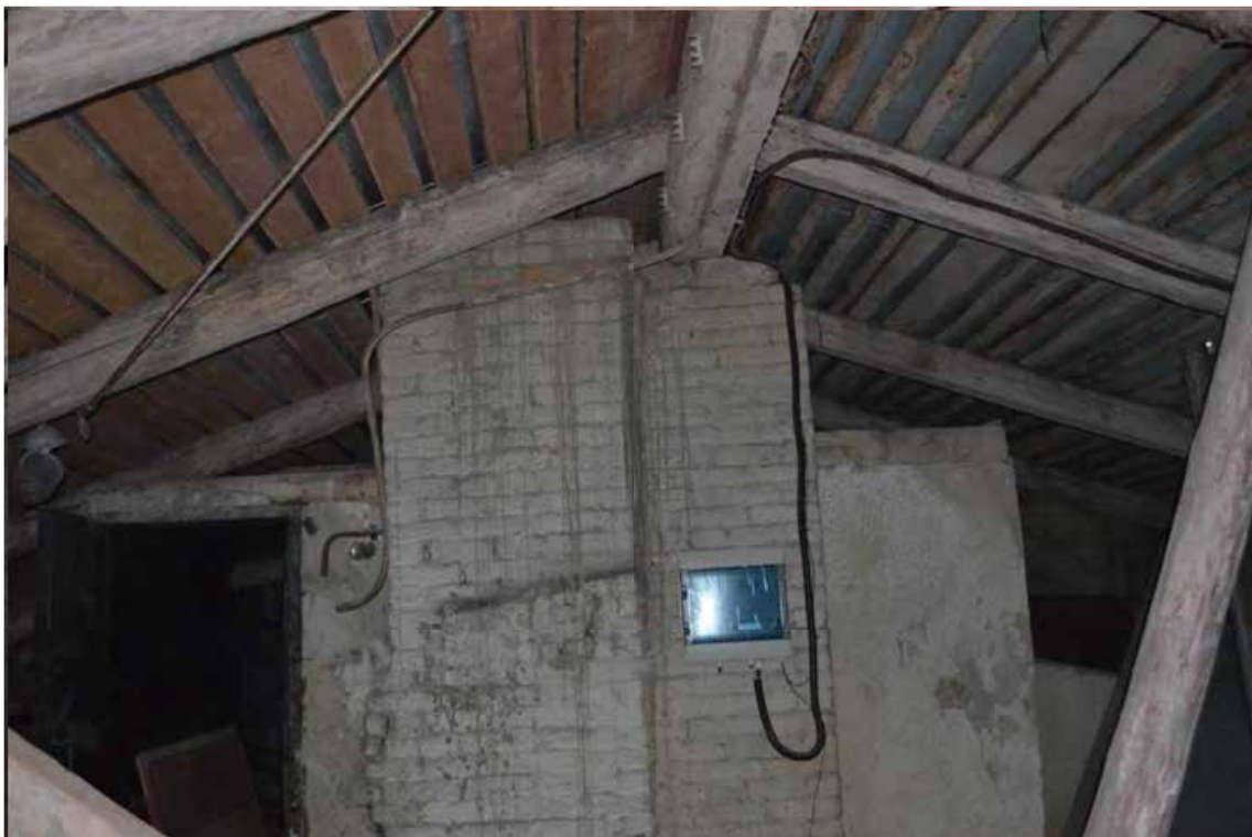
Фото 3. Объект культурного наследия федерального значения «Казармы с конюшнями», входящего в состав «Казармы лейб-гвардии конного полка» (г. Санкт-Петербург, Большая Морская ул., 67; Труда ул., 8-10; Якубовича ул., 26; Конногвардейский пер., 3-5). Чердачное пространство. Дата съемки:01.03.2024
