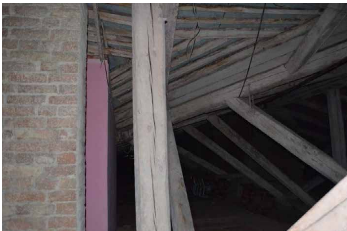
Фото 2. Объект культурного наследия федерального значения «Казармы с конюшнями», входящего в состав «Казармы лейб-гвардии конного полка» (г. Санкт-Петербург, Большая Морская ул., 67; Труда ул., 8-10; Якубовича ул., 26; Конногвардейский пер., 3-5). Чердачное пространство. Дата съемки:01.03.2024
