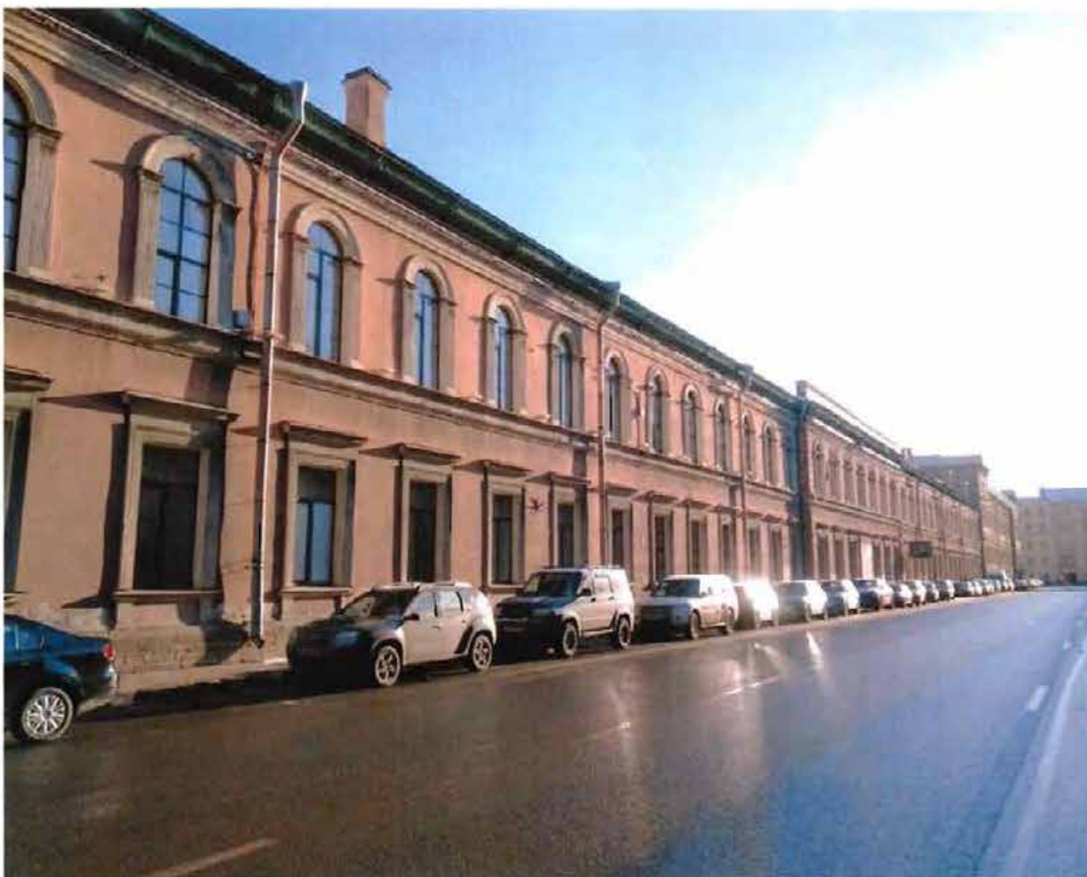
1. Вид на западный (лицевой) фасад объекта культурного наследия.
