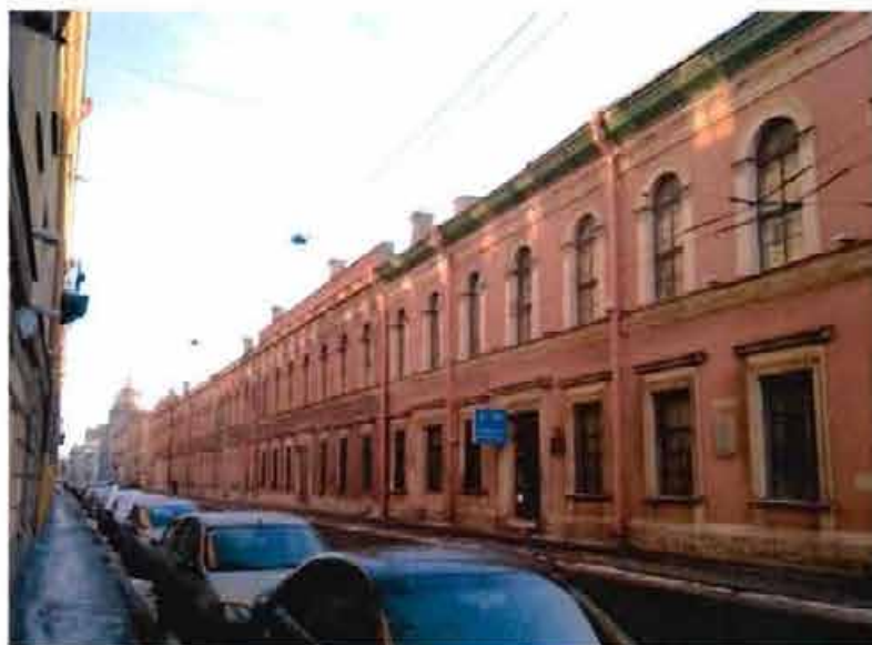
2. Вид на северный (лицевой) фасад объекта культурного наследия.
