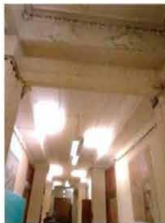
8. Помещение 1-го этажа.
