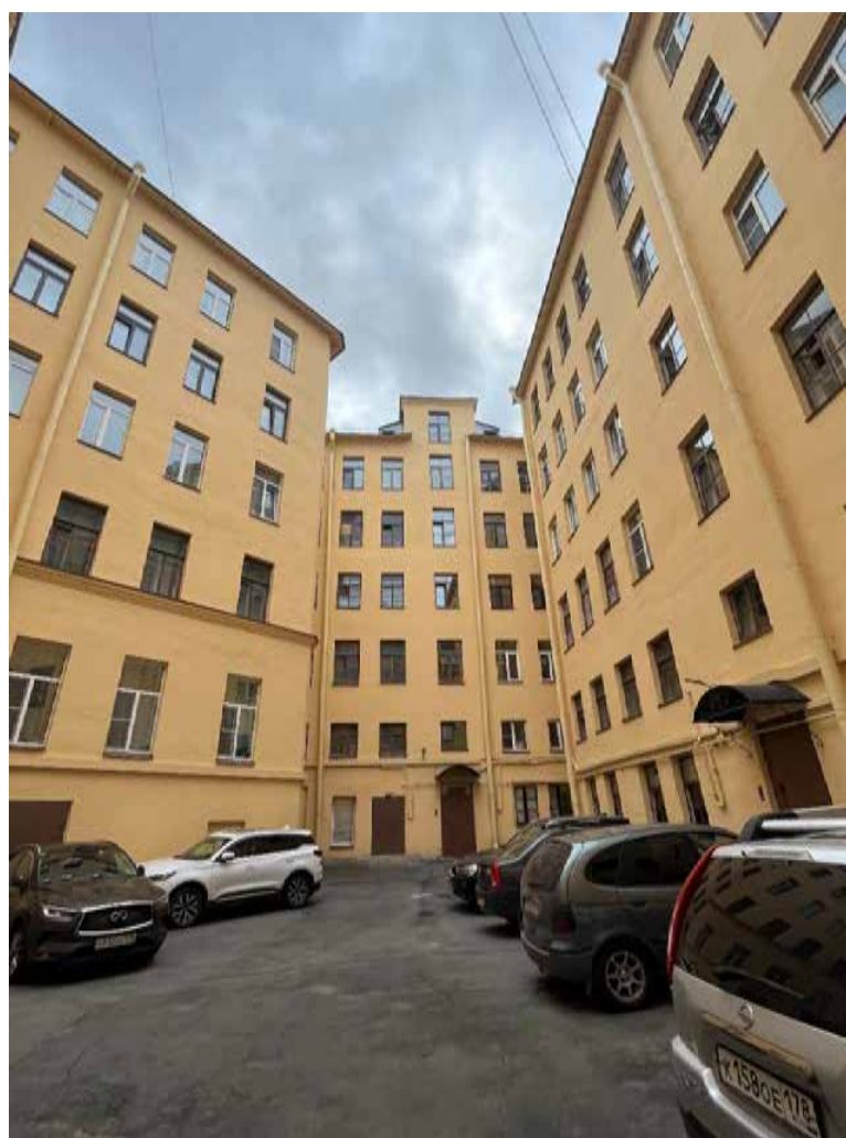
Фото №5. Восточный и северо-восточный дворовые фасады, общий вид.
