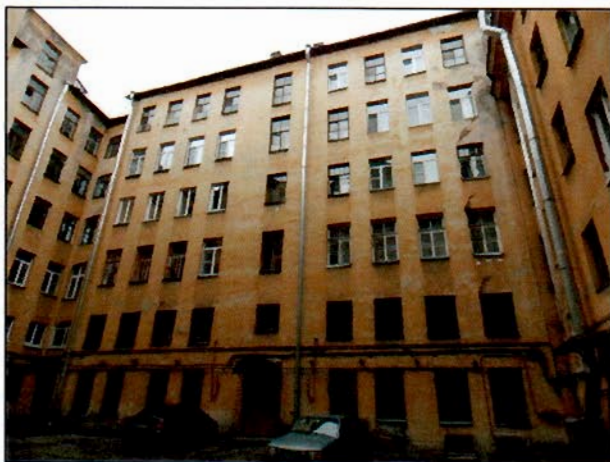
Фото 14. Южный дворовый фасад
