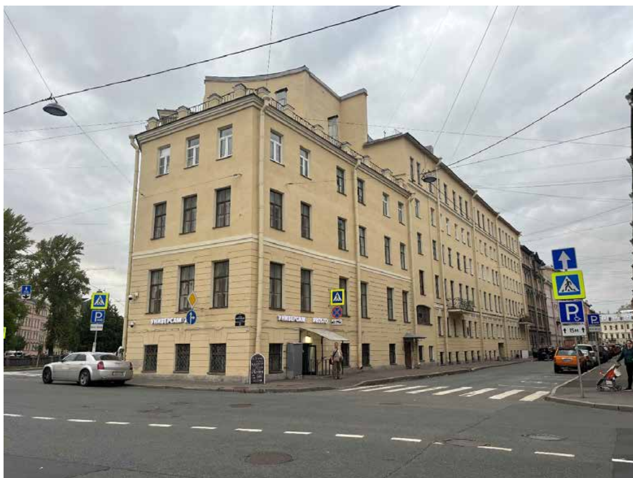
Фото №1. Восточный лицевой фасад, общий вид.
