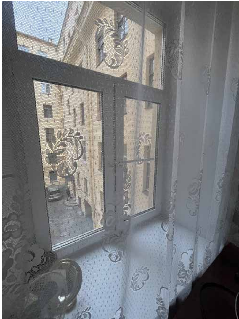
Фото №16. Квартира №49, пом. №5, оконное заполнение.
