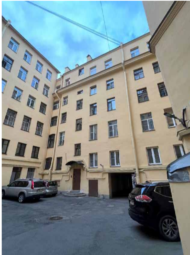
Фото №4. Западный дворовый фасад, общий вид.
