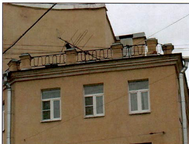
Фото 5. Фрагмент южного фасада.
