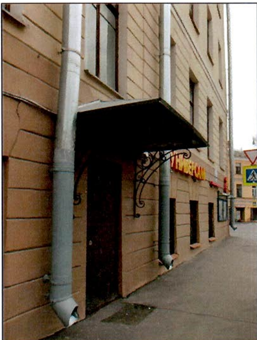
Фото 10. Вход со стороны юго-западного фасада (пом. 4-Н).
