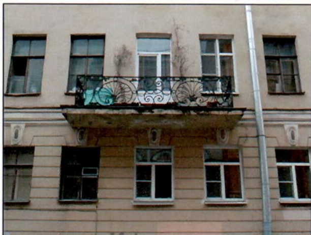
Фото 4. Фрагмент восточного фасада.
