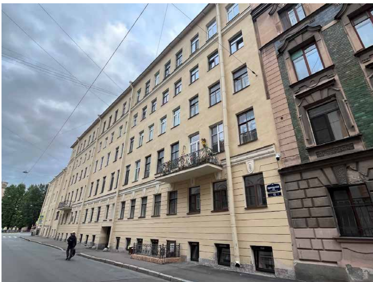
Фото №3. Восточный лицевой фасад, общий вид.
