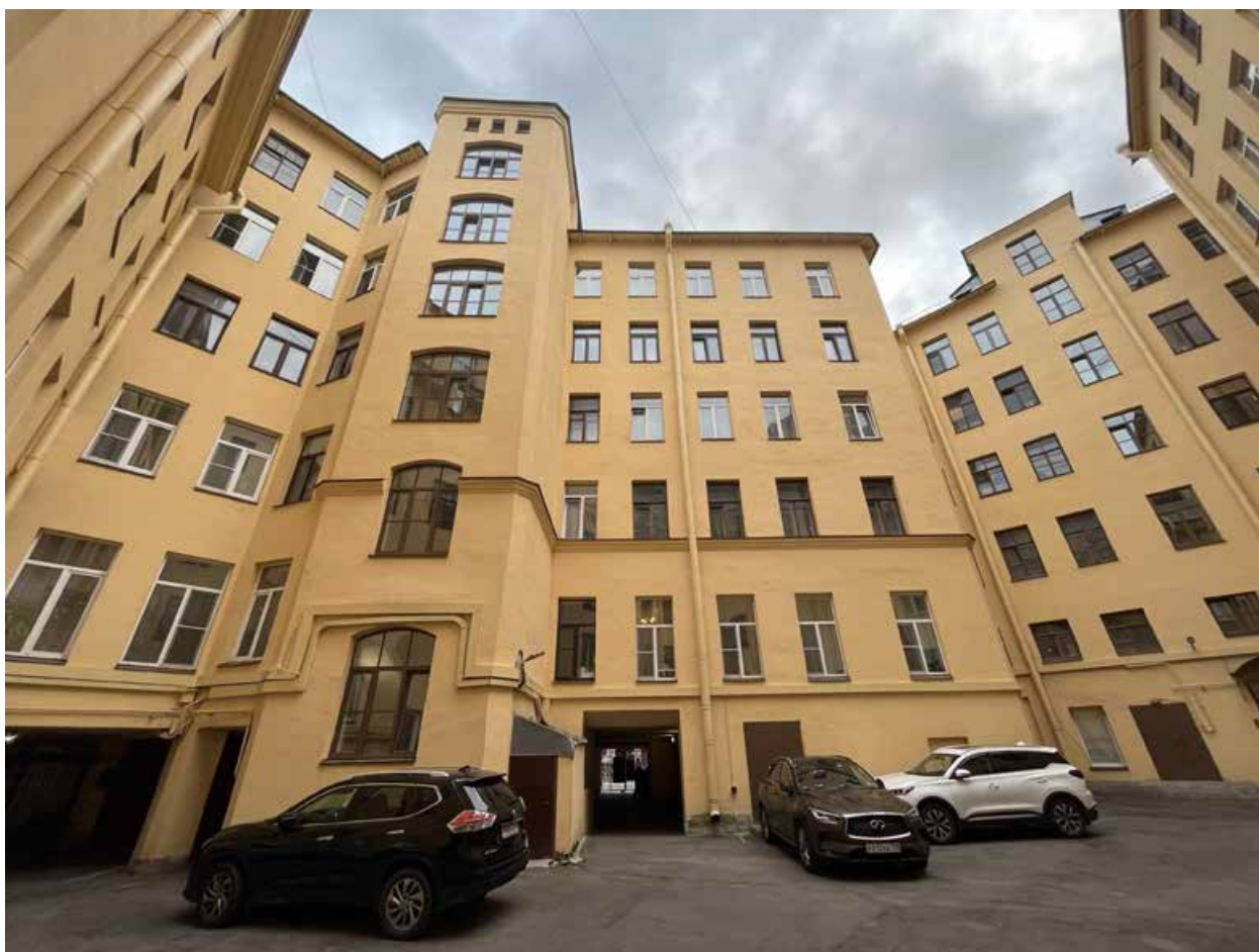
Фото №6. Восточный и северо-восточный дворовые фасады, общий вид.
