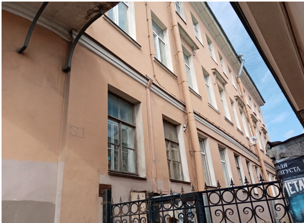
Фото 2. Общий вид объекта.
