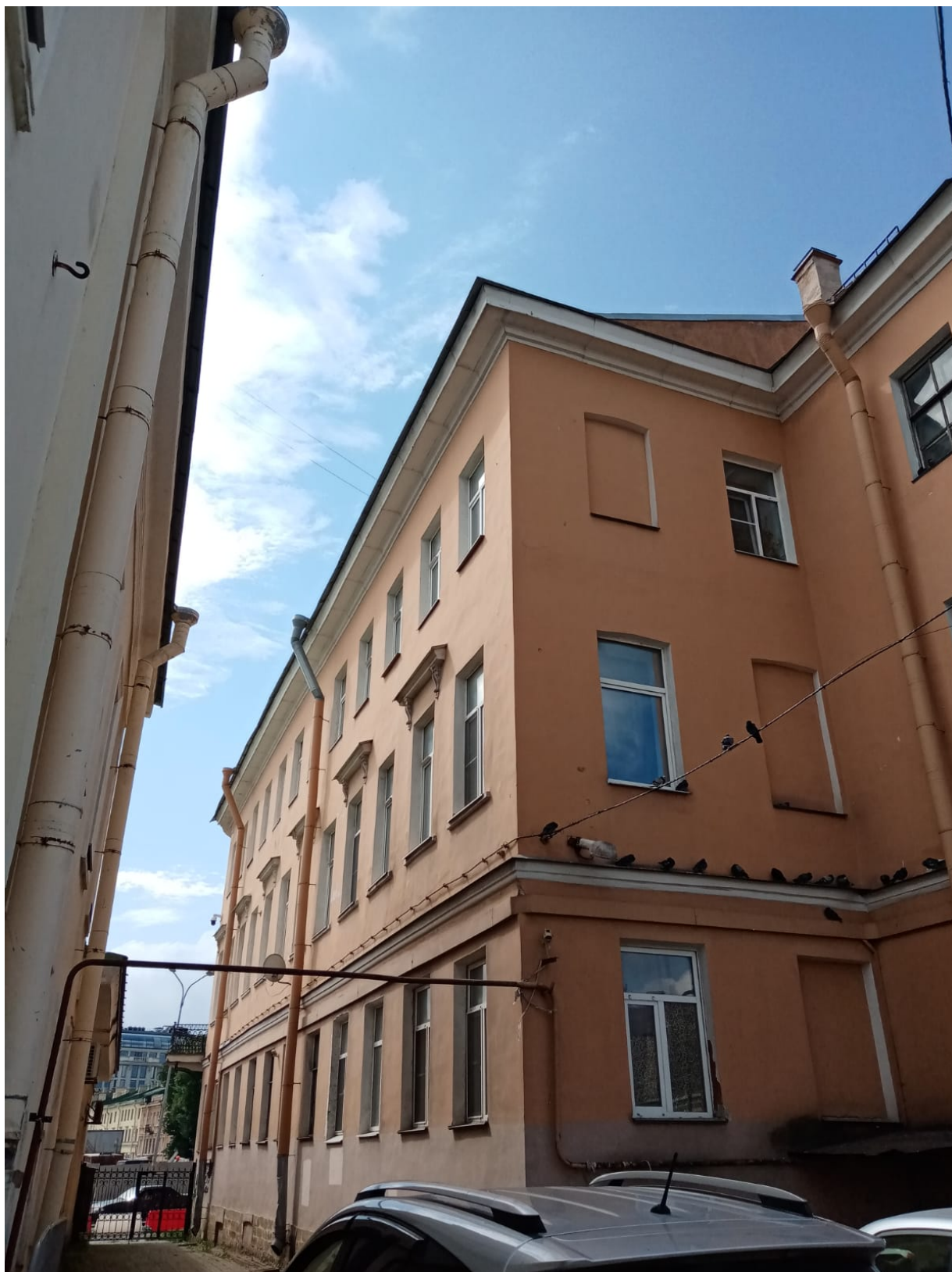
Фото 3. Общий вид объекта.
