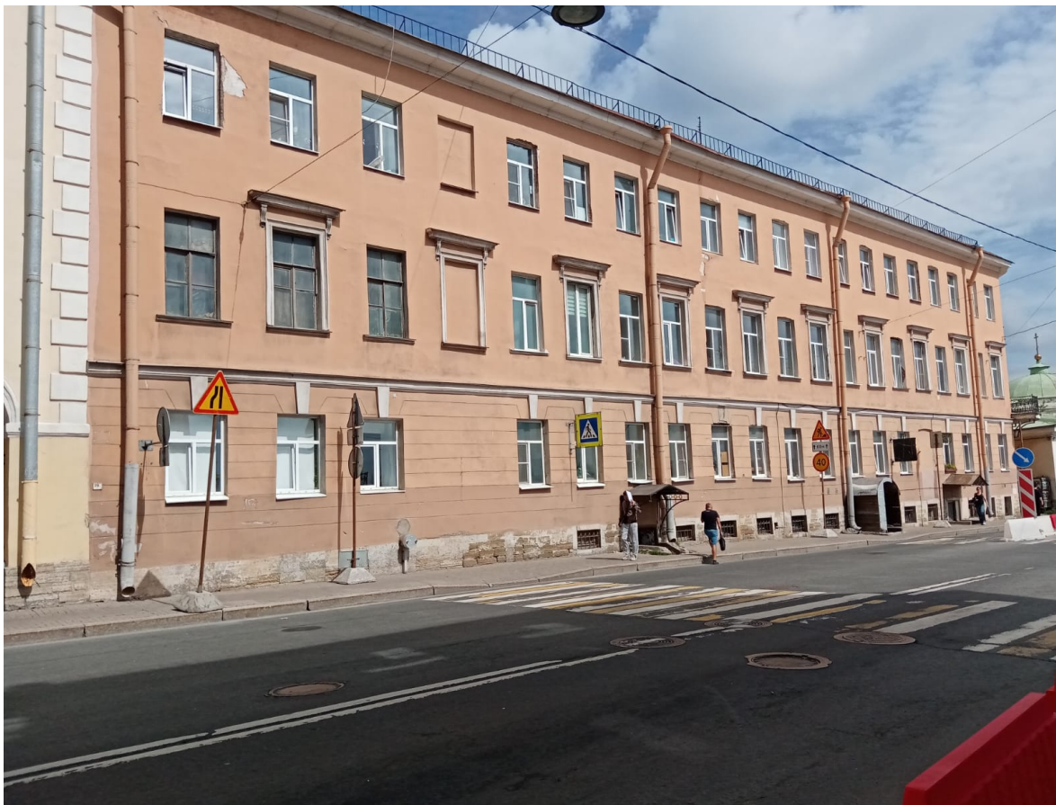
Фото 1. Общий вид объекта.
