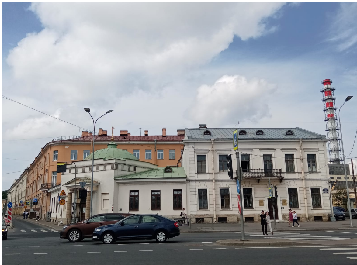
Фото 11. Общий вид объекта.
