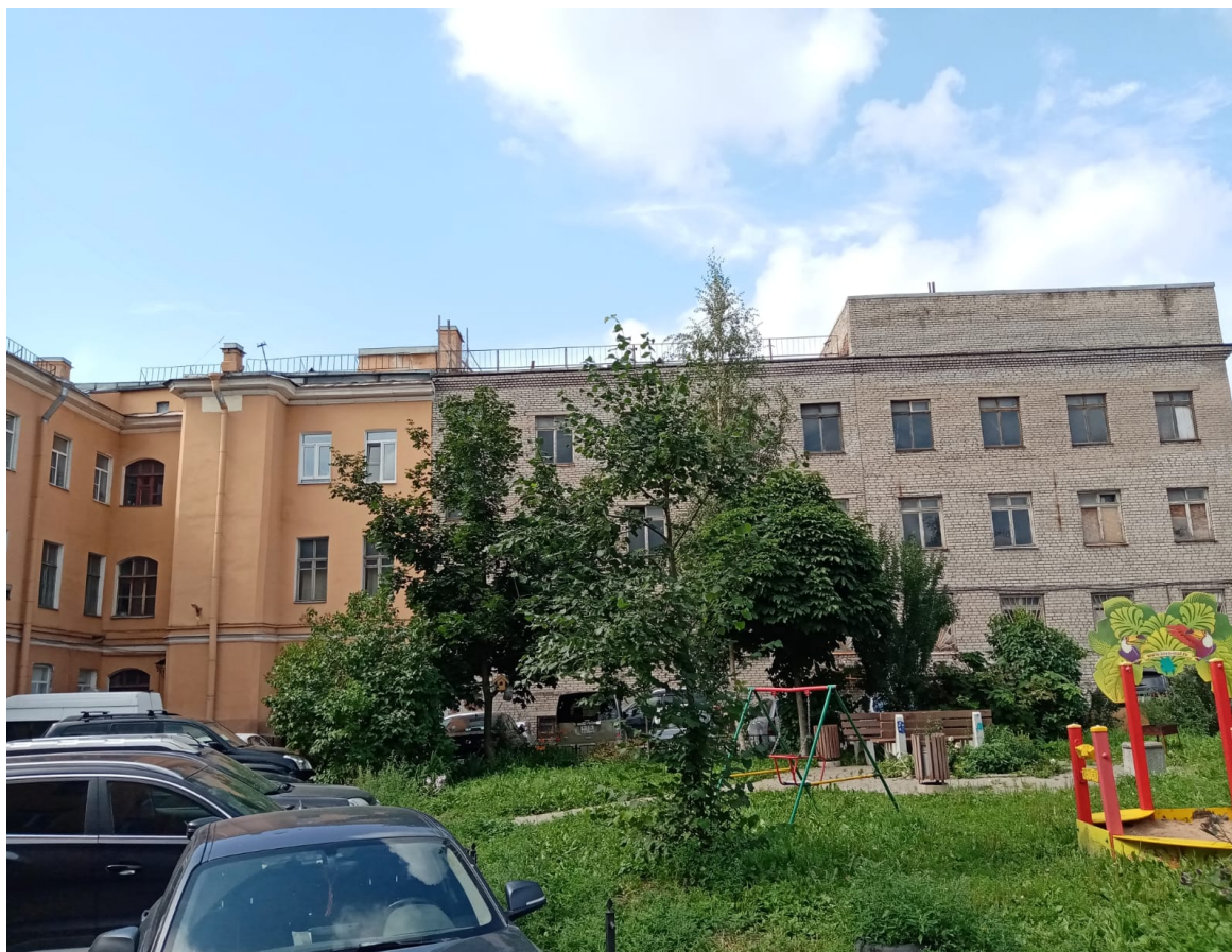
Фото 10. Общий вид объекта.
