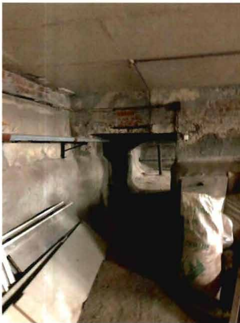
7. Сомкнутый свод помещение подвала.
