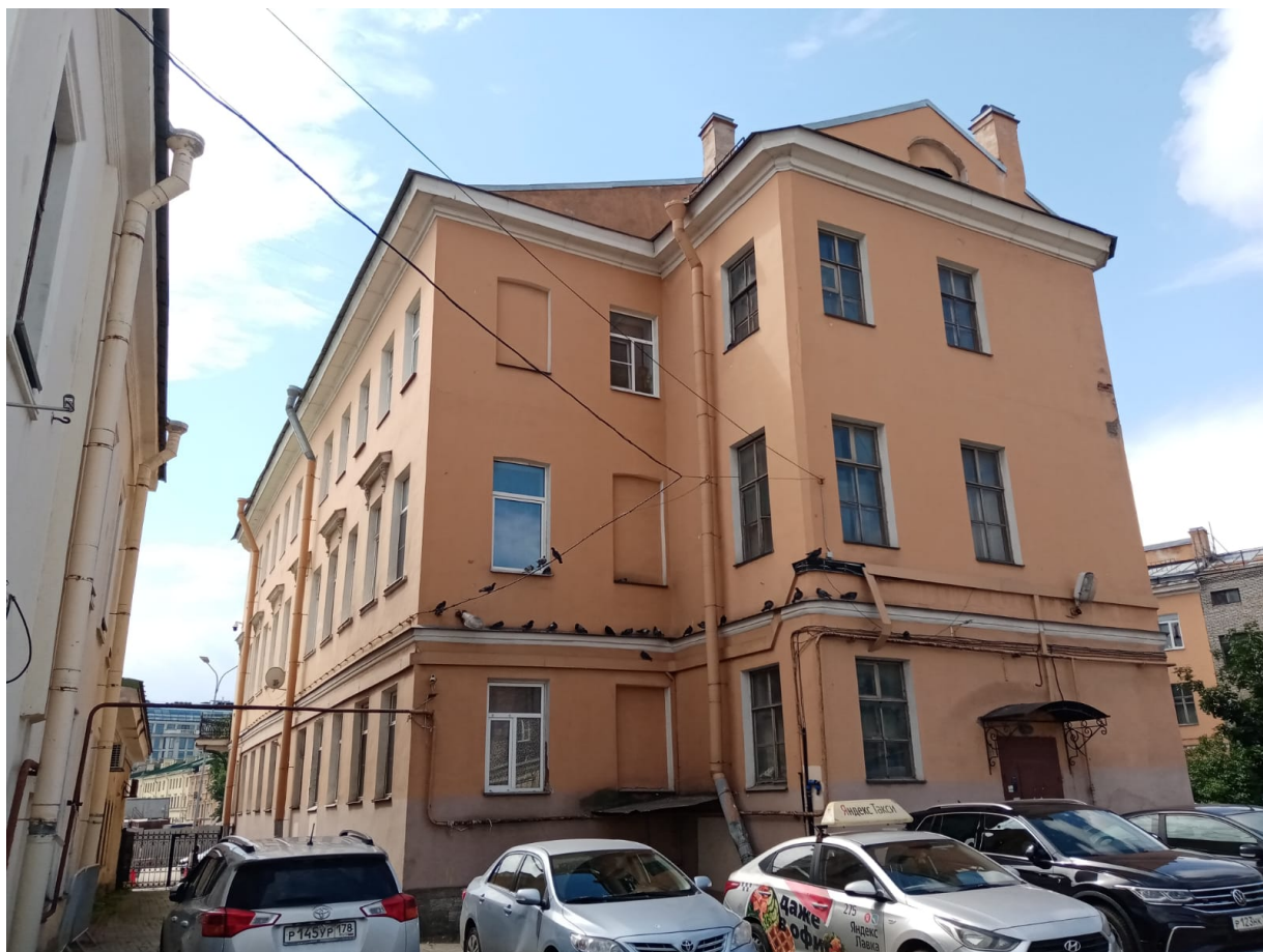
Фото 4. Общий вид объекта.
