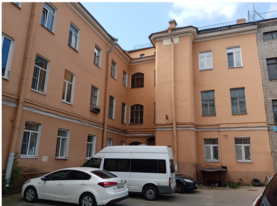
Фото 9. Общий вид объекта.
