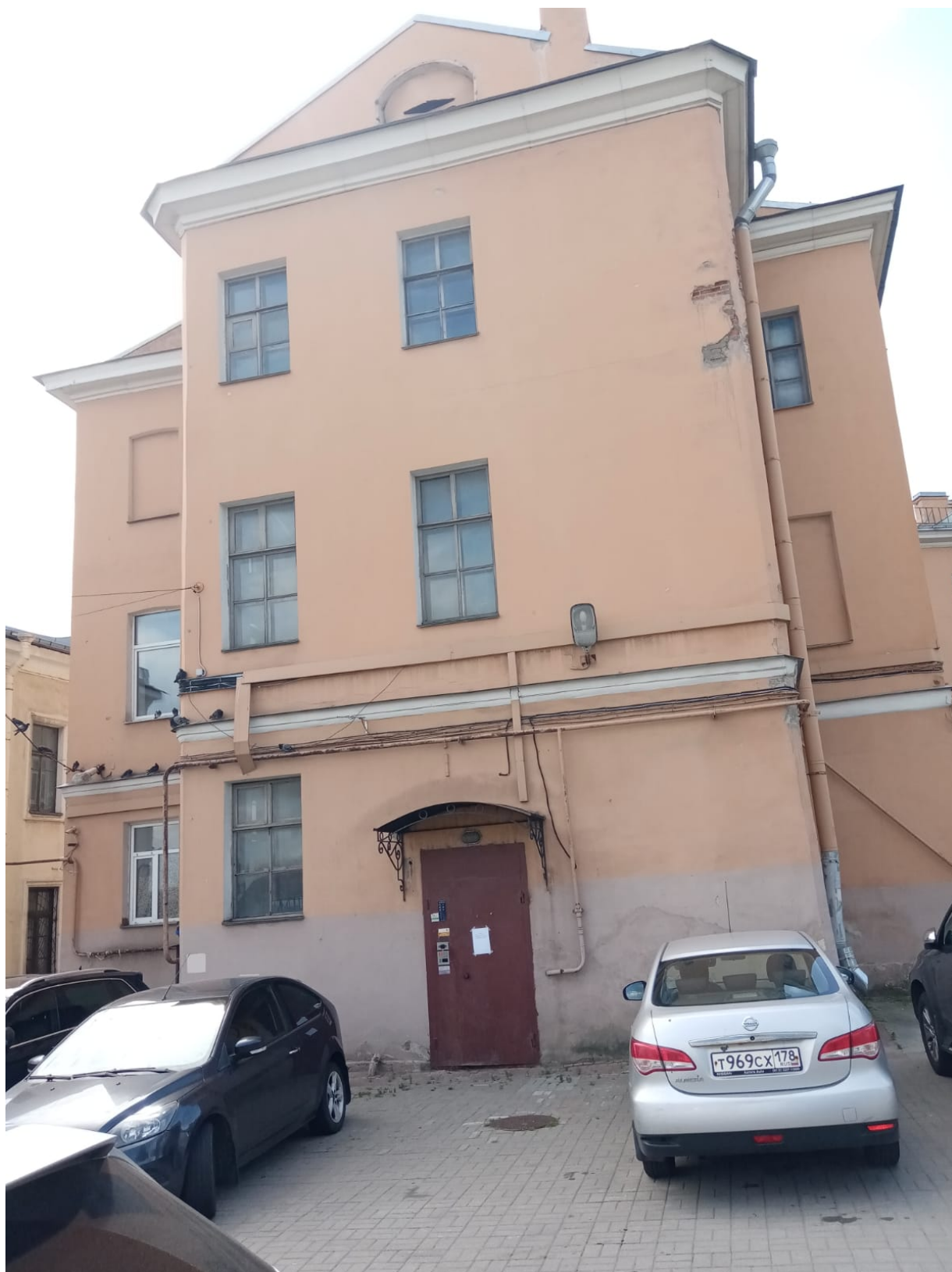
Фото 5. Общий вид объекта.
