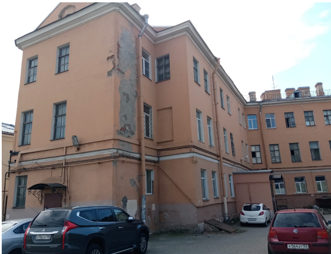
Фото 6. Общий вид объекта.
