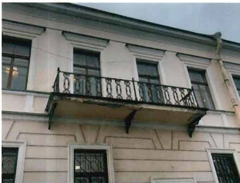
4. Фрагмент фасада с восточной стороны.
