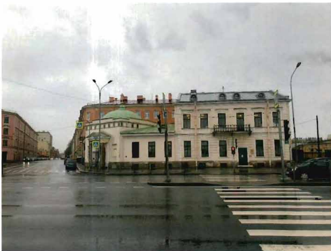
1. Вид на объект культурного наследия с восточной стороны.
