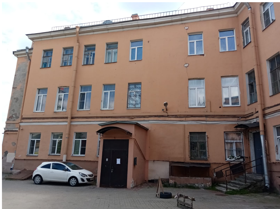
Фото 7. Общий вид объекта.
