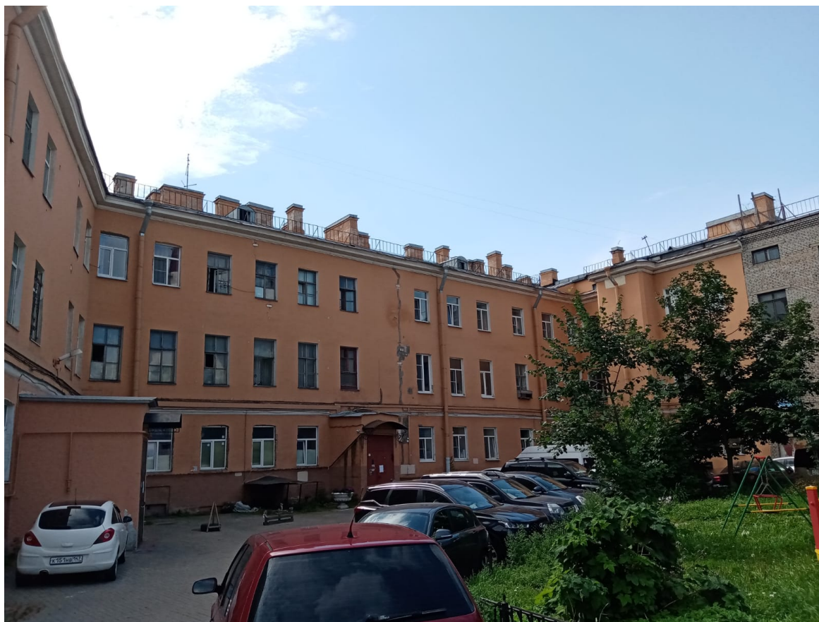
Фото 8. Общий вид объекта.
