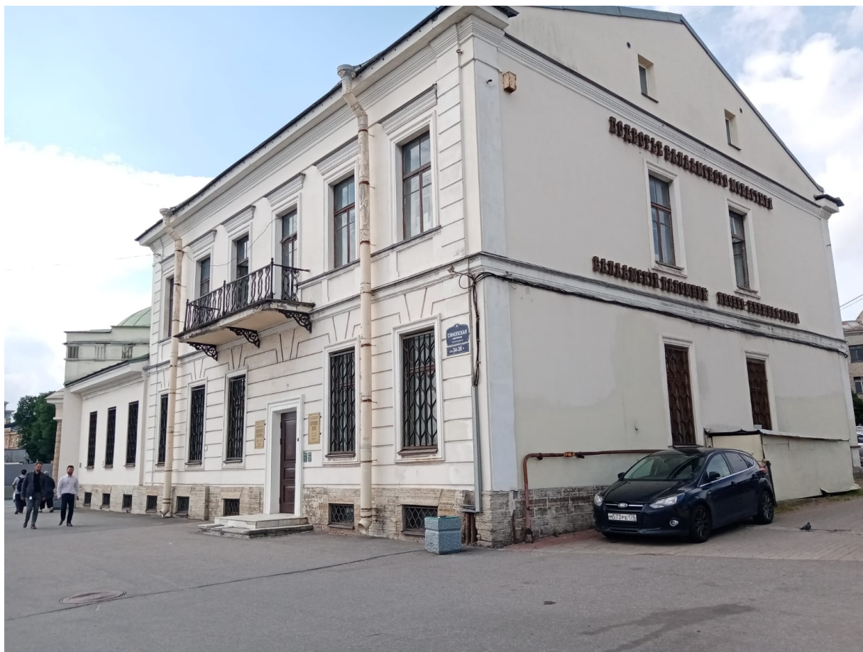
Фото 12. Общий вид объекта.
