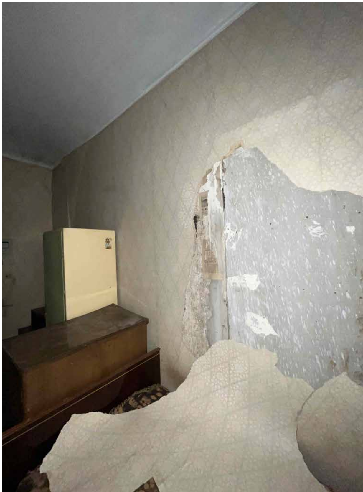
6. Фрагмент интерьера комнаты (помещение 9/10.8);
