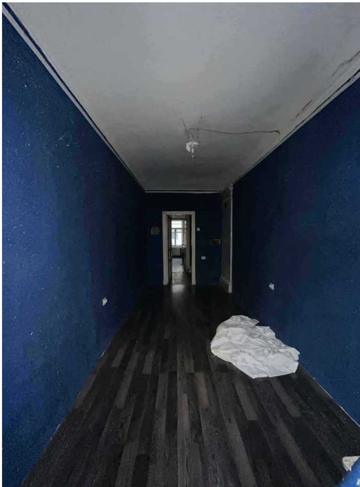
17.Фрагмент интерьера комнаты (помещение 3/15.2);
