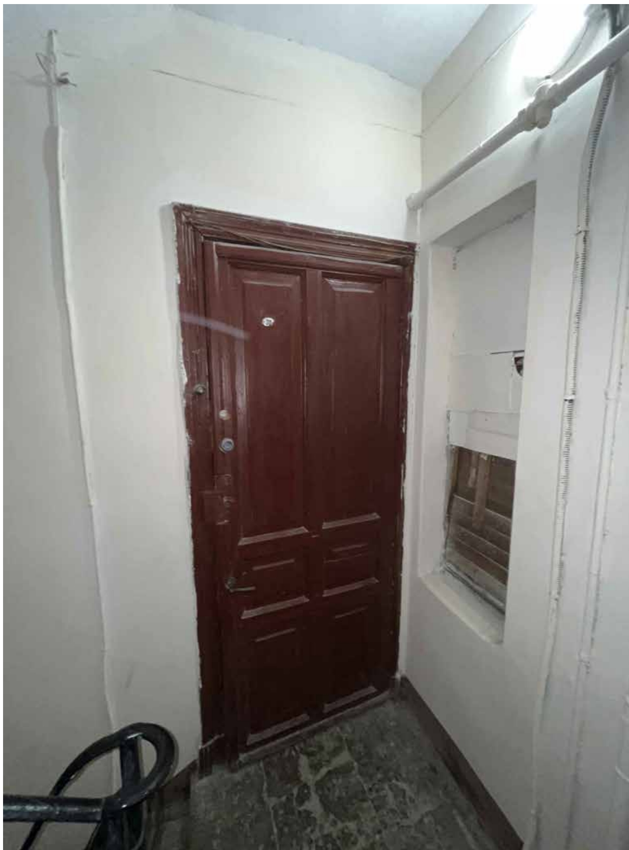
23. Вид на входную дверь.
