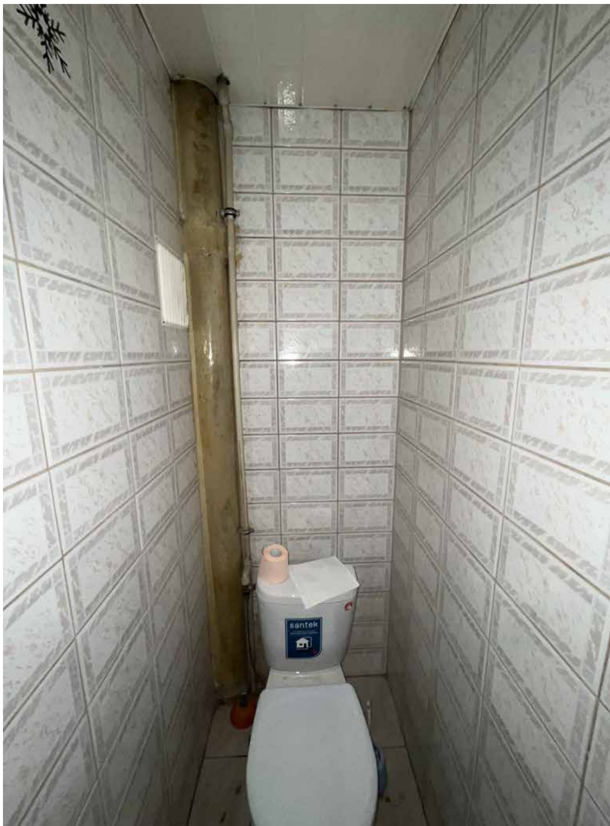
18. Фрагмент интеръера туалета (помещение 5/1);
