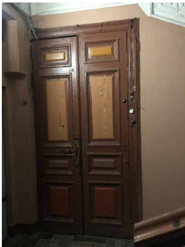
Фото 1. Вид на входную дверь.
