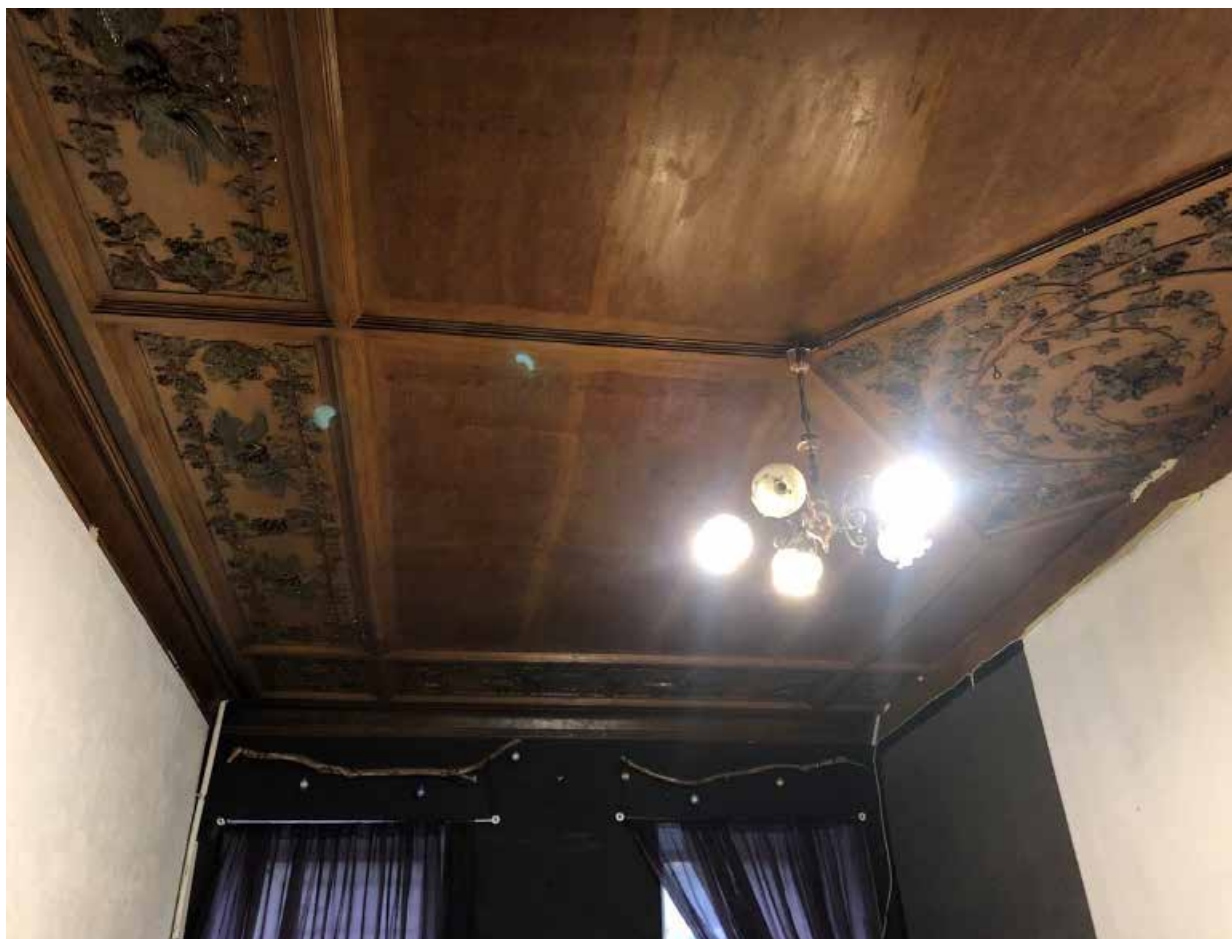
Фото 22. Лепной потолок в помещении № 10.
