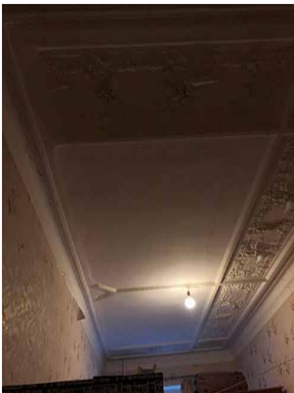
Фото 25. Лепной потолок в помещении № 23.
