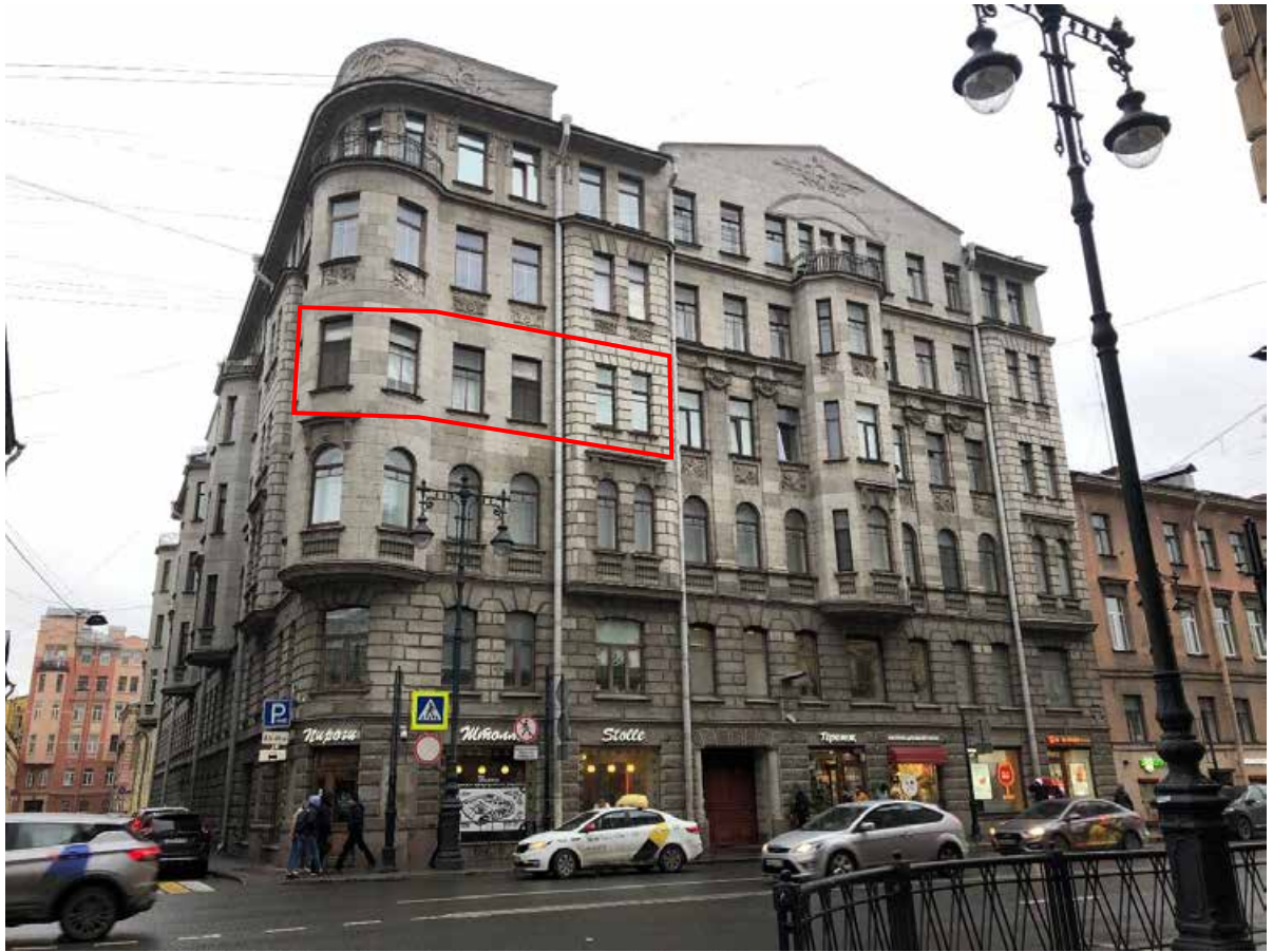
Фото 3. Вид на лицевой фасад исследуемого здания со стороны улицы Восстания.
