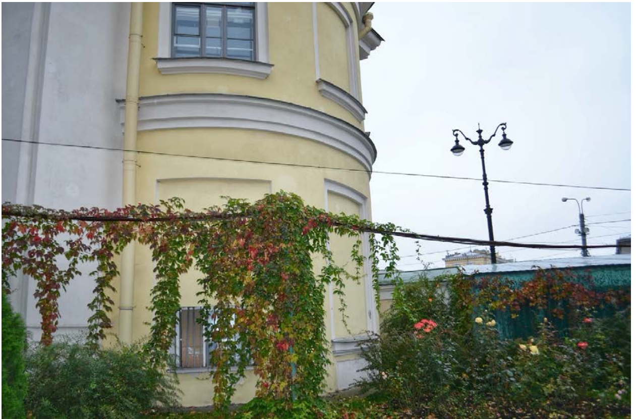
Фото 23. ОКН федерального значения «Церковь Всех Скорбящих Радости (надвратная)». Восточный фасад. Фрагмент. Съёмка 26.10.2020 г.
