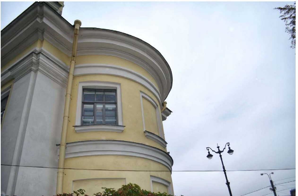
Фото 26. ОКН федерального значения «Церковь Всех Скорбящих Радости (надвратная)». Восточный фасад. Фрагмент. Съёмка 26.10.2020 г.
