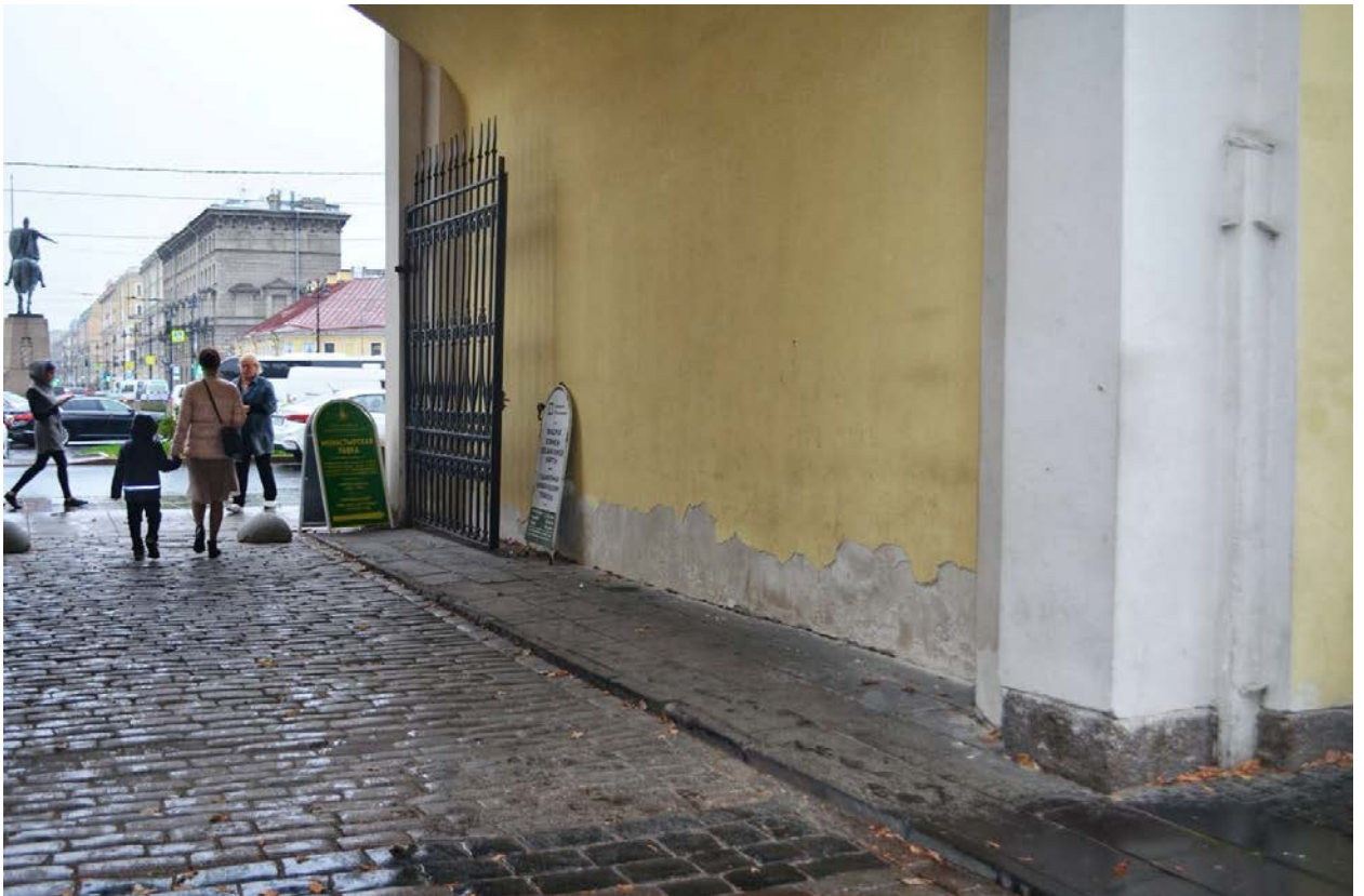
Фото 20. ОКН федерального значения «Церковь Всех Скорбящих Радости (надвратная)». Воротный проезд со стороны южного фасада. Фрагмент. Съёмка 26.10.2020 г.
