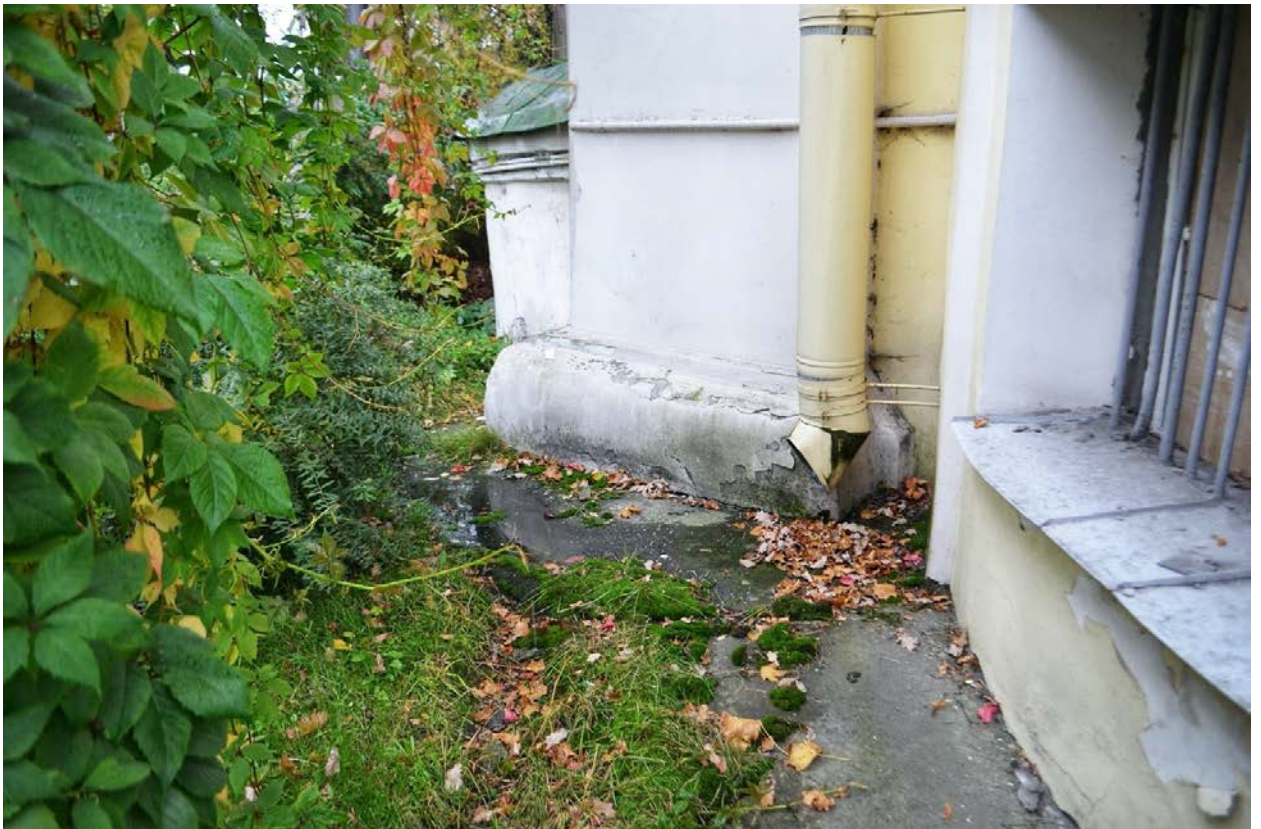
Фото 24. ОКН федерального значения «Церковь Всех Скорбящих Радости (надвратная)». Восточный фасад. Фрагмент. Съёмка 26.10.2020 г.
