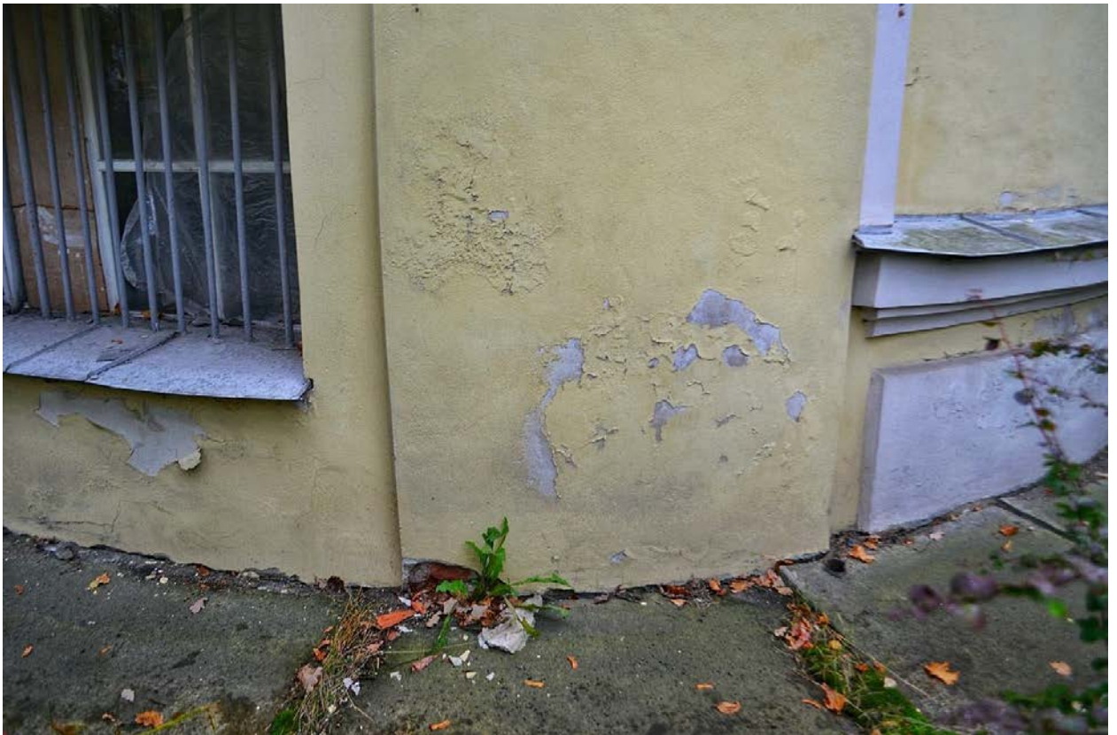
Фото 25. ОКН федерального значения «Церковь Всех Скорбящих Радости (надвратная)». Восточный фасад. Фрагмент. Съёмка 26.10.2020 г.
