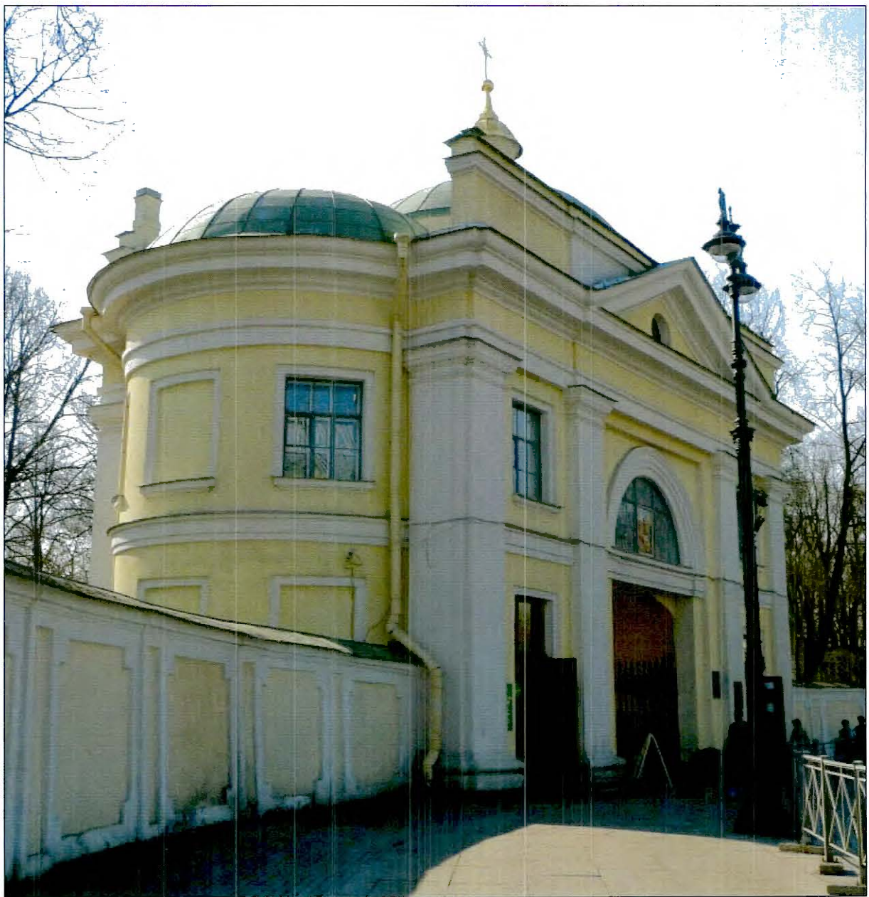
1. Общий вид с севера.
