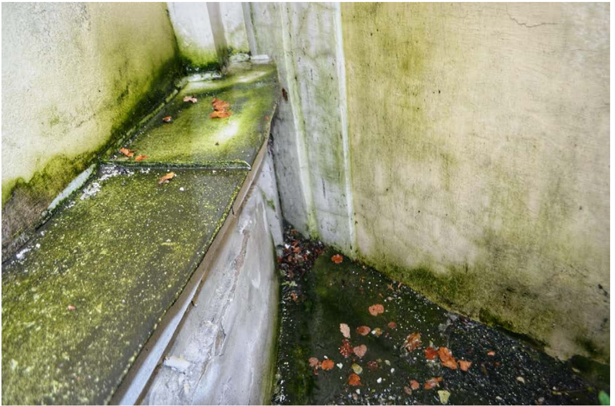
Фото 30. ОКН федерального значения «Церковь Всех Скорбящих Радости (надвратная)». Восточный фасад. Фрагмент. Съёмка 26.10.2020 г.
