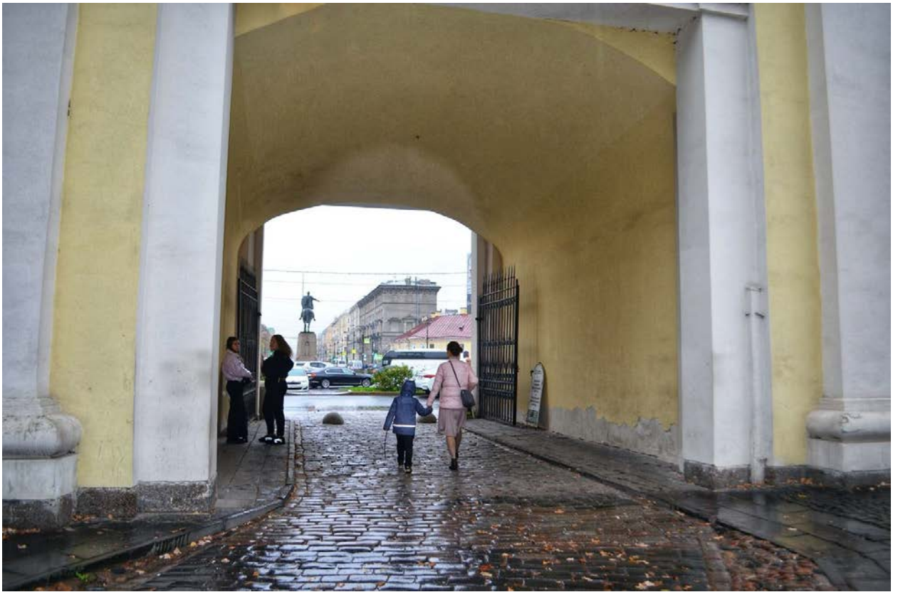
Фото 19. ОКН федерального значения «Церковь Всех Скорбящих Радости (надвратная)». Воротный проезд со стороны южного фасада. Общий вид. Съёмка 26.10.2020 г.
