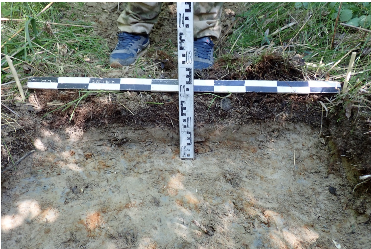
Рис. 27. Земельный участок с кадастровым номером 78:40:0008339:14674 по адресу Санкт-Петербург, Петергофское шоссе, участок 104 (севернее пересечения с улицей Пограничника Гарькавого. Квартал 31-1). Северная стенка шурфа № 2, вид с юга
