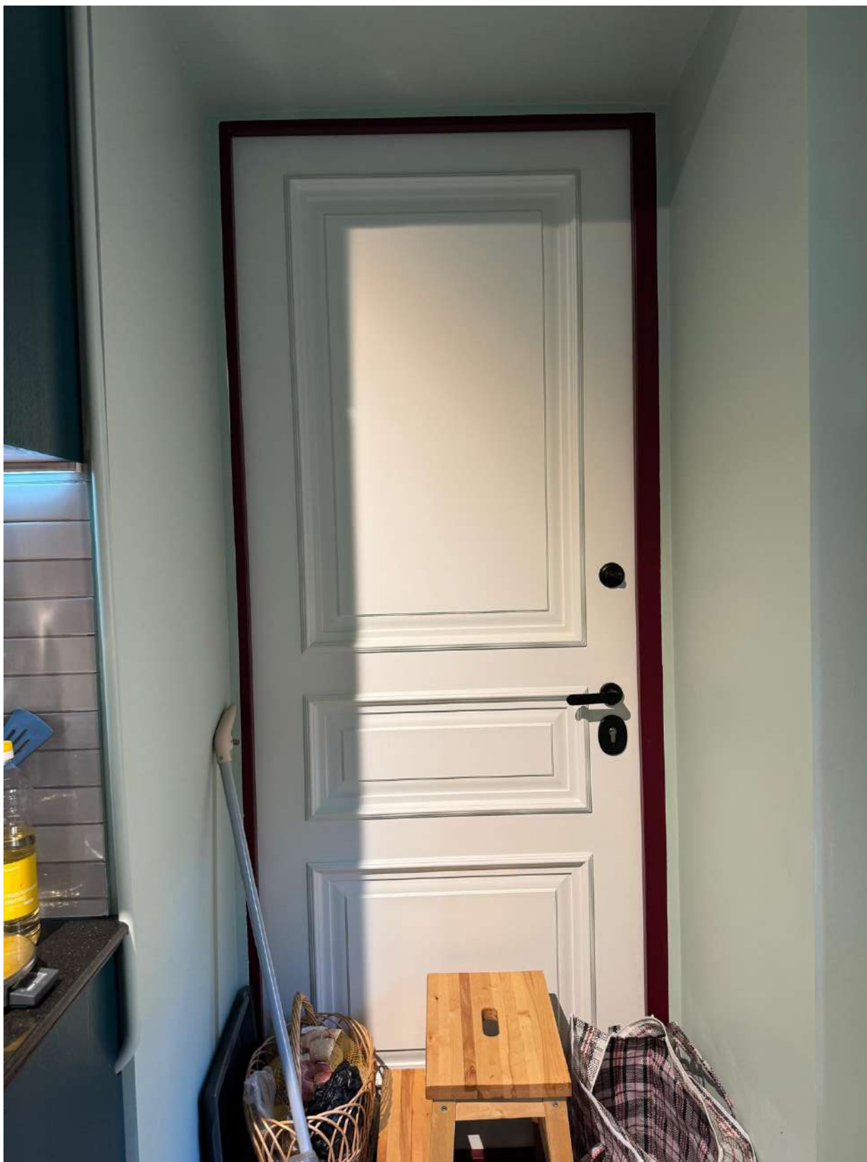
Фото 38. Вид на дверное заполнение квартиры № 45 объекта культурного наследия.
