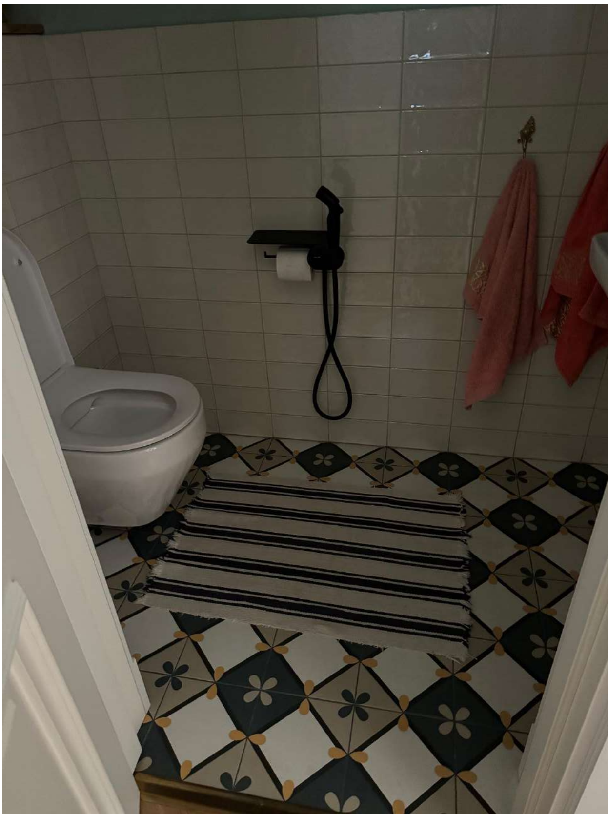
Фото 42. Вид на помещение квартиры № 45 объекта культурного наследия.
