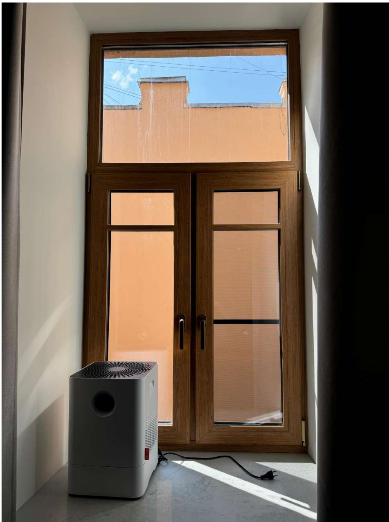
Фото 33. Вид на оконное заполнение квартиры № 45 объекта культурного наследия.
