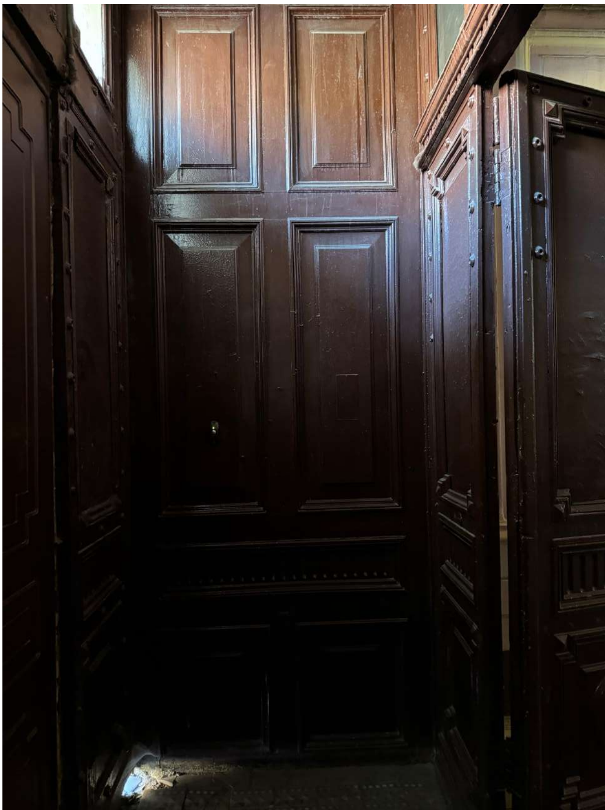
Фото 14. Интерьер тамбура объекта культурного наследия.
