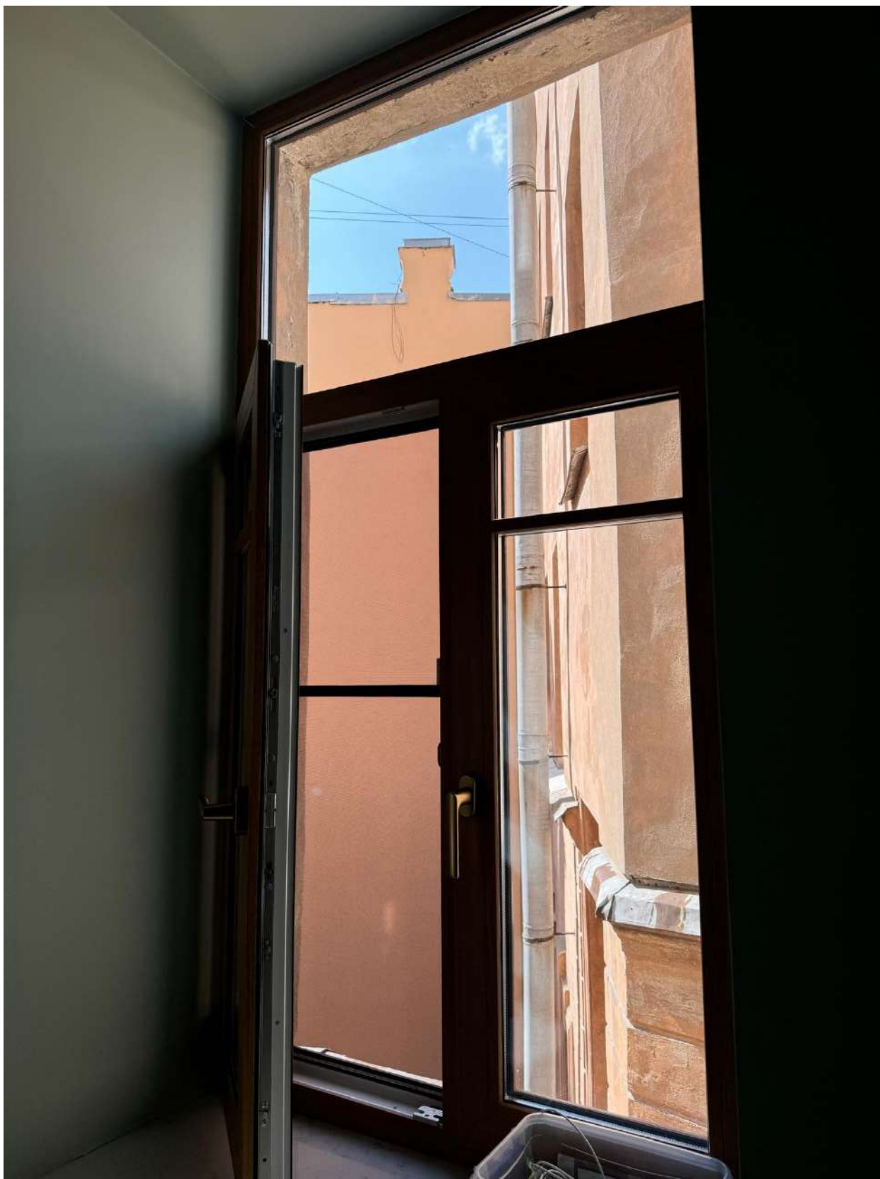
Фото 23. Вид на оконное заполнение квартиры № 45 объекта культурного наследия.
