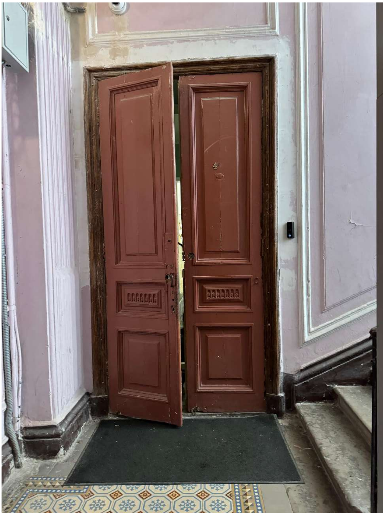
Фото 20. Вид на входное дверное заполнение квартиры № 45 объекта культурного наследия.
