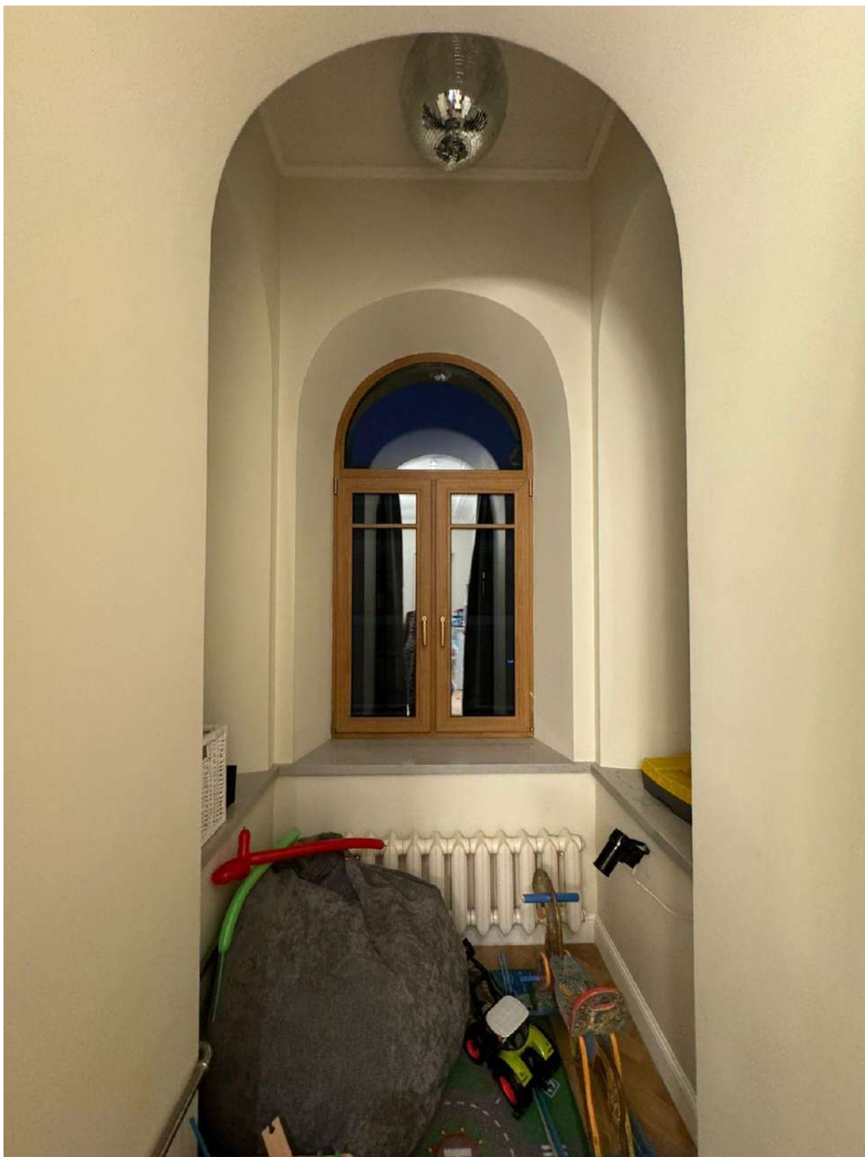
Фото 69. Вид на помещение квартиры № 45 объекта культурного наследия.
