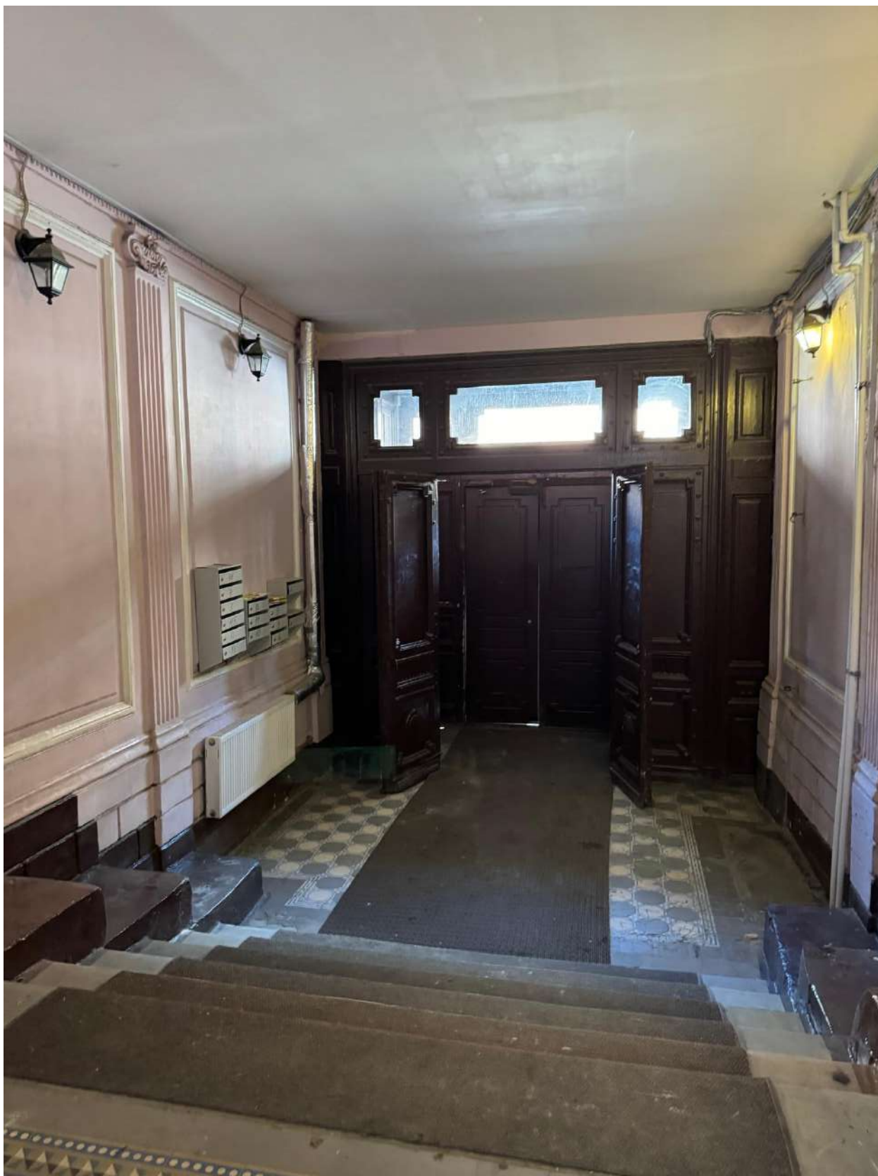
Фото 16. Интерьер вестибюля объекта культурного наследия.
