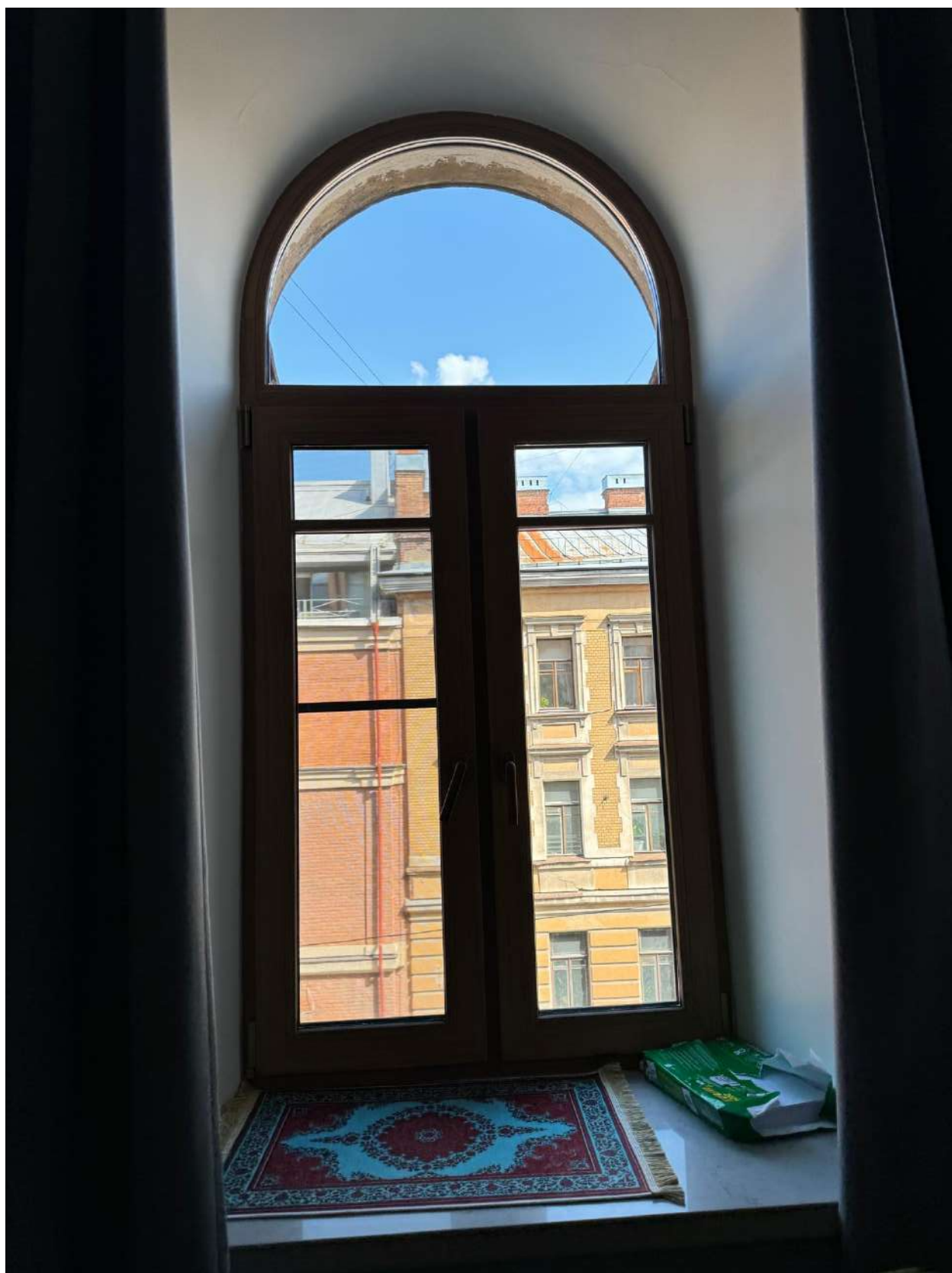
Фото 59. Вид на оконное заполнение квартиры № 45 объекта культурного наследия.
