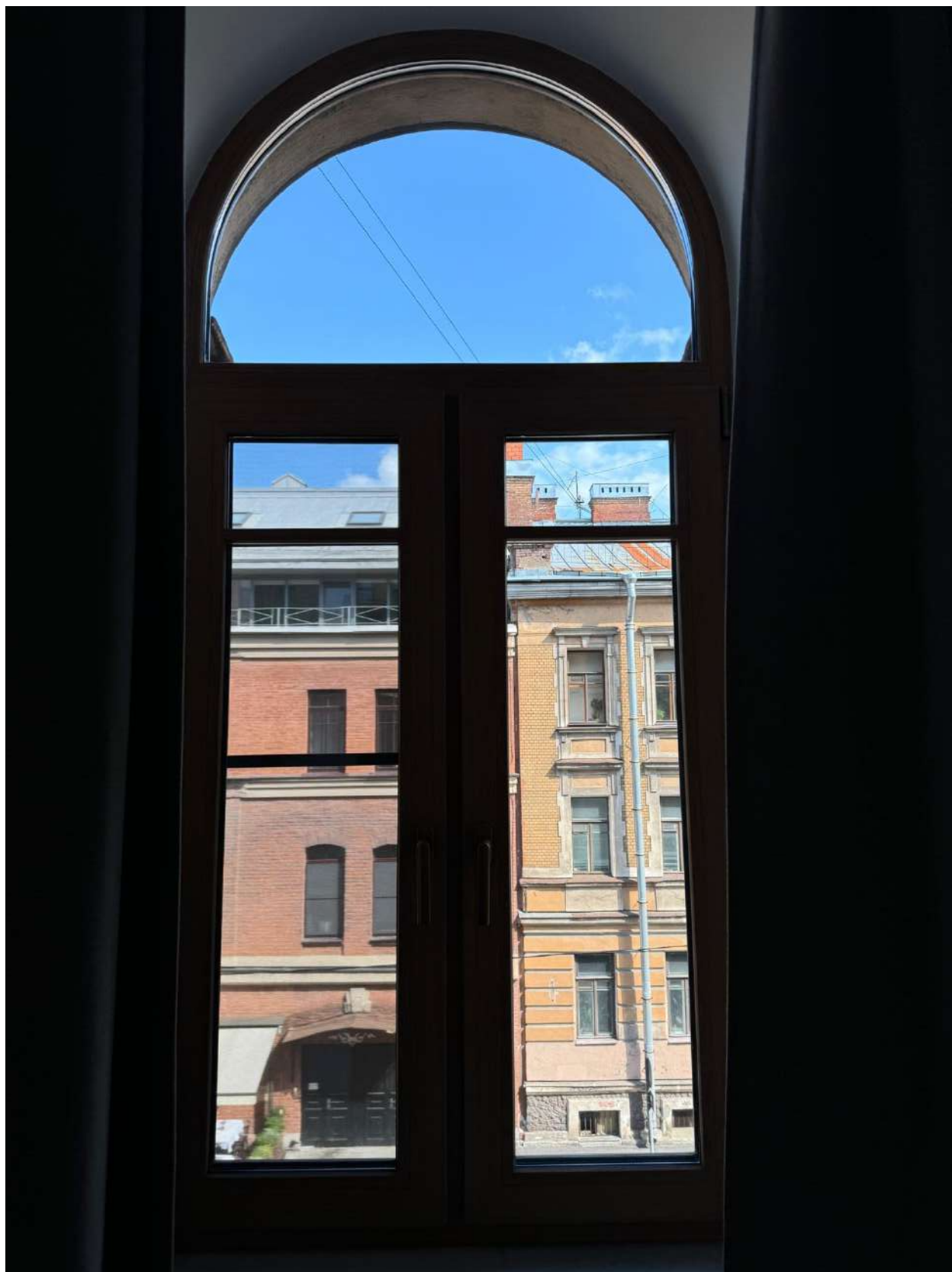
Фото 47. Вид на оконное заполнение квартиры № 45 объекта культурного наследия.
