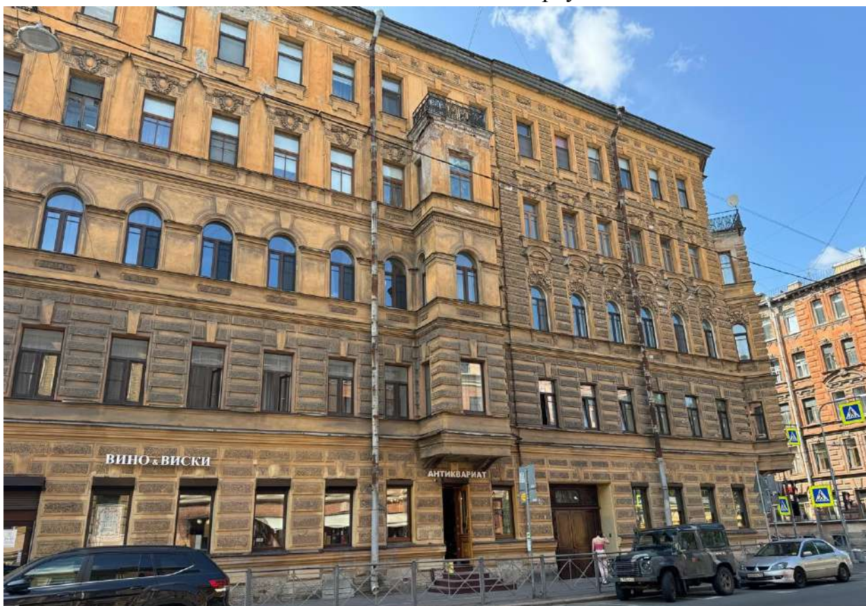
Фото 2. Фрагмент фасада объекта культурного наследия по улице Радищева.
