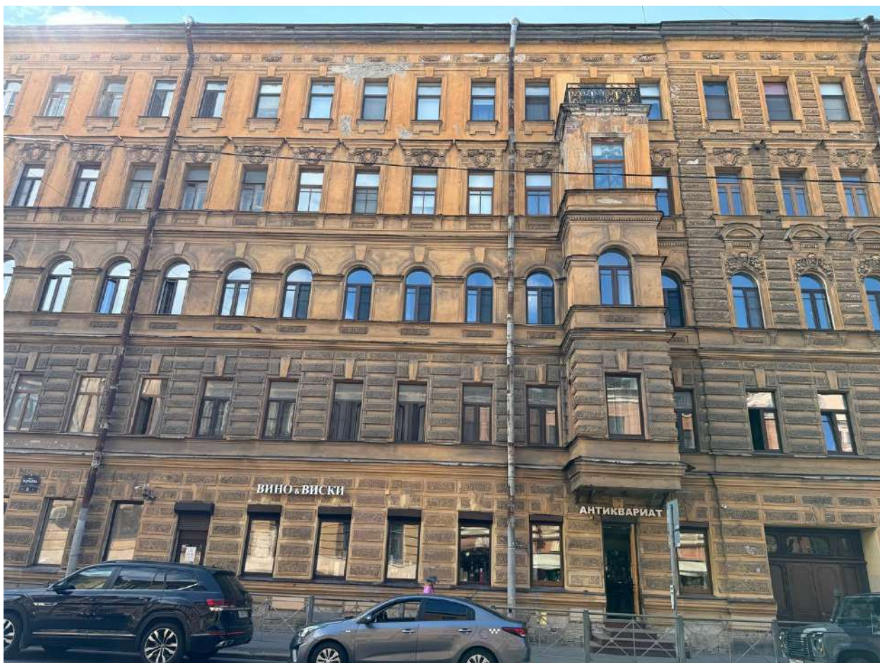
Фото 6. Фрагмент фасада объекта культурного наследия по улице Радищева.
