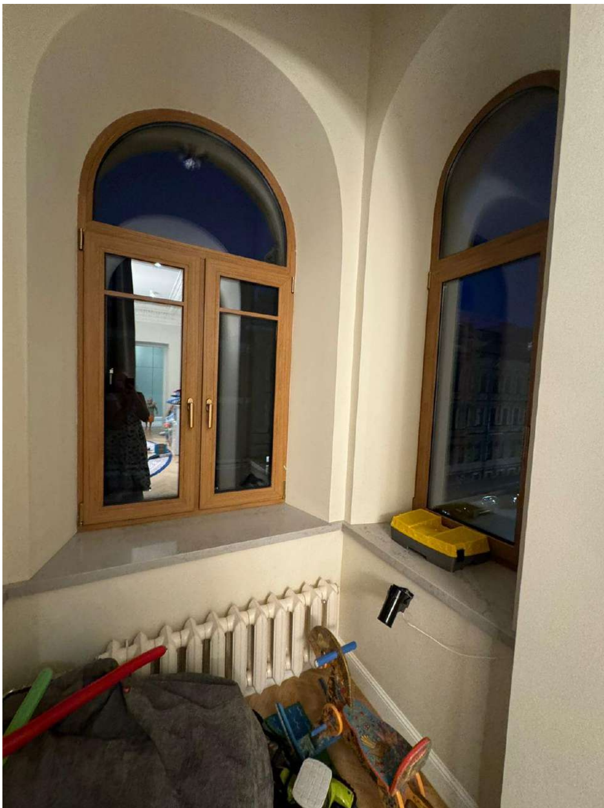
Фото 68. Вид на помещение квартиры № 45 объекта культурного наследия.
