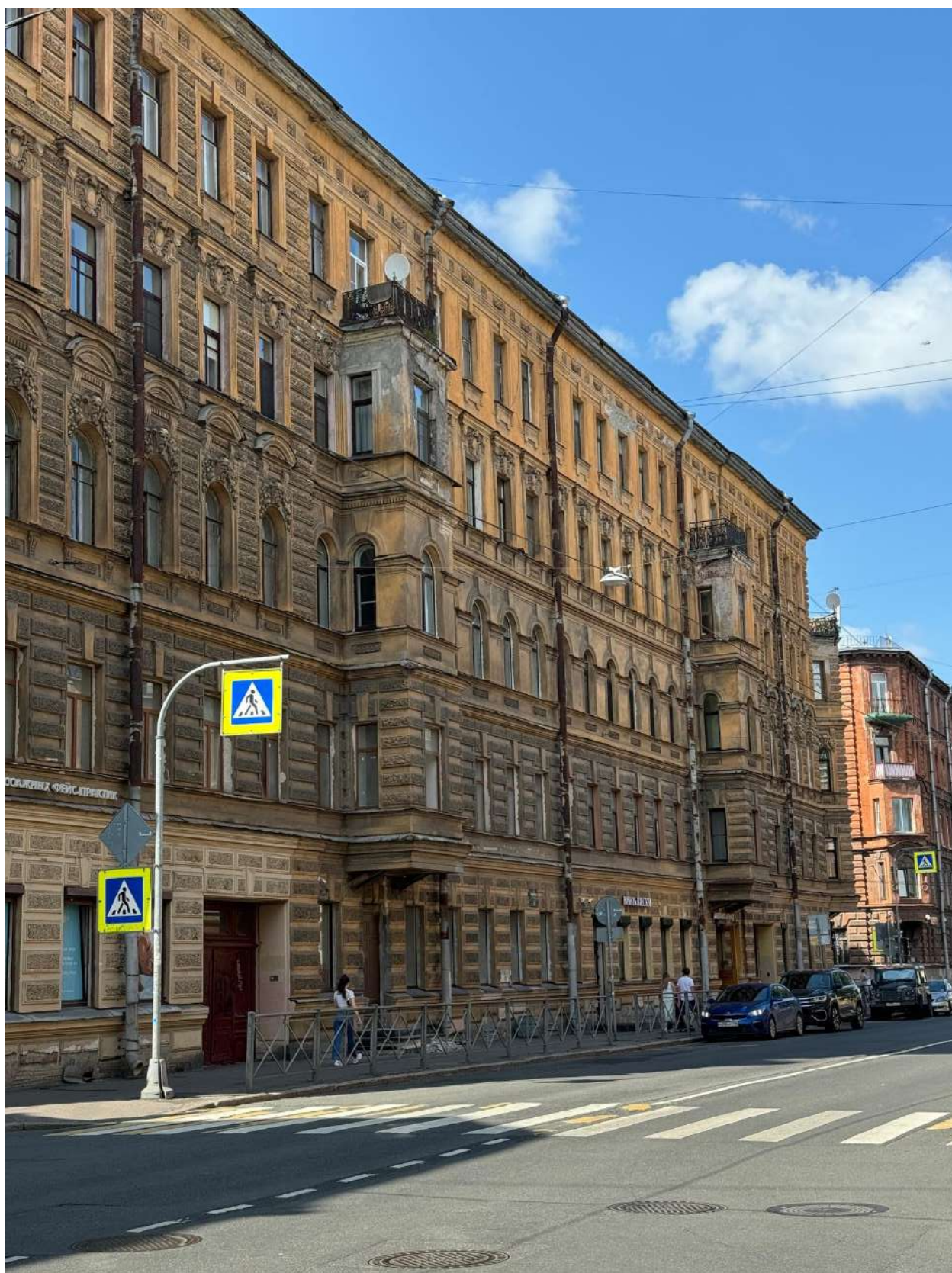
Фото 4. Фрагмент фасада объекта культурного наследия по улице Радищева.
