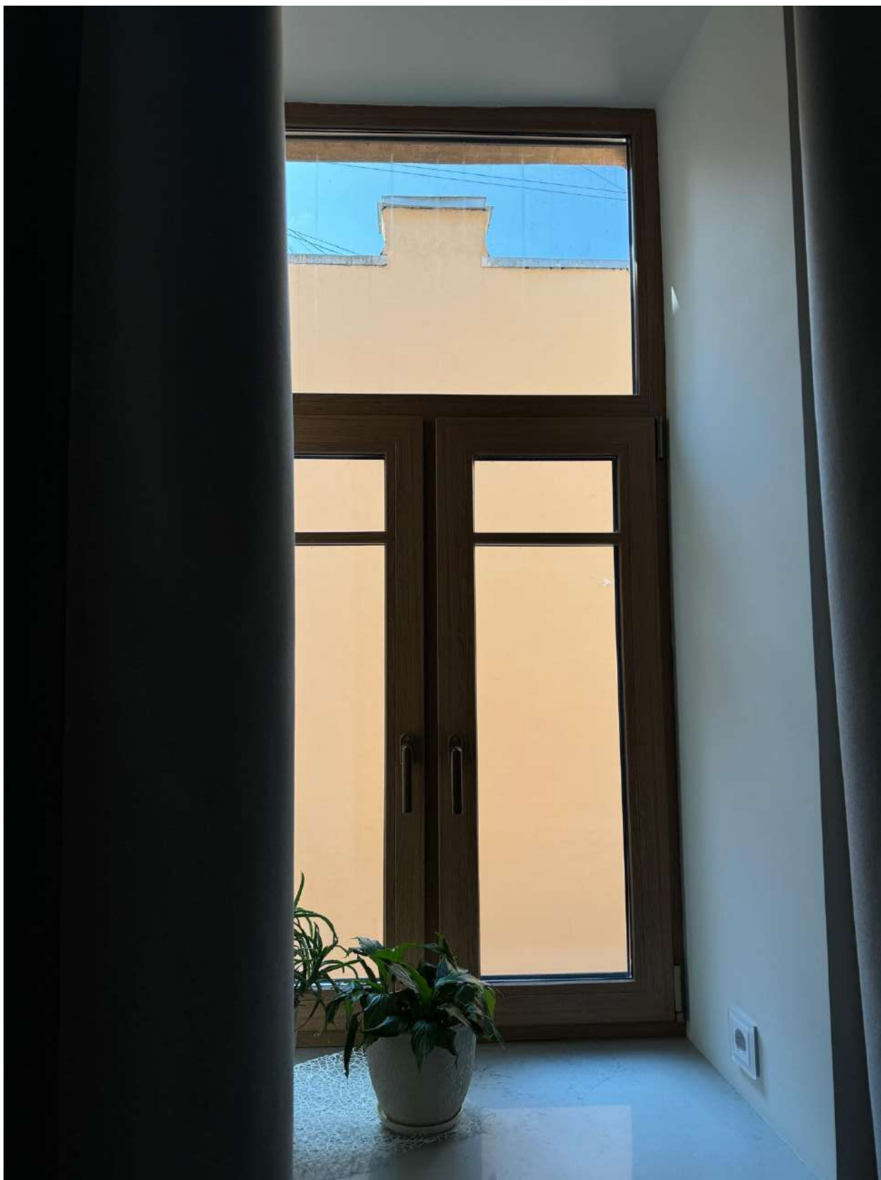
Фото 34. Вид на оконное заполнение квартиры № 45 объекта культурного наследия.
