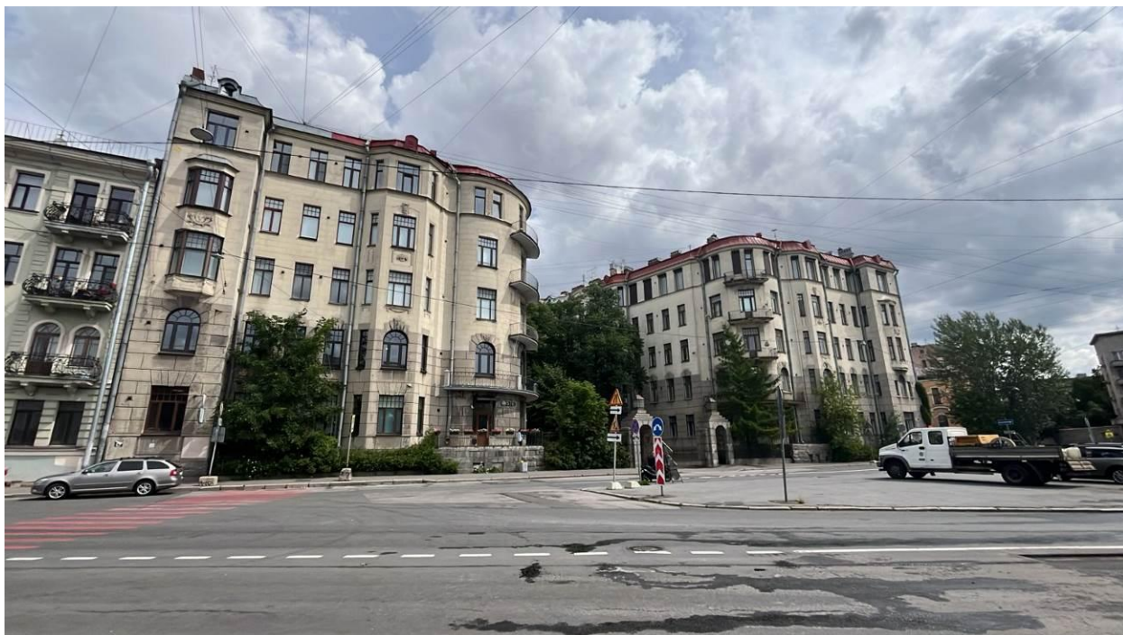
Фото 1. Лицевой фасад выявленного объекта культурного наследия «Дом Второго Санкт-Петербургского товарищества для устройства постоянных квартир (с курдонером, палисадниками и оградой)»
