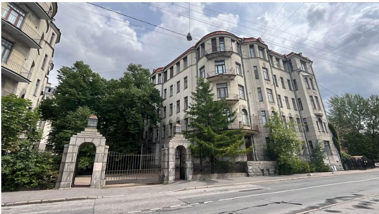
Фото 3. Лицевой фасад выявленного объекта культурного наследия «Дом Второго Санкт-Петербургского товарищества для устройства постоянных квартир (с курдонером, палисадниками и оградой)»
