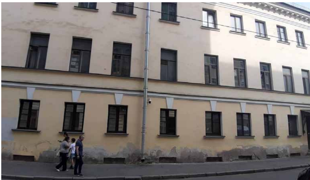
3. «Дом Булатовых» (ул. Рылеева, д. 1/9, лит. А). Лицевой фасад. Фото мест установки оборудования и прокладки кабельных трасс. Штиглиц М.С. 10.06.2024.
