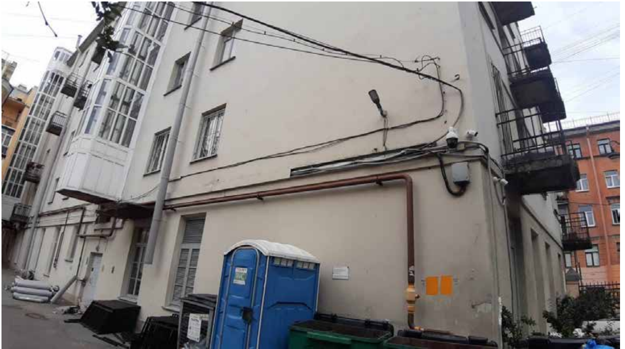
25. «Дом-коммуна инженеров и писателей (с оградой)» (ул. Рубинштейна, д. 7, лит. Б). Штиглиц М.С. Дворовый фасад. Фото мест установки оборудования и прокладки кабельных трасс. 10.06.2024.
