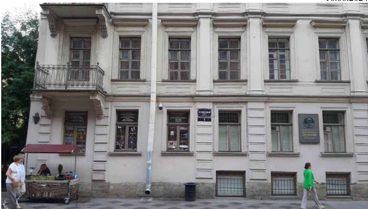
16. «Дом, где в 1846 г., 1878-1881 гг. жил писатель Достоевский Ф.М.» (ул. Достоевского, д. 2/5, лит. А). Лицевой фасад. Фото мест установки оборудования и прокладки кабельных трасс. Штиглиц М.С. 10.06.2024.
