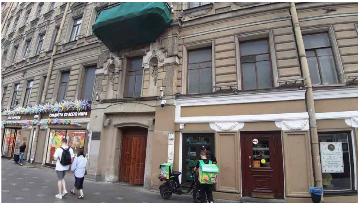
19. «Дом И.И. Ростовцева» (ул. Рубинштейна, д. 2/45, лит. А). Лицевой фасад. Фото мест установки оборудования и прокладки кабельных трасс. Штиглиц М.С. 10.06.2024.
