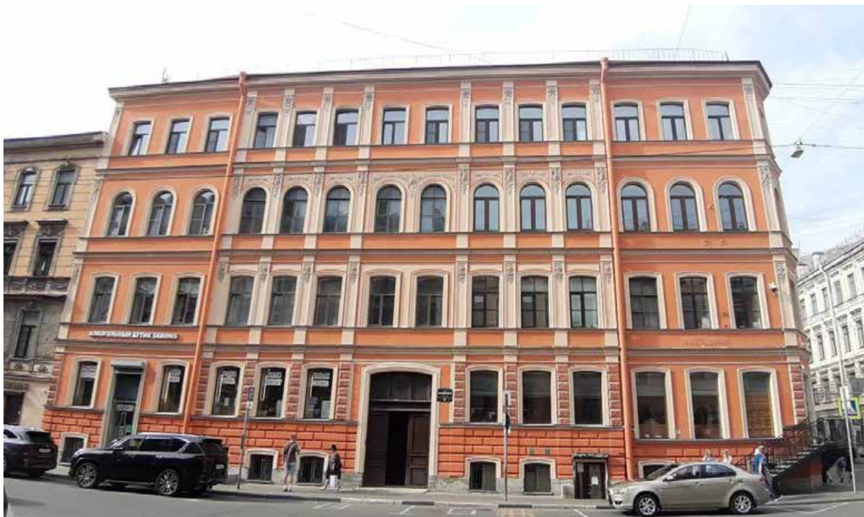
11. «Дом, где в 1863-1870 гг. жил физиолог Сеченов И.М.» (ул. Жуковского, д. 10, лит. А). Лицевой фасад по ул. Жуковского. Штиглиц М.С. 10.06.2024.
