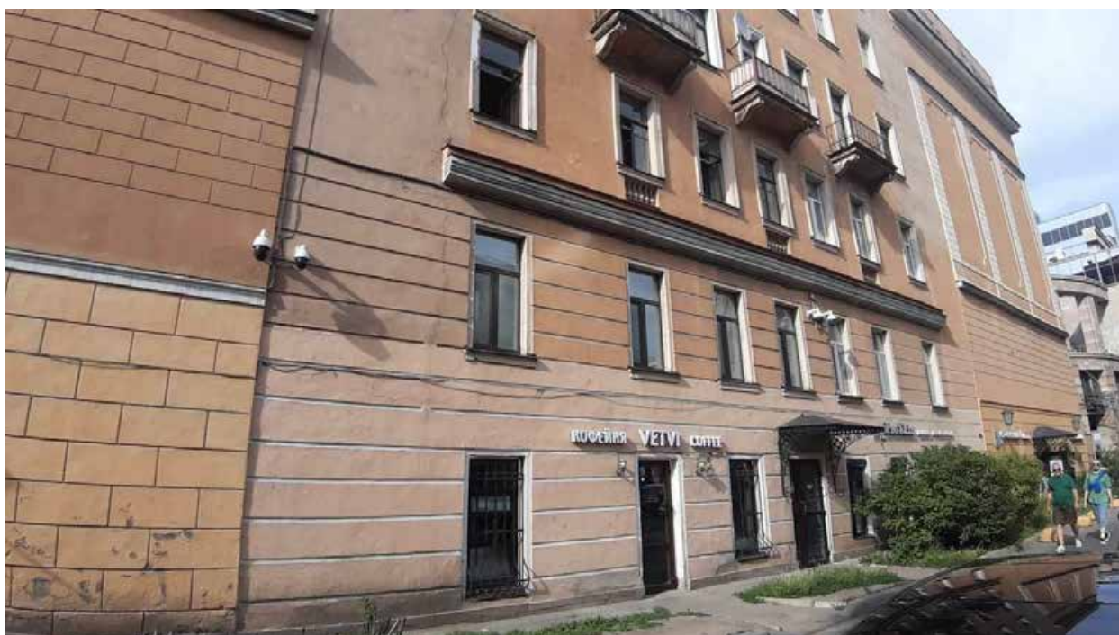
8.«Дом, где в 1910-1927 гг. жил юрист, литератор Кони А.Ф.» (ул. Маяковского, д. 3, лит. А). Боковой фасад. Фото мест установки оборудования и прокладки кабельных трасс. Штиглиц М.С. 10.06.2024.
