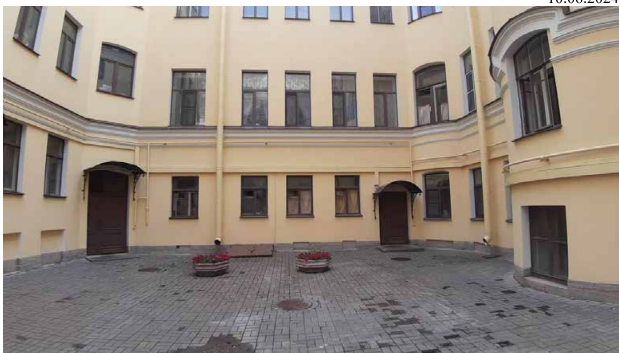
44. «Дом Н.Н. Никонова» (ул. Достоевского, д. 38, лит. А). Дворовый фасад. Фото мест установки оборудования и прокладки кабельных трасс. Штиглиц М.С. 10.06.2024.
