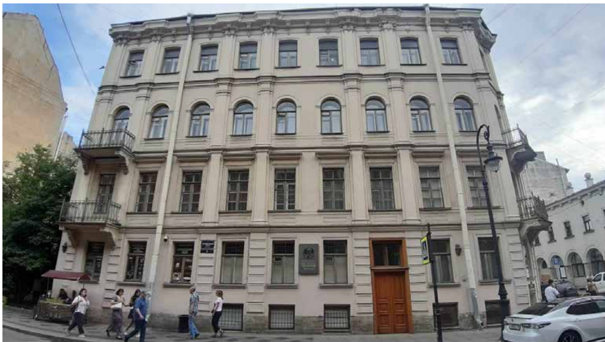
15. «Дом, где в 1846 г., 1878-1881 гг. жил писатель Достоевский Ф.М.» (ул. Достоевского, д. 2/5, лит. А). Лицевой фасад по Кузнечному пер. Штиглиц М.С. 10.06.2024.
