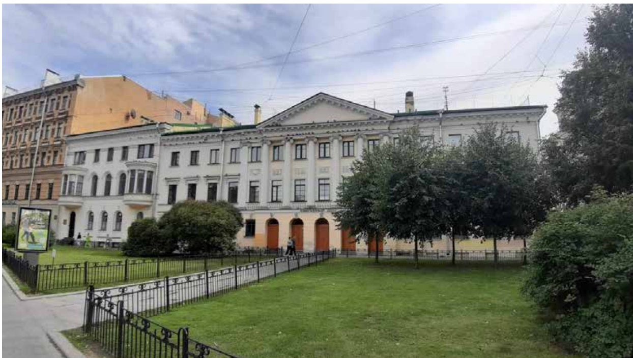
1. «Дом Булатовых» (ул. Рылеева, д. 1/9, лит. А). Лицевой фасад. Вид с Преображенской пл. Штиглиц М.С. 10.06.2024.
