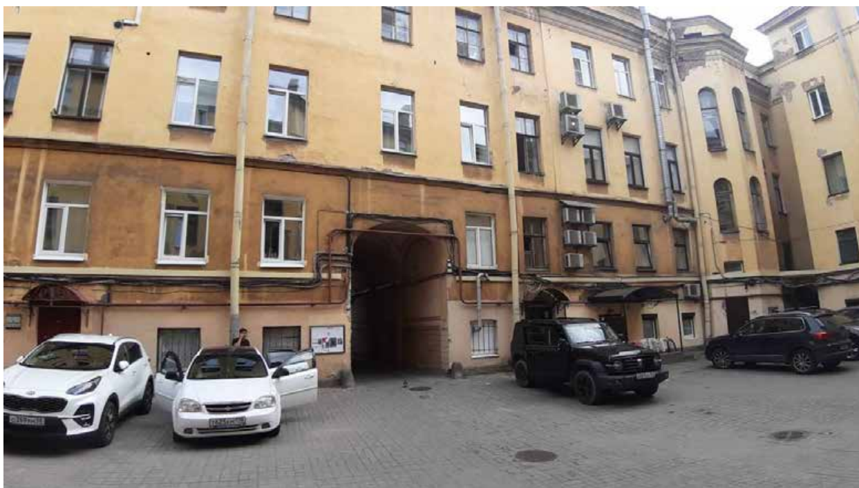
35. «Особняк А.П.Гагариной (дом Н.П.Жеребцовой)» (Миллионная ул., д. 11, лит. А). Дворовый фасад. Фото мест установки оборудования и прокладки кабельных трасс. Штиглиц М.С. 10.06.2024.
