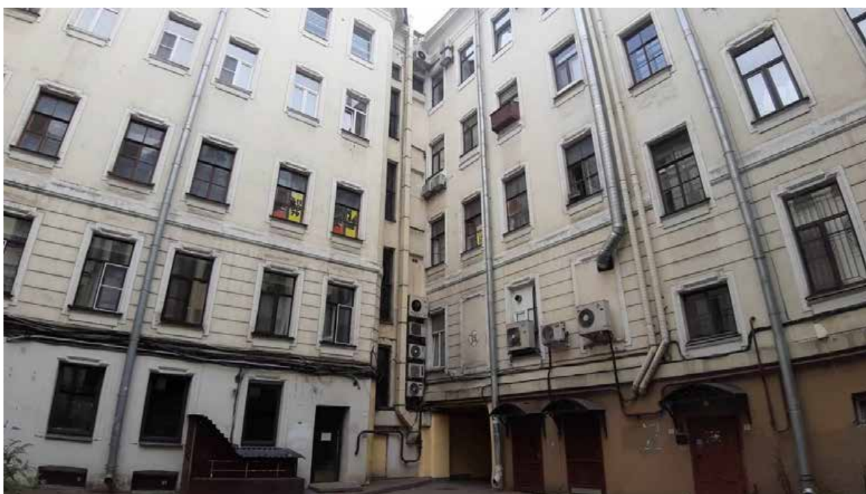
20. «Дом И.И. Ростовцева» (ул. Рубинштейна, д. 2/45, лит. А). Дворовый фасад. Фото мест установки оборудования и прокладки кабельных трасс. Штиглиц М.С. 10.06.2024.
