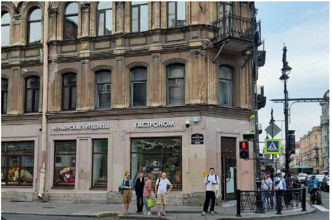
29. «Дом, где с 1881 по 1890 г. жил художественный критик Стасов Владимир Васильевич (б. кв. 6)» (ул. Некрасова, д. 38/26, лит. А). Лицевой фасад. Фото мест установки оборудования и прокладки кабельных трасс. Штиглиц М.С. 10.06.2024.
