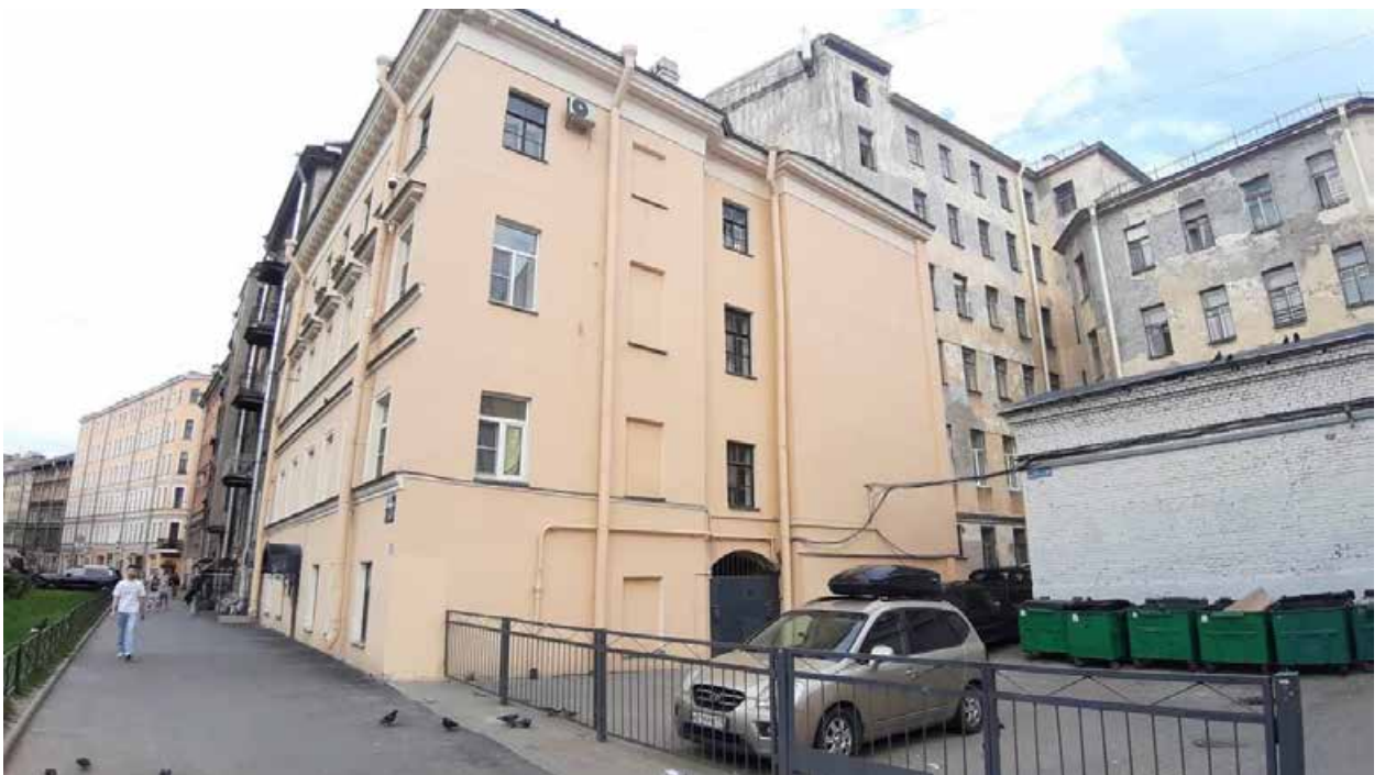
50. «Дом О. Головкина» (ул. Достоевского, д. 28, лит. А). Боковой фасад. Штиглиц М.С. 10.06.2024.
