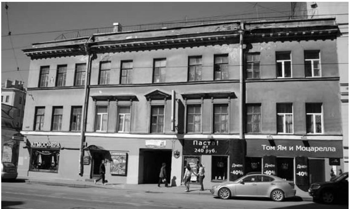
41. «Дом А.С. Гедике (с 1849 г. дом причта церкви св. Симеония и Анны)» (ул. Белинского, д. 6, лит. А). Фото 2016 (29).
