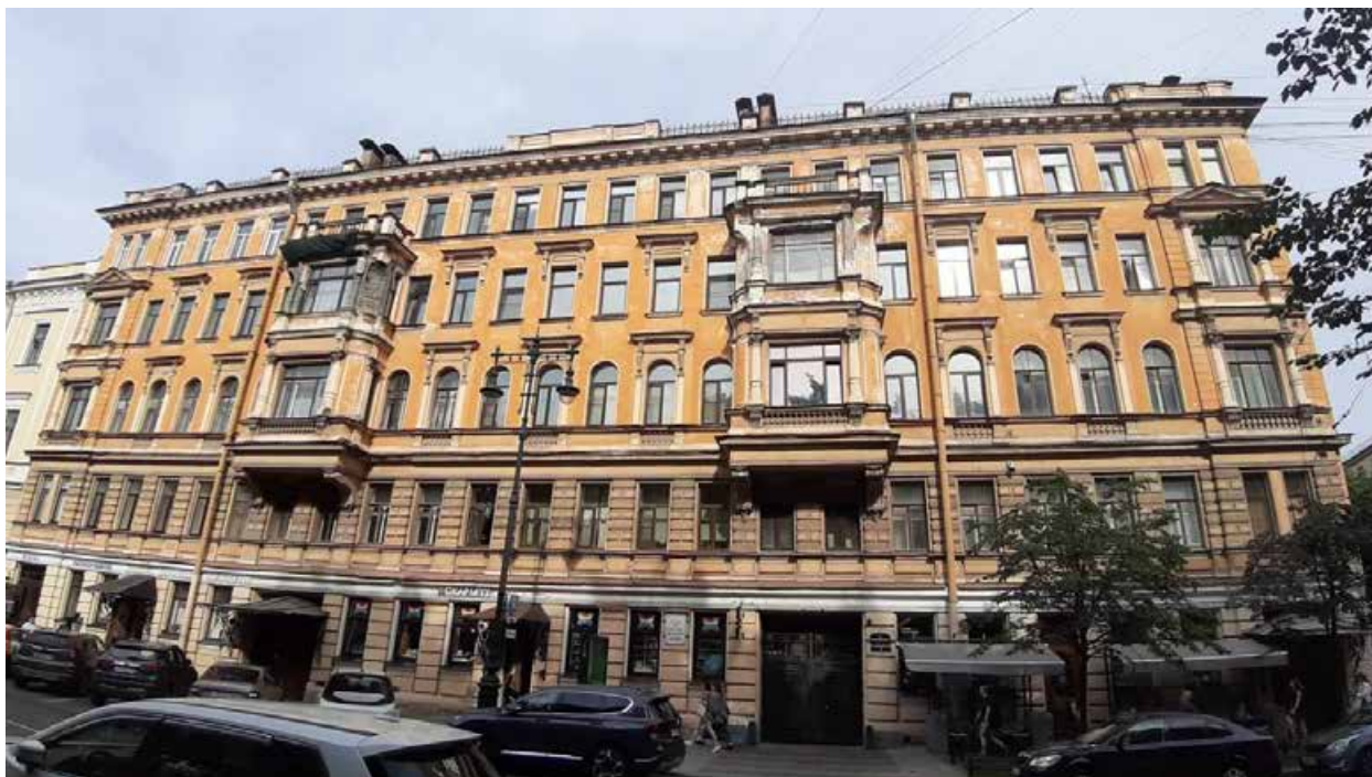
5. «Дом, где в 1910-1927 гг. жил юрист, литератор Кони А.Ф.» (ул. Маяковского, д. 3, лит. А). Лицевой фасад по ул. Маяковского. Штиглиц М.С. 10.06.2024.
