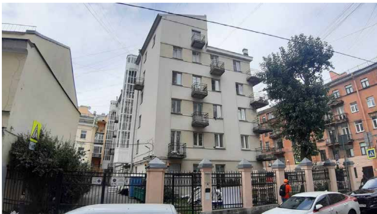
24. «Дом-коммуна инженеров и писателей (с оградой)» (ул. Рубинштейна, д. 7, лит. Б). Боковой фасад. Штиглиц М.С. 10.06.2024.
