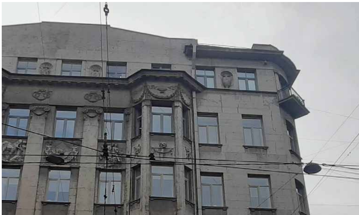
39. «Дом Ш.З. Иофа» (ул. Белинского, д. 13, лит. А). Лицевой фасад. Фото мест установки оборудования и прокладки кабельных трасс. Штиглиц М.С. 10.06.2024.
