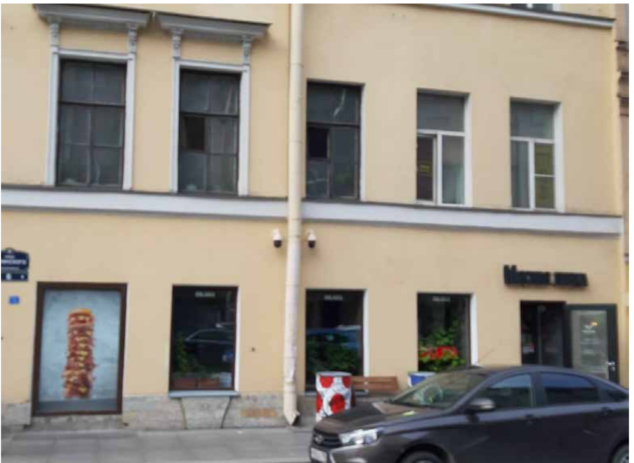
46. «Дом А.С. Гедике (с 1849 г. дом причта церкви св. Симеония и Анны)» (ул. Белинского, д. 6, лит. А). Лицевой фасад. Фото мест установки оборудования и прокладки кабельных трасс. Штиглиц М.С. 10.06.2024.
