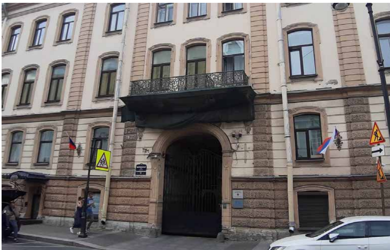
33. «Особняк А.П.Гагариной (дом Н.П.Жеребцовой)» (Миллионная ул., д. 11, лит. А). Лицевой фасад. Фото мест установки оборудования и прокладки кабельных трасс. Штиглиц М.С. 10.06.2024.
