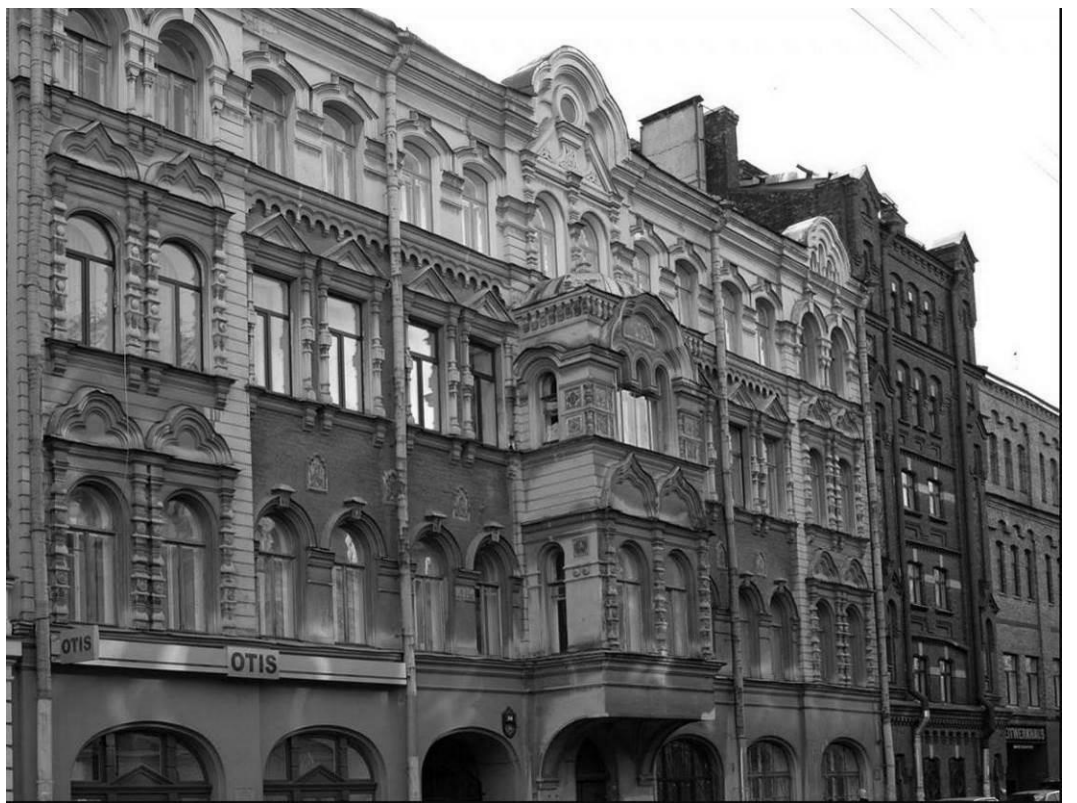
39. «Дом Н.Н. Никонова» (ул. Достоевского, д. 38, лит. А). Фото 2008 (23).
