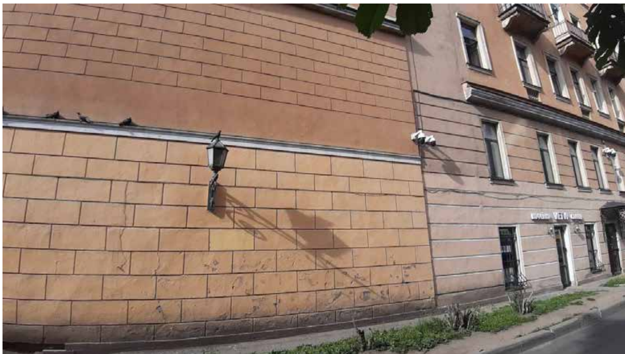
7.«Дом, где в 1910-1927 гг. жил юрист, литератор Кони А.Ф.» (ул. Маяковского, д. 3, лит. А). Боковой фасад. Фото мест установки оборудования и прокладки кабельных трасс. Штиглиц М.С. 10.06.2024.
