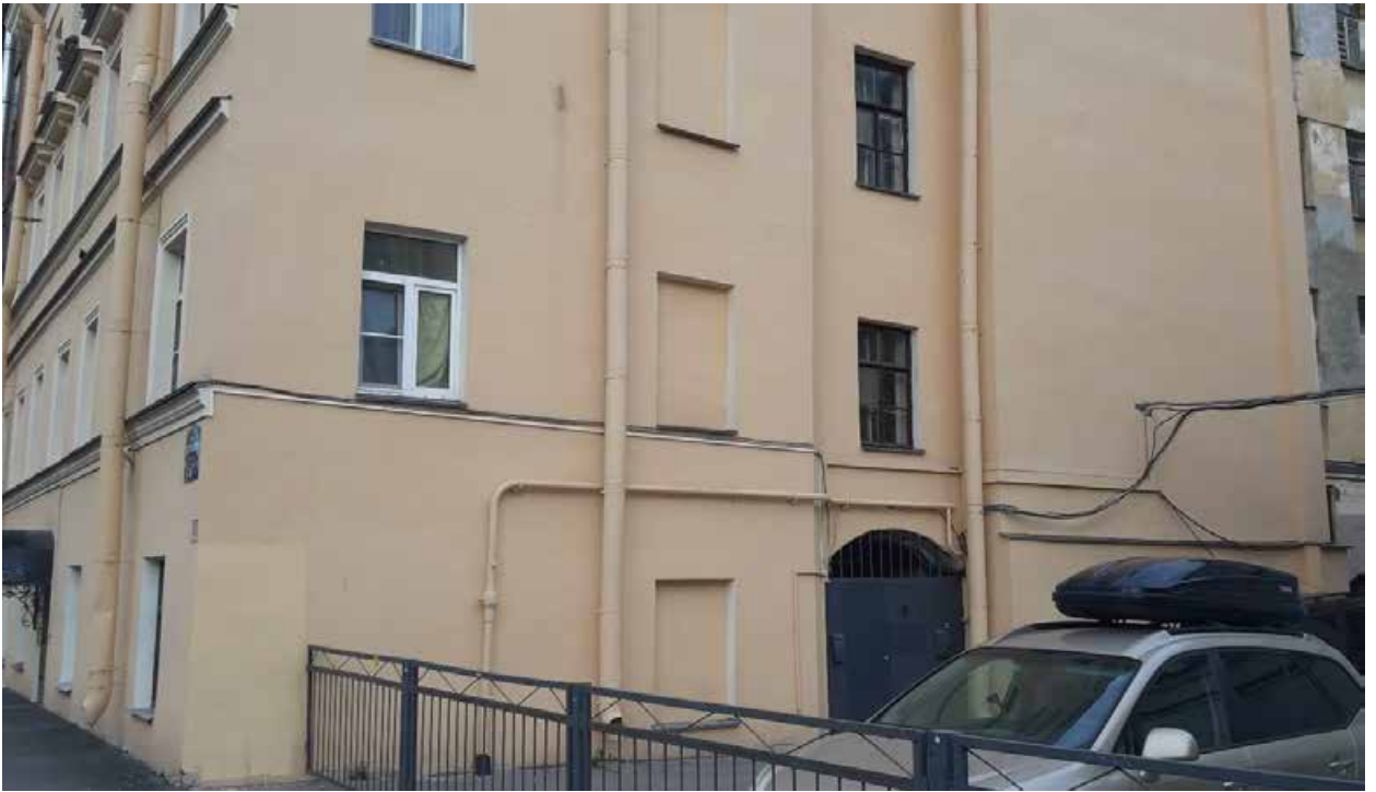
51. «Дом О. Головкина» (ул. Достоевского, д. 28, лит. А). Боковой фасад. Фото мест установки оборудования и прокладки кабельных трасс. Штиглиц М.С. 10.06.2024.
