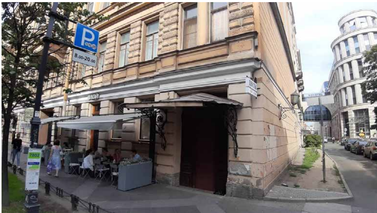
9. «Дом, где в 1910-1927 гг. жил юрист, литератор Кони А.Ф.» (ул. Маяковского, д. 3, лит. А). Лицевой фасад. Фото мест установки оборудования и прокладки кабельных трасс. Штиглиц М.С. 10.06.2024.
