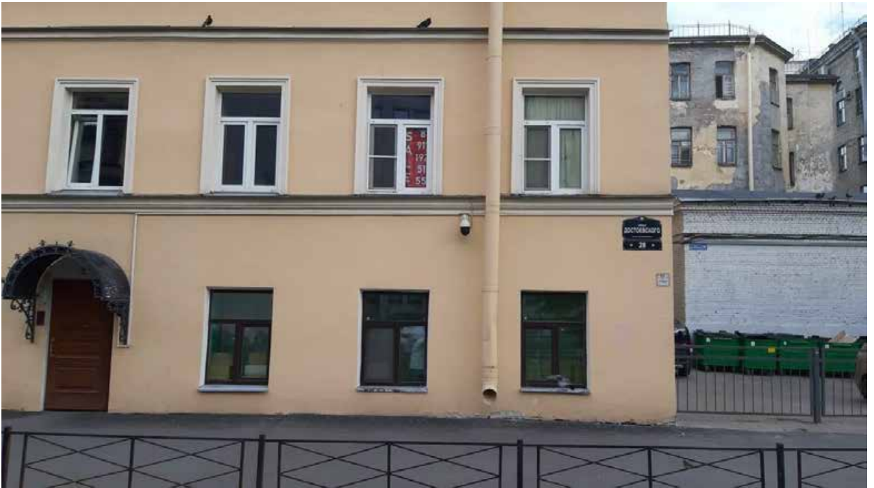
49. «Дом О. Головкина» (ул. Достоевского, д. 28, лит. А). Лицевой фасад. Фото мест установки оборудования и прокладки кабельных трасс. Штиглиц М.С. 10.06.2024.
