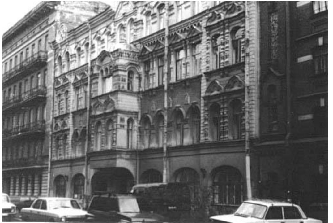
38. «Дом Н.Н. Никонова» (ул. Достоевского, д. 38, лит. А). Фото 2008 (23).
