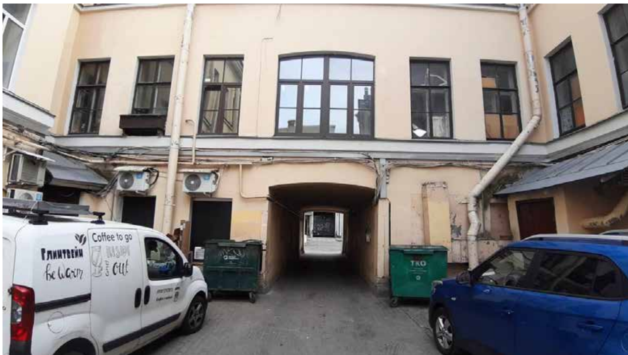
47. «Дом А.С. Гедике (с 1849 г. дом причта церкви св. Симеония и Анны)» (ул. Белинского, д. 6, лит. А). Дворовый фасад. Фото мест установки оборудования и прокладки кабельных трасс. Штиглиц М.С. 10.06.2024.
