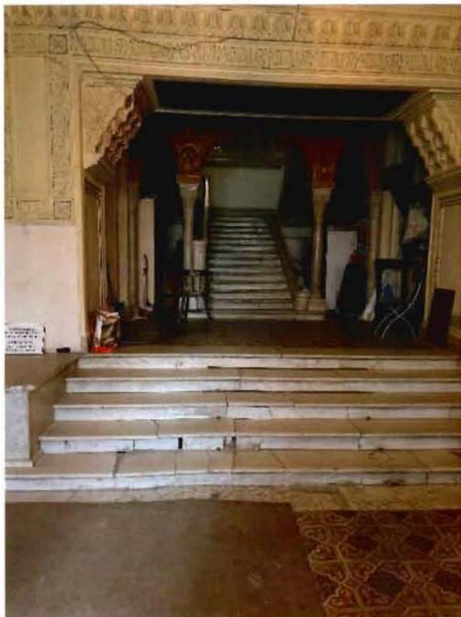
16, 17. Лестница 2ЛК в уровне 1-го и 2-го этажей.
