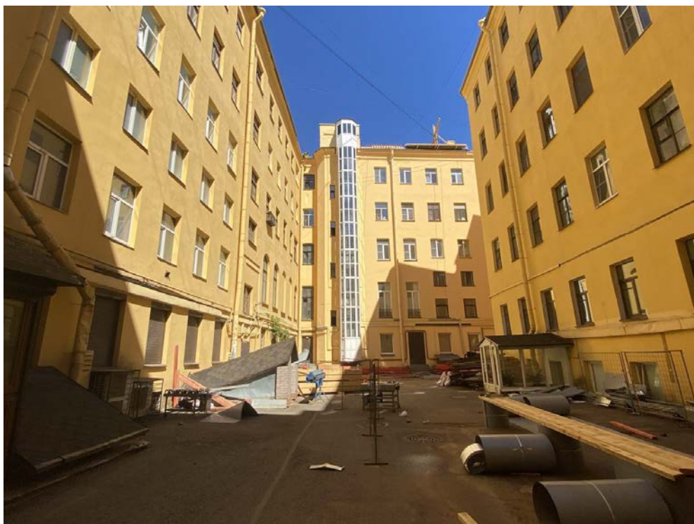
Рисунок 5. Фрагмент дворового фасада объекта культурного наследия регионального значения «Доходный дом князя А.Д. Мурузи»
