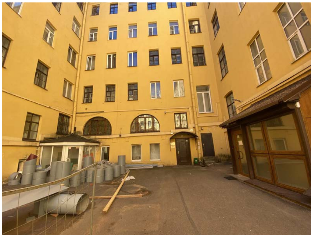
Рисунок 7. Фрагмент дворового фасада объекта культурного наследия регионального значения «Доходный дом князя А.Д. Мурузи»
