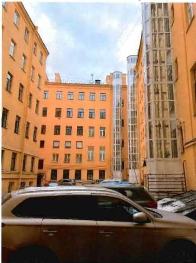
8. Дворовые фасады восточного колодца (южный, западный и восточный фасады).
