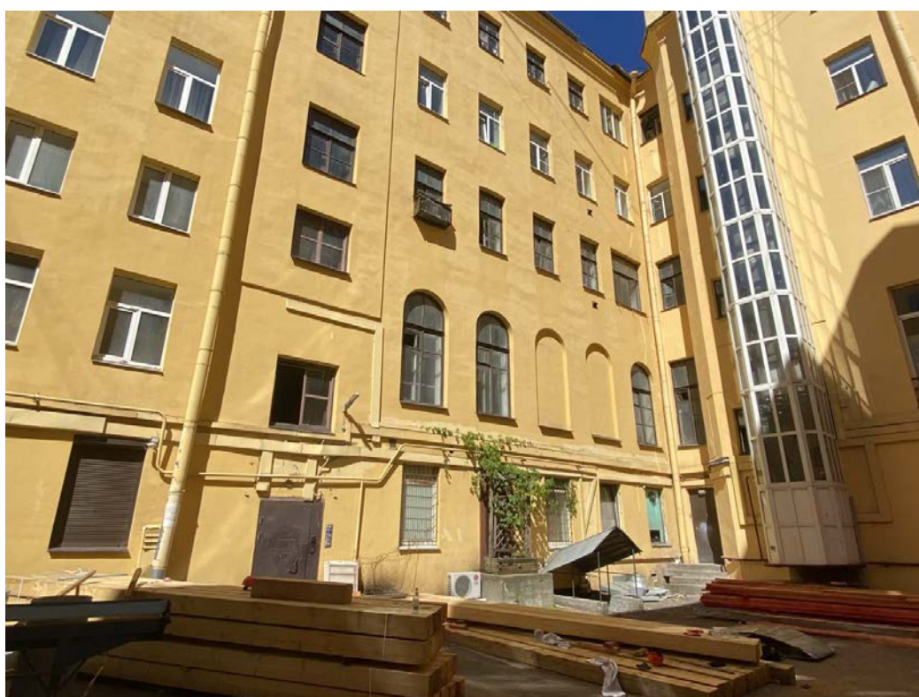
Рисунок 10. Фрагмент дворового фасада объекта культурного наследия регионального значения «Доходный дом князя А.Д. Мурузи»
