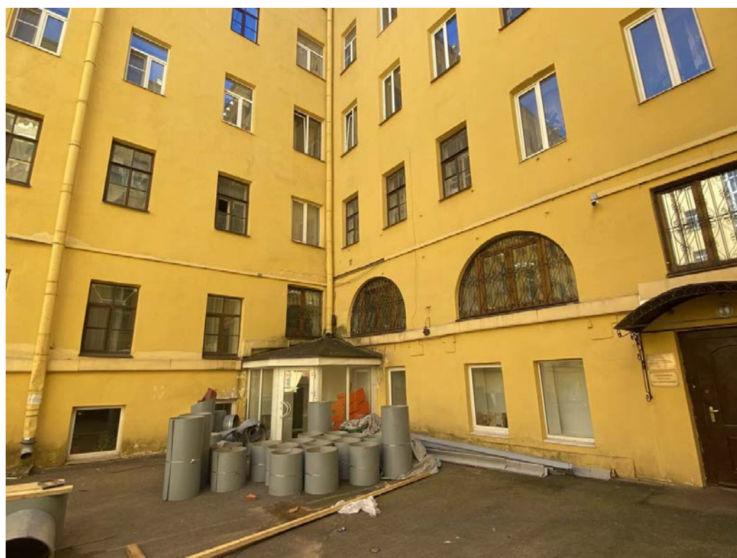
Рисунок 8. Фрагмент дворового фасада объекта культурного наследия регионального значения «Доходный дом князя А.Д. Мурузи»
