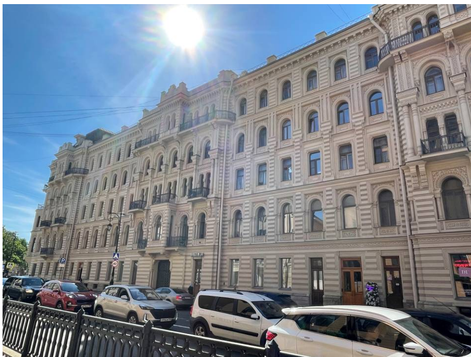
Рисунок 1. Лицевой фасад объекта культурного наследия регионального значения «Доходный дом князя А.Д. Мурузи» (по ул. Пестеля)
