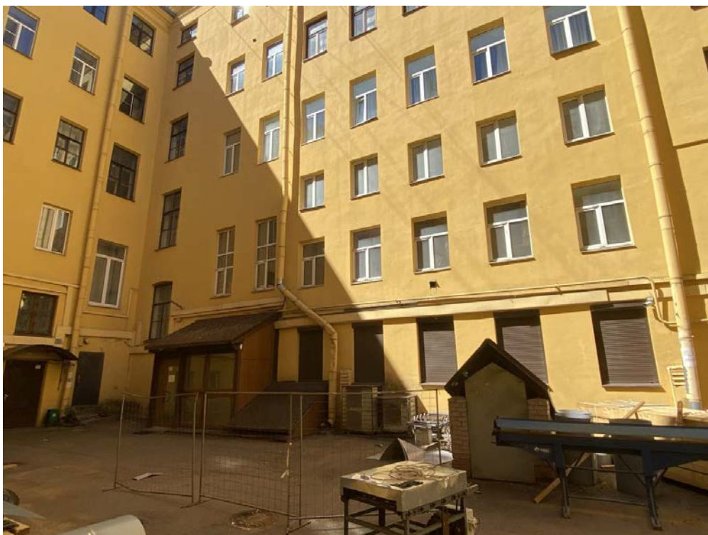
Рисунок 9. Фрагмент дворового фасада объекта культурного наследия регионального значения «Доходный дом князя А.Д. Мурузи»
