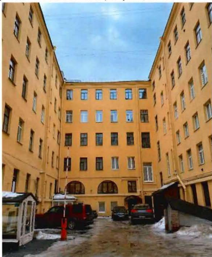
10. Дворовые фасады западного колодца (северный, восточный и западный фасады).
