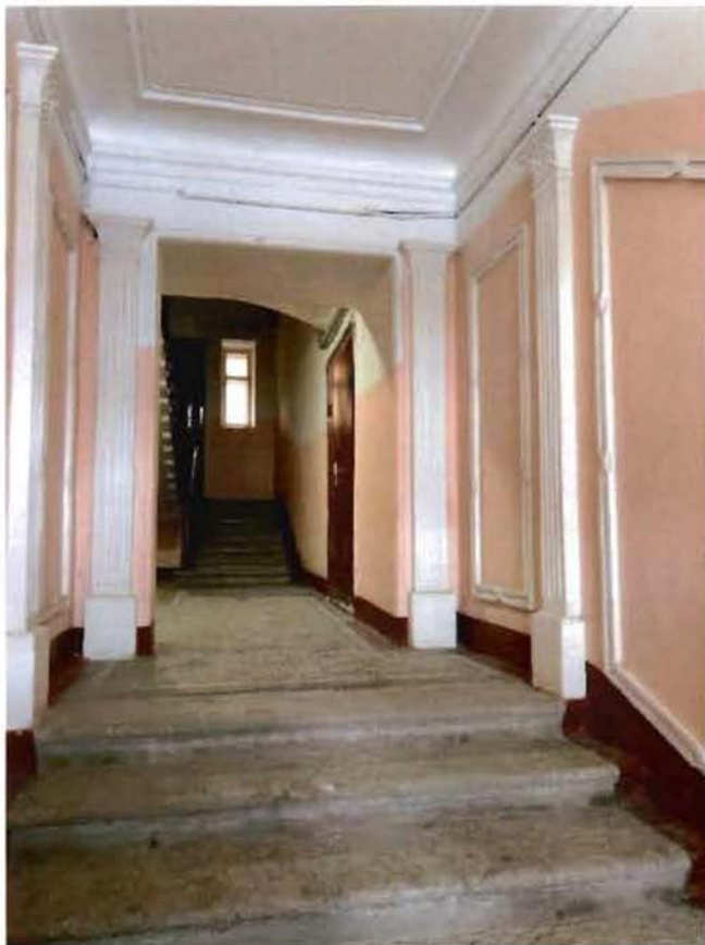
14, 15. Лестница 5ЛК в уровне 1-го и 2-го этажей.
