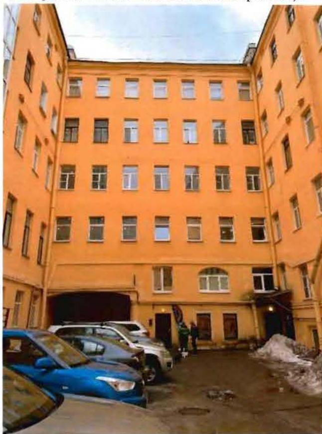
9. Дворовые фасады восточного колодца (северный, западный и восточный фасады).
