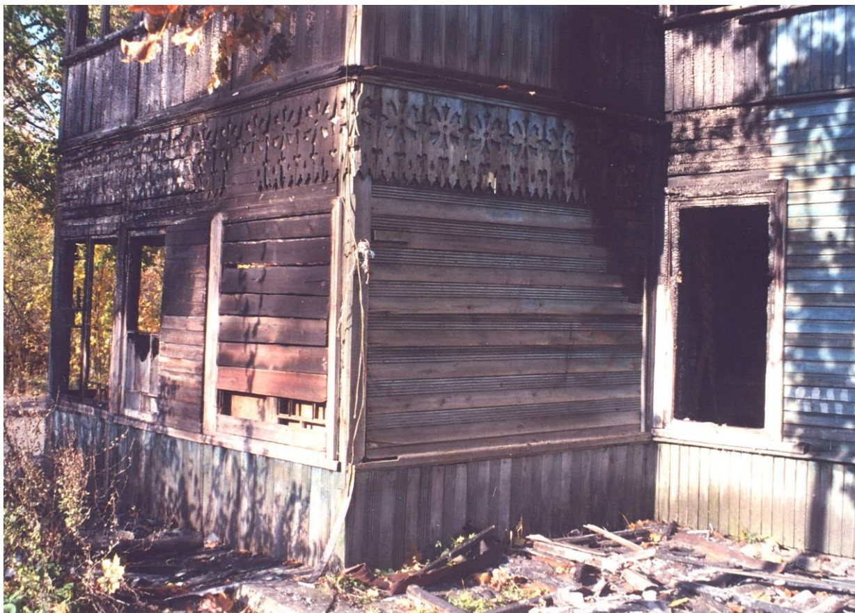
Илл. 18. Вид нижнего уровня веранды здания с юго-восточной стороны. Фотография. 2004 г.
