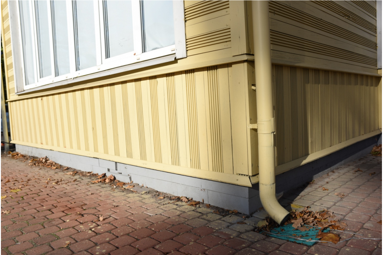
6. Оформление цоколя по периметру здания.
