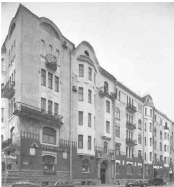
49. Доходный дом А.Ф. Циммермана. Фрагмент фасада по ул. Чапыгина // Иллюстрация из книги Б.М. Кирикова «Архитектура Петербургского модерна. Особняки и доходные дома». 2012.
