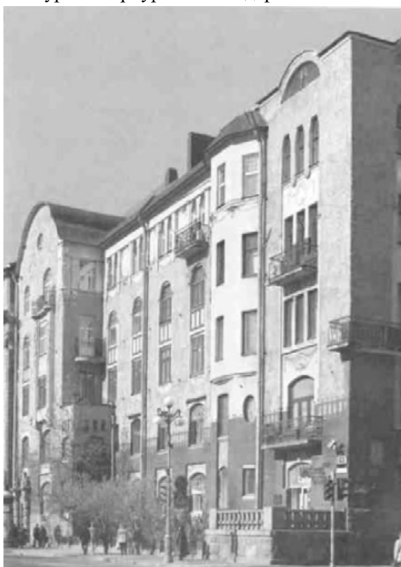
48. Доходный дом А.Ф. Циммермана. Фрагмент фасада по Каменноостровскому проспекту // Иллюстрация из книги Б.М. Кирикова «Архитектура Петербургского модерна. Особняки и доходные дома». 2012 .
