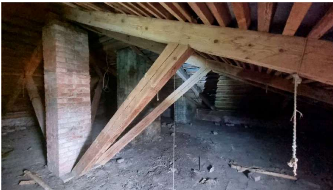
57. Выявленный объект культурного наследия «Казарма Офицерской стрелковой школы» по адресу: Санкт-Петербург, г. Ломоносов, Владимирская ул., д.12, литера А
