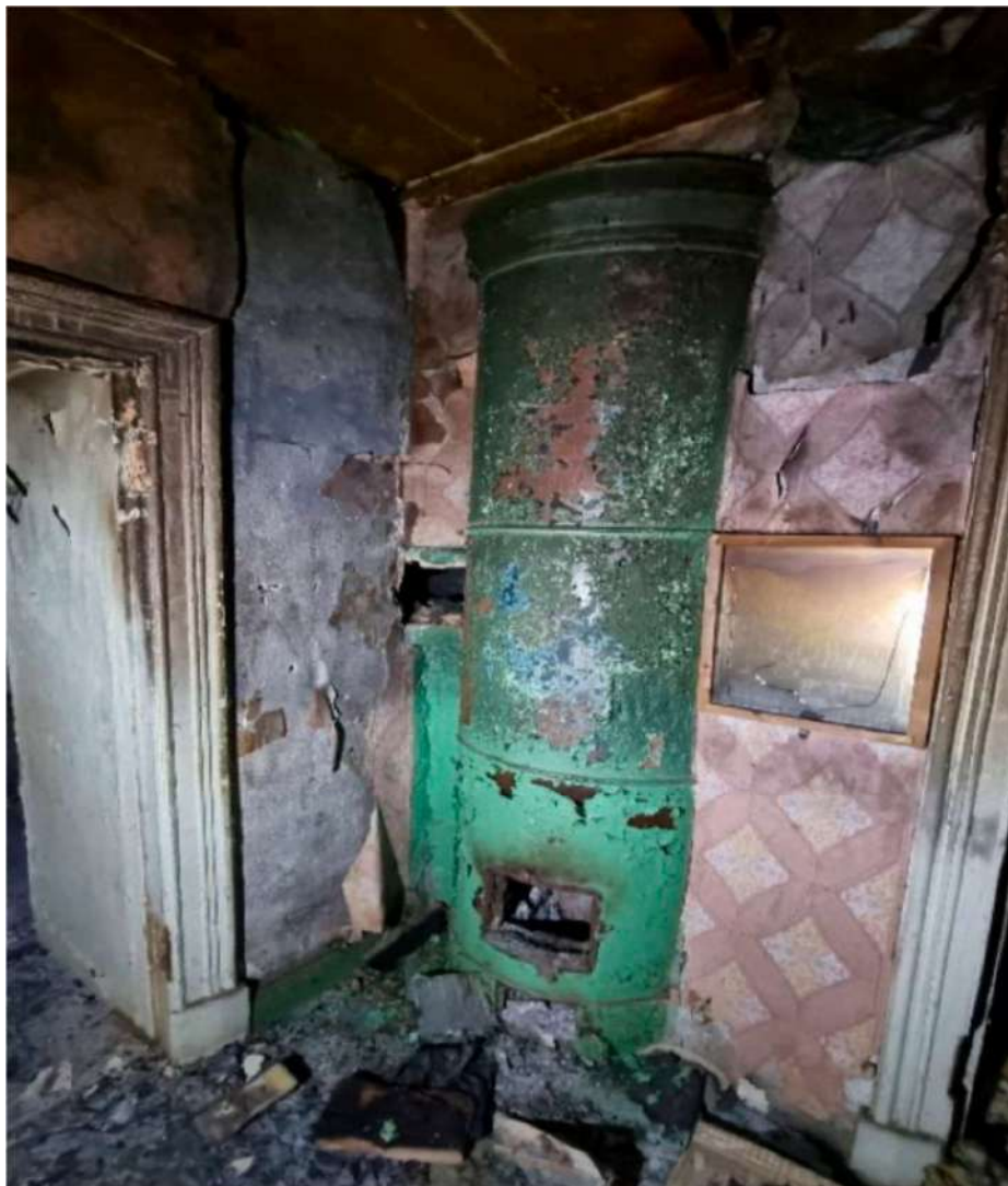
48. Выявленный объект культурного наследия «Казарма Офицерской стрелковой школы» по адресу: Санкт-Петербург, г. Ломоносов, Владимирская ул., д.12, литер А
