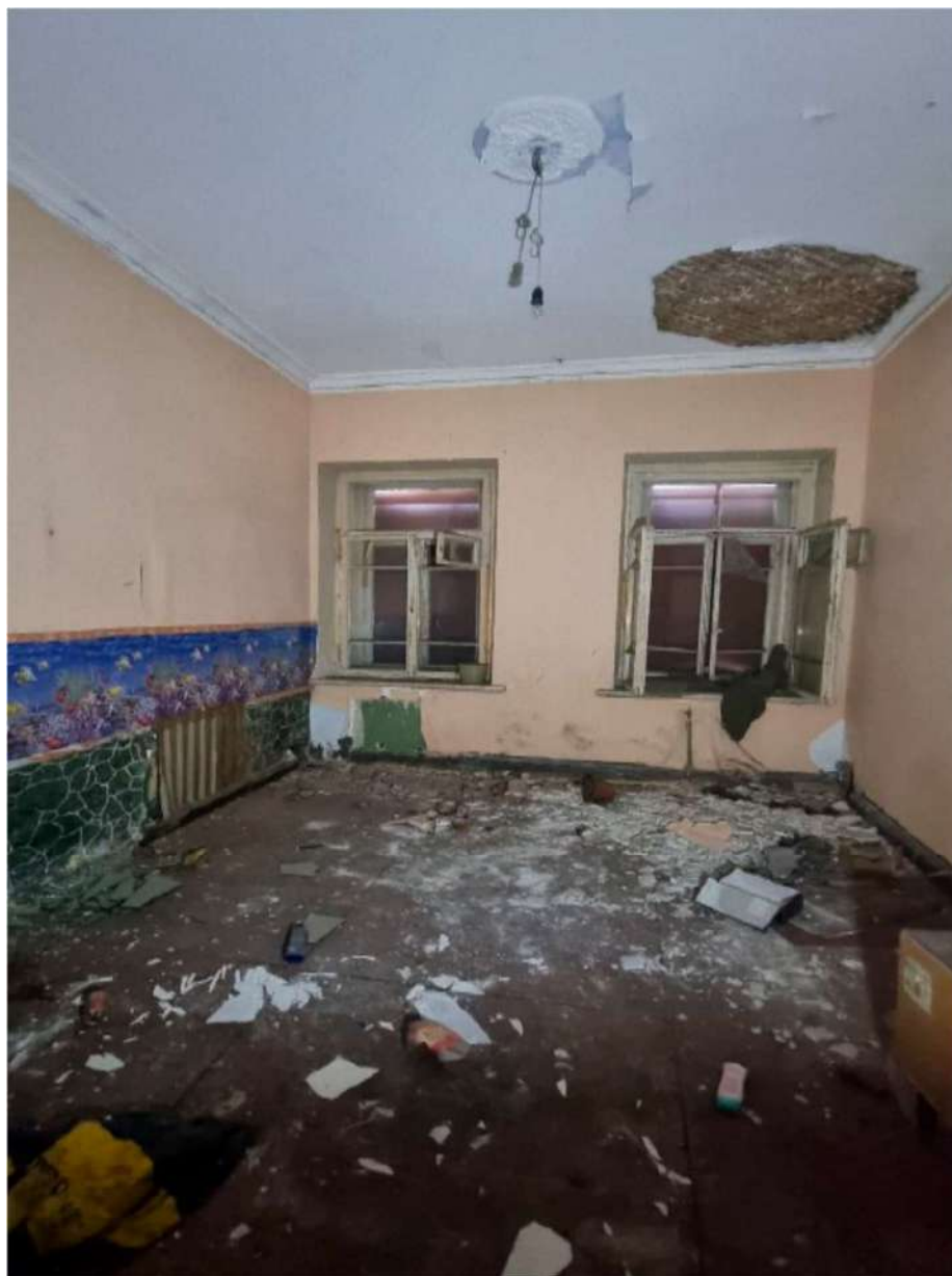
26. Выявленный объект культурного наследия «Казарма Офицерской стрелковой школы» по адресу: Санкт-Петербург, г. Ломоносов, Владимирская ул., д.12, литер А
