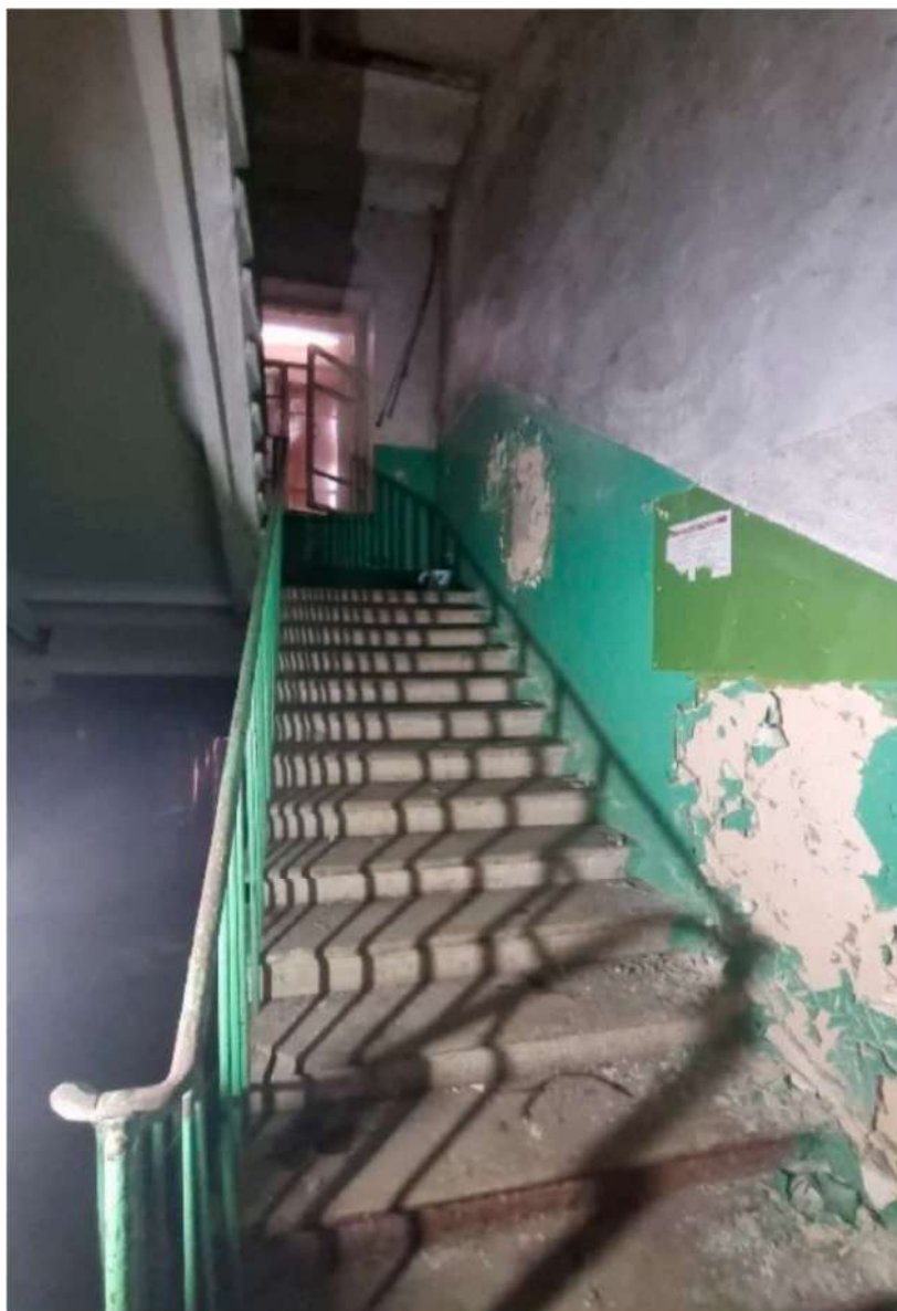
22. Выявленный объект культурного наследия «Казарма Офицерской стрелковой школы» по адресу: Санкт-Петербург, г. Ломоносов, Владимирская ул., д.12, литера А Лестница ЛК 2 Дата съемки: 23.10.2023
