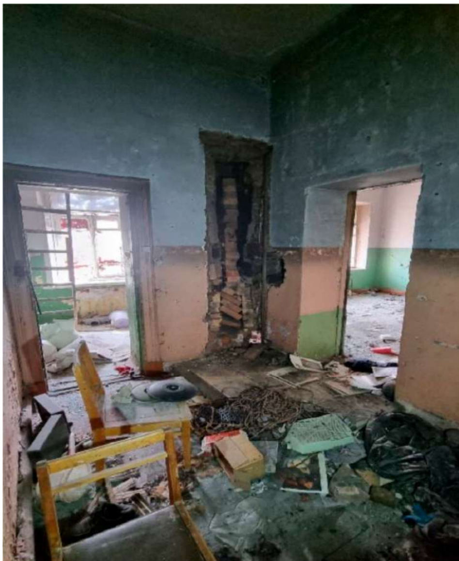
44. Выявленный объект культурного наследия «Казарма Офицерской стрелковой школы» по адресу: Санкт-Петербург, г. Ломоносов, Владимирская ул., д.12, литера А
