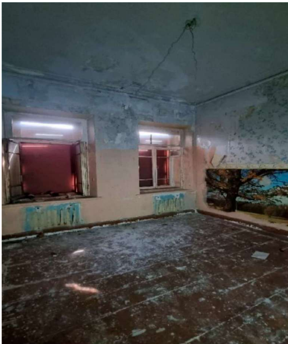
46. Выявленный объект культурного наследия «Казарма Офицерской стрелковой школы» по адресу: Санкт-Петербург, г. Ломоносов, Владимирская ул., д.12, литера А
