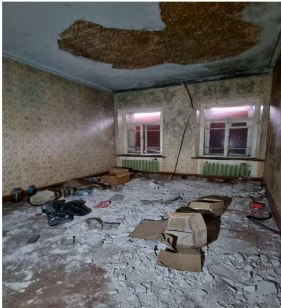
53. Выявленный объект культурного наследия «Казарма Офицерской стрелковой школы» по адресу: Санкт-Петербург, г. Ломоносов, Владимирская ул., д.12, литер А
