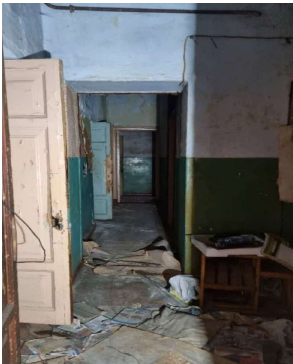
15. Выявленный объект культурного наследия «Казарма Офицерской стрелковой школы» по адресу: Санкт-Петербург, г. Ломоносов, Владимирская ул., д.12, литера А
