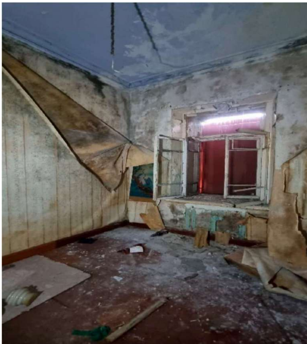
50. Выявленный объект культурного наследия «Казарма Офицерской стрелковой школы» по адресу: Санкт-Петербург, г. Ломоносов, Владимирская ул., д.12, литера А
