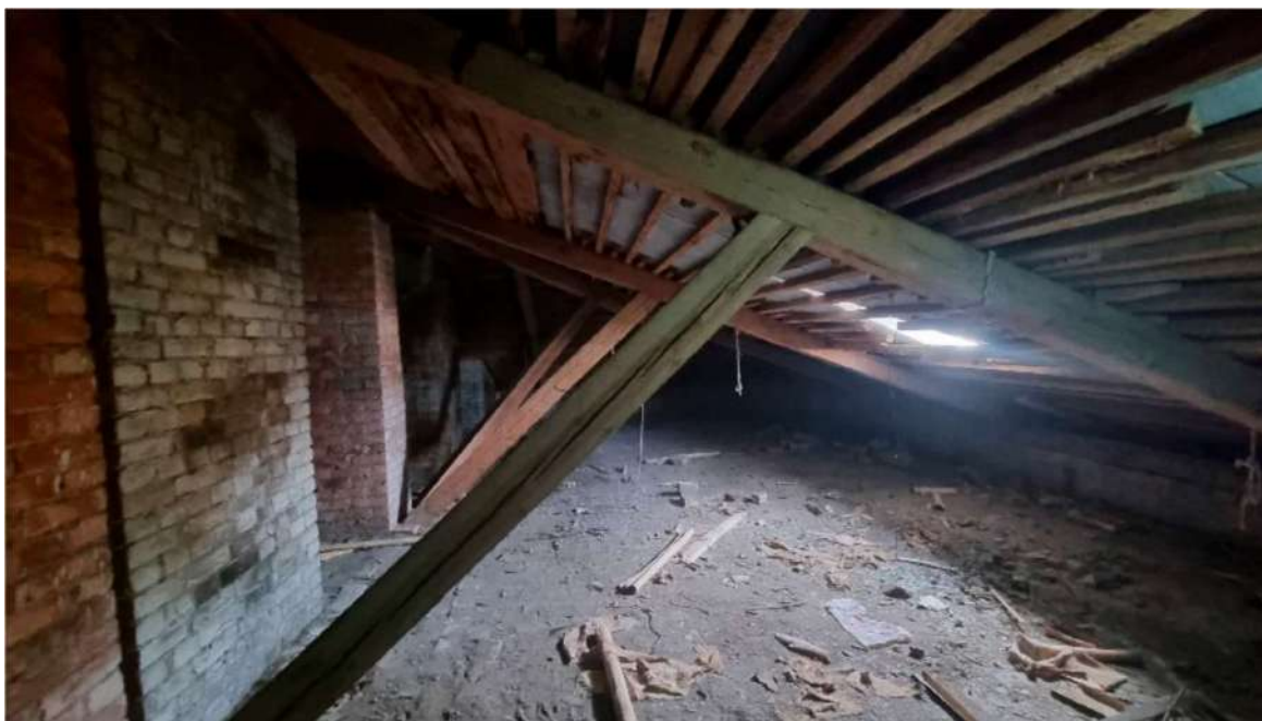
56. Выявленный объект культурного наследия «Казарма Офицерской стрелковой школы» по адресу: Санкт-Петербург, г. Ломоносов, Владимирская ул., д.12, литера А
