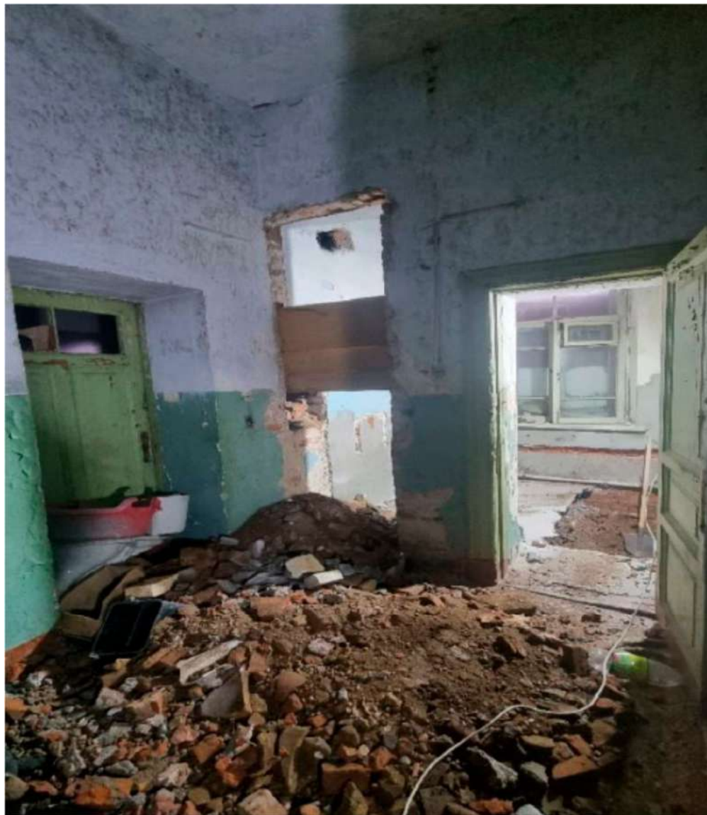
27. Выявленный объект культурного наследия «Казарма Офицерской стрелковой школы» по адресу: Санкт-Петербург, г. Ломоносов, Владимирская ул., д.12, литера А
