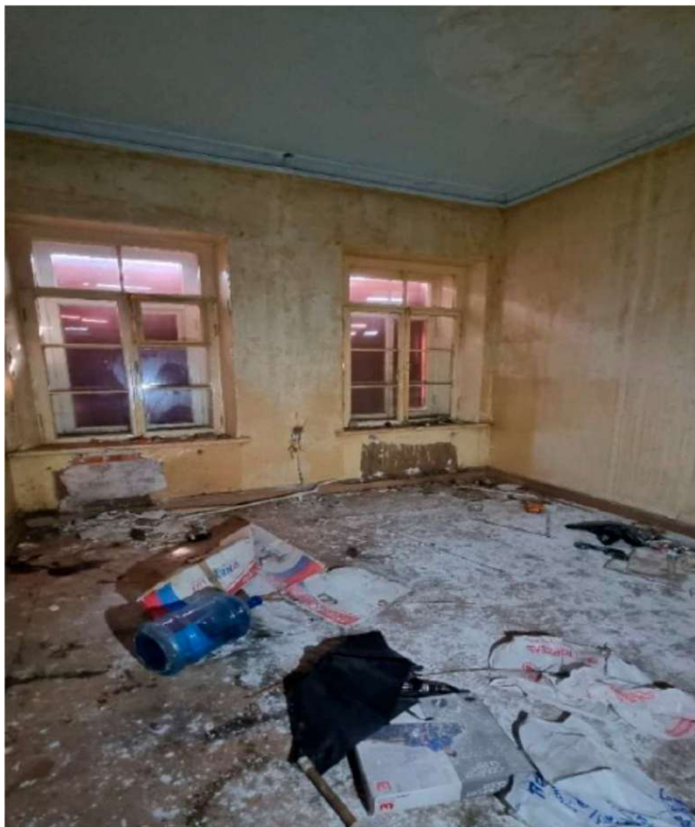
54. Выявленный объект культурного наследия «Казарма Офицерской стрелковой школы» по адресу: Санкт-Петербург, г. Ломоносов, Владимирская ул., д.12, литер А
