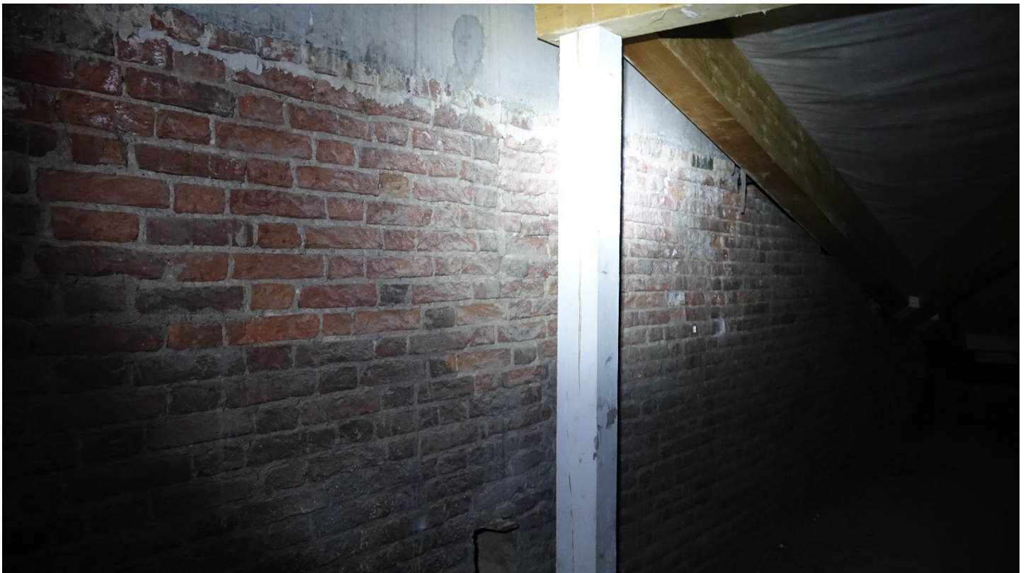
Фото 10. Фрагмент кирпичной кладки на уровне чердака. Дата фотофиксации: 15.07.2024
