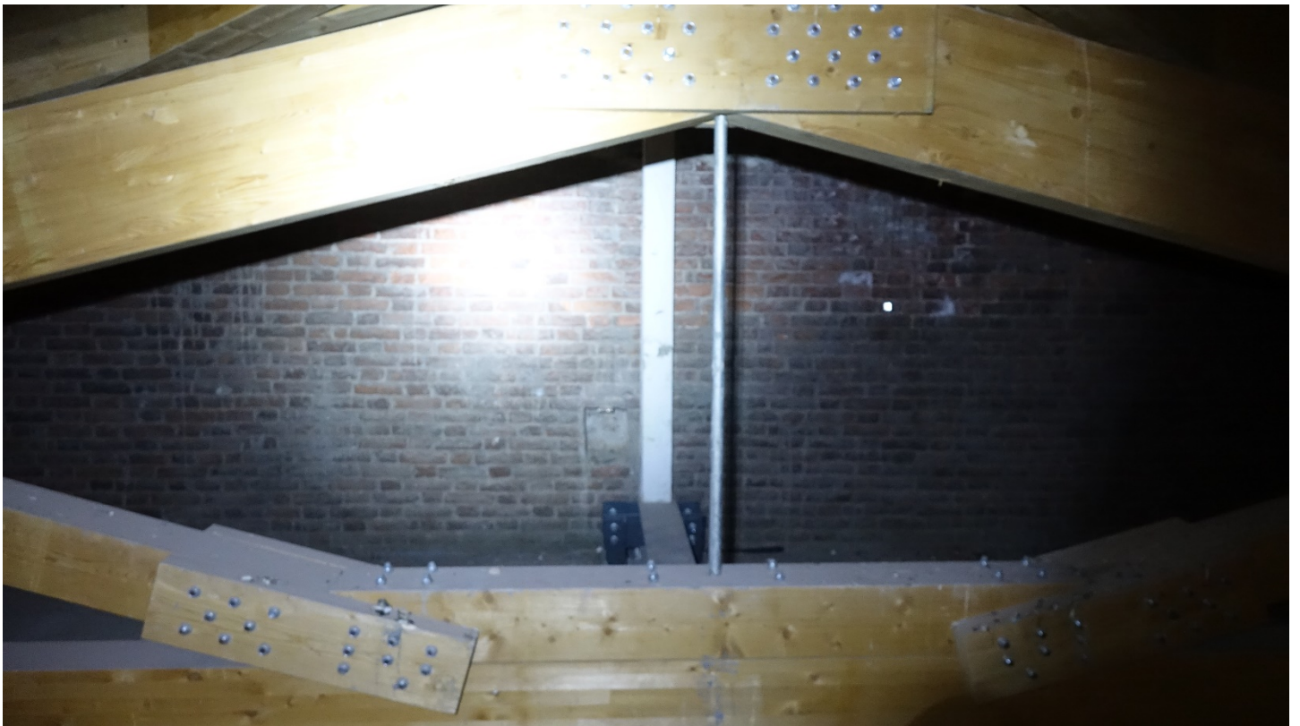
Фото 8. Стена фронтона на уровне чердака. Общий вид. Дата фотофиксации: 15.07.2024
