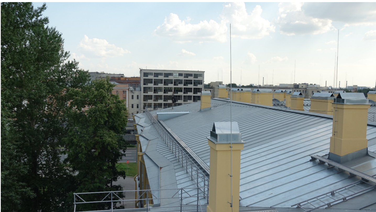
Фото 16. Вид на Обводный канал и юго-восточную часть здания с местоположения постаumenta. Дата фотофиксации: 15.07.2024
