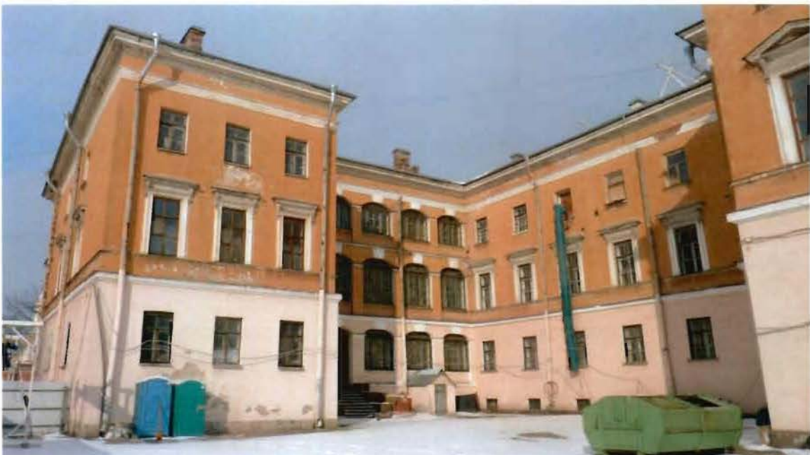
5. Объект культурного наследия. Дворовые фасады. Северный флигель. Вид с юга.
