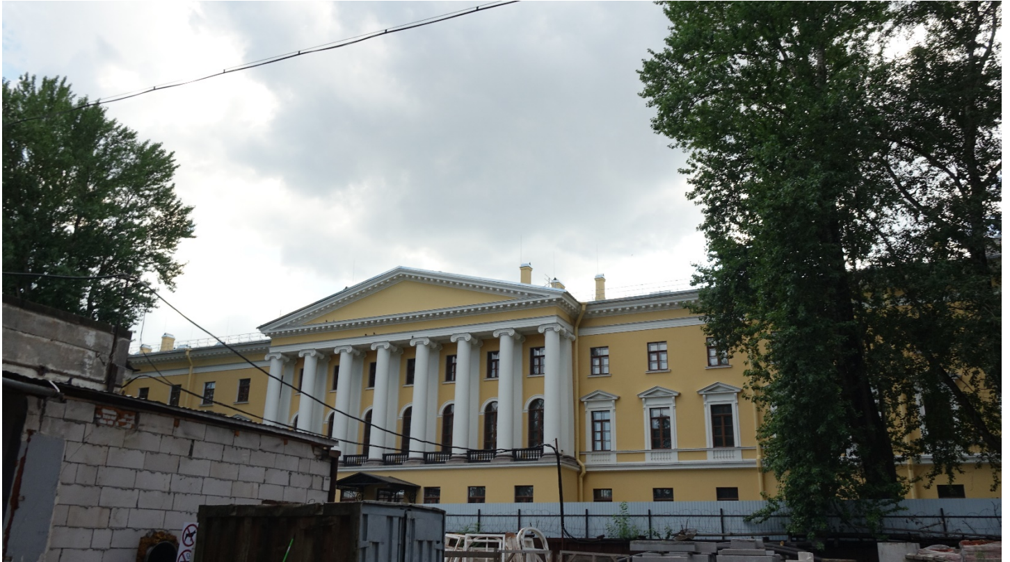
Фото 5. Лицевой фасад здания и центральный портик. Общий вид. Дата фотофиксации: 15.07.2024
