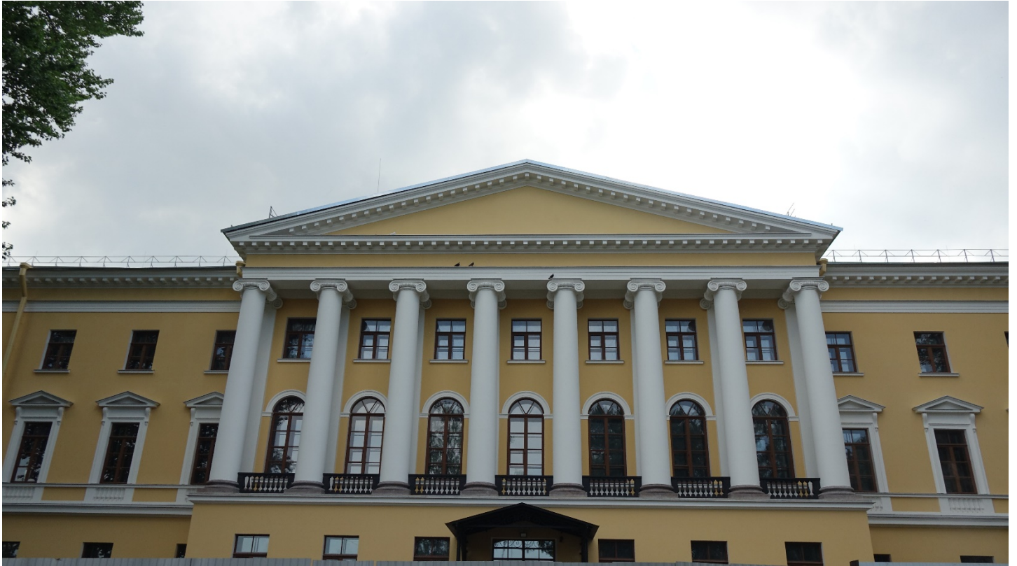
Фото 7. Центральный портик лицевого фасада. Общий вид. Дата фотофиксации: 15.07.2024
