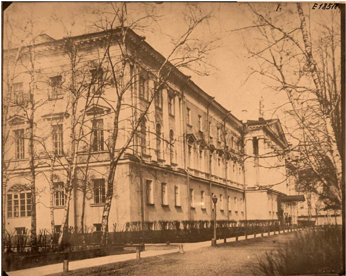
Илл.17. Главный и южный фасады здания Духовной Академии. 1910-е гг.
