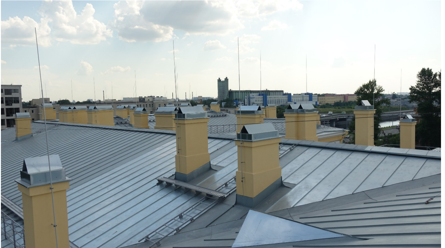
Фото 17. Общий вид на юго-западную часть здания и панораму города с местоположения постомента. Дата фотофиксации: 15.07.2024
