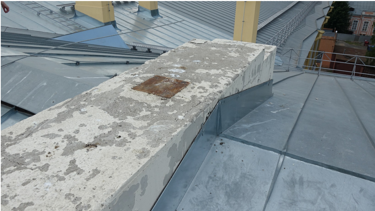
Фото 15. Место фиксации скульптурной группы на постаменте. Фрагмент. Дата фотофиксации: 15.07.2024
