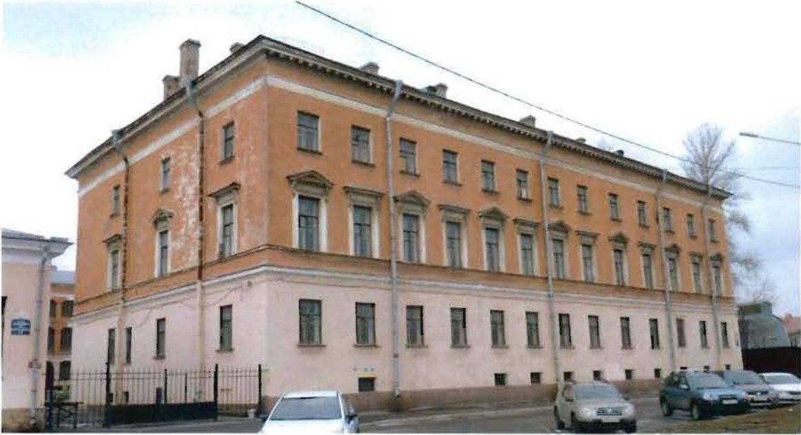
3. Объект культурного наследия. Южный фасад. Вид с юга.
