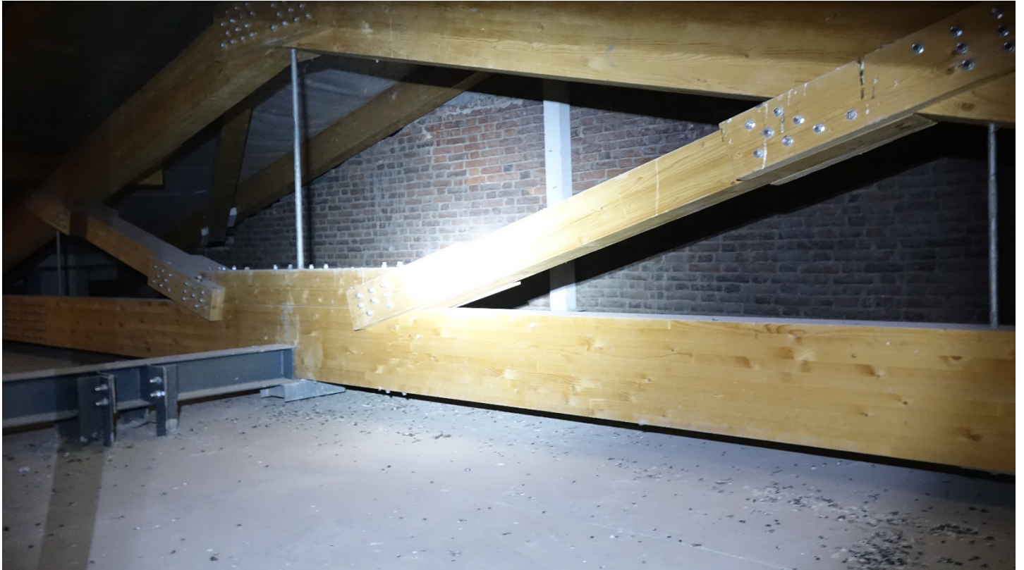
Фото 9. Элементы стропильной системы на уровне чердака. Дата фотофиксации: 15.07.2024
