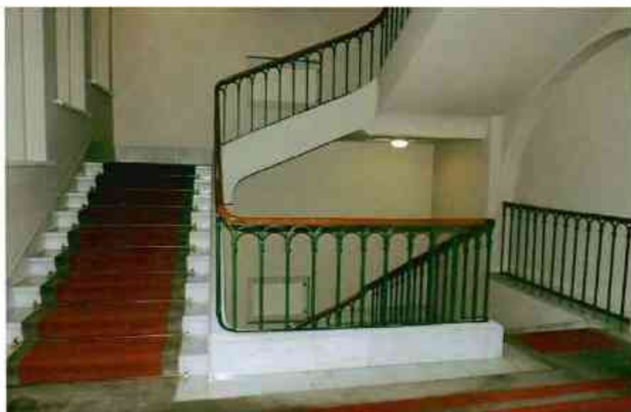
36. Лестница в юго-восточной части здания.
