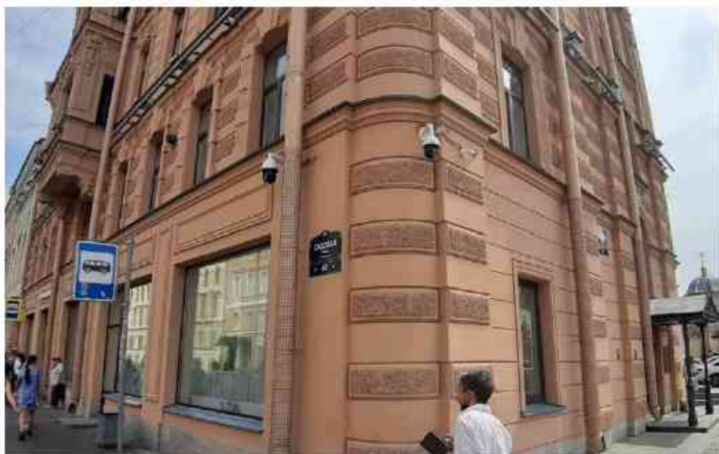
22. Доходный дом Успенской церкви (Садовая ул., д. 40, лит. Б). Лицевой фасад. Фото мест установки оборудования и прокладки кабельных трасс. Штиглиц М.С. 11.06.2024.
