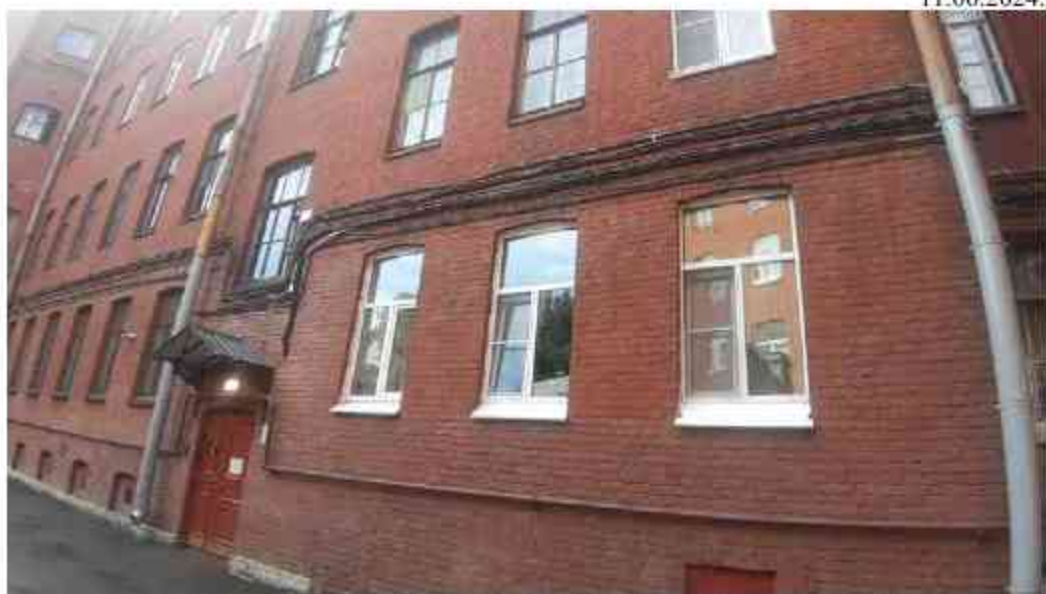
42. Доходный дом (в составе «Дом и фабрика шелковых изделий А.И.Ниссена») (наб. реки Фонтанки, д. 183, лит. А). Дворовый фасад. Фото мест установки оборудования и прокладки кабельных трасс. Штиглиц М.С. 11.06.2024.
