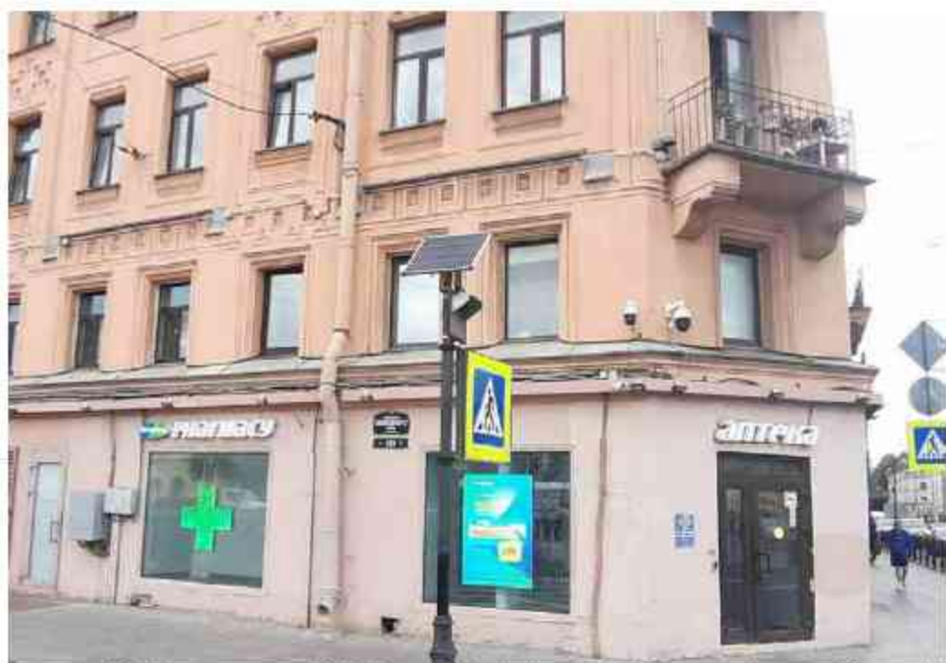
29. Доходные дома Н.И. Львовой (А.Д. Сивкова) (Московский пр., д. 63, лит.А). Лицевой фасад. Фото мест установки оборудования и прокладки кабельных трасс. Штиглиц М.С. 11.06.2024.
