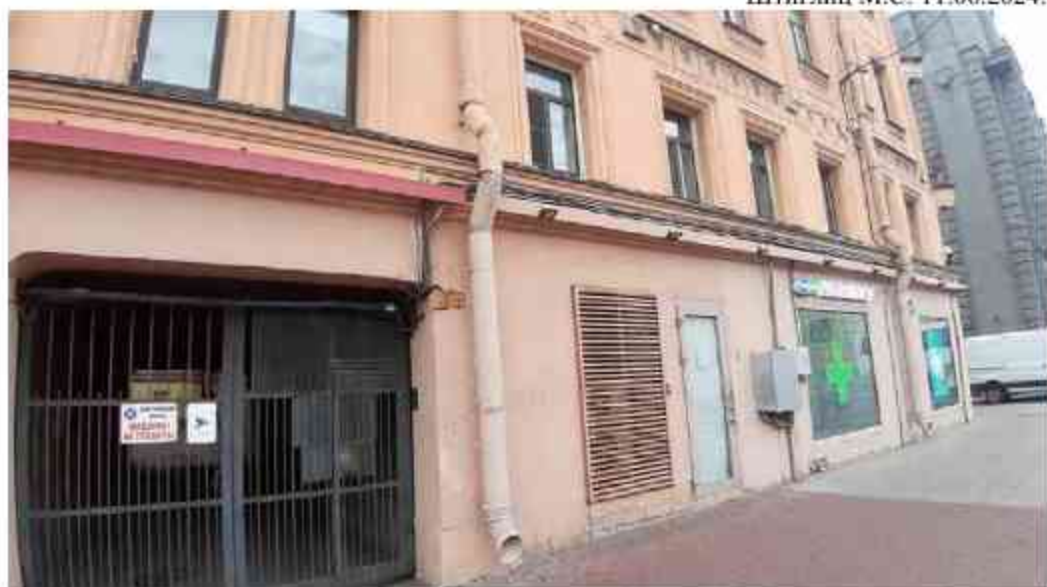
30. Доходные дома Н.И. Львовой (А.Д. Сивкова) (Московский пр., д. 63, лит.А). Лицевой фасад. Фото мест установки оборудования и прокладки кабельных трасс. Штиглиц М.С. 11.06.2024.
