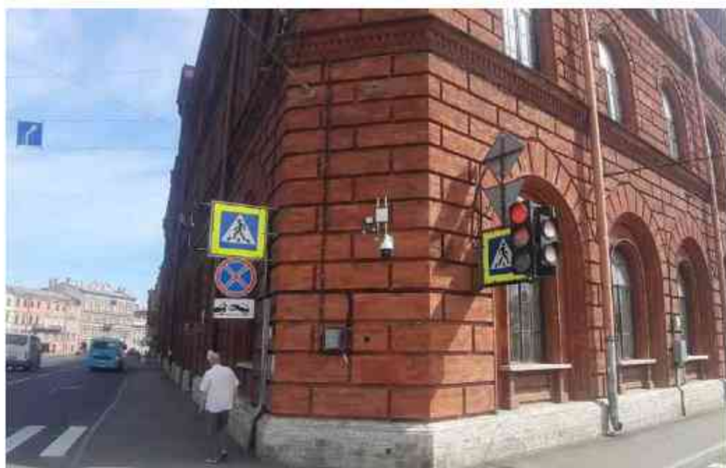
18. Съезжий дом 4-й Адмиралтейской (Коломенской) части (пл. Репина, 1/201, лит. А). Лицевой фасад. Фото мест установки оборудования и прокладки кабельных трасс. Штиглиц М.С. 11.06.2024.
