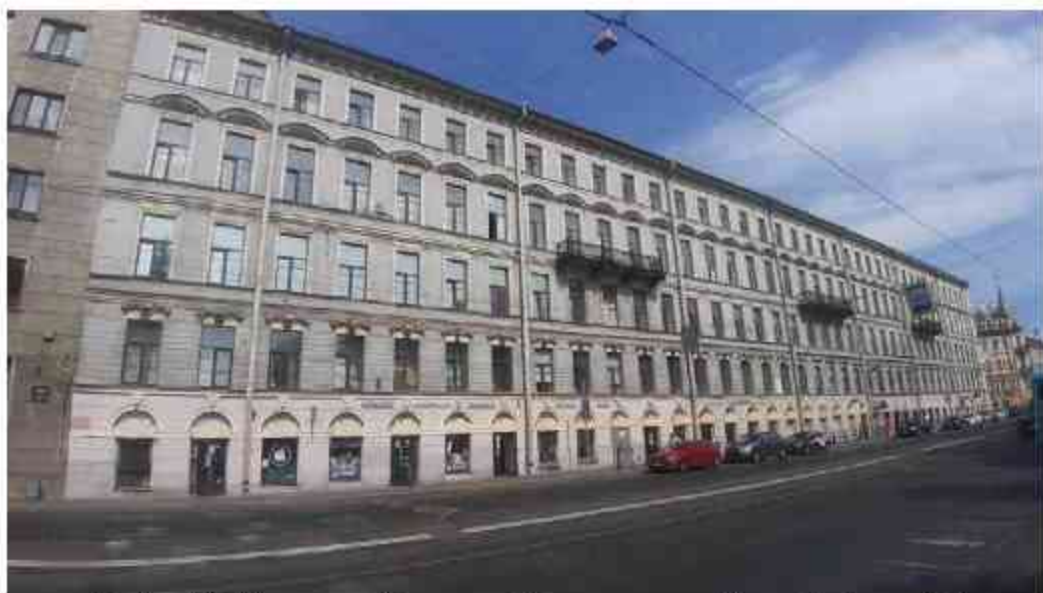
45. Дом Г.Р. Державина (Кукановых) (Садовая, ул., д. 51, лит.А). Лицевой фасад по Садовой ул. Штиглиц М.С. 11.06.2024.
