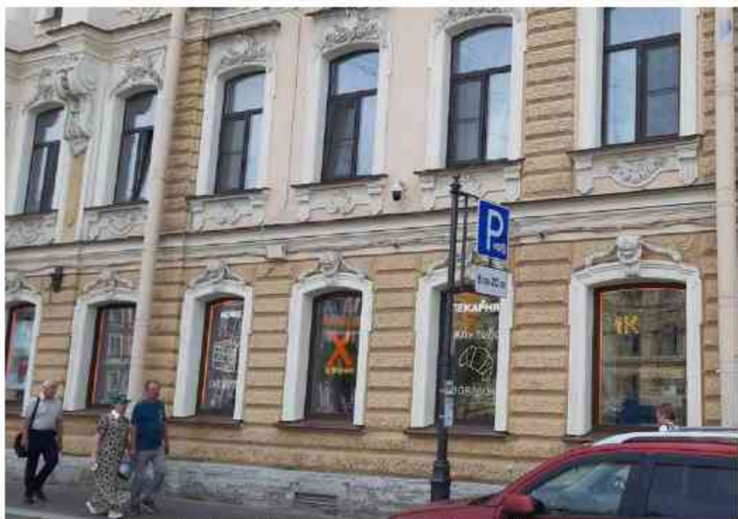
36. Дом Липина (наб. реки Мойки, 62/2, лит. А). Лицевой фасад. Фото мест установки оборудования и прокладки кабельных трасс. Штиглиц М.С. 11.06.2024.
