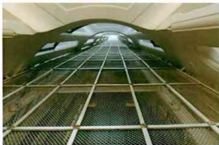
34. Лестничные марши парадной лестницы и шахты лифта. Вид сверху.
