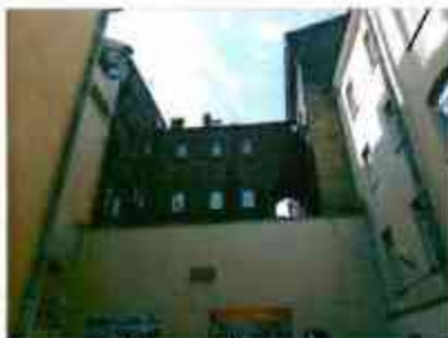
9. Северный фасад здания.
