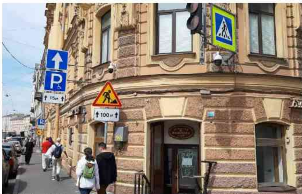
14. Дом С.О. Китнера (наб. канала Грибоедова, д. 79/23, лит. А). Лицевой фасад. Фото мест установки оборудования и прокладки кабельных трасс. Штиглиц М.С. 11.06.2024.
