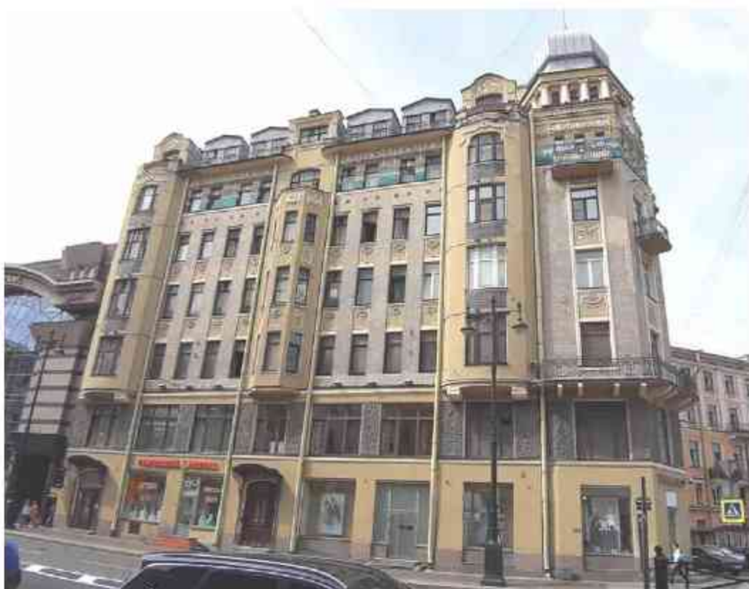
23. Дом Я.И. Перетца (Московский пр., д. 1/2, лит.А). Лицевой фасад по Московскому пр. Штиглиц М.С. 11.06.2024.
