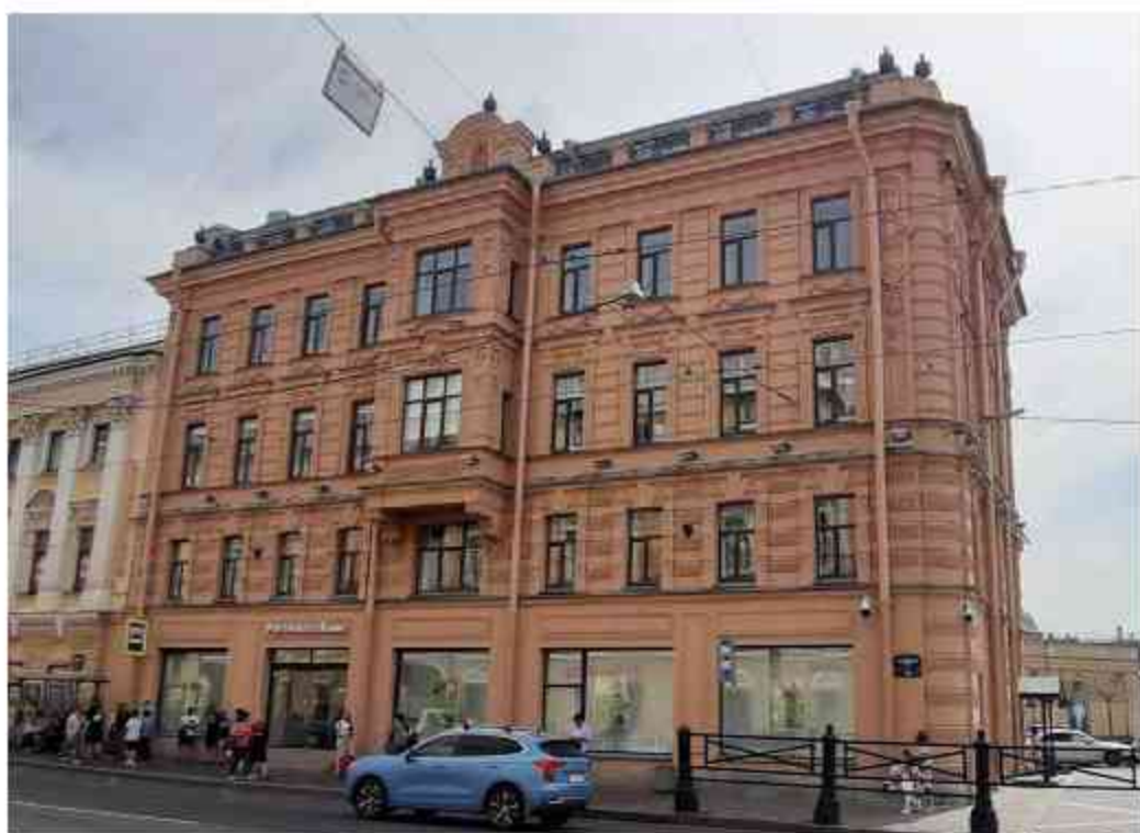
20. Доходный дом Успенской церкви (Садовая ул., д. 40, лит. Б). Лицевой фасад по Садовой ул. Штиглиц М.С. 11.06.2024.
