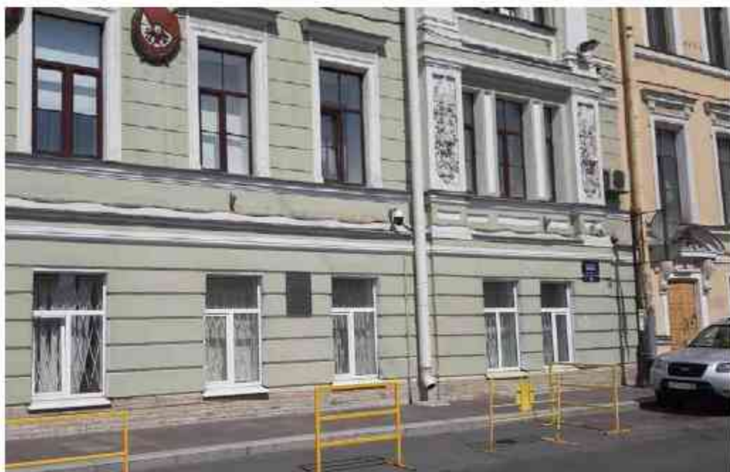
11. Дом Первого Российского страхового общества (Большая Морская ул., д. 40, лит. А). Лицевой фасад. Фото мест установки оборудования и прокладки кабельных трасс. Штиглиц М.С. 11.06.2024.
