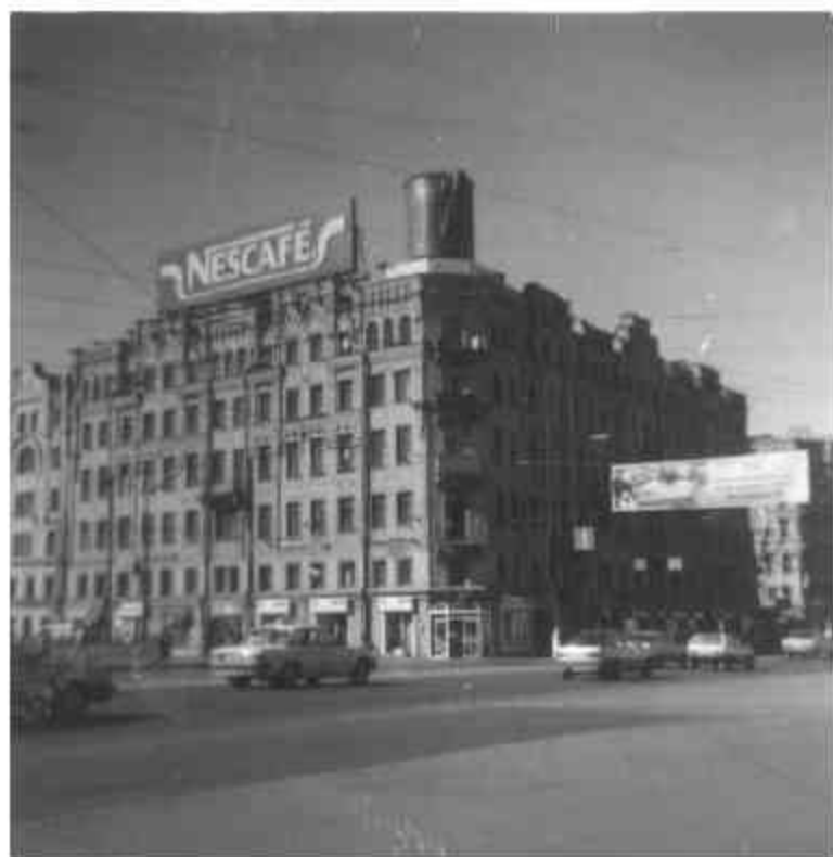
35. Доходные дома Н.И. Львовой (А.Д. Сивкова) (Московский пр., д. 63, лит.А). На фото 1999 г. - исследуемый дом (21).
