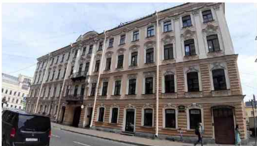
35. Дом Липина (наб. реки Мойки, 62/2, лит. А). Лицевой фасад по пер. Гривцова. Штиглиц М.С. 11.06.2024.
