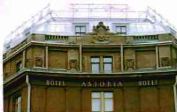
2. Фрагмент юго-западного фасада.
