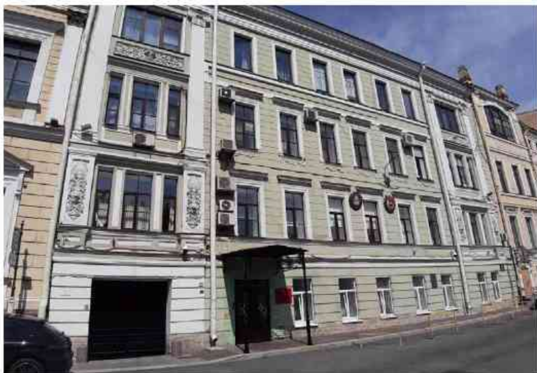
9. Дом Первого Российского страхового общества (Большая Морская ул., д. 40, лит. А). Лицевой фасад по наб. реки Мойки. Штиглиц М.С. 11.06.2024.
