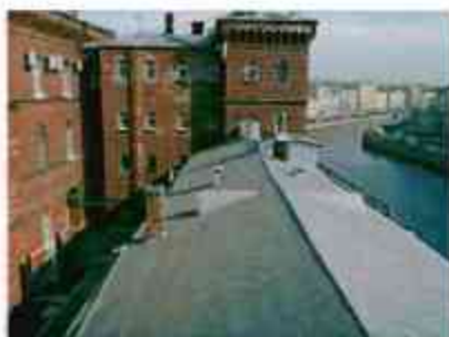
3. Северный дворовой фасад
