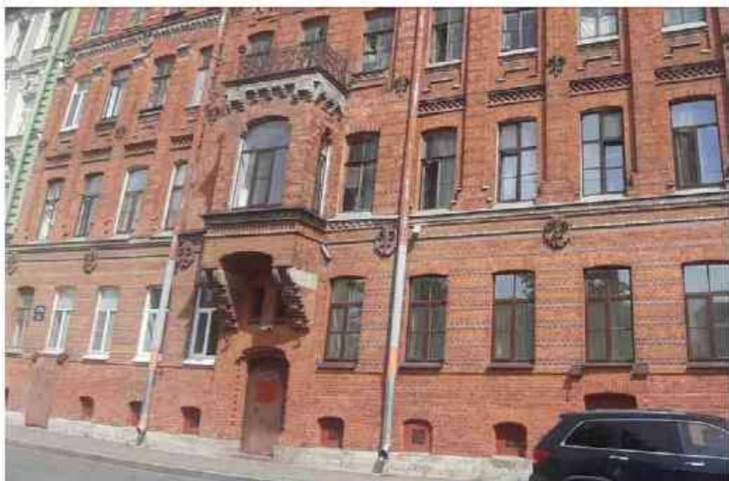
41. Доходный дом (в составе «Дом и фабрика шелковых изделий А.И.Ниссена») (наб. реки Фонтанки, д. 183, лит. А). Фото мест установки оборудования и прокладки кабельных трасс. Лицевой фасад. Штиглиц М.С.
