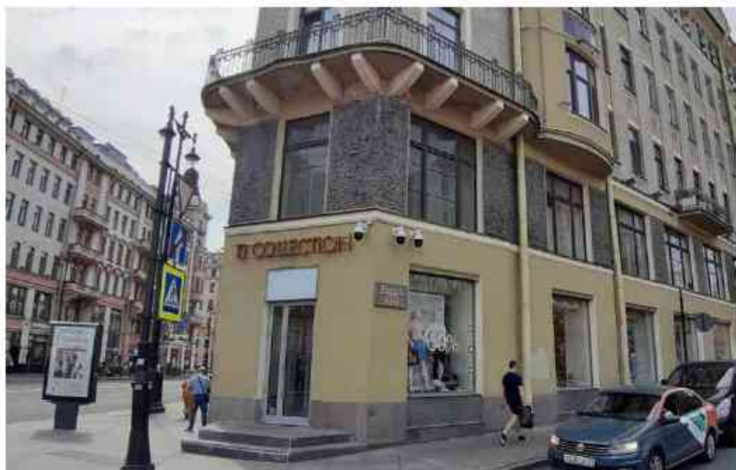
25. Дом Я.И. Перетца (Московский пр., д. 1/2, лит.А). Лицевой фасад. Фото мест установки оборудования и прокладки кабельных трасс. Штиглиц М.С. 11.06.2024.
