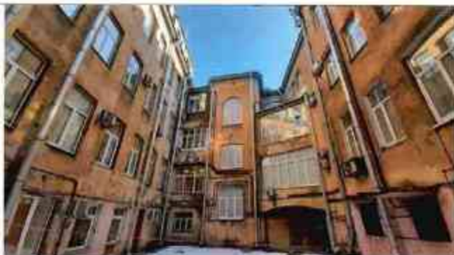
3. Фрагмент дворового фасада
