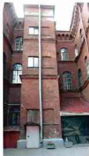
7. Юго-западный дворовой фасад.
