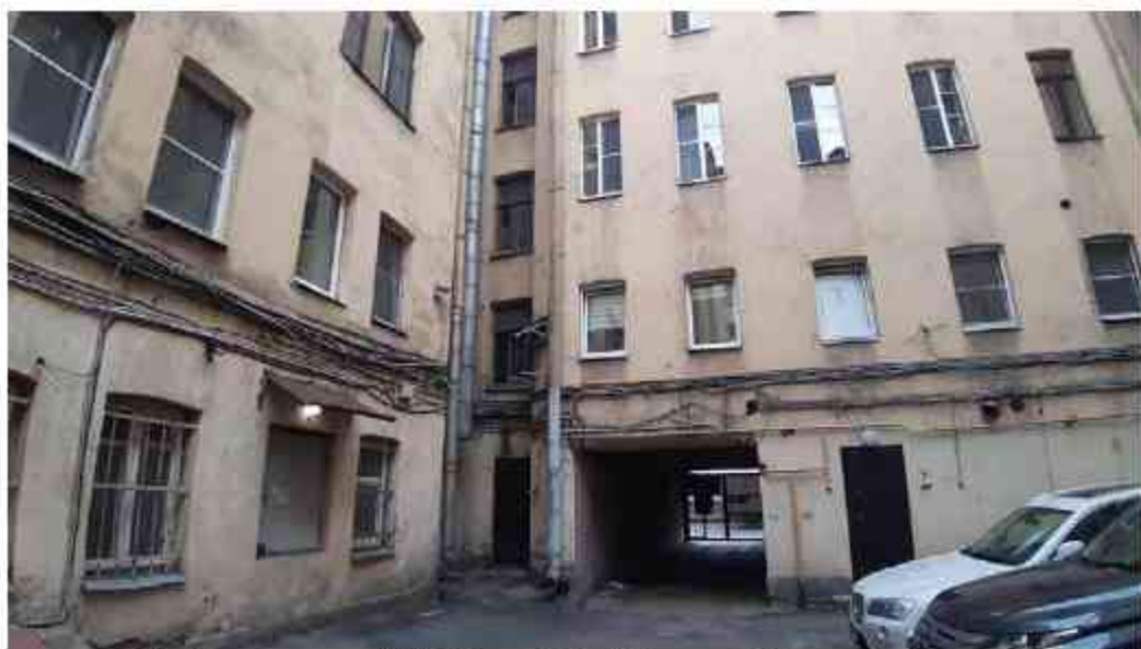
31. Доходные дома Н.И. Львовой (А.Д. Сивкова) (Московский пр., д. 63, лит.А). Дворовый фасад. Фото мест установки оборудования и прокладки кабельных трасс. Штиглиц М.С. 11.06.2024.
