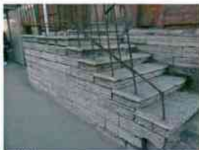
10. Крыльцо со стороны западного фасада.
