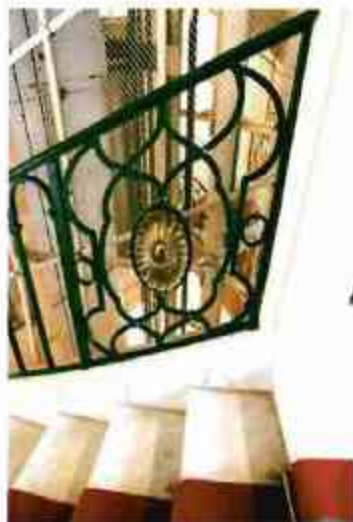
33. Фрагмент перильного ограждения лестницы.
