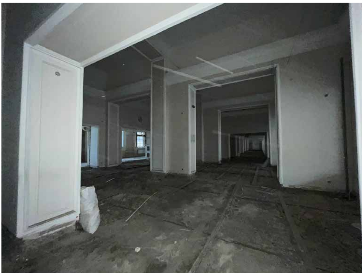
Фото №25. Второй этаж. Общий вид помещений.
