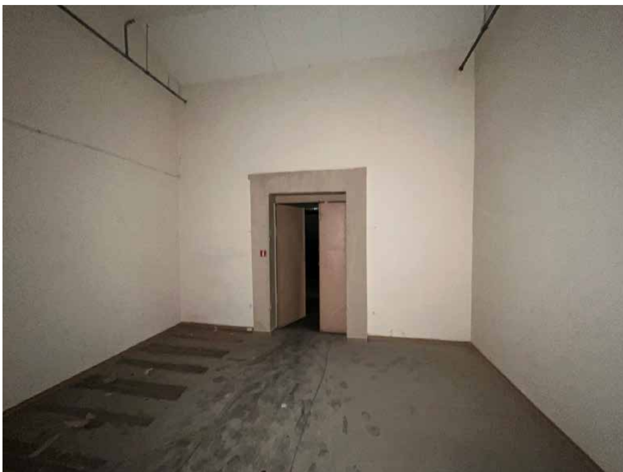
Фото №36. Помещение третьего этажа (мансарда).
