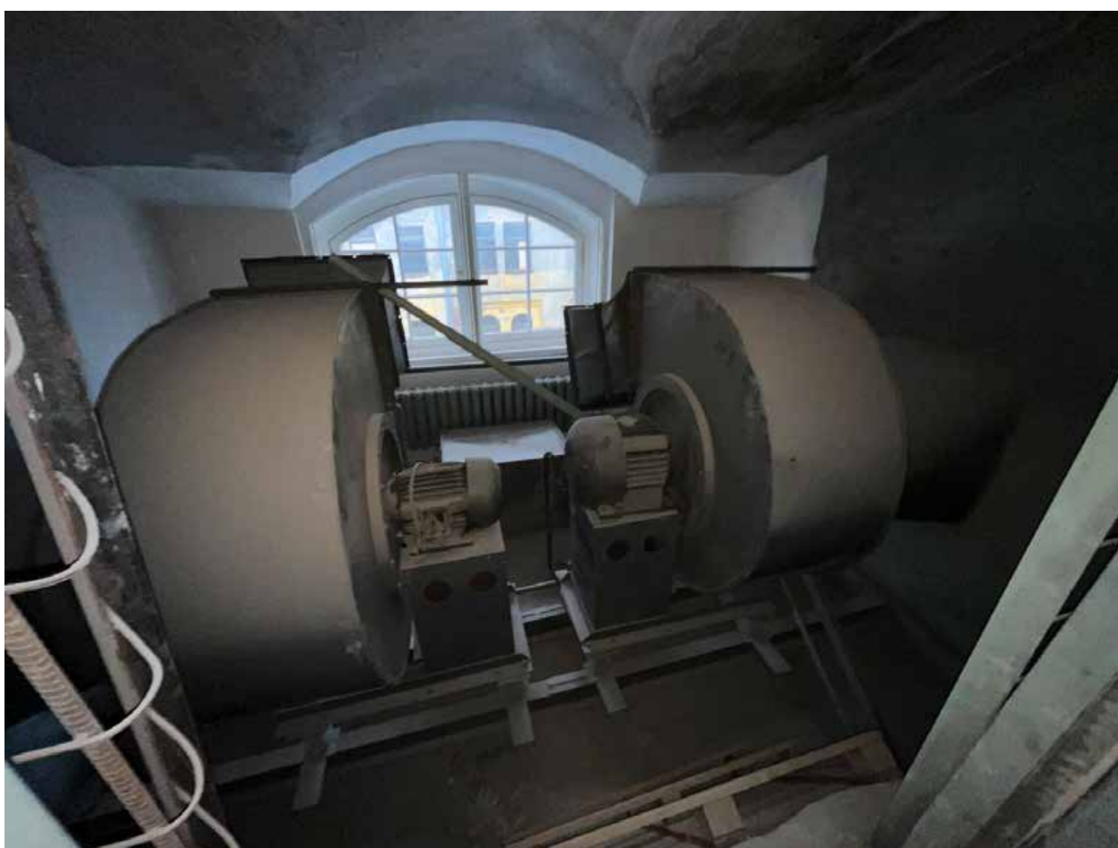
Фото №37. Помещение третьего этажа (мансарда).
