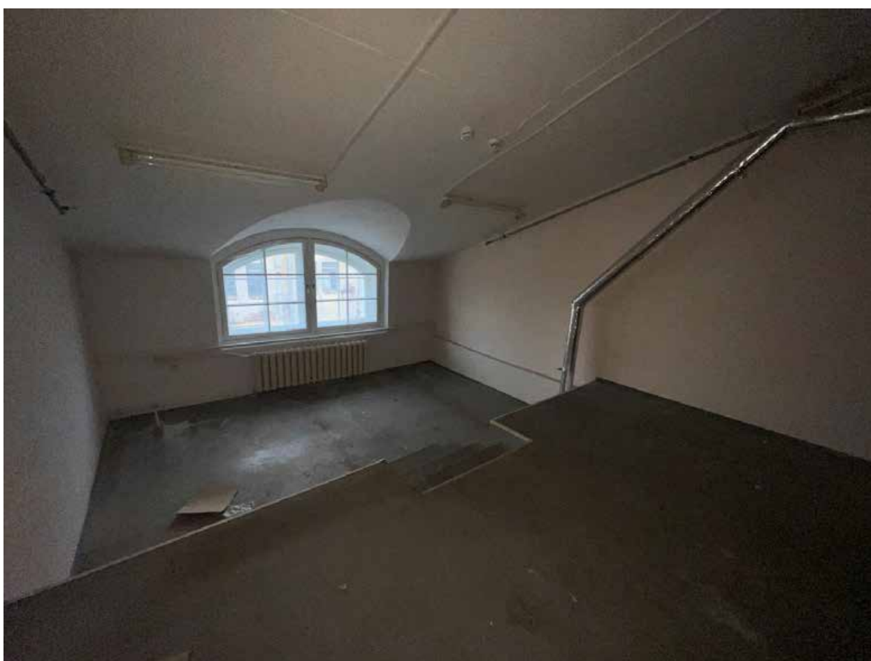
Фото №43. Помещение третьего этажа (мансарда).
