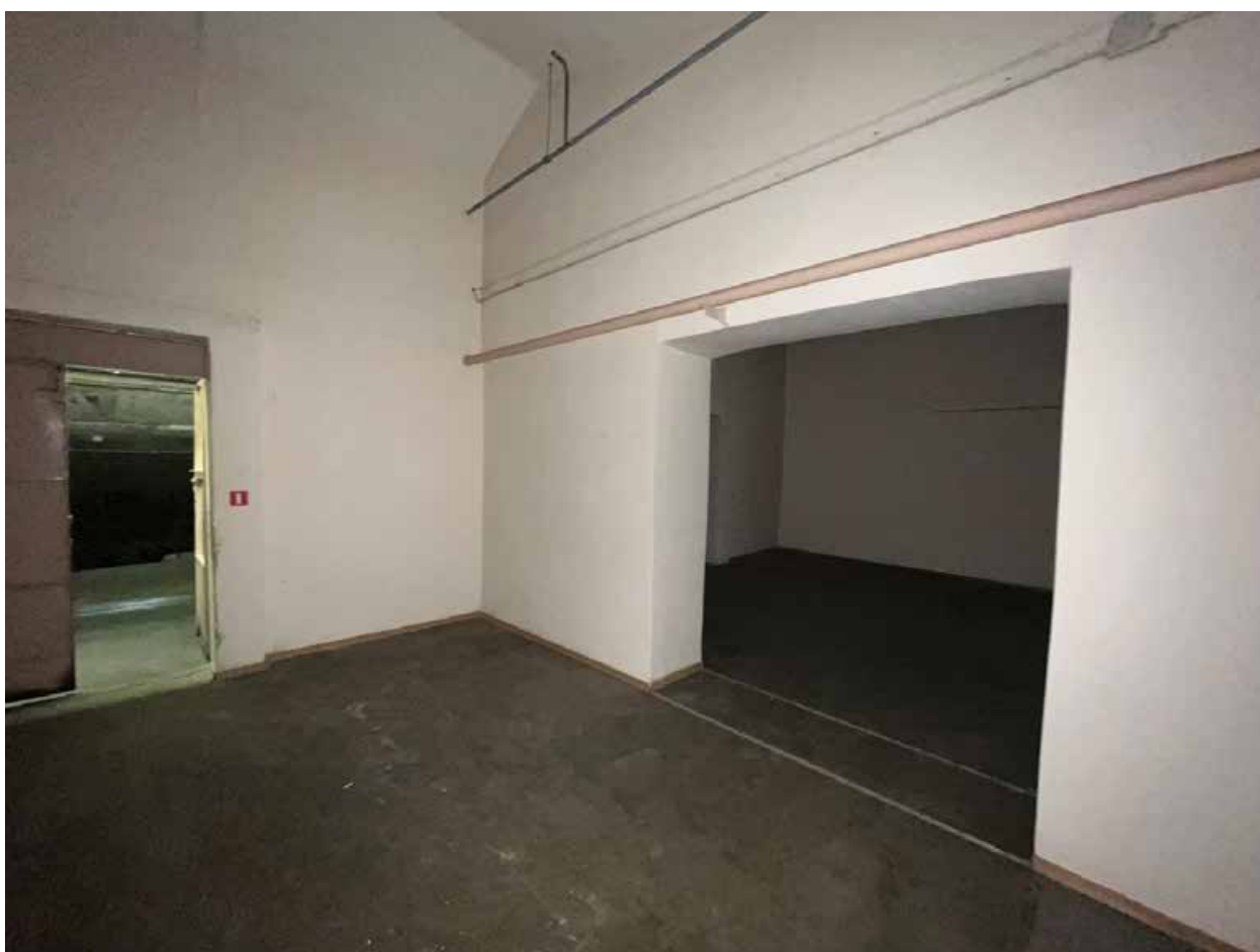
Фото №32. Помещение третьего этажа (мансарда).
