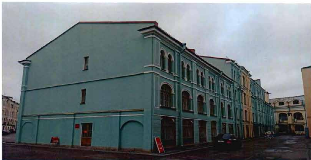
2. Вид на восточный фасад объекта культурного наследия (Невский проспект, дом 35, лит. В).
