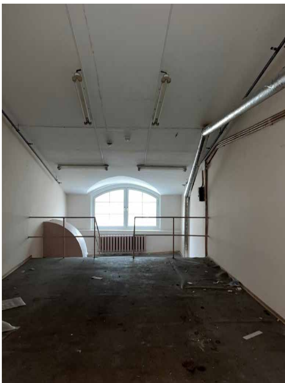
Фото №34. Помещение третьего этажа (мансарда).
