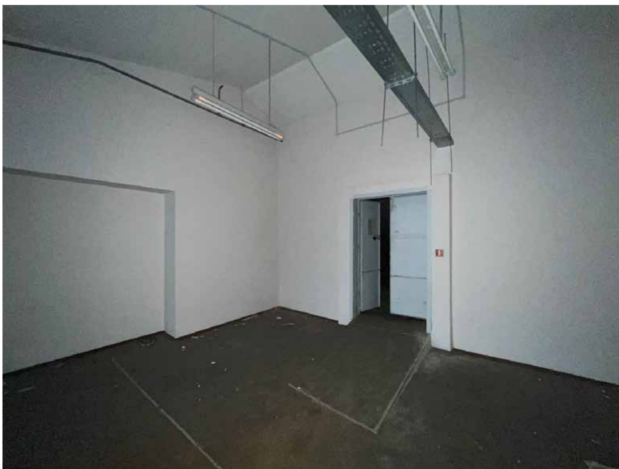
Фото №49. Помещение третьего этажа (мансарда).
