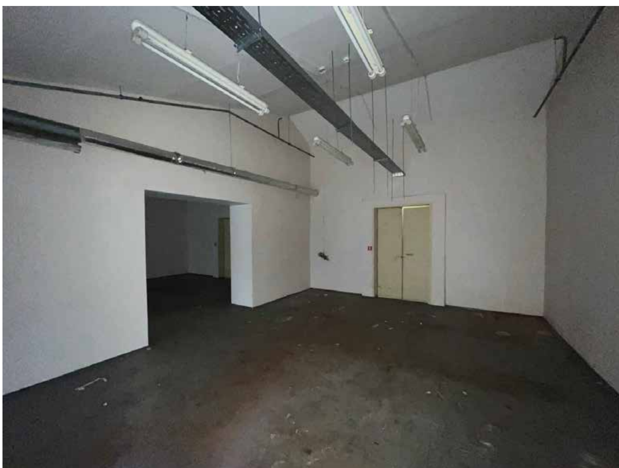
Фото №42. Помещение третьего этажа (мансарда).
