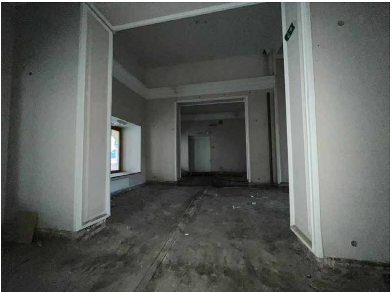
Фото №24. Второй этаж. Общий вид помещений.
