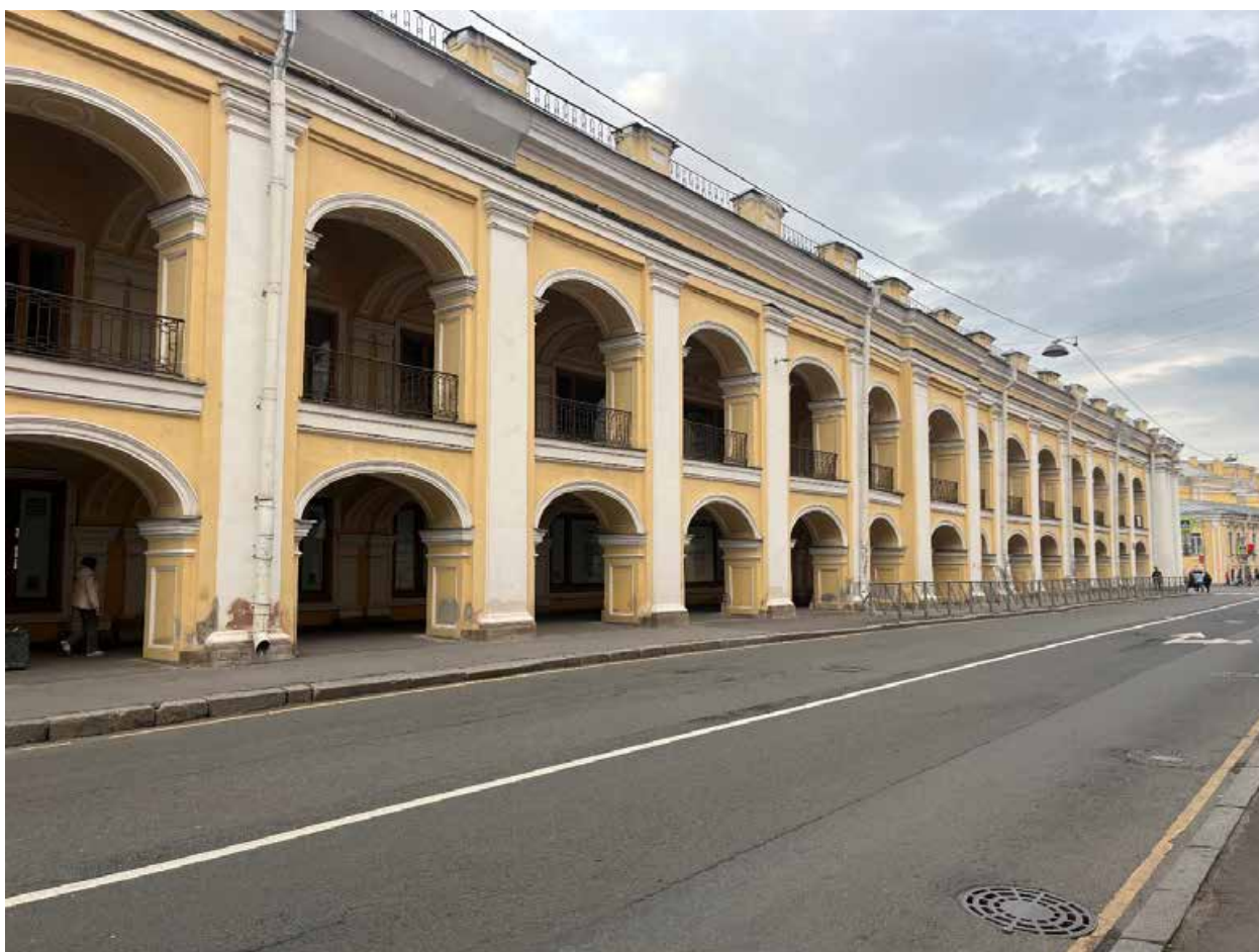
Фото №4. Лицевой фасад Ломоносовской улице.
