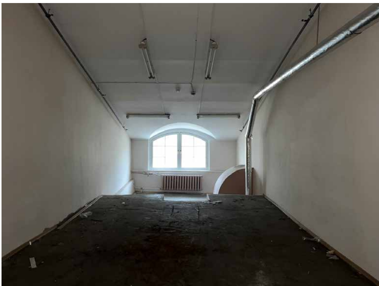
Фото №38. Помещение третьего этажа (мансарда).
