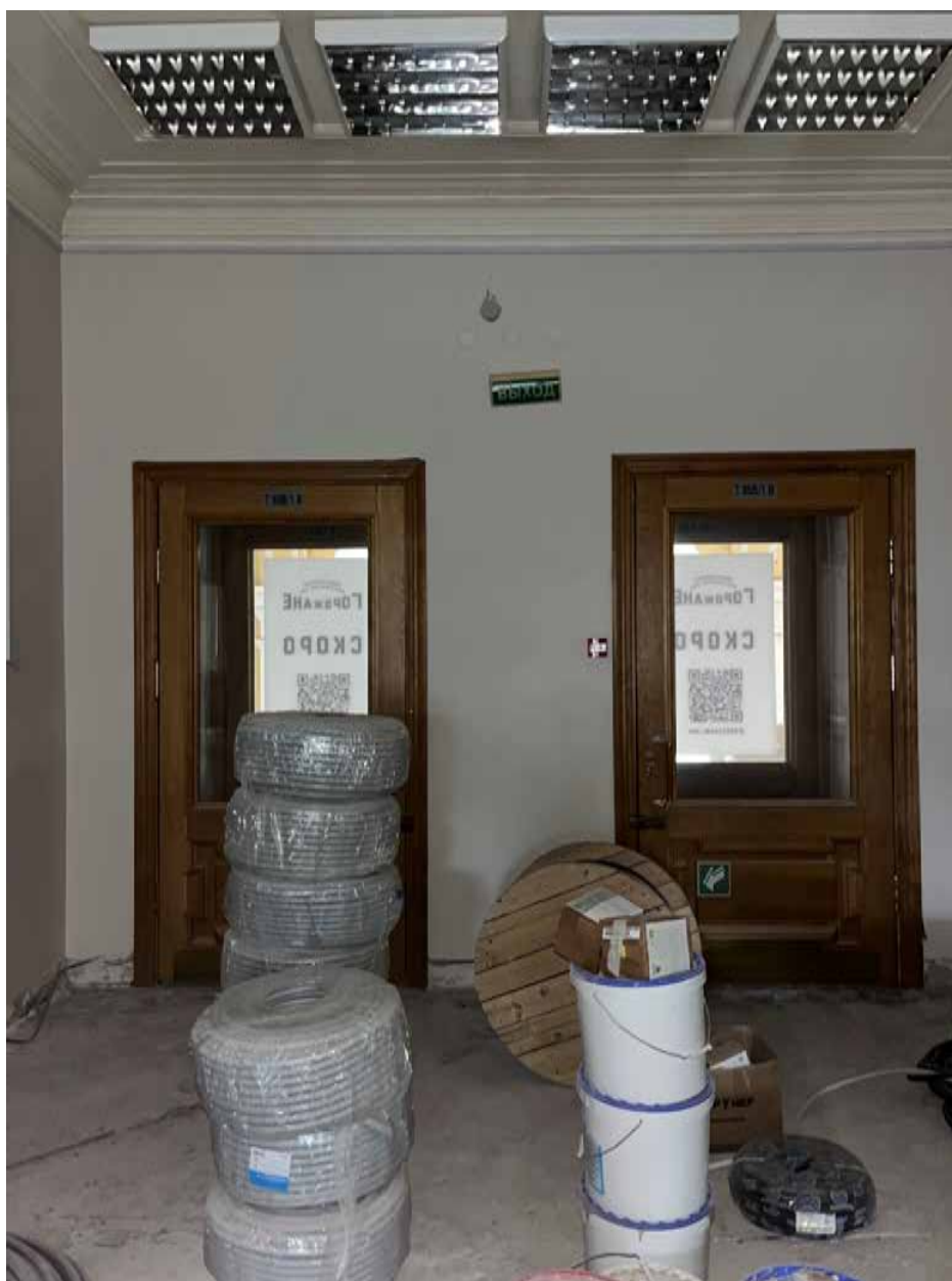
Фото №13. Первый этаж. Вход со стороны лицевого фасада.
