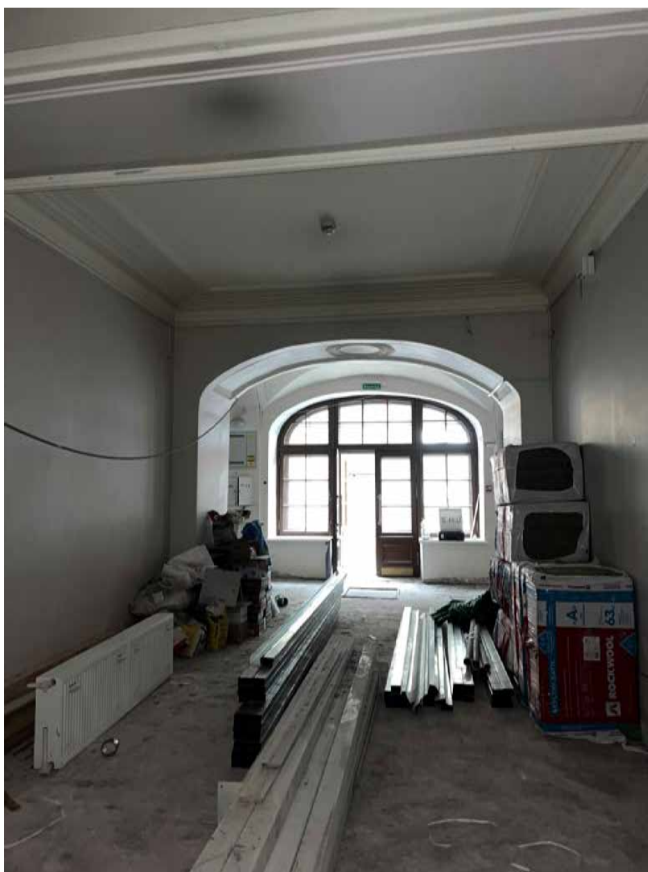
Фото №12. Первый этаж. Вход со стороны двора.
