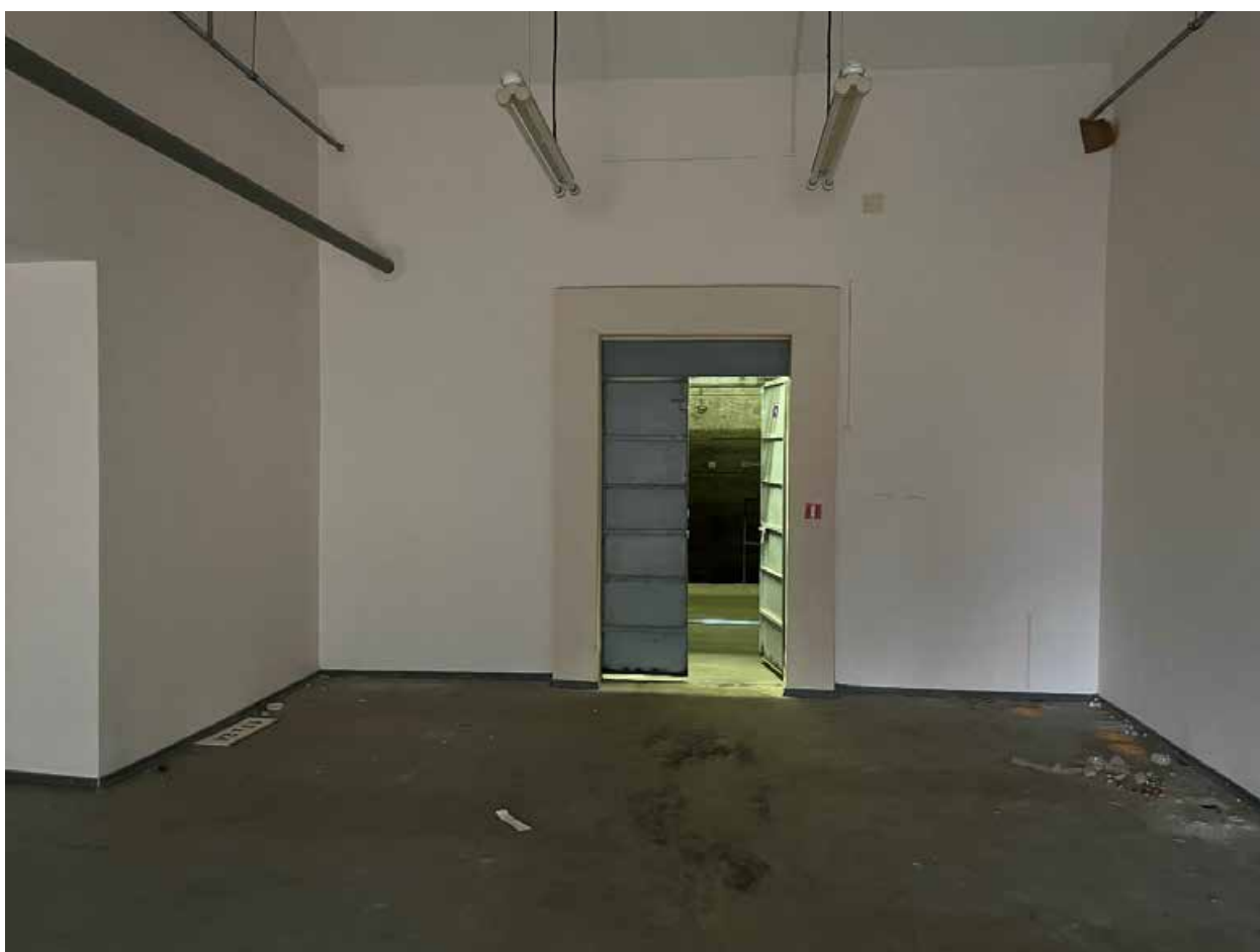
Фото №28. Помещение третьего этажа (мансарда).
