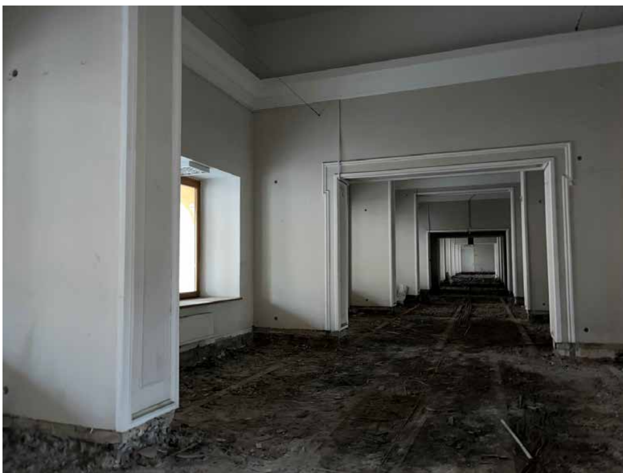
Фото №18. Второй этаж. Галерея вдоль стены лицевого фасада.
