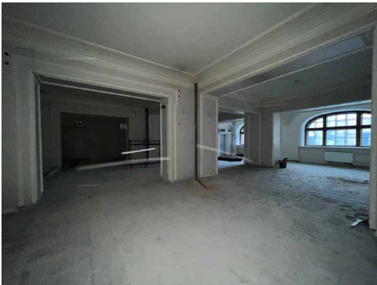
Фото №14. Первый этаж. Общий вид помещений.
