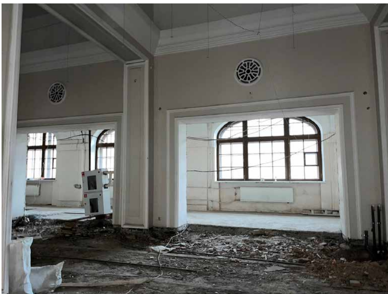
Фото №19. Второй этаж. Общий вид помещений.
