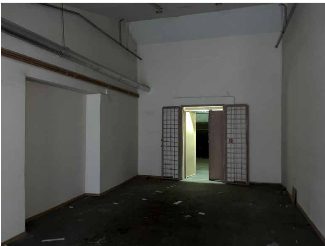
Фото №35. Помещение третьего этажа (мансарда).
