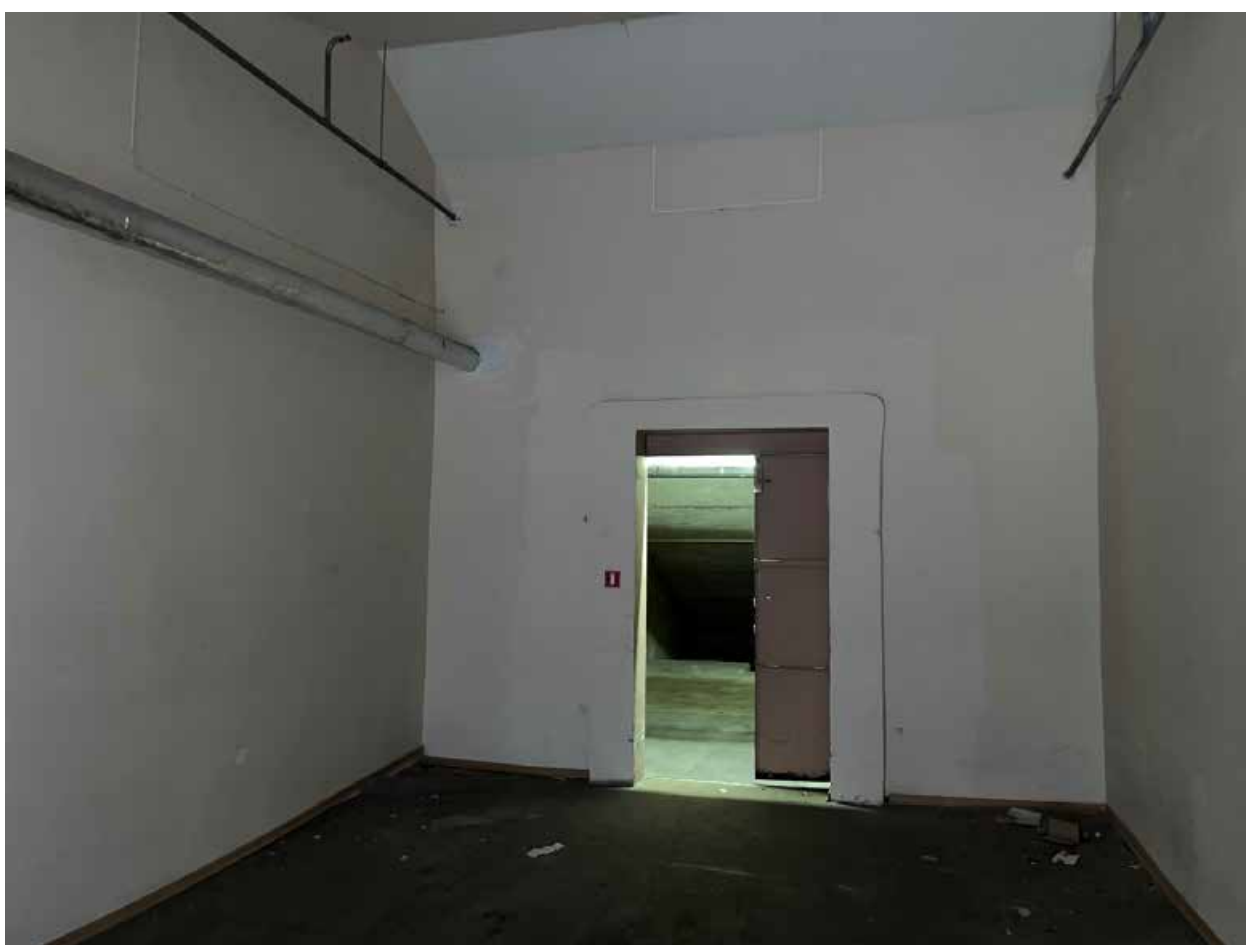
Фото №39. Помещение третьего этажа (мансарда).
