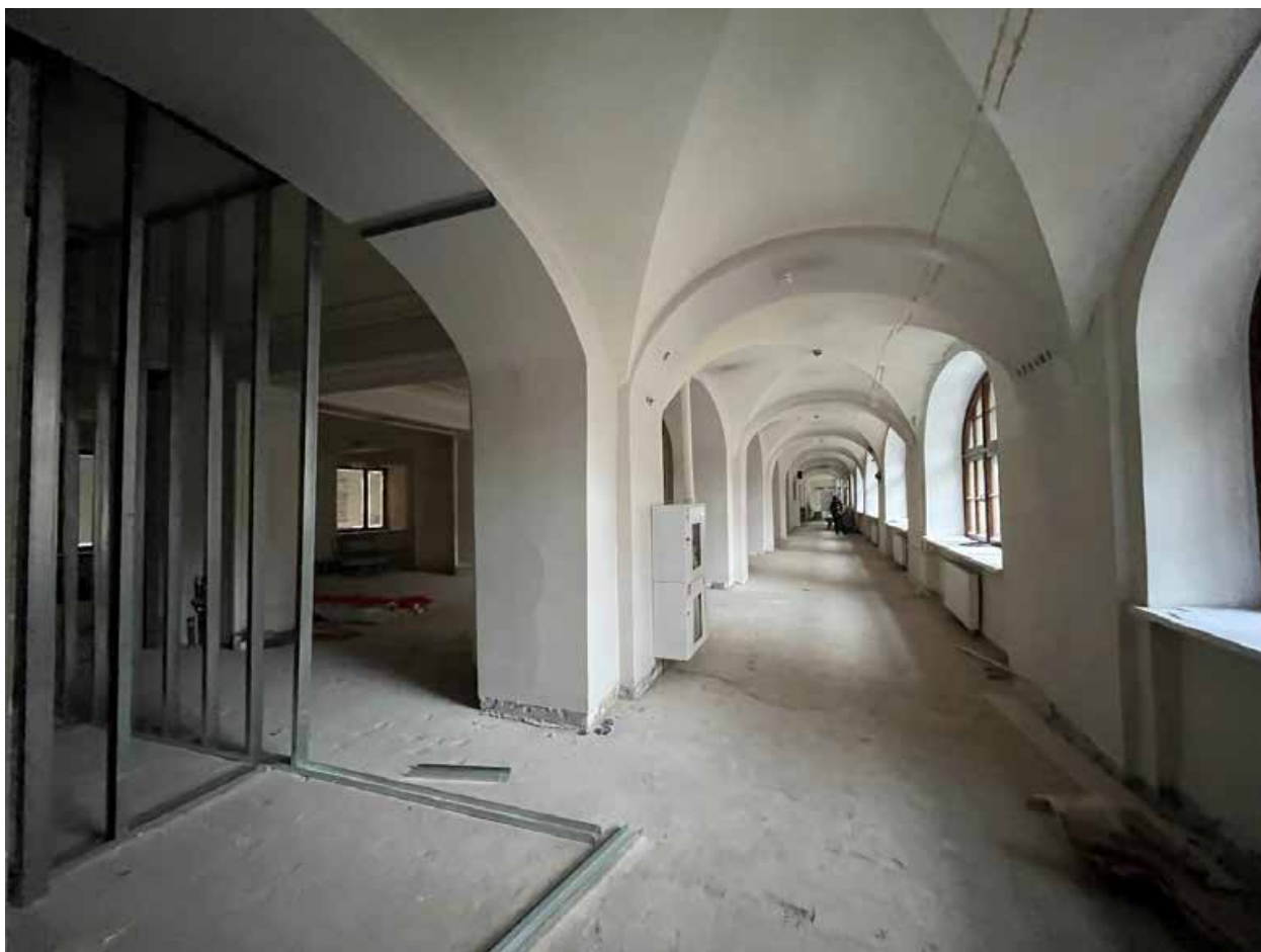
Фото №8. Первый этаж, галерея вдоль стены дворового фасада.
