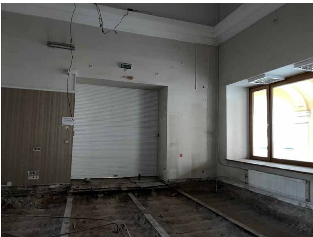
Фото №17. Второй этаж. Выход в вестибюль.
