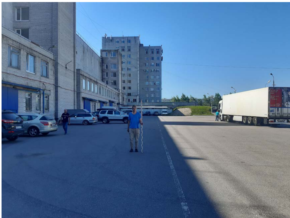
Рис. 22. Санкт-Петербург, Выборгский район, 1-й Верхний пер. д. 2 лит. Б. Общий вид участка. Точка съёмки 5. Вид на юго-запад.
