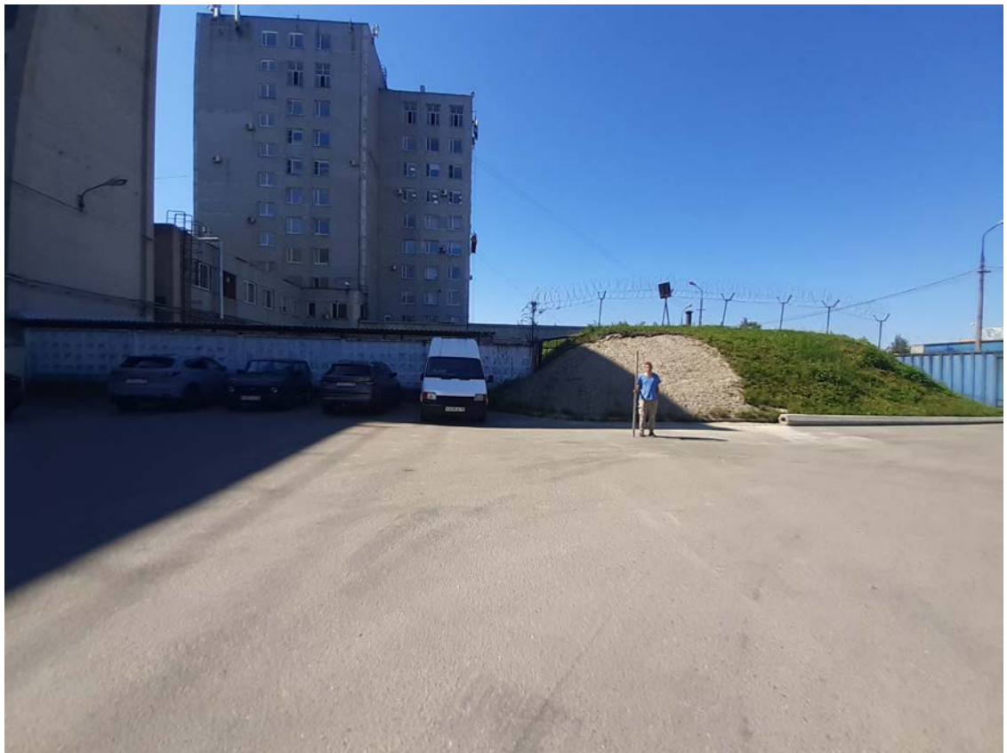
Рис. 20. Санкт-Петербург, Выборгский район, 1-й Верхний пер. д. 2 лит. Б. Общий вид участка. Точка съёмки 4. Вид на юго-запад.
