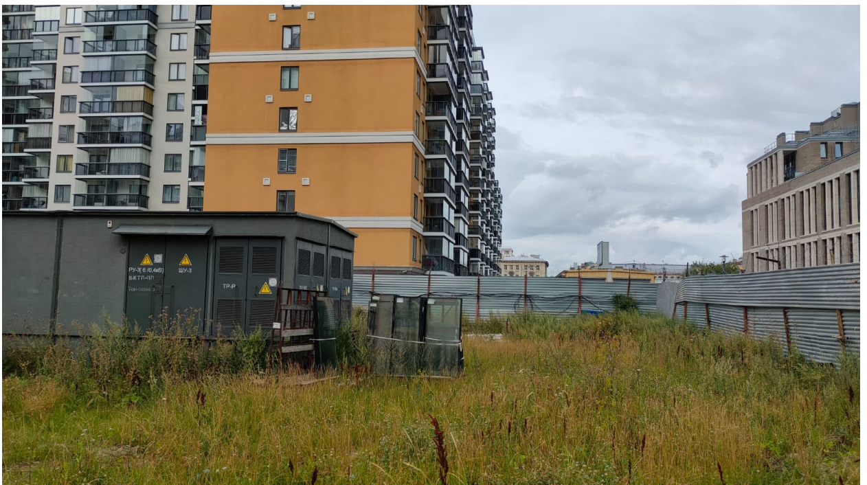
Илл. 30. ТФ 2. Общий вид участка проектирования с юго-запада. Фото 29.07.2024 г.
