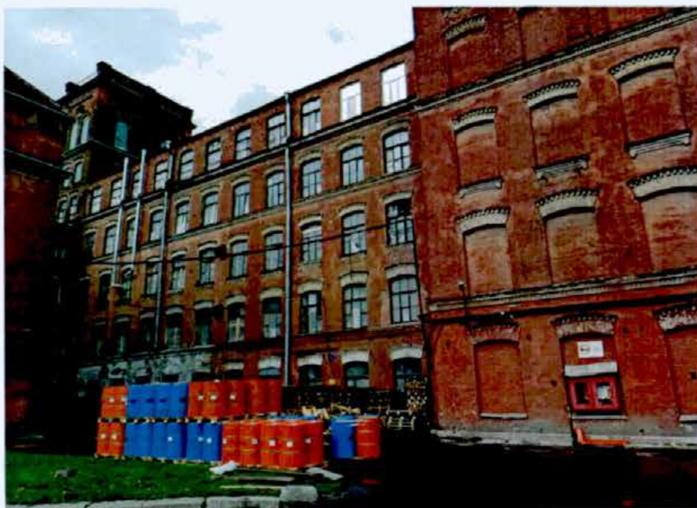
5. Общий вид объекта культурного наследия. Южный фасад строения 4.
