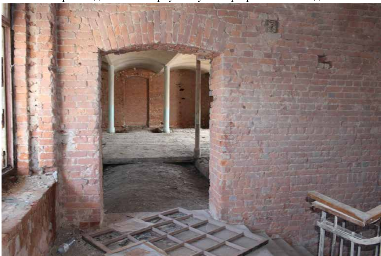
Фото 80. Центральный корпус объекта культурного наследия регионального значения «Производственные корпуса обувной фабрики». 1ЛК в уровне 4-го этажа.
