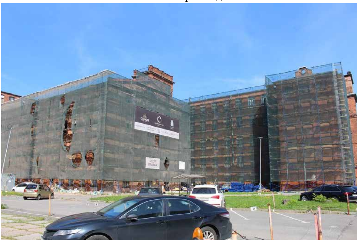
Фото 5. Вид на восточный фасад объекта культурного наследия регионального значения «Конторское здание» и южный фасад центрального корпуса объекта культурного наследия регионального значения «Производственные корпуса обувной фабрики».
