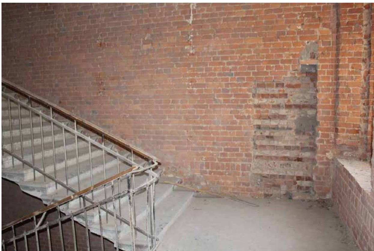
Фото 39. Центральный корпус объекта культурного наследия регионального значения «Производственные корпуса обувной фабрики». 1ЛК в уровне 2-го этажа.
