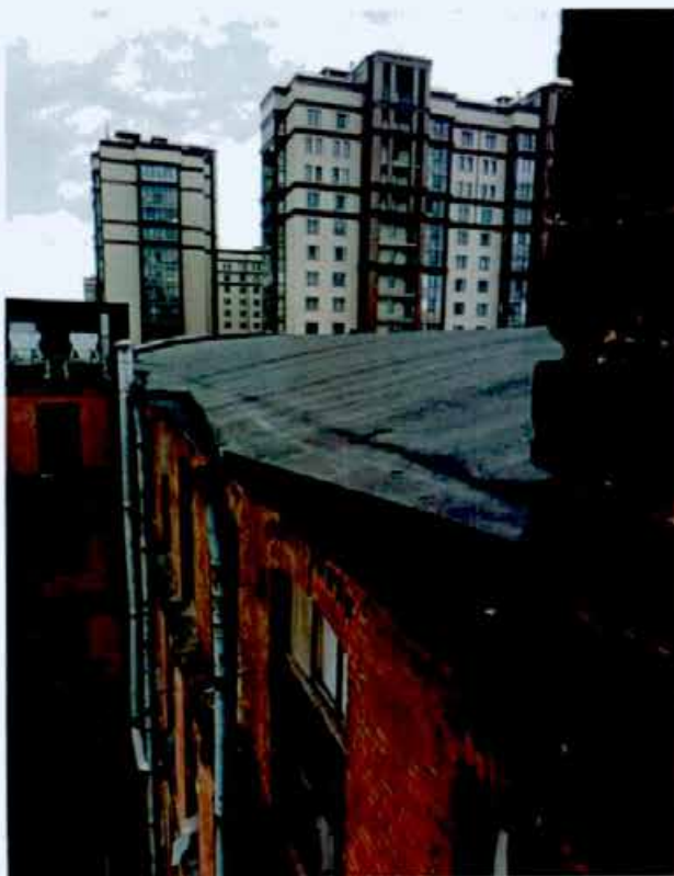
21. Кровля объекта культурного наследия.
