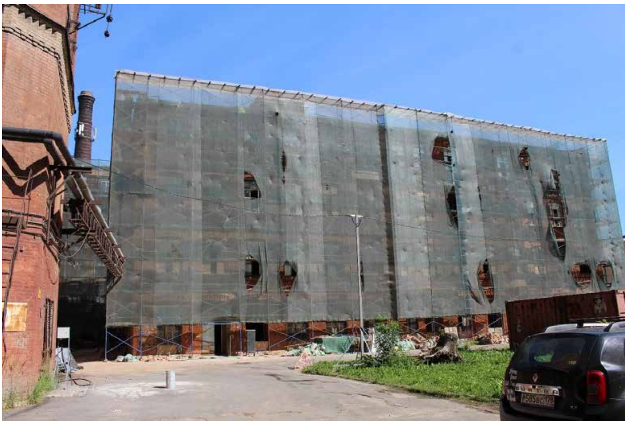
Фото 4. Вид на южный фасад объекта культурного наследия регионального значения «Конторское здание».
