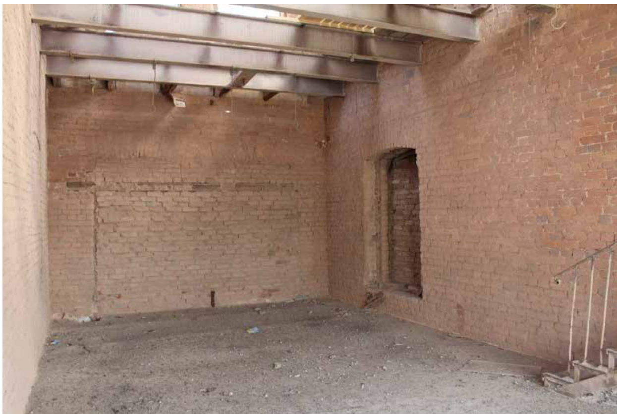
Фото 116. Центральный корпус объекта культурного наследия регионального значения «Производственные корпуса обувной фабрики». 1ЛК в уровне 6-го этажа.
