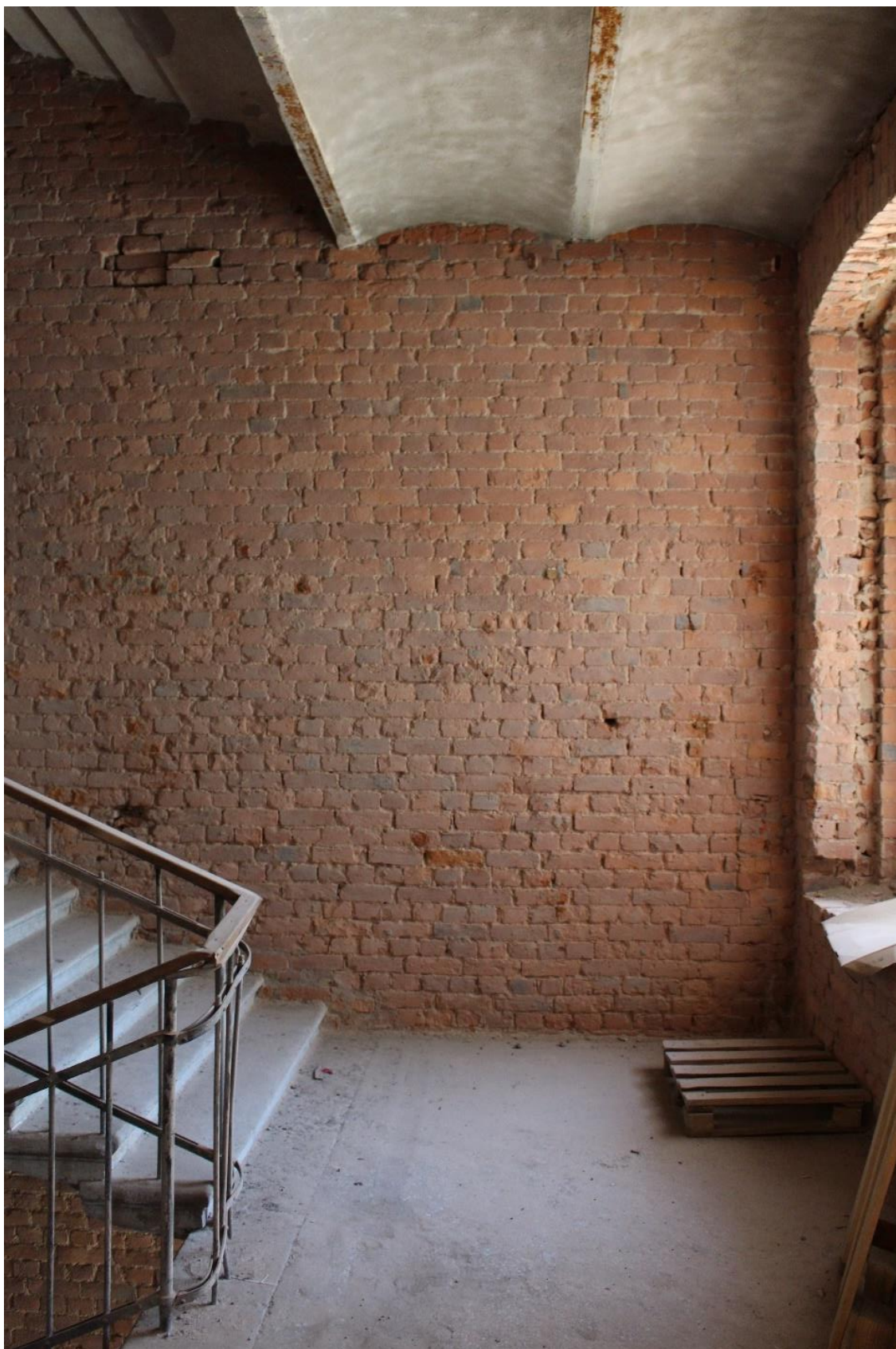
Фото 74. Центральный корпус объекта культурного наследия регионального значения «Производственные корпуса обувной фабрики». 1ЛК в уровне 3-го этажа.
