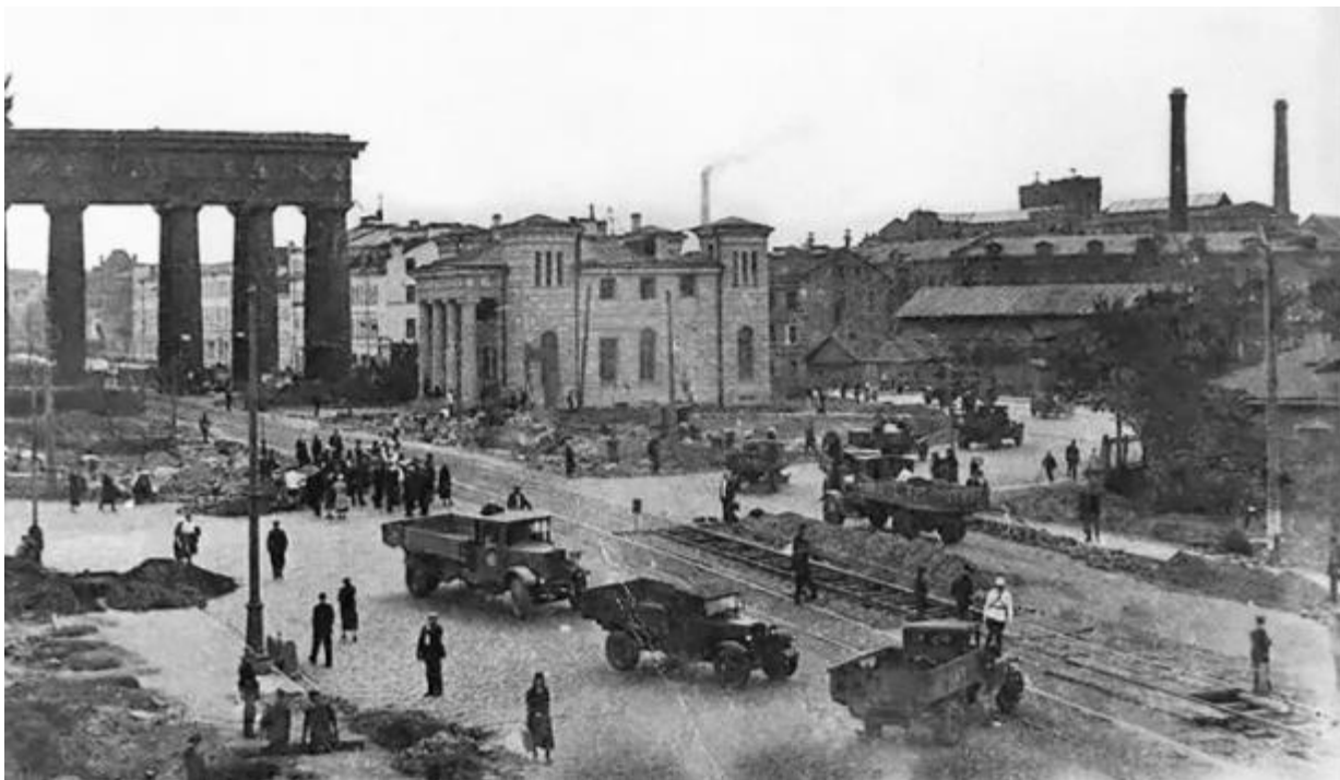
Илл. 86. Ремонтные работы у Московских триумфальных ворот на Международном проспекте. 1930-е гг. (источник: ЦГАКФФД СПб. Фотодокументы. Опись 1АР-111. Ед.хр.153338).
