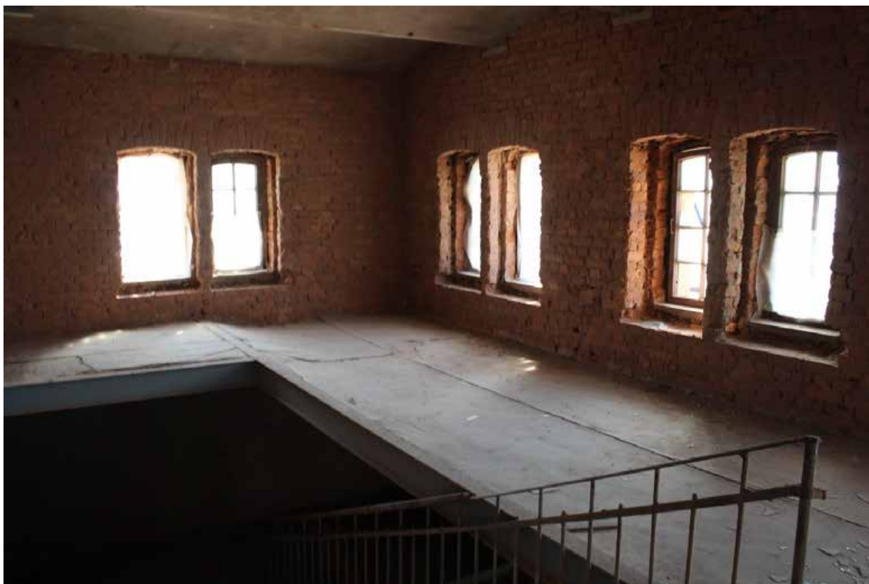
Фото 106. Центральный корпус объекта культурного наследия регионального значения «Производственные корпуса обувной фабрики». 1ЛК в уровне 5-го этажа.
