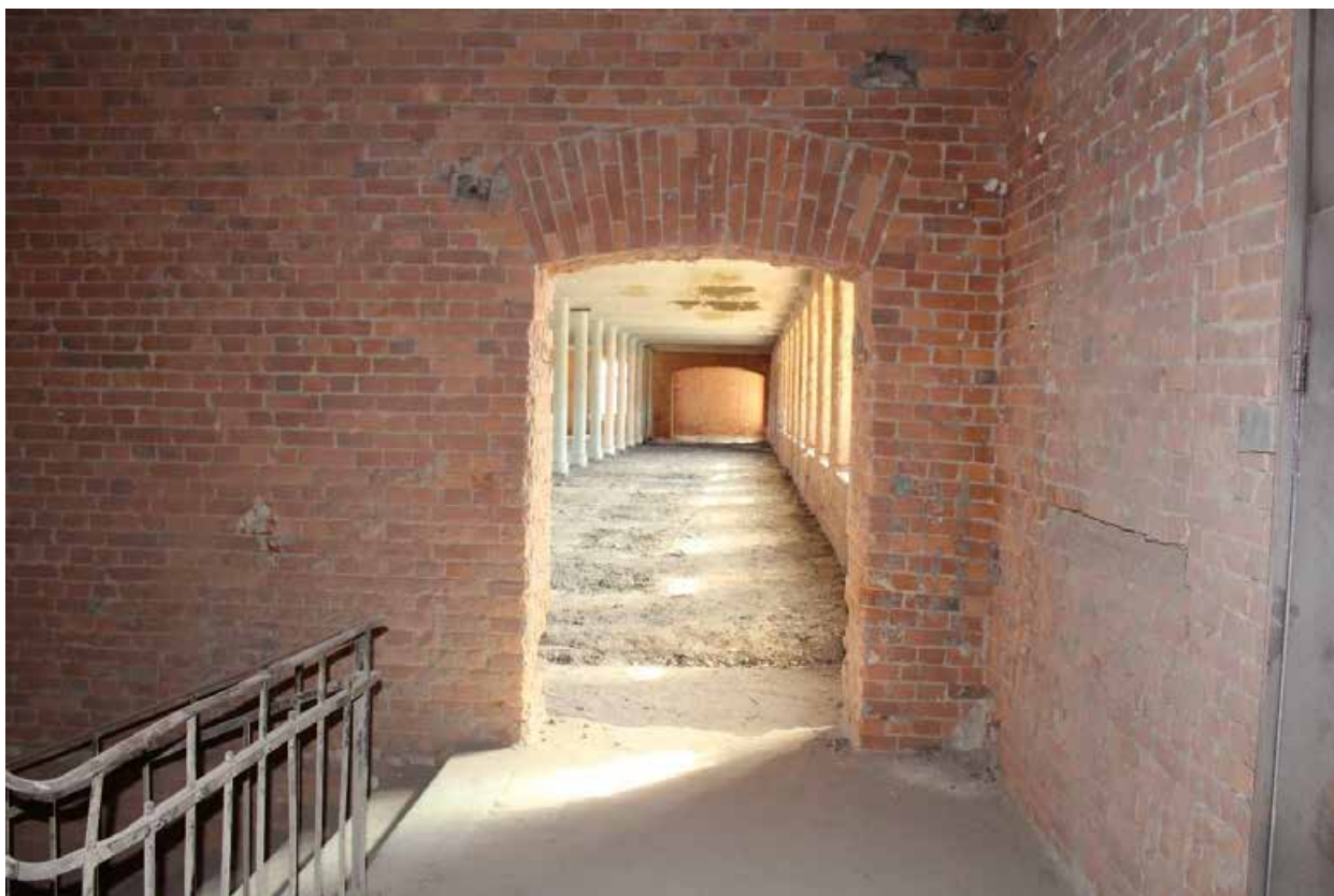
Фото 96. Центральный корпус объекта культурного наследия регионального значения «Производственные корпуса обувной фабрики». 2ЛК в уровне 4-го этажа.
