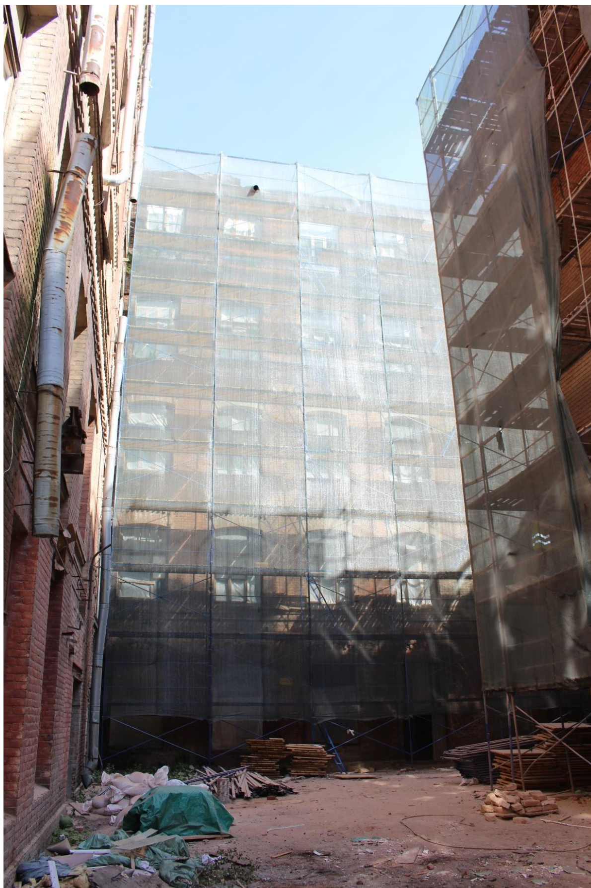
Фото 3. Вид на южный фасад центрального корпуса объекта культурного наследия регионального значения «Производственные корпуса обувной фабрики».
