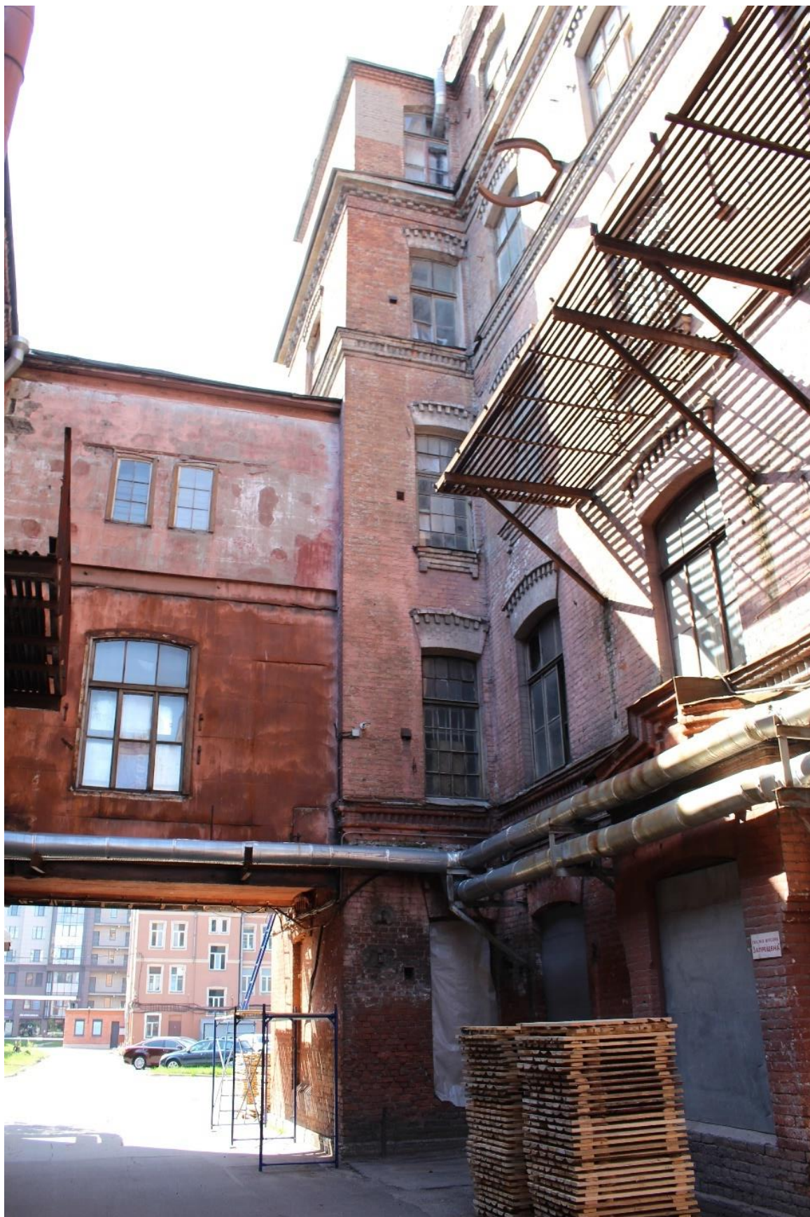
Фото 11. Вид на восточный фасад центрального корпуса объекта культурного наследия регионального значения «Производственные корпуса обувной фабрики» с севера.
