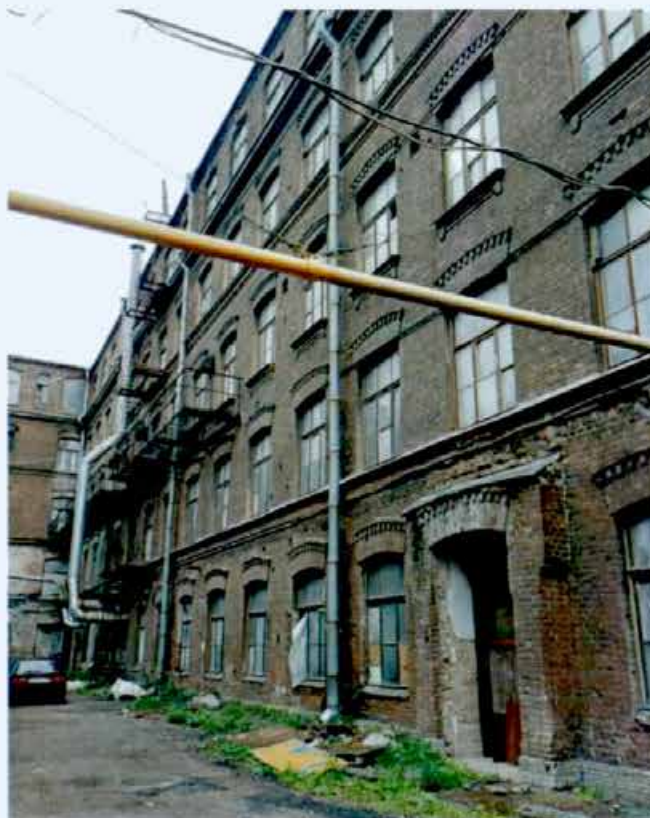
6. Общий вид объекта культурного наследия. Северный фасад строения 4.
