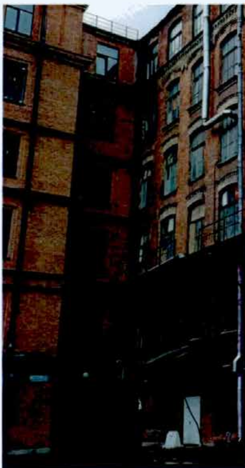
10. Общий вид объекта культурного наследия. Северный фасад строения 2.
