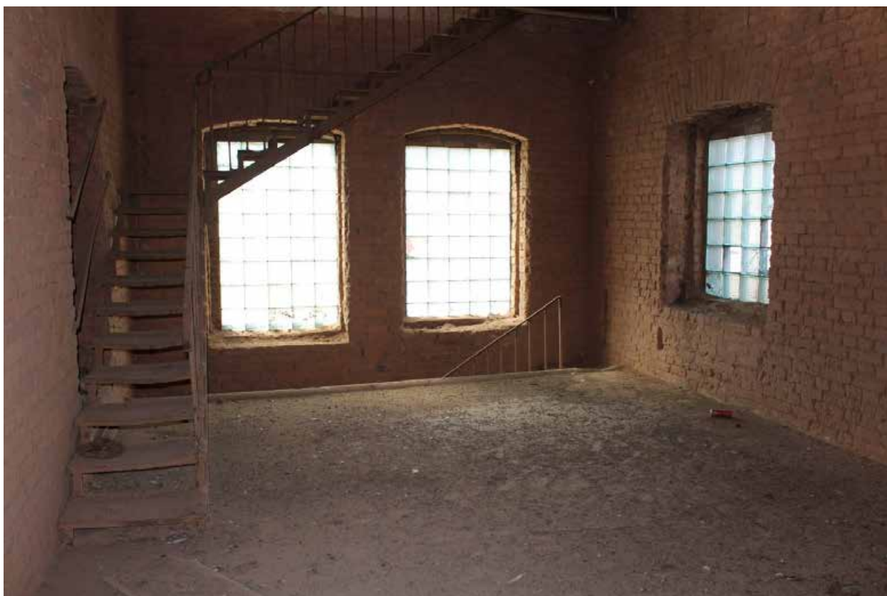
Фото 117. Центральный корпус объекта культурного наследия регионального значения «Производственные корпуса обувной фабрики». 1ЛК в уровне 6-го этажа.
