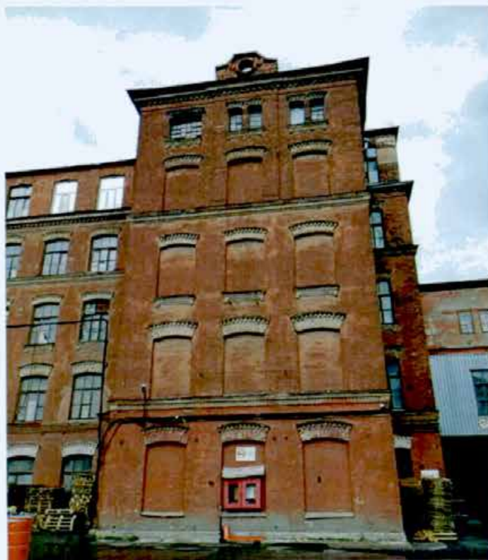
7. Фрагмент объекта культурного наследия. Южный фасад строения 4.
