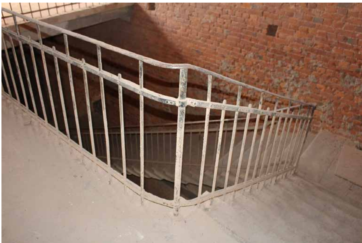
Фото 99. Центральный корпус объекта культурного наследия регионального значения «Производственные корпуса обувной фабрики». 2ЛК в уровне 5-го этажа.
