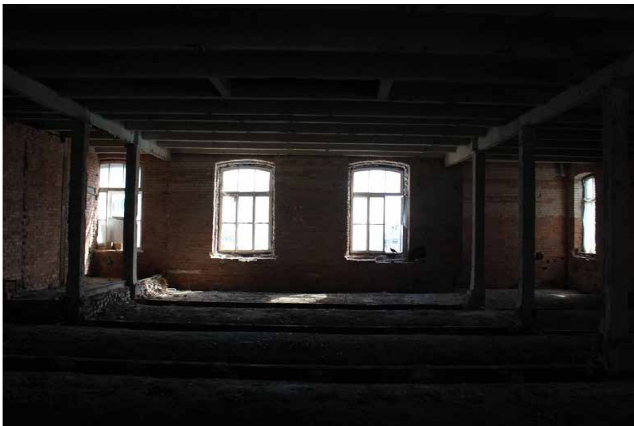
Фото 104. Центральный корпус объекта культурного наследия регионального значения «Производственные корпуса обувной фабрики». Внутренние помещения 5-го этажа.
