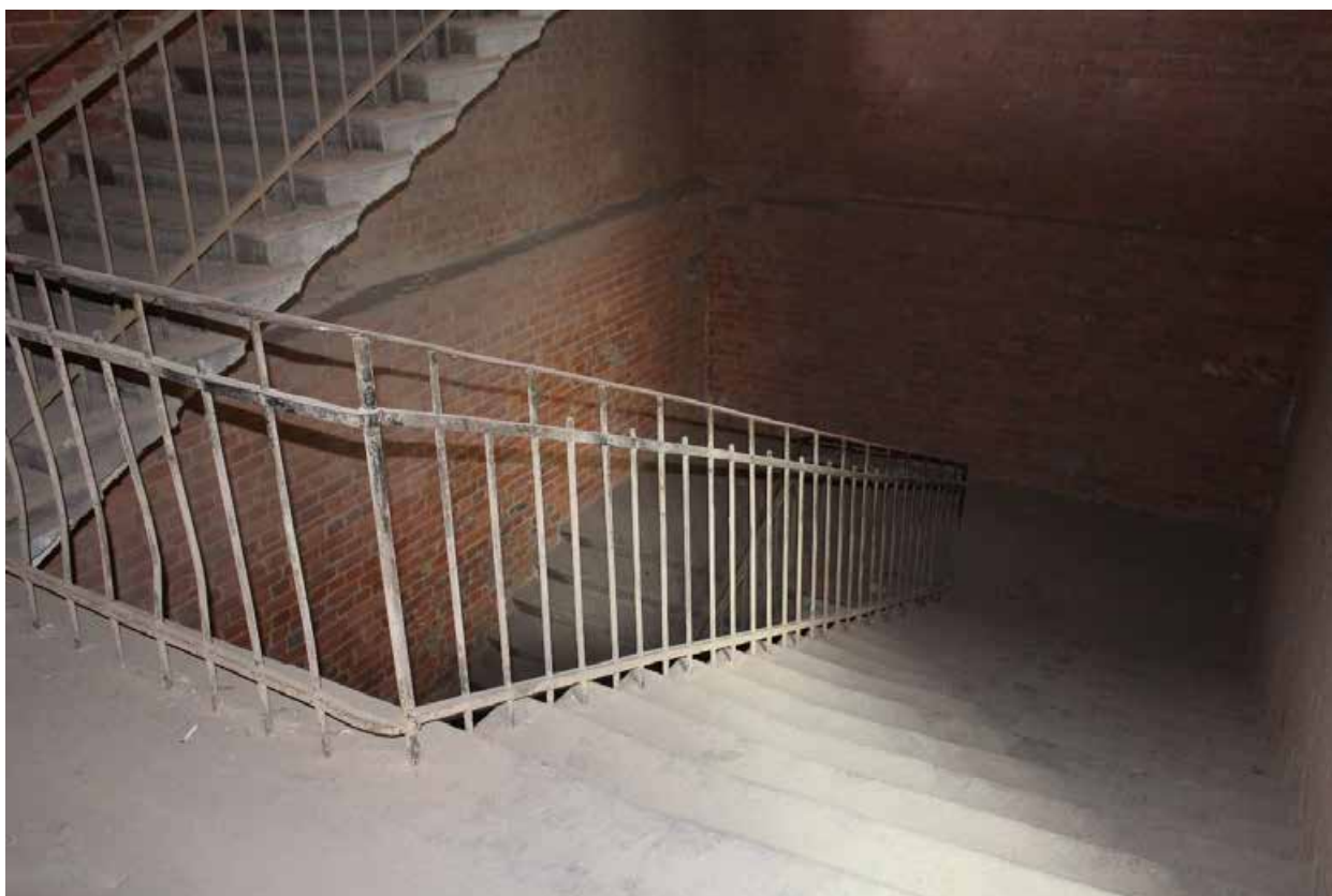
Фото 97. Центральный корпус объекта культурного наследия регионального значения «Производственные корпуса обувной фабрики». Вид на междуэтажную площадку 2ЛК в уровне 3-го – 4-го этажей.
