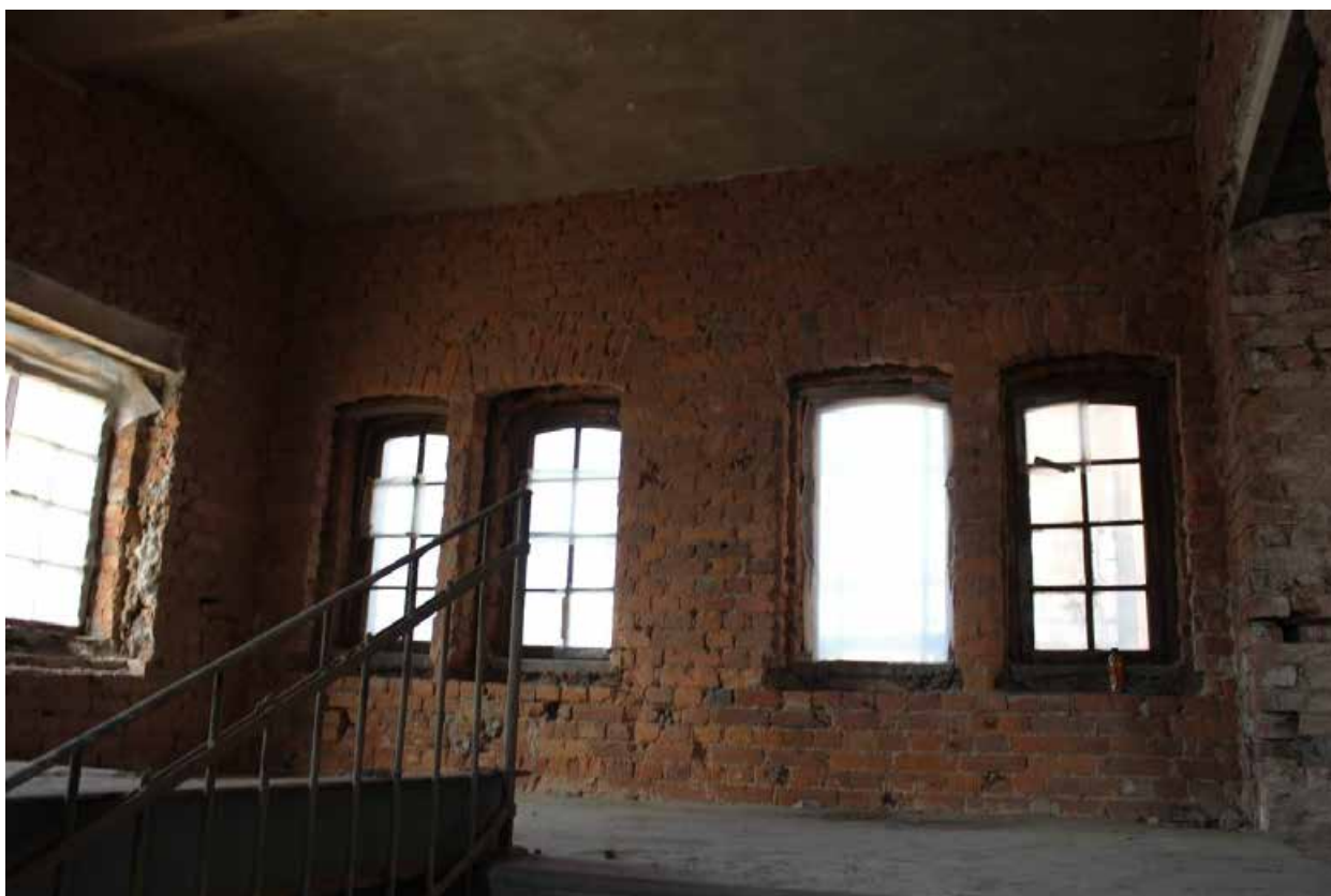
Фото 107. Центральный корпус объекта культурного наследия регионального значения «Производственные корпуса обувной фабрики». 1ЛК в уровне 5-го этажа.
