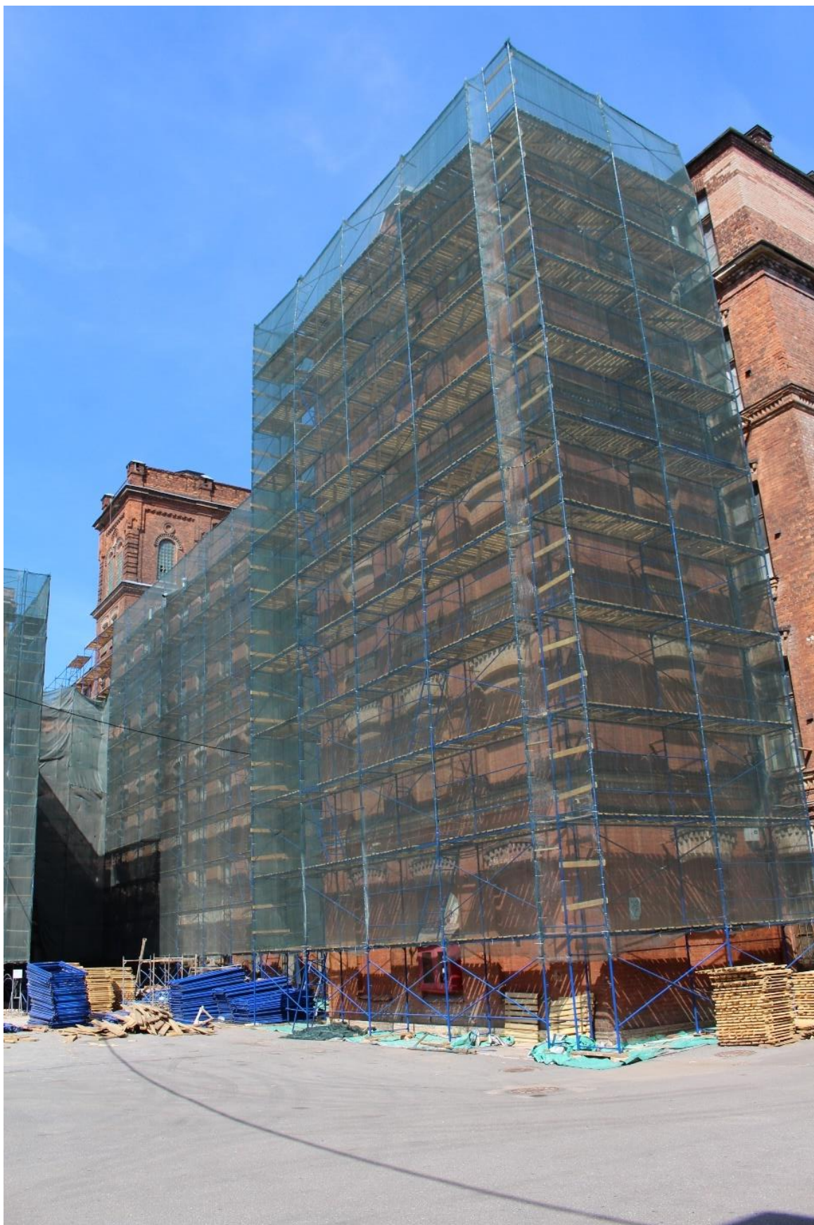
Фото 6. Вид на южный фасад центрального корпуса объекта культурного наследия регионального значения «Производственные корпуса обувной фабрики».
