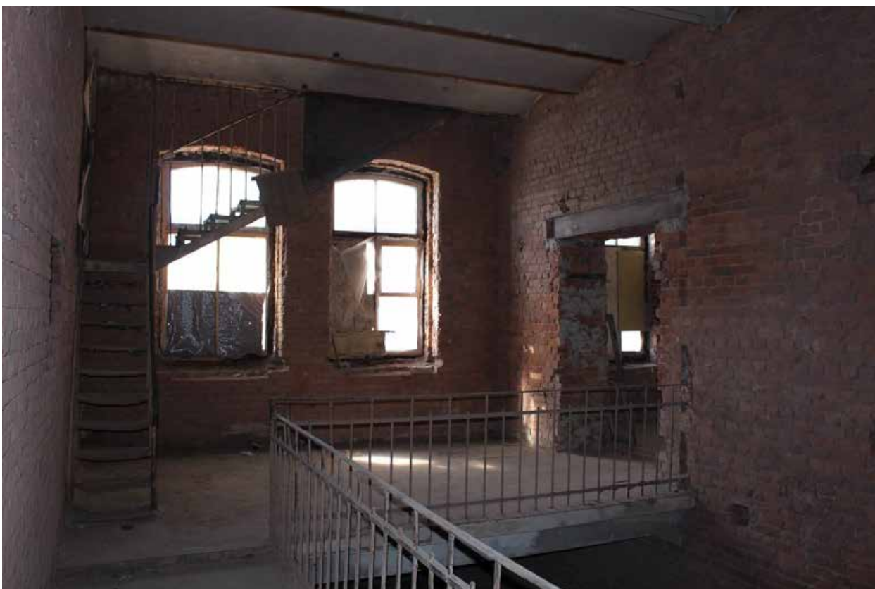
Фото 100. Центральный корпус объекта культурного наследия регионального значения «Производственные корпуса обувной фабрики». 2ЛК в уровне 5-го этажа.
