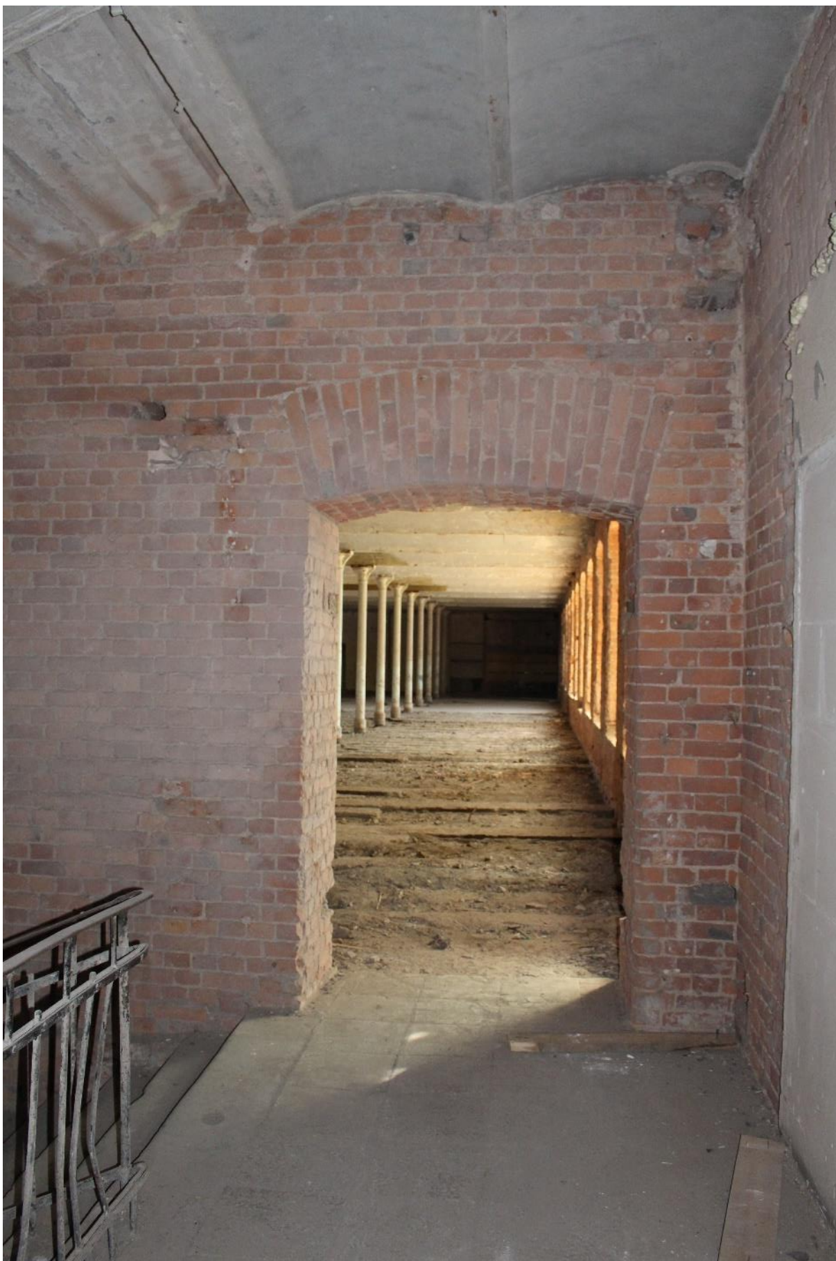
Фото 53. Центральный корпус объекта культурного наследия регионального значения «Производственные корпуса обувной фабрики». 2ЛК в уровне 2-го этажа.
