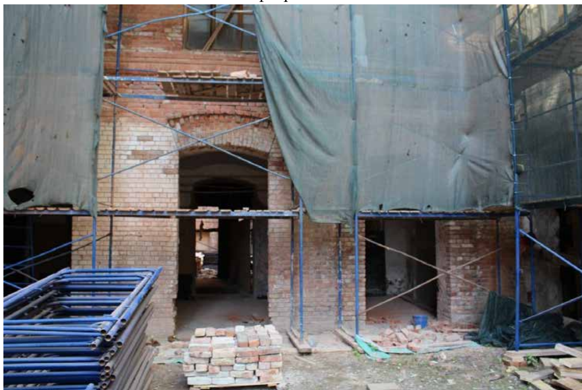
Фото 8. Вид на переход, соединяющий объект культурного наследия регионального значения «Конторское здание» и центральный корпус объекта культурного наследия регионального значения «Производственные корпуса обувной фабрики».
