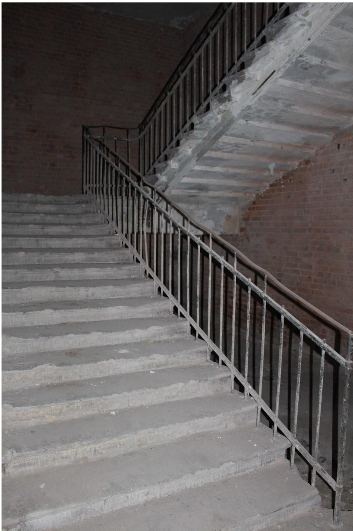
Фото 30. Центральный корпус объекта культурного наследия регионального значения «Производственные корпуса обувной фабрики». 2ЛК в уровне 1-го этажа.
