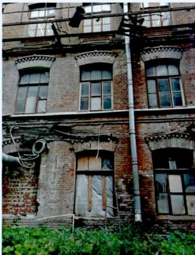
4. Фрагмент объекта культурного наследия. Восточный фасад строения 1.
