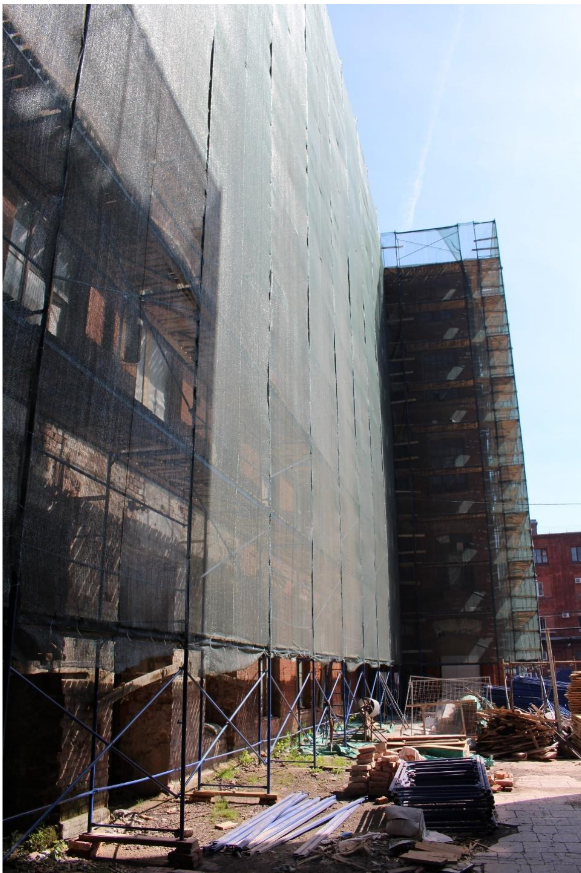
Фото 9. Вид на южный фасад центрального корпуса объекта культурного наследия регионального значения «Производственные корпуса обувной фабрики».
