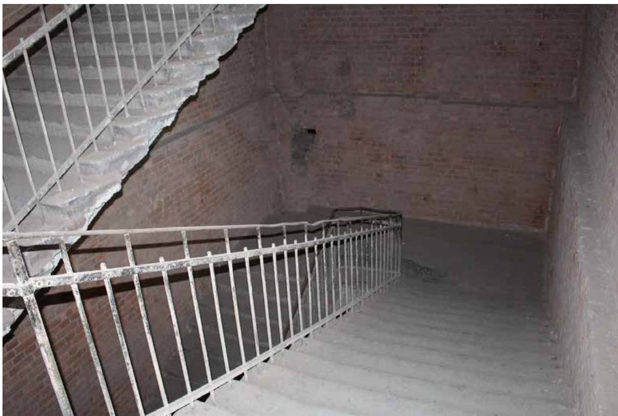
Фото 54. Центральный корпус объекта культурного наследия регионального значения «Производственные корпуса обувной фабрики». 2ЛК вид со 2-го этажа.
