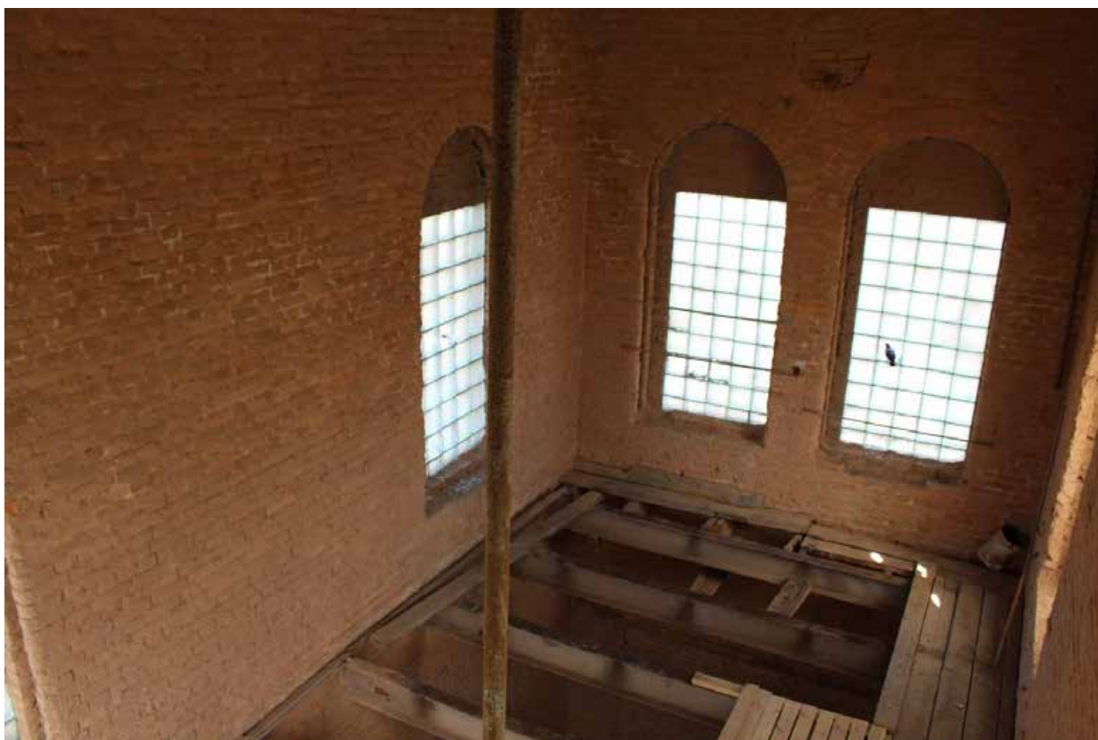
Фото 119. Центральный корпус объекта культурного наследия регионального значения «Производственные корпуса обувной фабрики». 1ЛК в уровне 7-го этажа.
