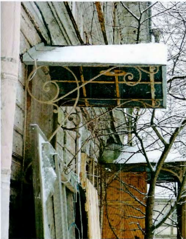
13. Кованый козырек на юго-западном фасаде.
