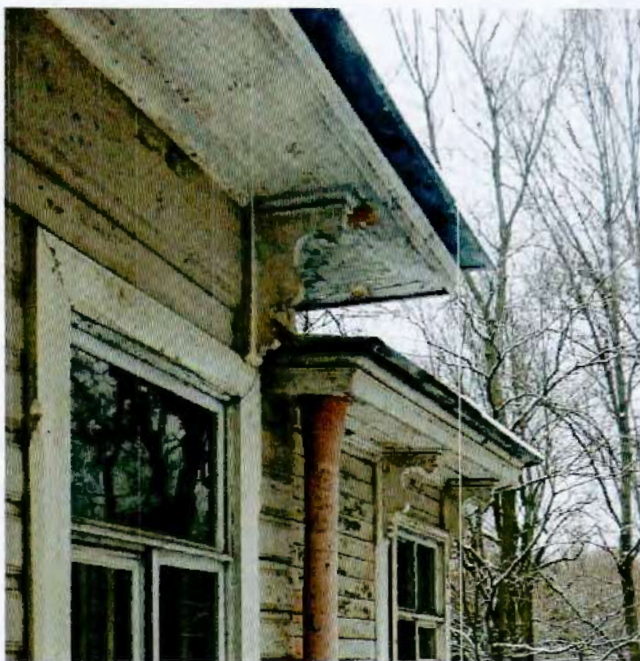
8. Фрагмент северо-восточного фасада.
