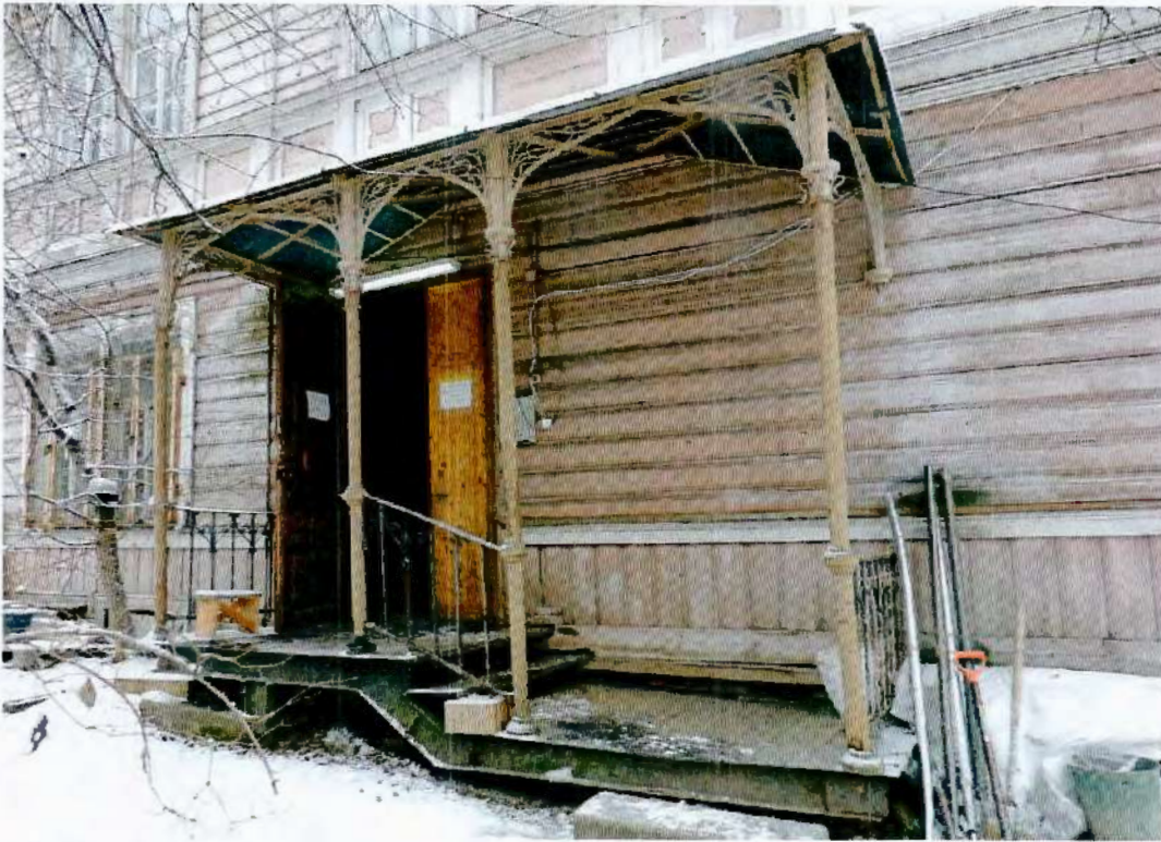
12. Фрагмент юго-западного фасада.
