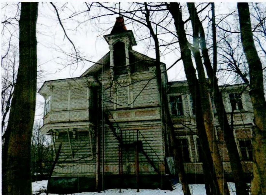
4. Общий вид с северо-востока.
