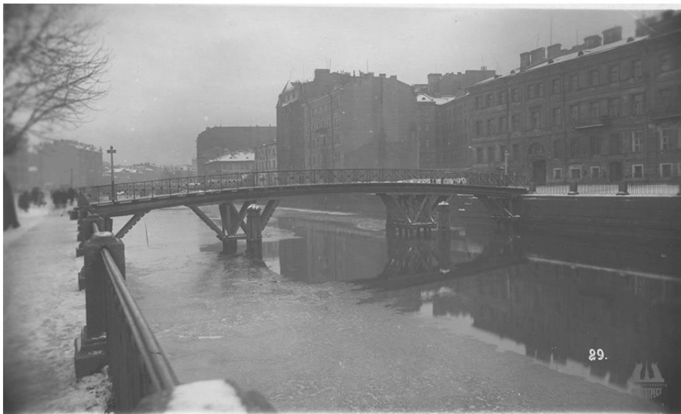
Илл. 17. Набережная канала Грибоедова. Фотография 1936 г. Источник: https://mostotrest-spb.ru/bridges/kolomenskiy .
