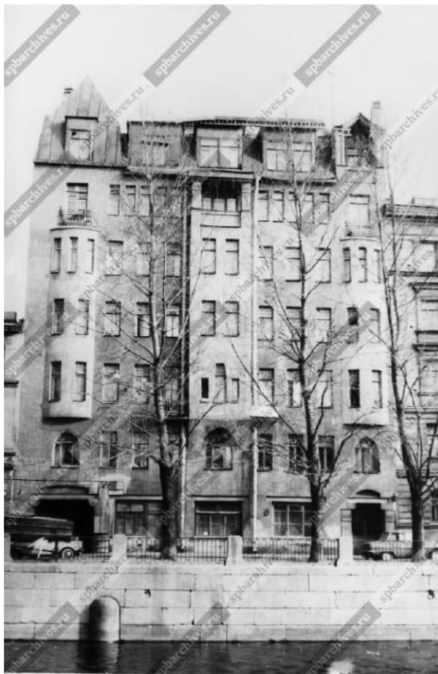
Илл. 19. ЦГАКФФ. Шифр Ар 212594. Общий вид дома №158 по набережной канала Грибоедова. Архитектор И.А. Претро. Фото 20 апреля 1983 г.
