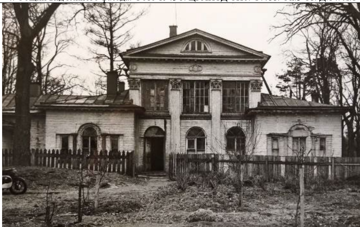
5. Северный (дворовый) фасад. Фото 1950 г. ЦГАНТД СПб. Ф.488. Оп.3-18. Д.84. Л.2
