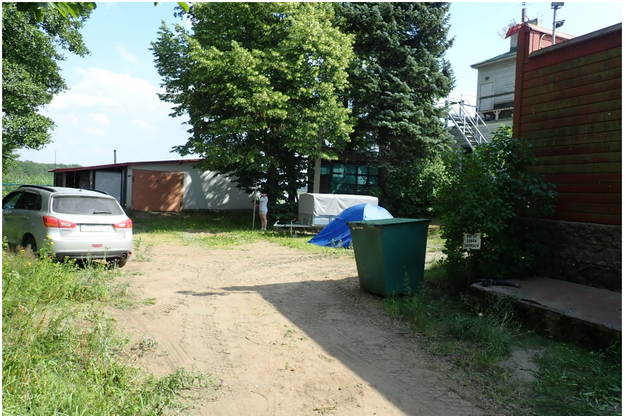
Рис.12. Объект №1. «Строительство спасательной станции № 19 по адресу: г. Санкт-Петербург, п. Лисий Нос, ул. Морские Дубки, д. 2, к. 3, лит. А». Точка фотофиксации 1. Вид с 3.
