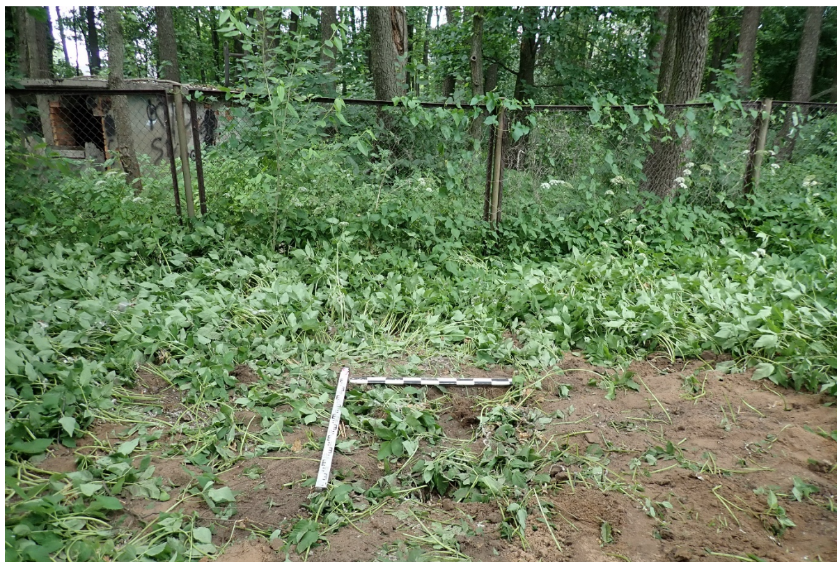
Рис.21. Объект №1. «Строительство спасательной станции № 19 по адресу: г. Санкт-Петербург, п. Лисий Нос, ул. Морские Дубки, д. 2, к. 3, лит. А». Шурф 1. После завершения работ. Вид с Ю.
