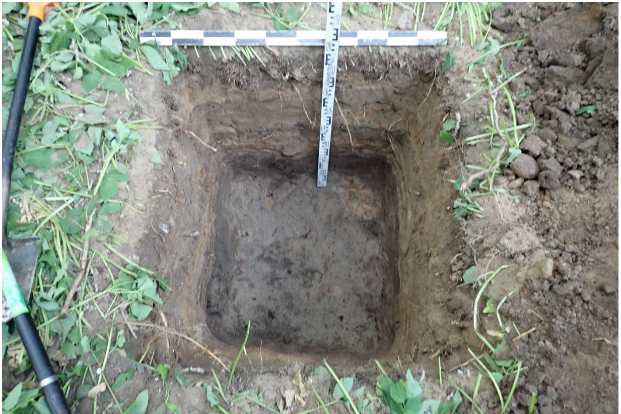
Рис.18. Объект №1. «Строительство спасательной станции № 19 по адресу: г. Санкт-Петербург, п. Лисий Нос, ул. Морские Дубки, д. 2, к. 3, лит. А». Шурф 1. Зачистка материковой поверхности. Вид с Ю.
