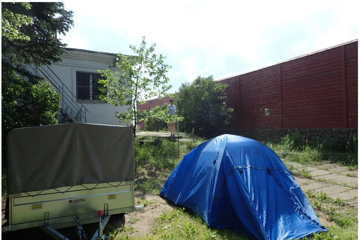
Рис.13. Объект №1. «Строительство спасательной станции № 19 по адресу: г. Санкт-Петербург, п. Лисий Нос, ул. Морские Дубки, д. 2, к. 3, лит. А». Точка фотофиксации 1. Вид с 3.
