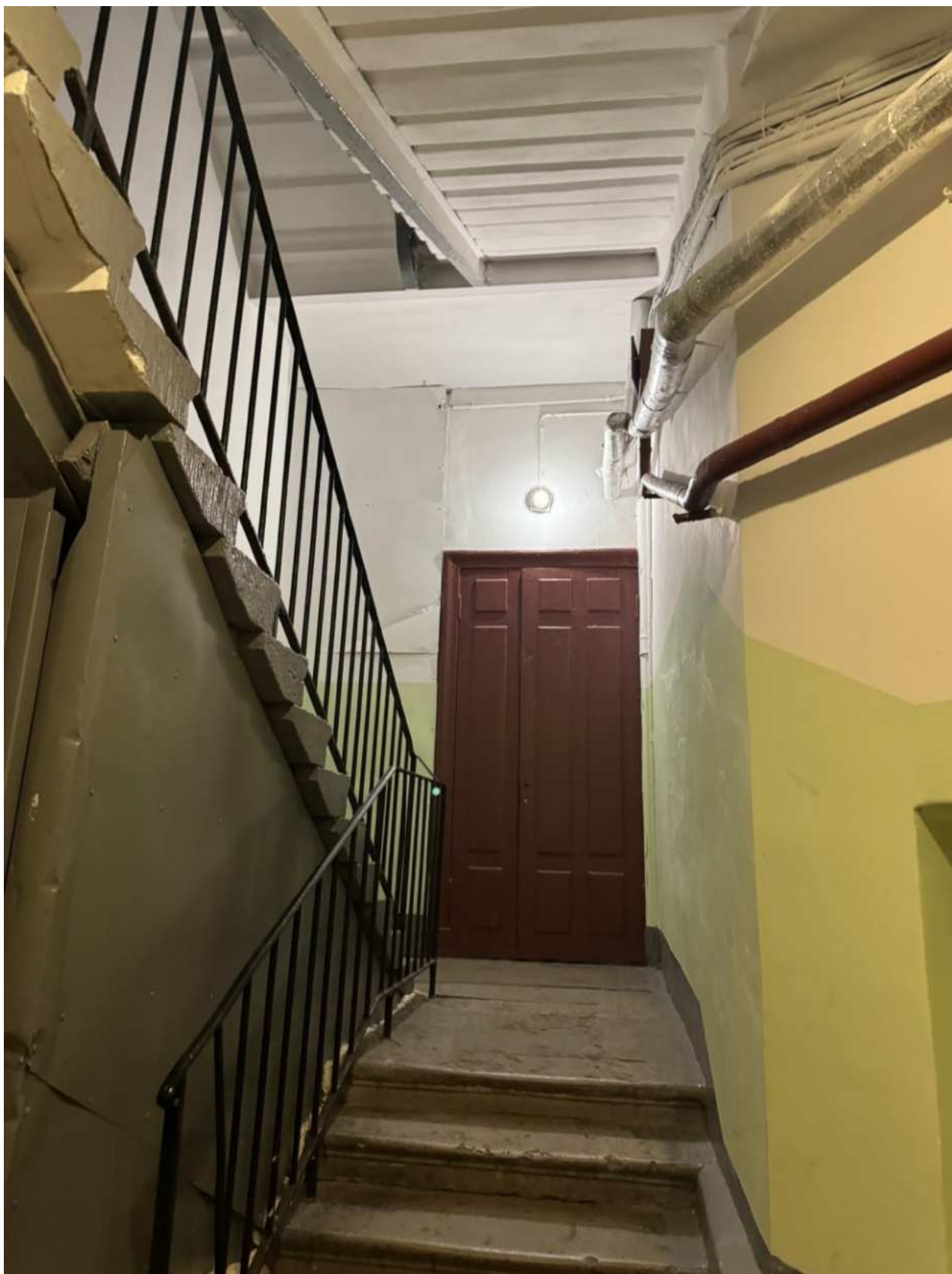
Фото 84. Вид на интерьер лестницы 4ЛК объекта культурного наследия.
