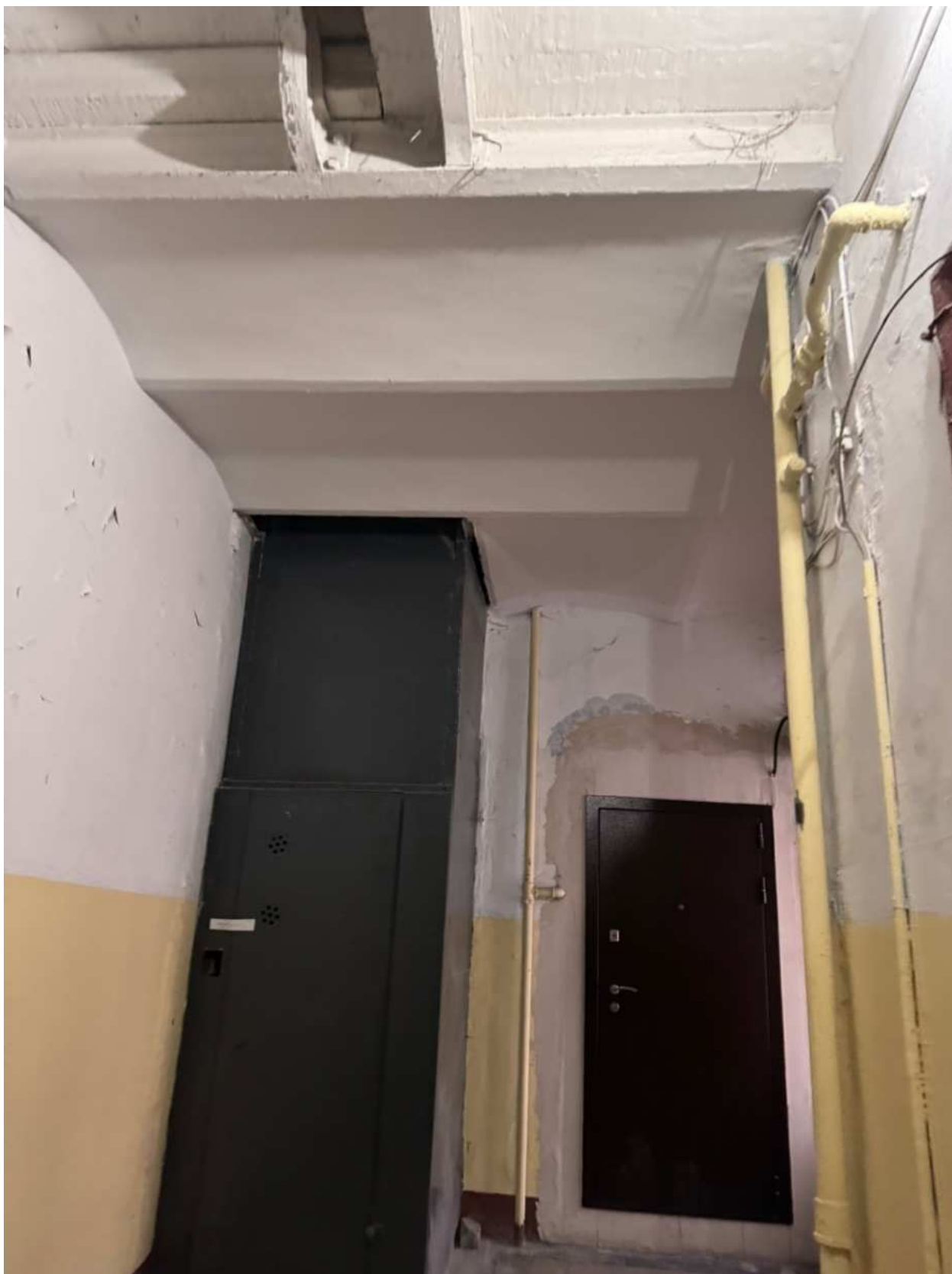
Фото 96. Вид на интерьер лестницы 5ЛК объекта культурного наследия.
