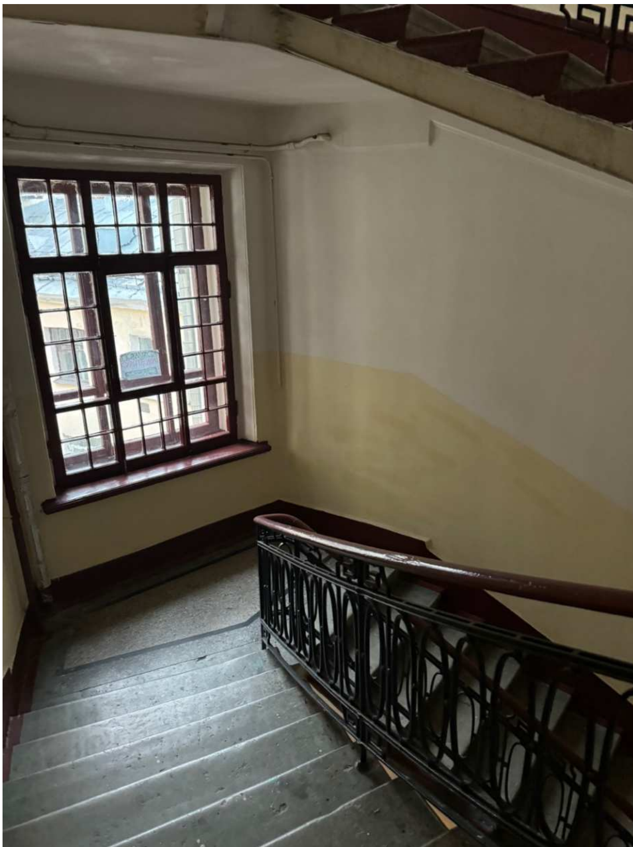
Фото 28. Вид на интерьер лестницы 1ЛК объекта культурного наследия.
