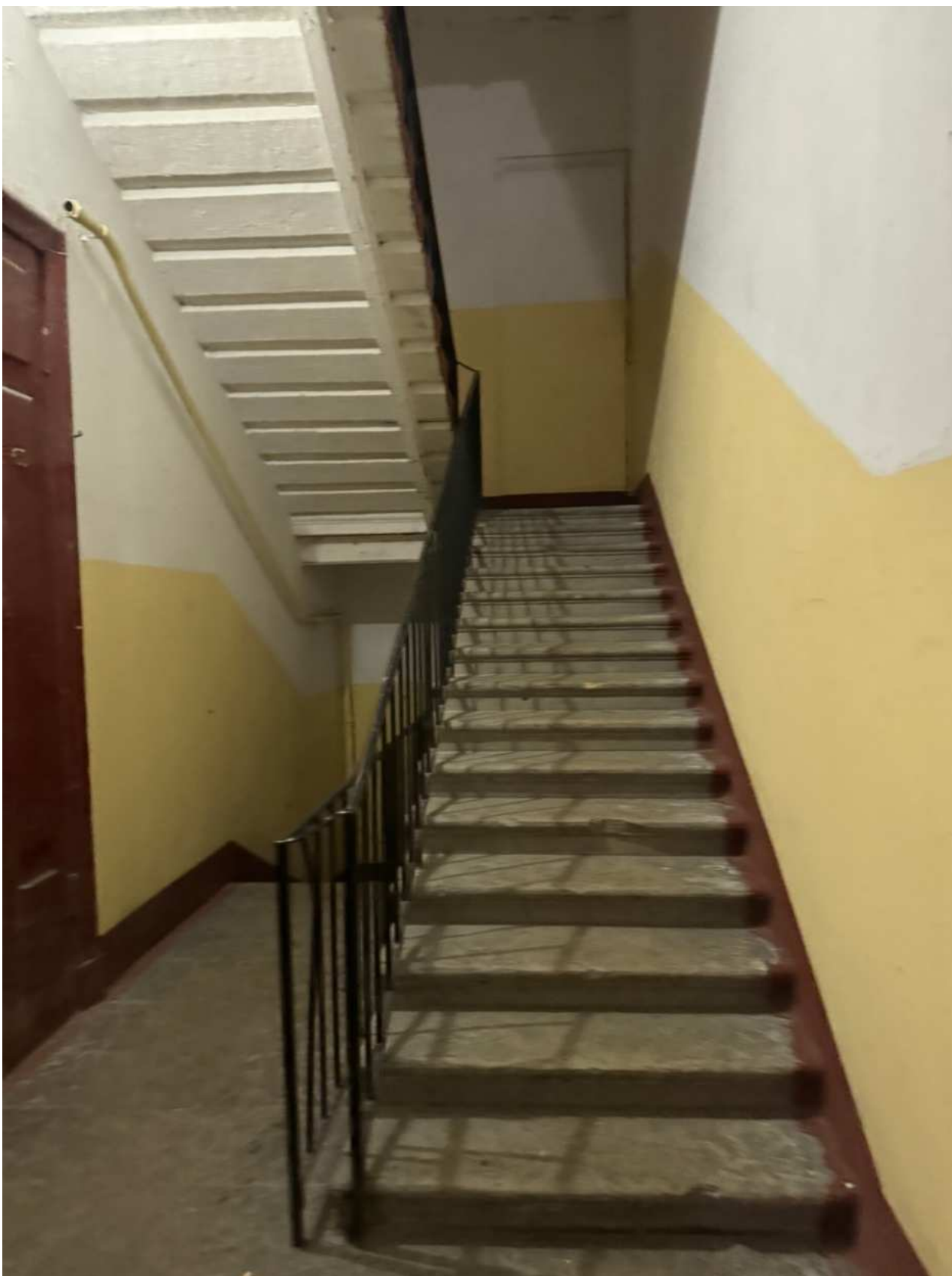
Фото 98. Вид на интерьер лестницы 5ЛК объекта культурного наследия.
