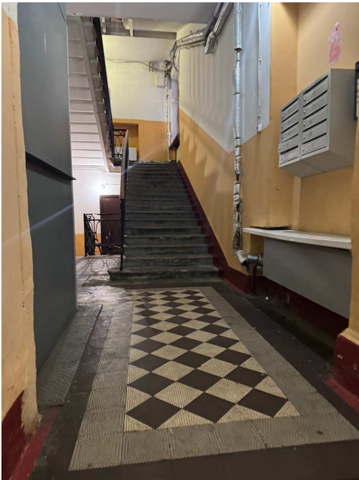
Фото 39. Вид на интерьер лестницы 2ЛК объекта культурного наследия.
