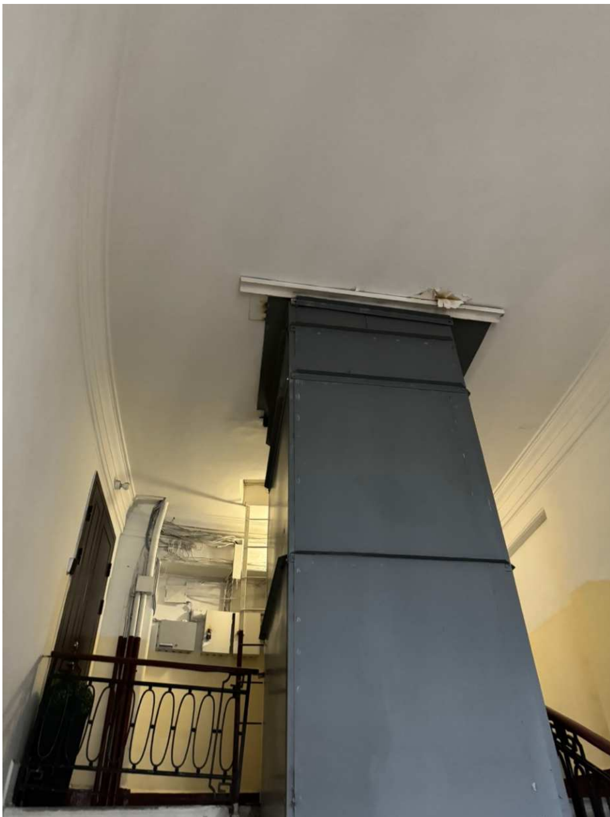
Фото 31. Вид на интерьер лестницы 1ЛК объекта культурного наследия.
