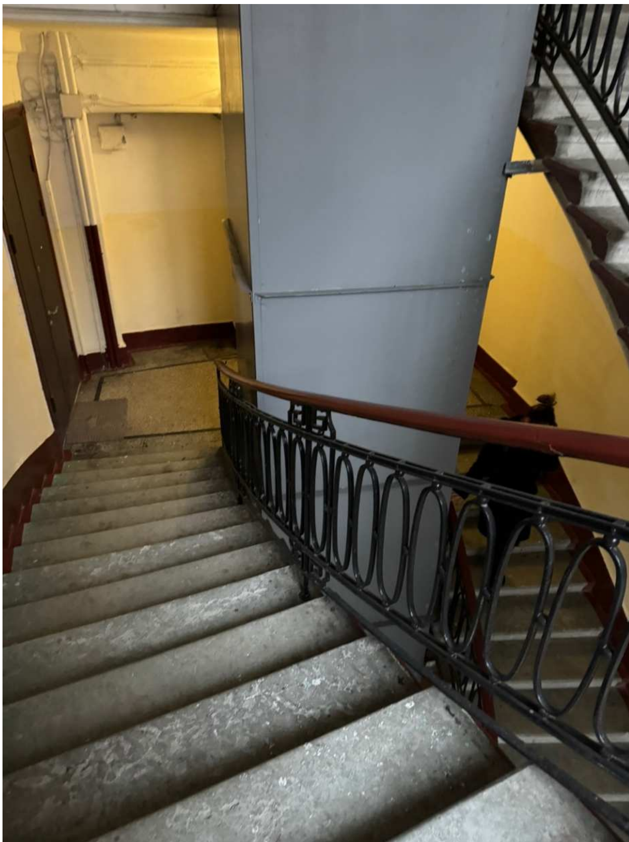
Фото 32. Вид на интерьер лестницы 1ЛК объекта культурного наследия.
