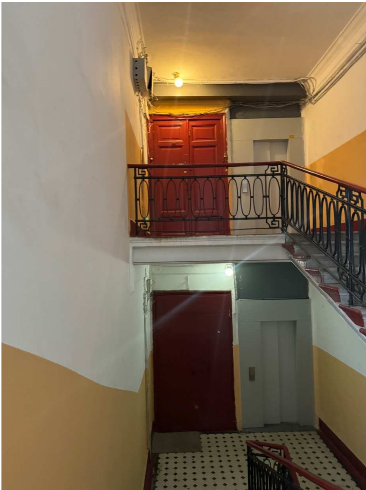
Фото 55. Вид на интерьер лестницы 2ЛК объекта культурного наследия.
