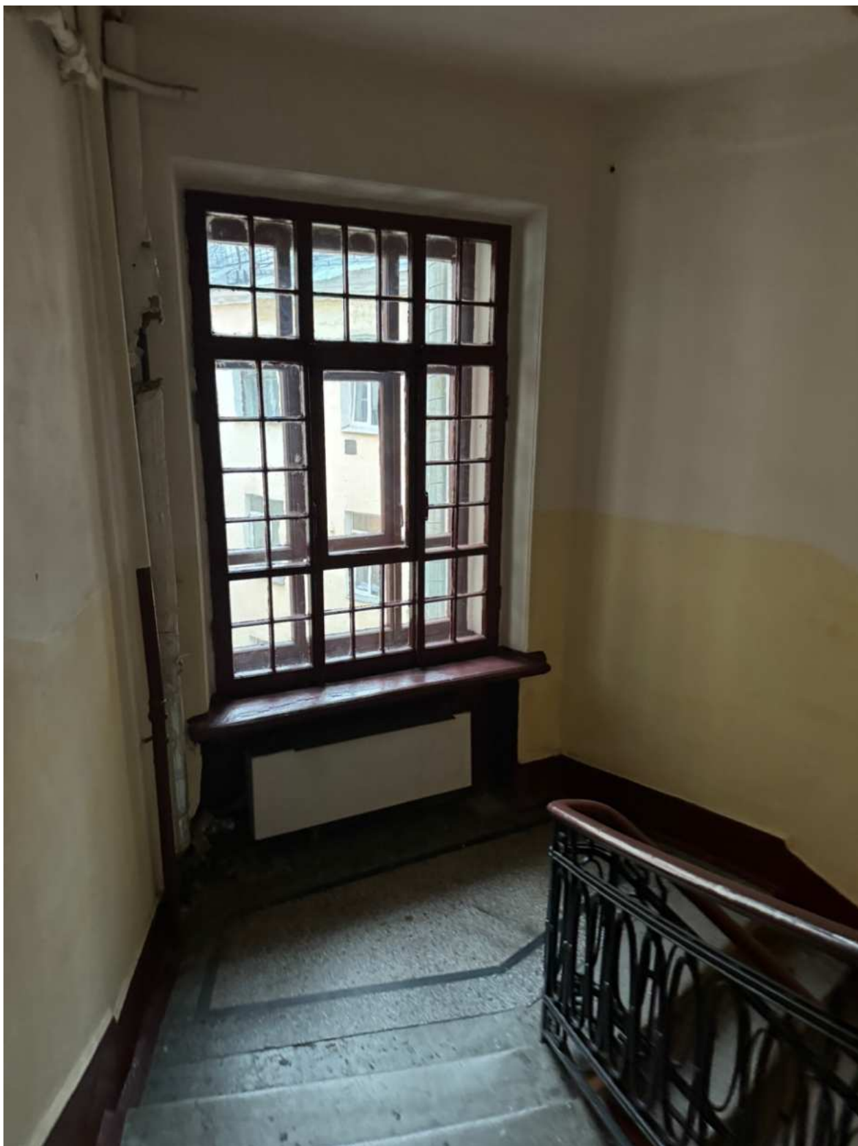
Фото 24. Вид на интерьер лестницы 1ЛК объекта культурного наследия.
