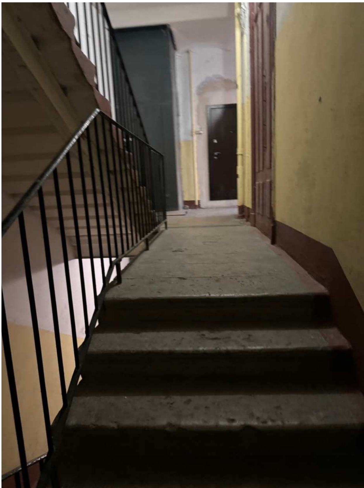
Фото 94. Вид на интерьер лестницы 5ЛК объекта культурного наследия.
