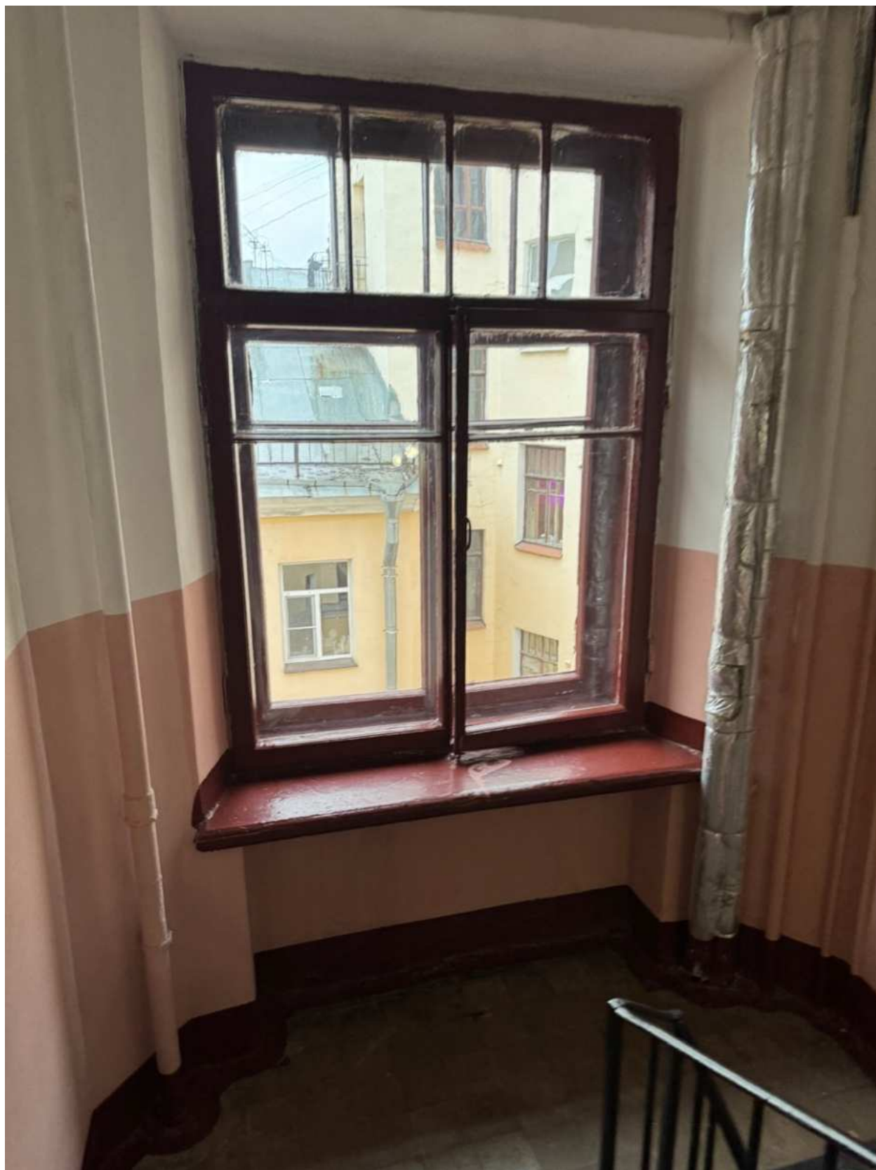
Фото 64. Вид на оконное заполнение лестницы ЗЛК объекта культурного наследия.
