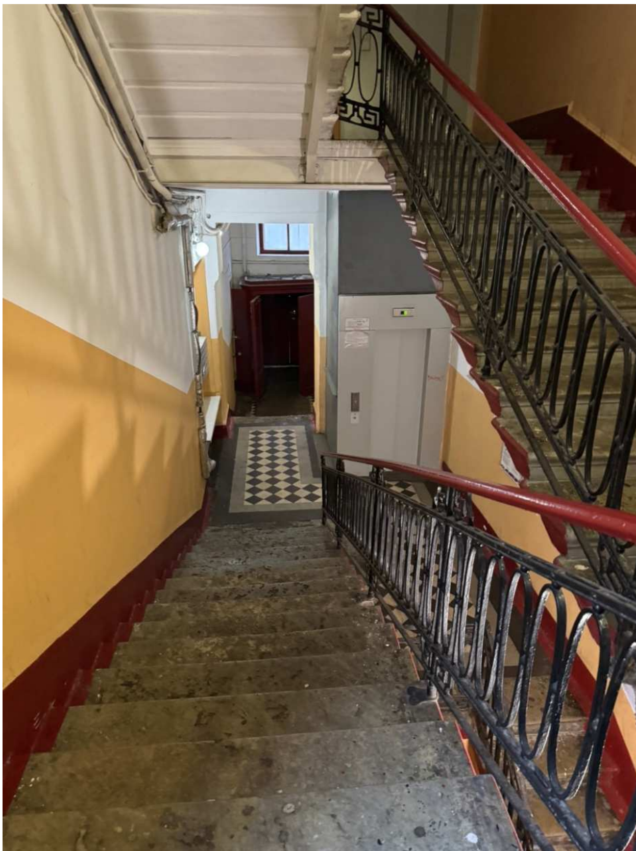
Фото 42. Вид на интерьер лестницы 2ЛК объекта культурного наследия.
