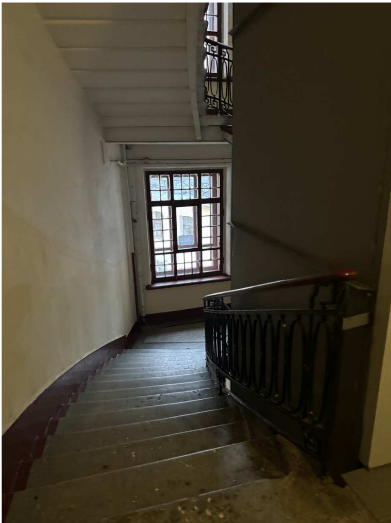
Фото 29. Вид на интерьер лестницы 1ЛК объекта культурного наследия.
