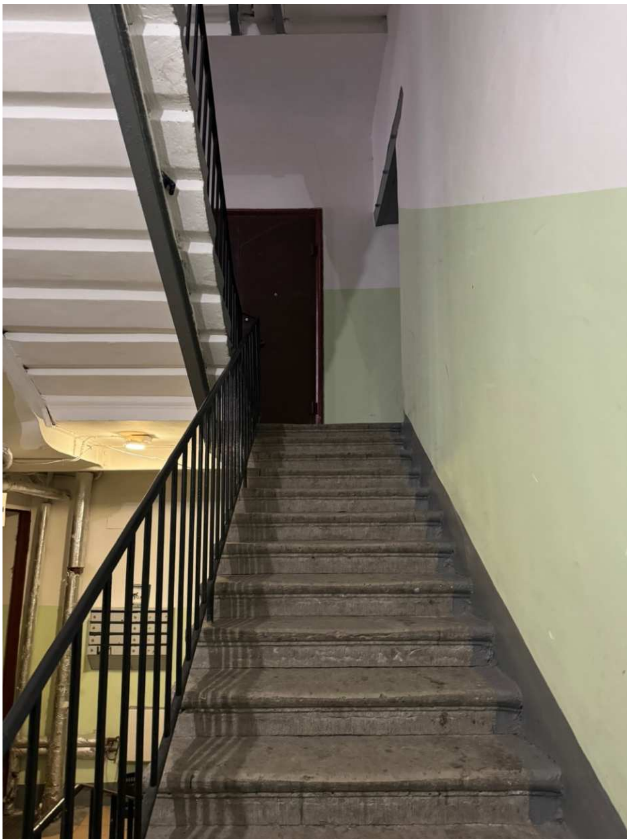
Фото 85. Вид на интерьер лестницы 4ЛК объекта культурного наследия.
