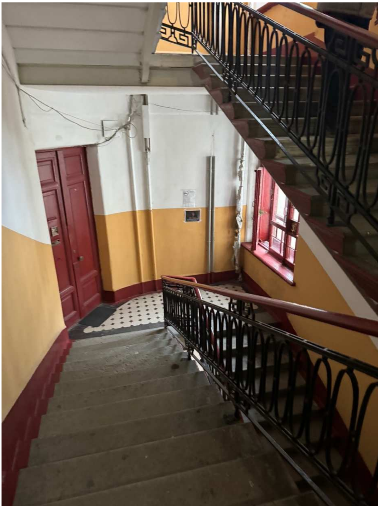
Фото 53. Вид на интерьер лестницы 2ЛК объекта культурного наследия.
