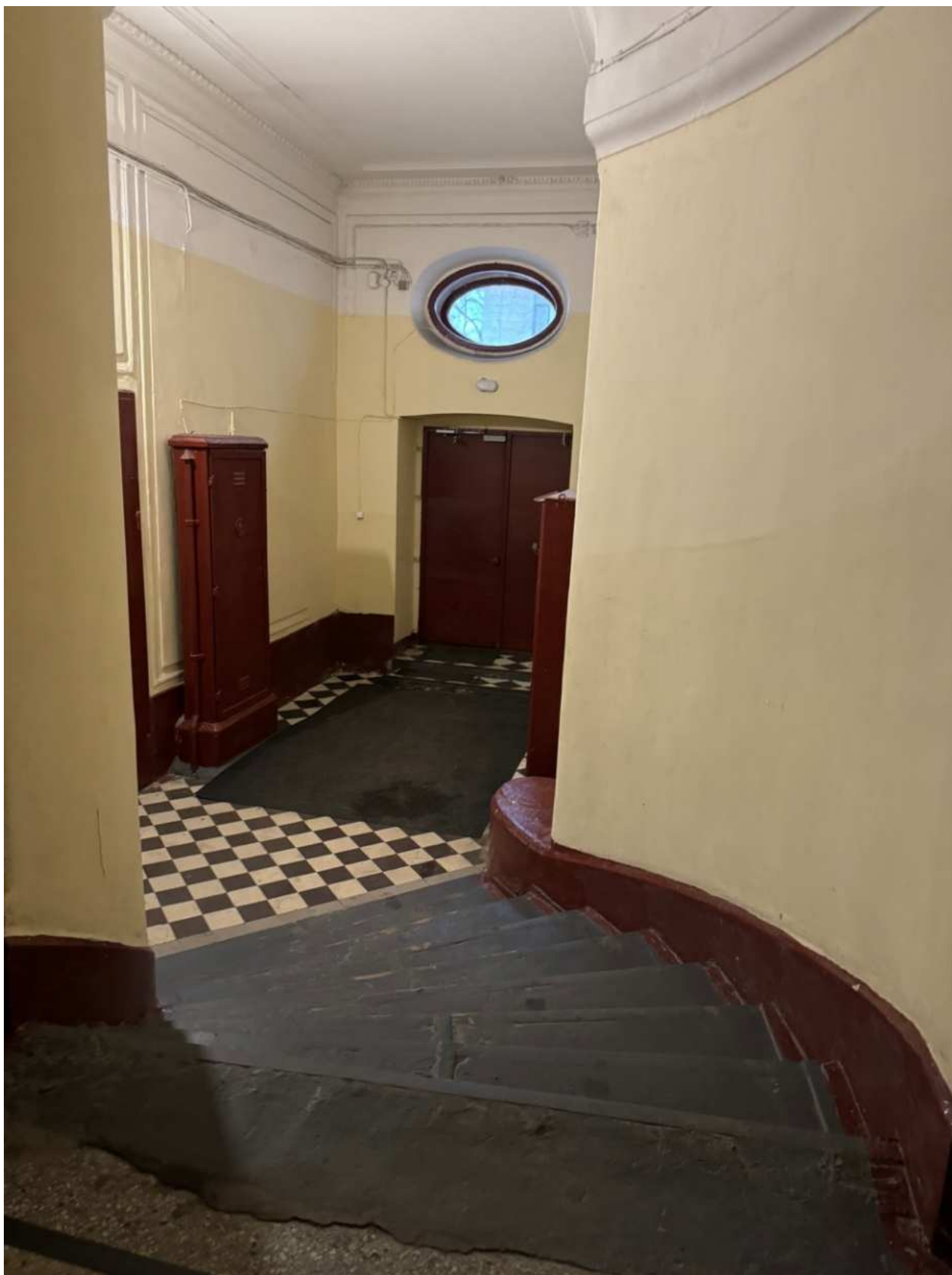
Фото 16. Вид на интерьер лестницы 1ЛК объекта культурного наследия.
