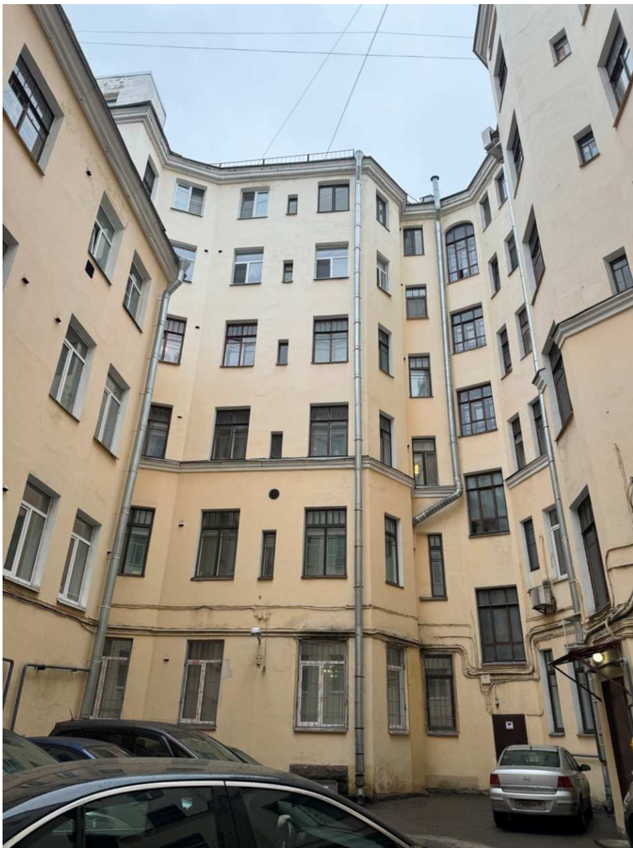
Фото 9. Вид на дворовые фасады объекта культурного наследия.
