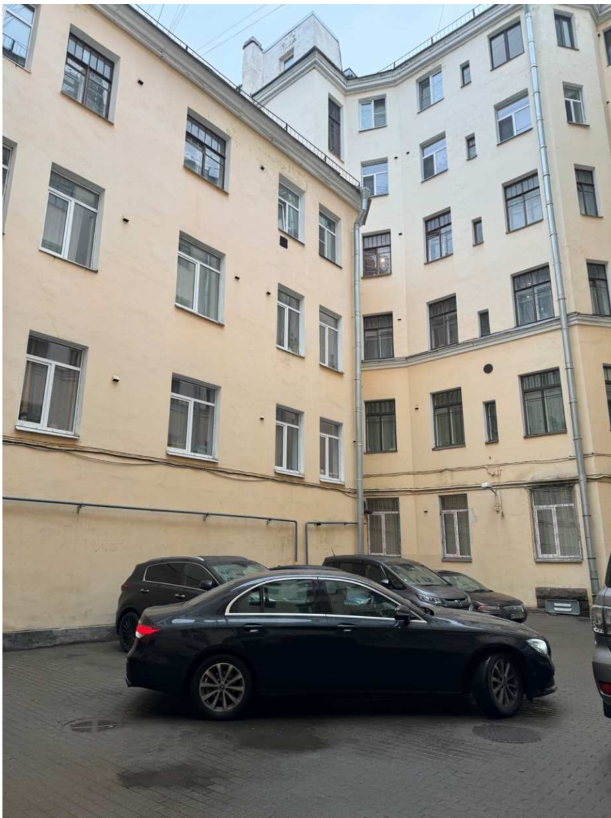
Фото 10. Вид на дворовые фасады объекта культурного наследия.
