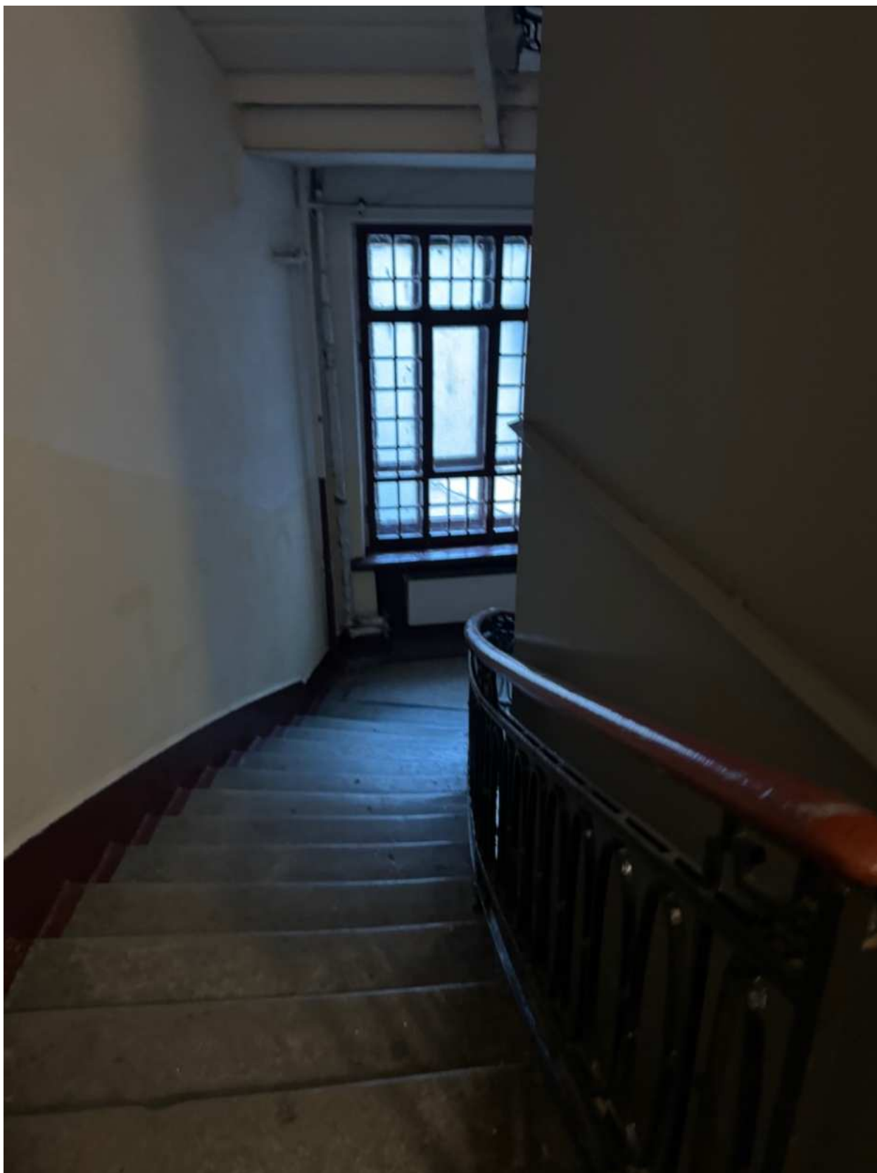
Фото 22. Вид на интерьер лестницы 1ЛК объекта культурного наследия.
