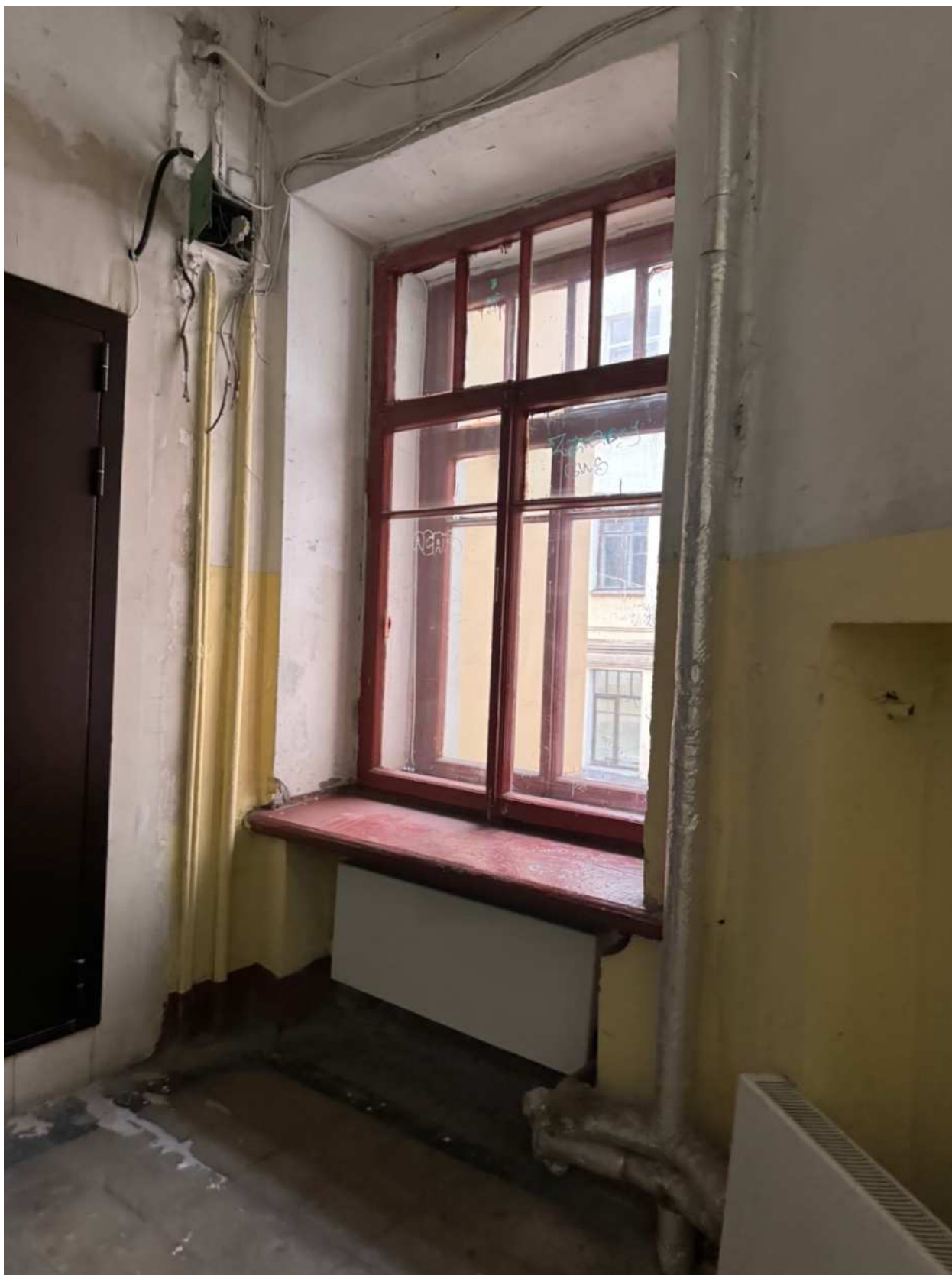
Фото 97. Вид на оконное заполнение лестницы 5ЛК объекта культурного наследия.
