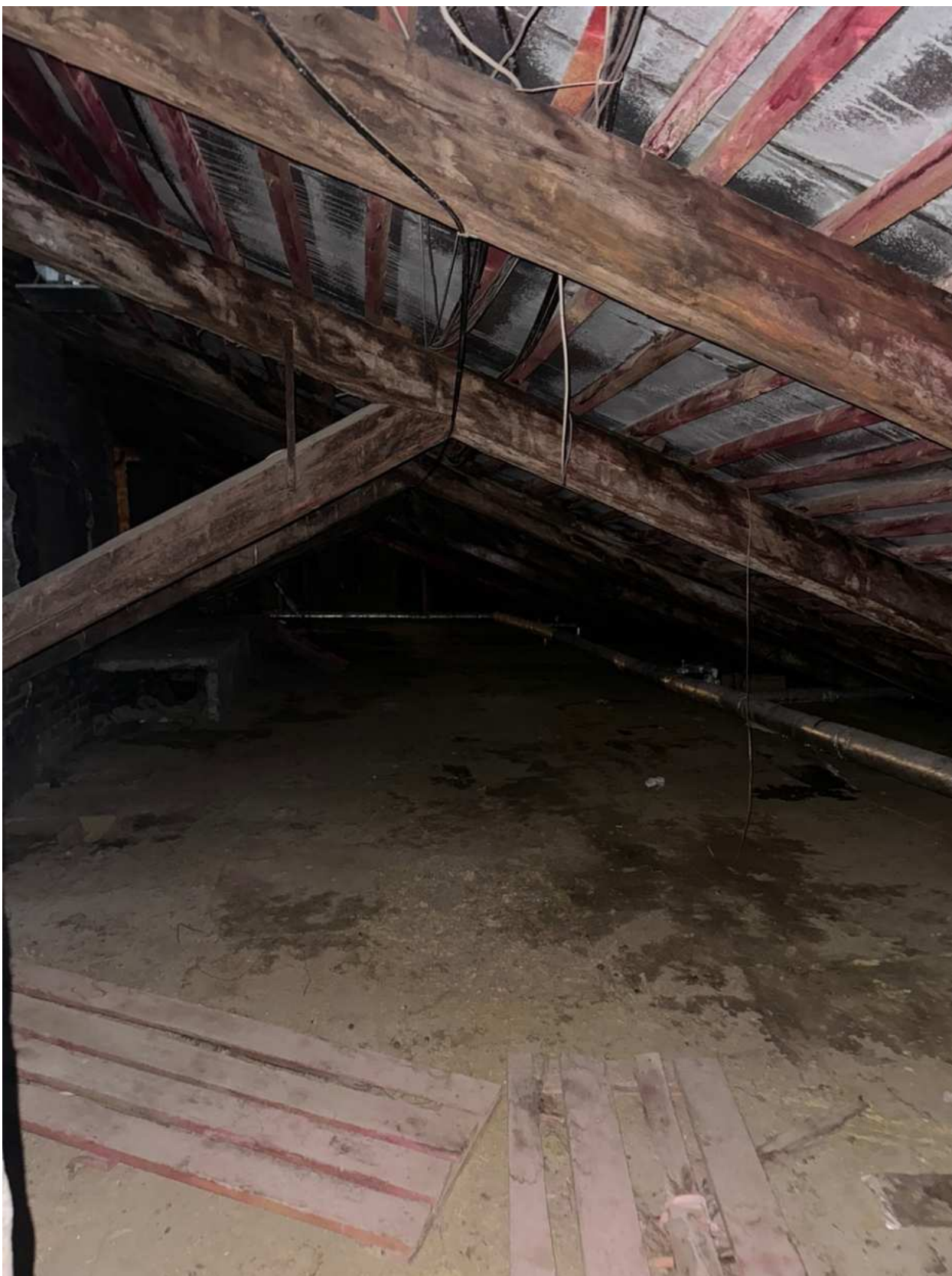
Фото 80. Вид на чердачное помещение объекта культурного наследия.
