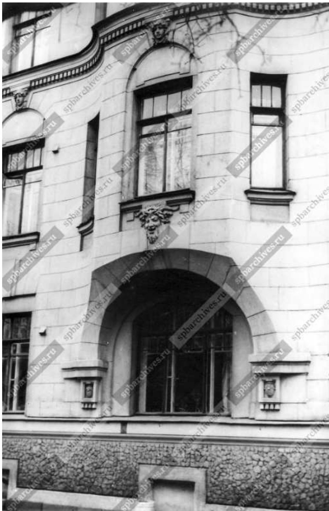
48. Вид части фасада жилого дома № 57/15 со стороны Большого проспекта Васильевского острова, оформленного эркером ( бывший доходный дом Л.Н.Бенуа, архитектор Л.Н.Бенуа, 1913-1914 гг.), 1983 г. – ЦГАКФД СПб – Фотодокумент Оп.1АР-157. Ед.хр.225708
