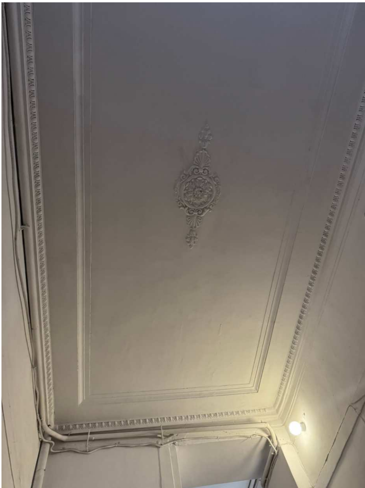
Фото 38. Вид на интерьер лестницы 2ЛК объекта культурного наследия.
