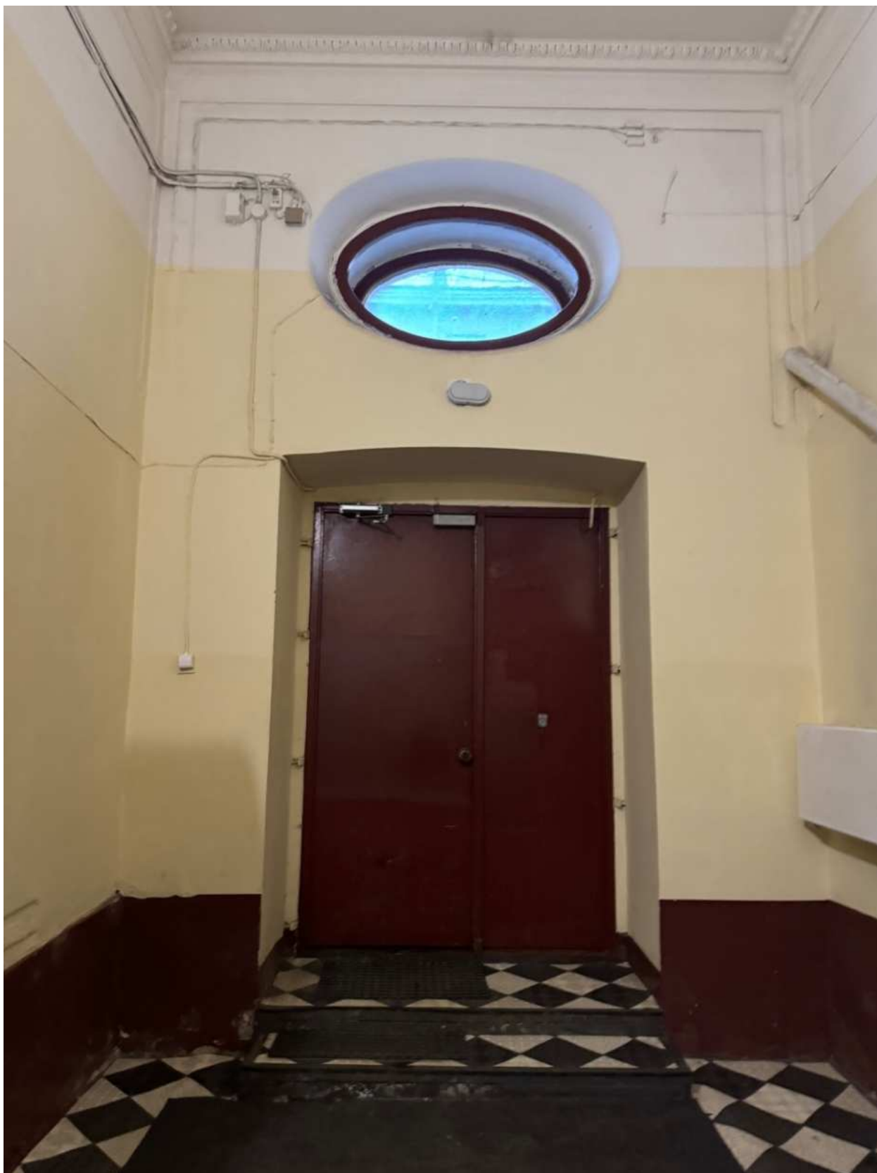
Фото 18. Вид на интерьер лестницы 1ЛК объекта культурного наследия.
