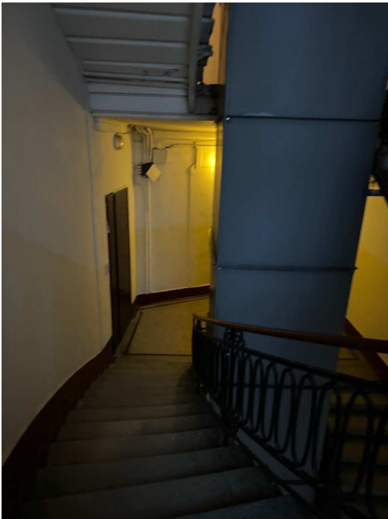
Фото 21. Вид на интерьер лестницы 1ЛК объекта культурного наследия.
