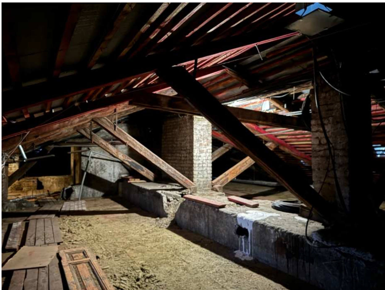
Фото 78. Вид на чердачное помещение объекта культурного наследия.
