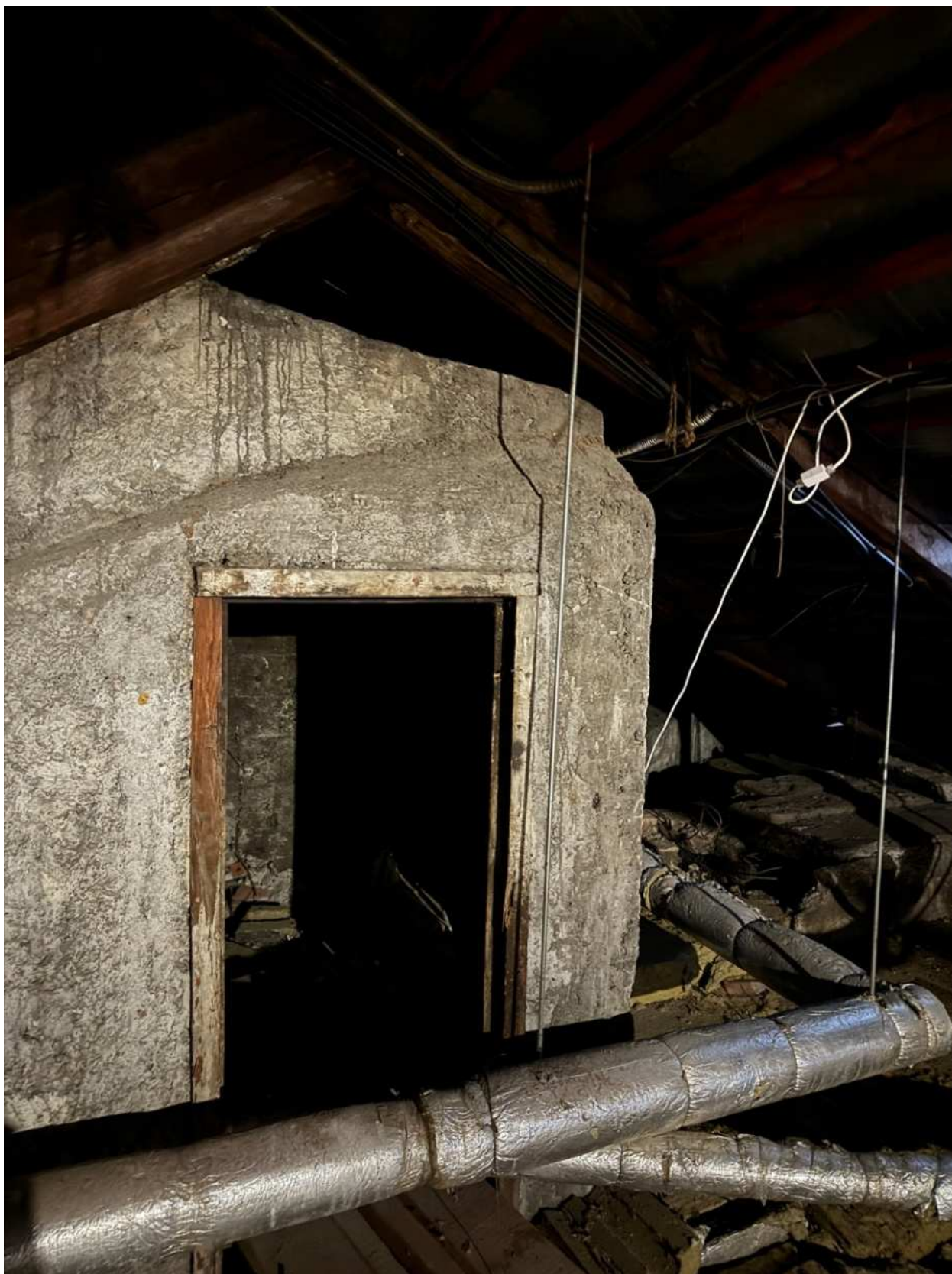
Фото 75. Вид на чердачное помещение объекта культурного наследия.
