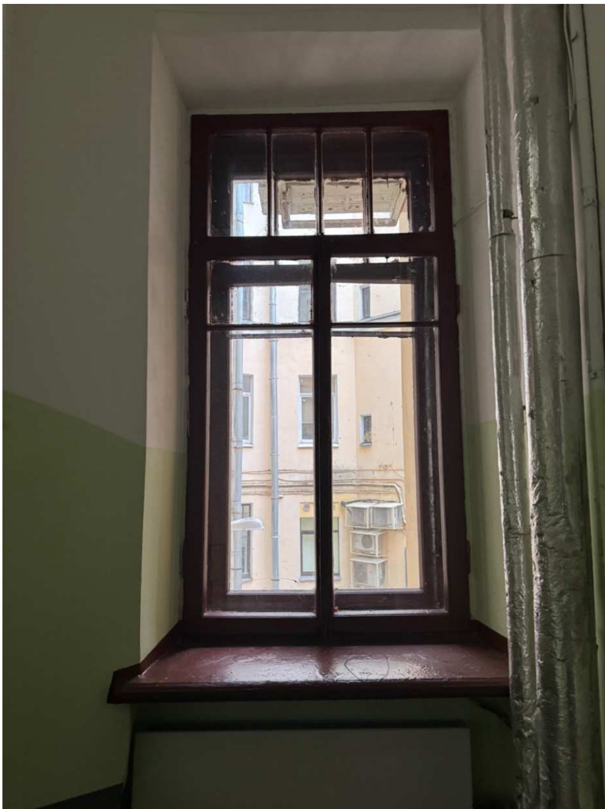
Фото 86. Вид на оконное заполнение лестницы 4ЛК объекта культурного наследия.
