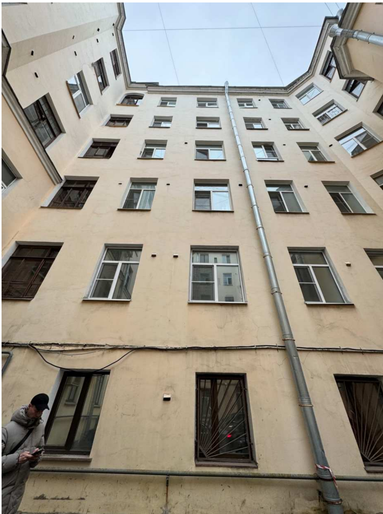
Фото 12. Вид на дворовые фасады объекта культурного наследия.
