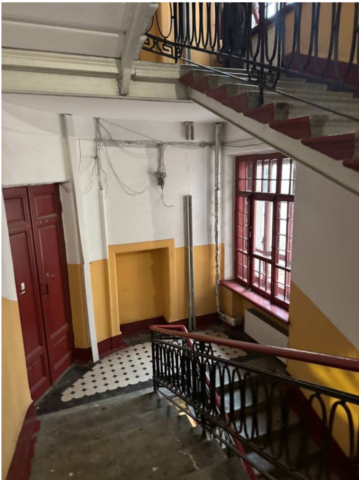
Фото 46. Вид на интерьер лестницы 2ЛК объекта культурного наследия.
