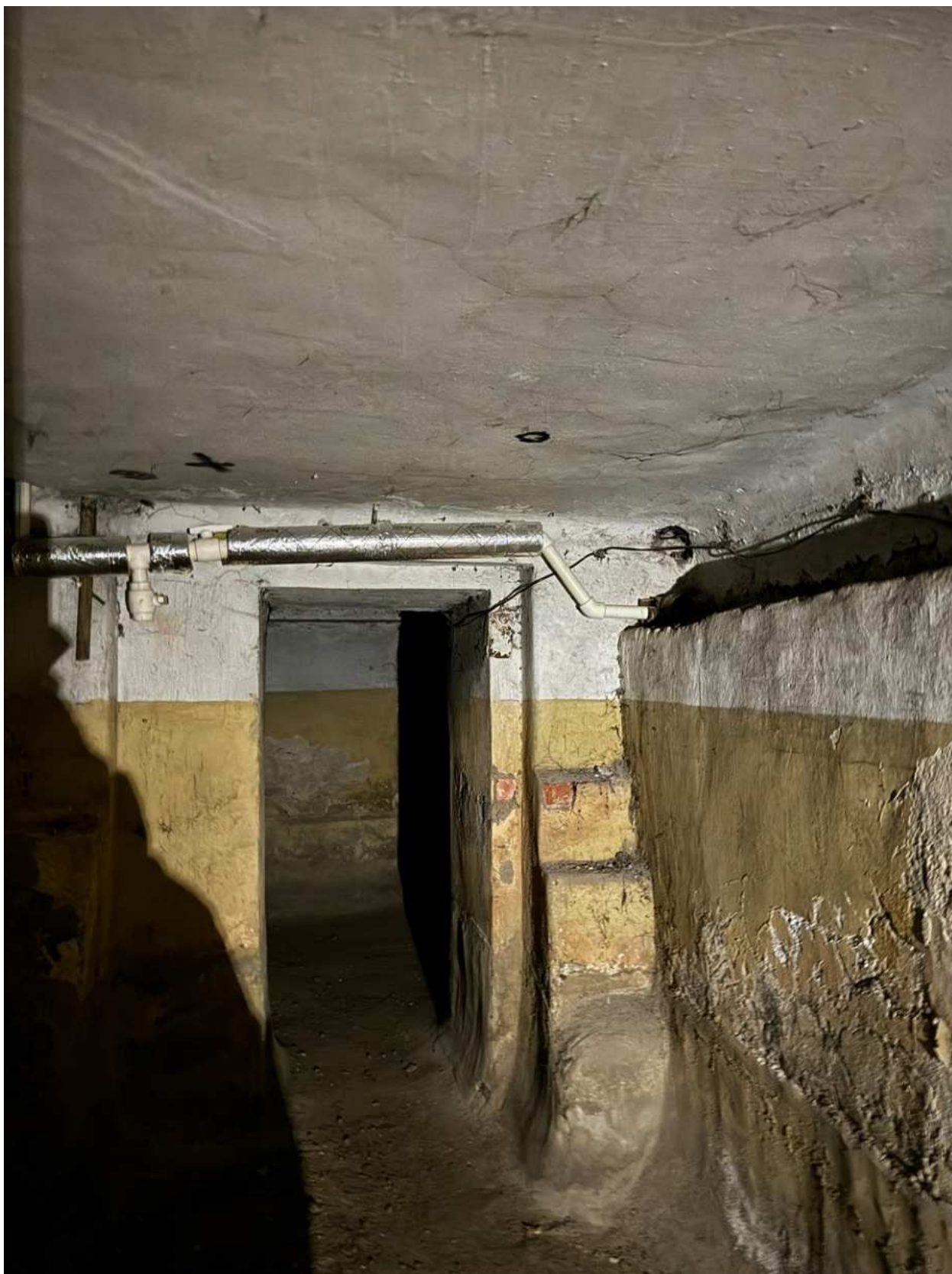
Фото 91. Вид на подвальное помещение объекта культурного наследия.
