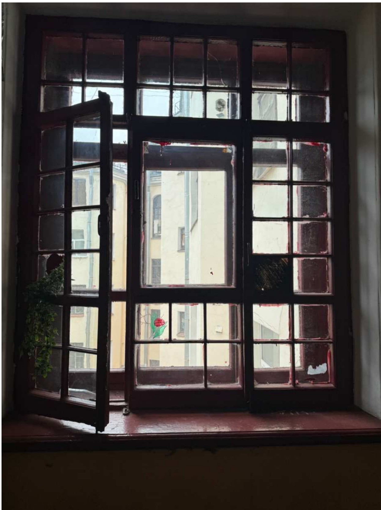
Фото 52. Вид на интерьер лестницы 2ЛК объекта культурного наследия.
