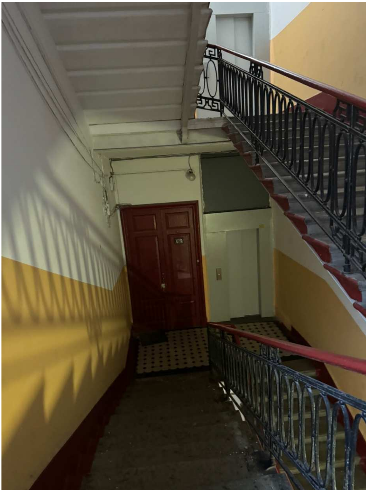
Фото 45. Вид на интерьер лестницы 2ЛК объекта культурного наследия.
