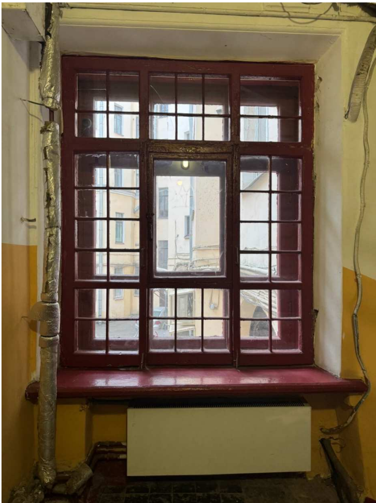
Фото 41. Вид на оконное заполнение лестницы 2ЛК объекта культурного наследия.
