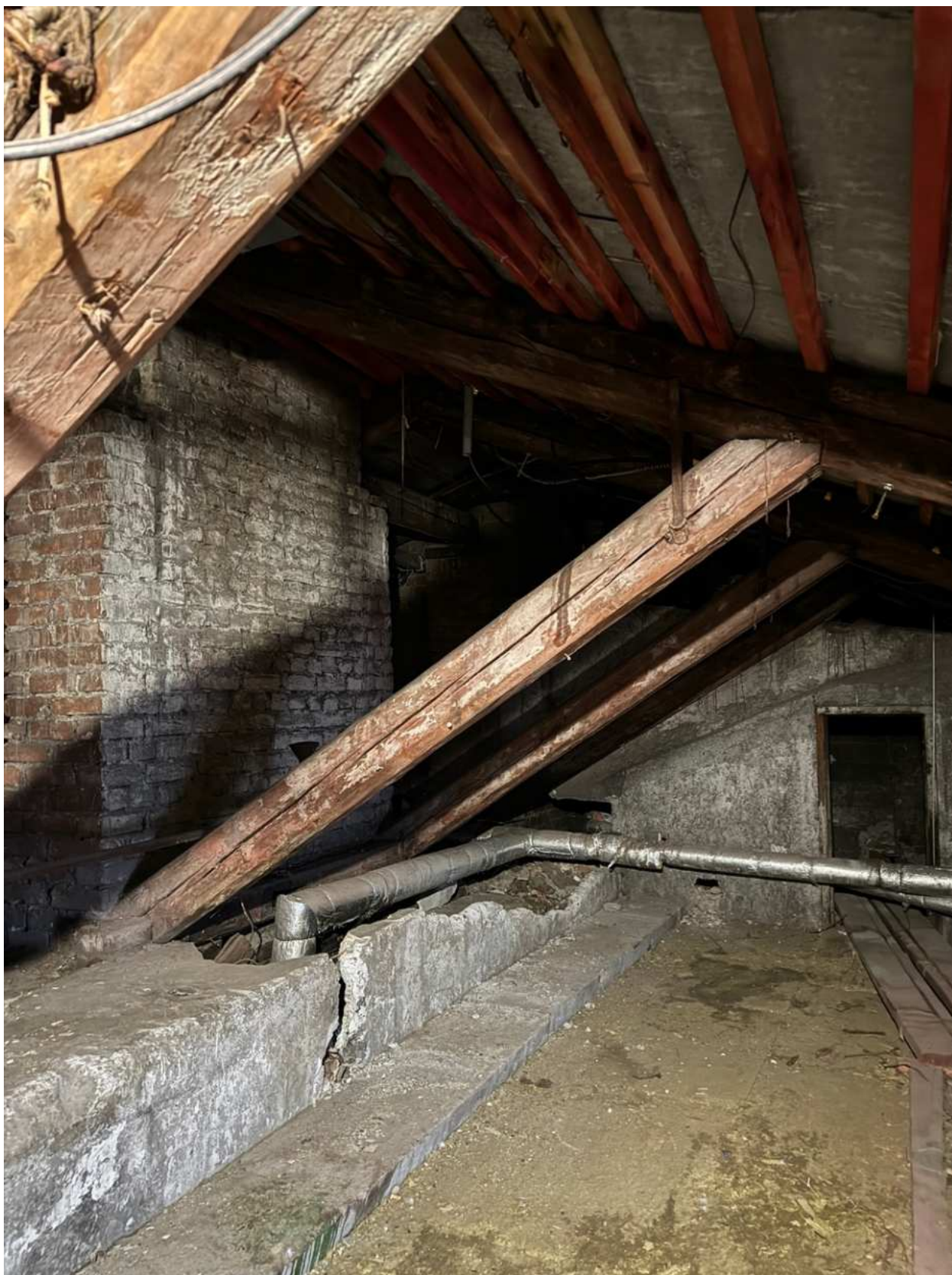
Фото 73. Вид на чердачное помещение объекта культурного наследия.
