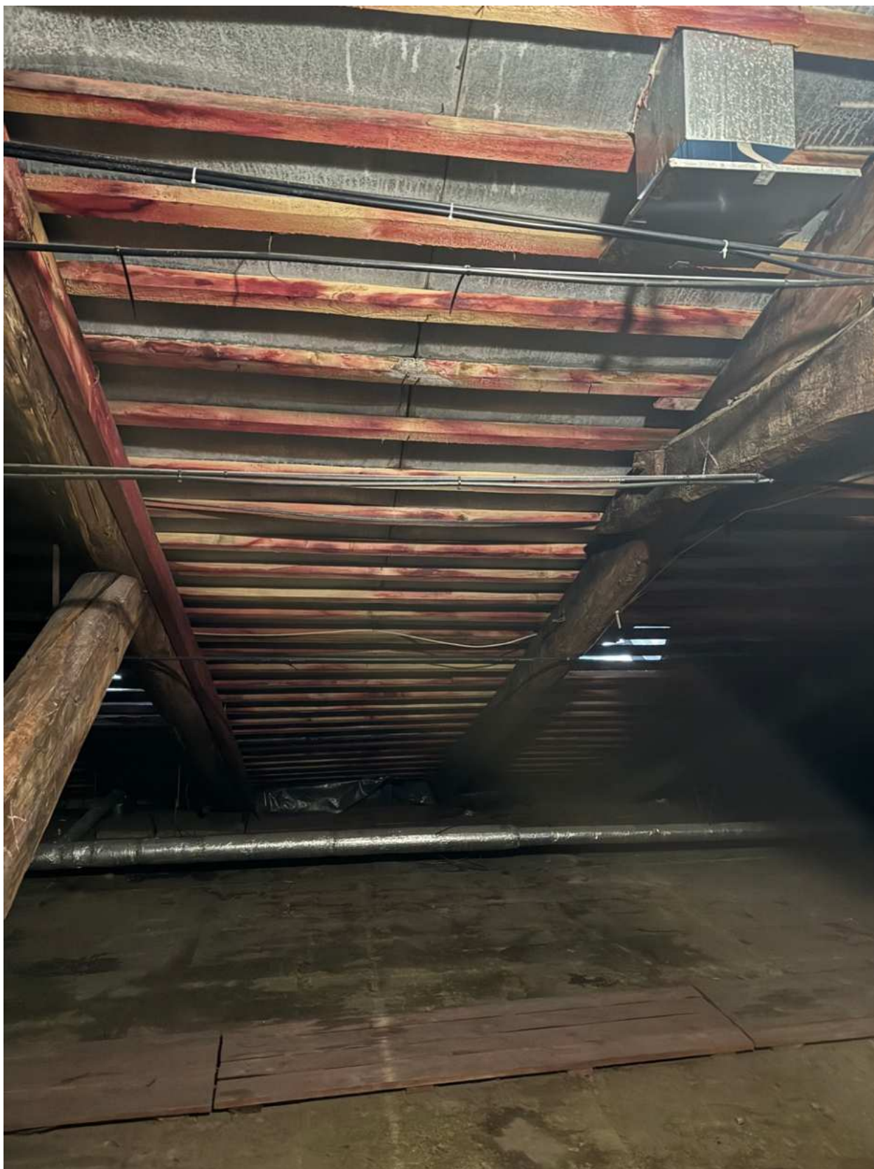
Фото 82. Вид на чердачное помещение объекта культурного наследия.
