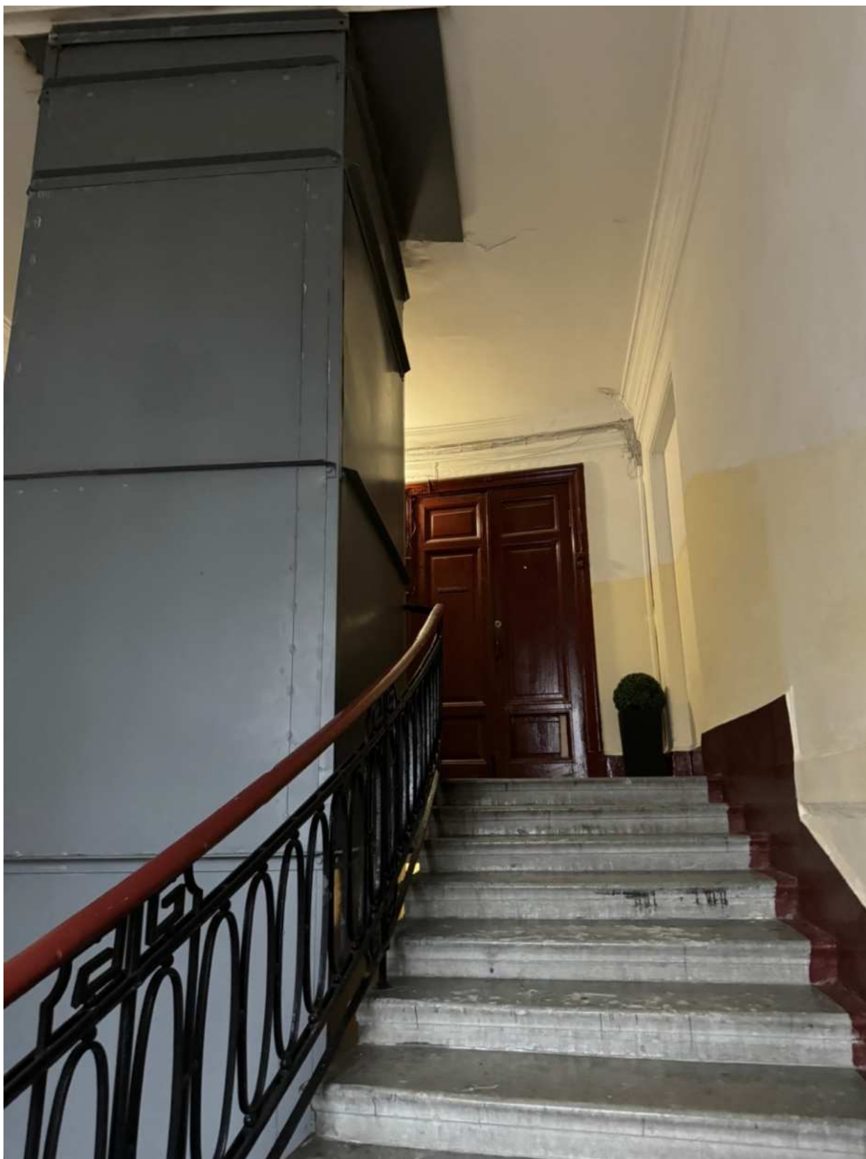
Фото 33. Вид на интерьер лестницы 1ЛК объекта культурного наследия.
