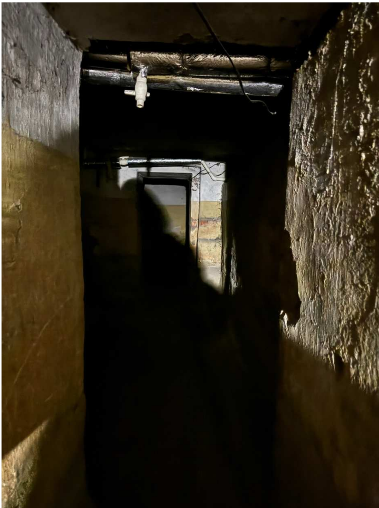
Фото 90. Вид на подвальное помещение объекта культурного наследия.
