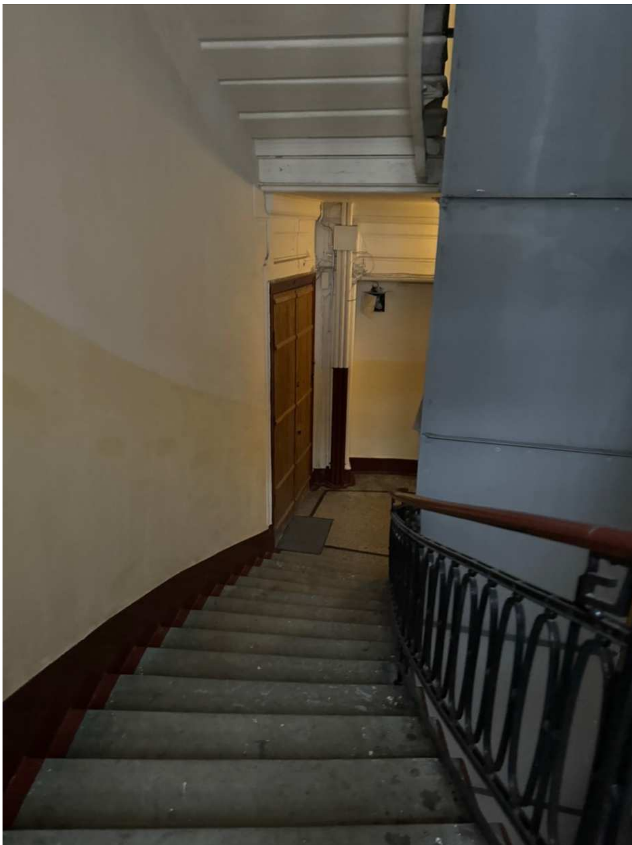
Фото 27. Вид на интерьер лестницы 1ЛК объекта культурного наследия.
