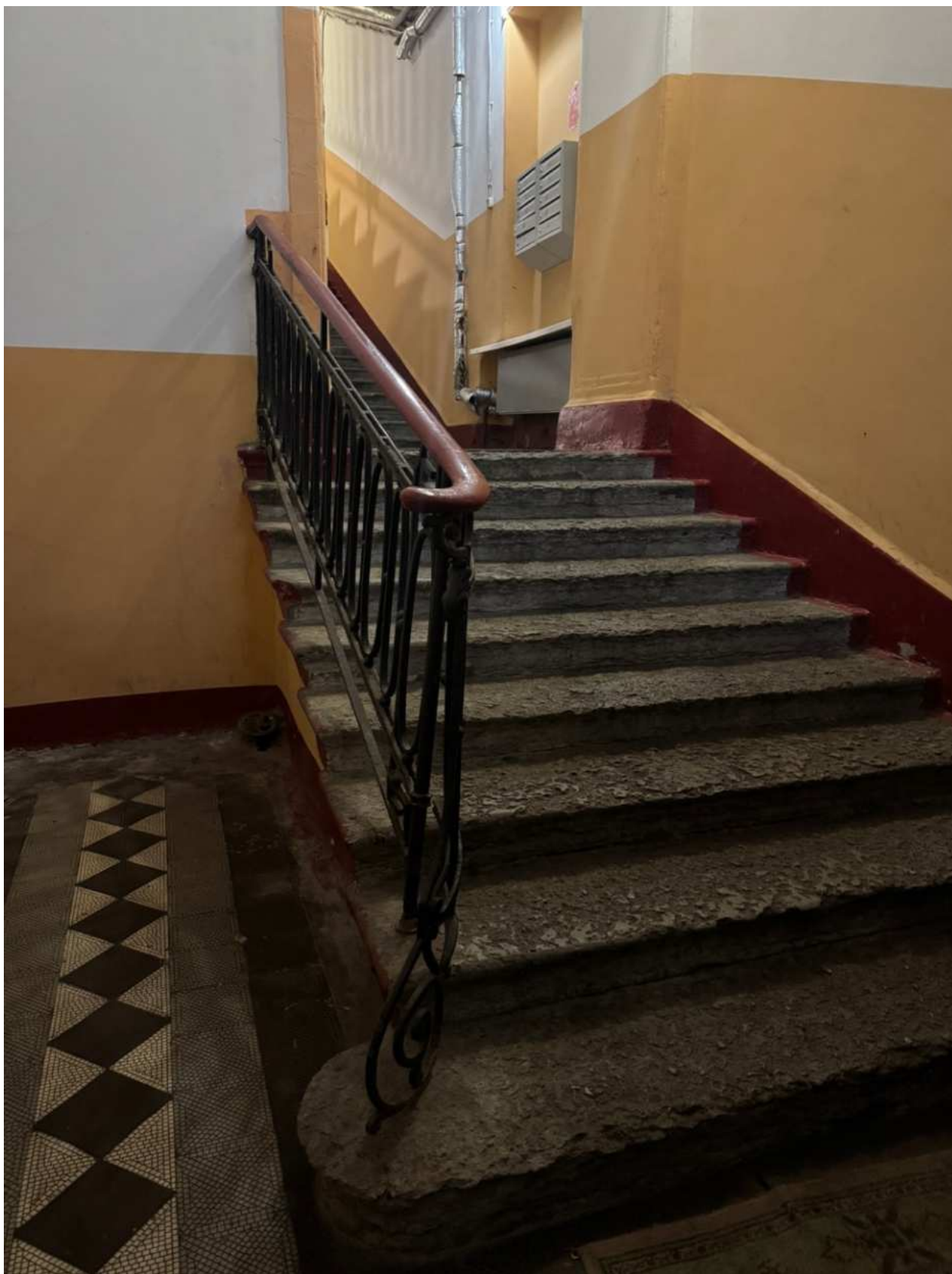
Фото 36. Вид на интерьер лестницы 2ЛК объекта культурного наследия.
