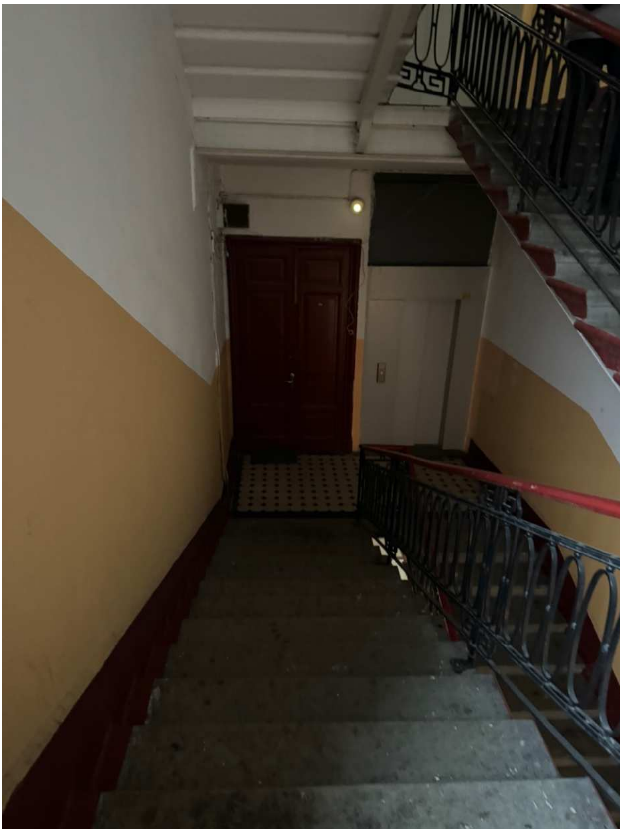
Фото 50. Вид на интерьер лестницы 2ЛК объекта культурного наследия.
