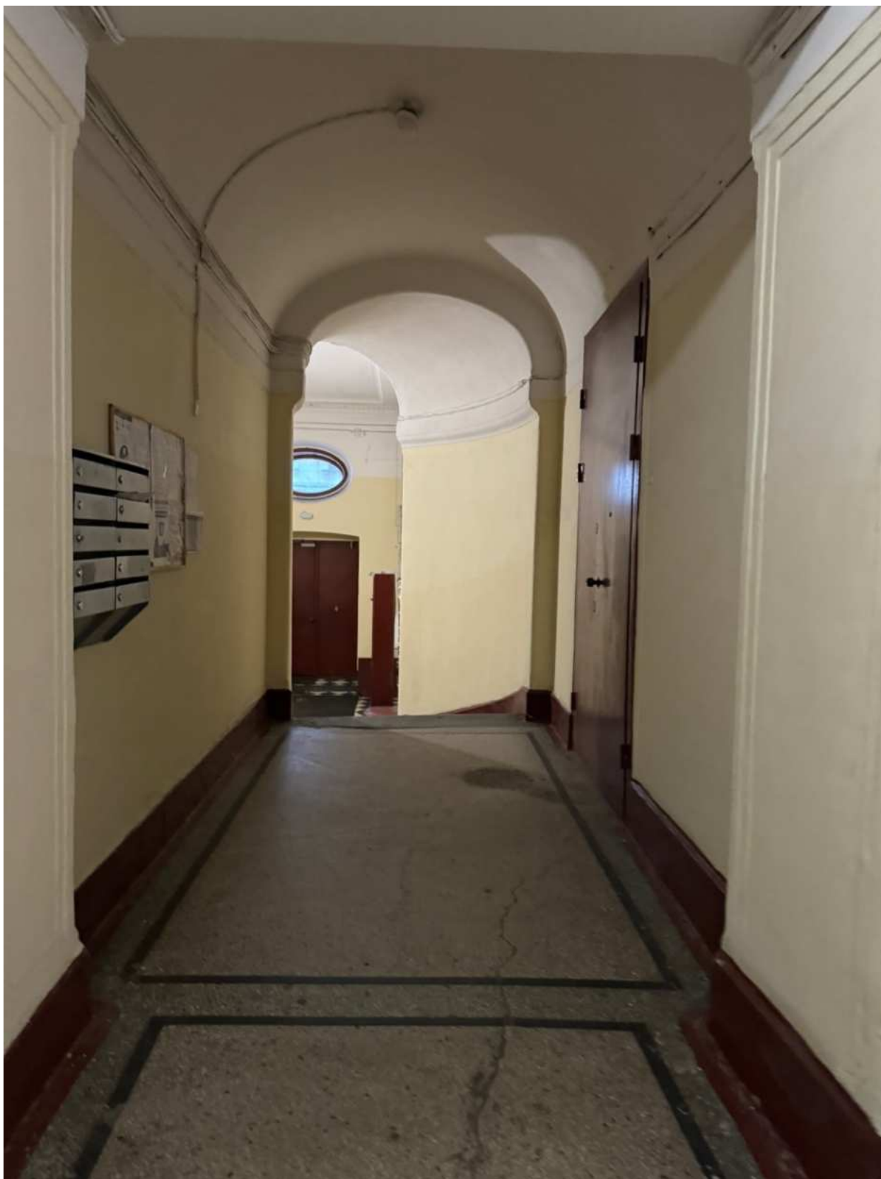
Фото 15. Вид на интерьер лестницы 1ЛК объекта культурного наследия.
