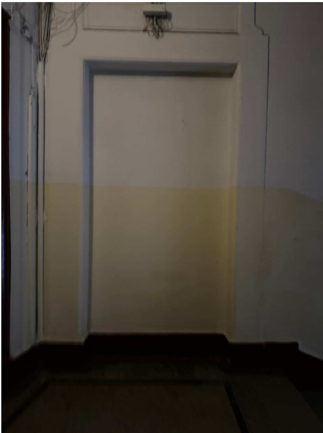
Фото 26. Вид на интерьер лестницы 1ЛК объекта культурного наследия.
