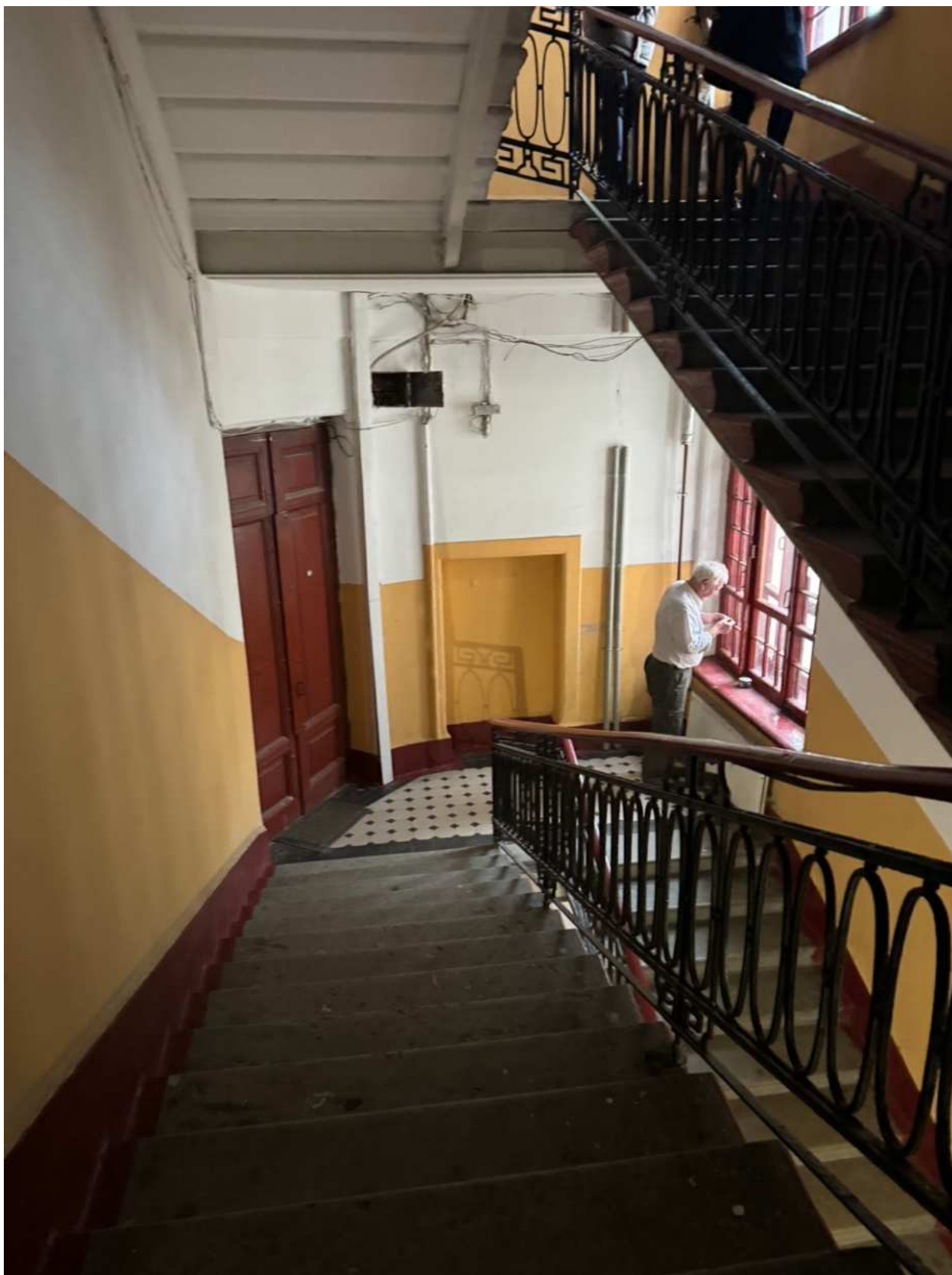
Фото 48. Вид на интерьер лестницы 2ЛК объекта культурного наследия.
