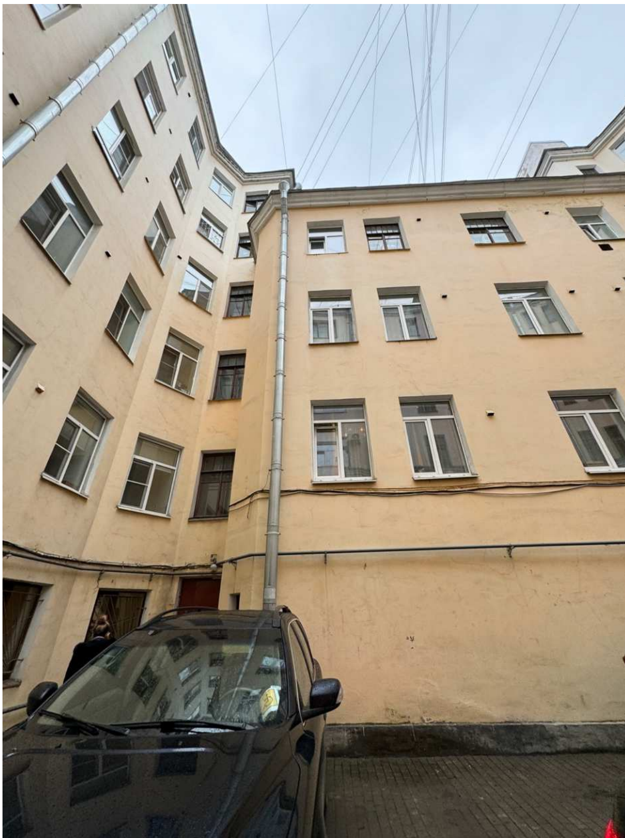
Фото 13. Вид на дворовые фасады объекта культурного наследия.
