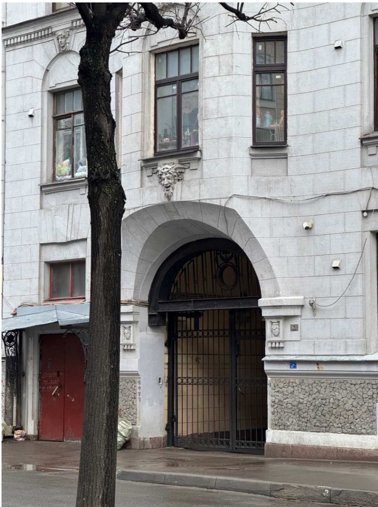
Фото 3. Фрагмент лицевого фасада объекта культурного наследия по 16-й линии В.О.
