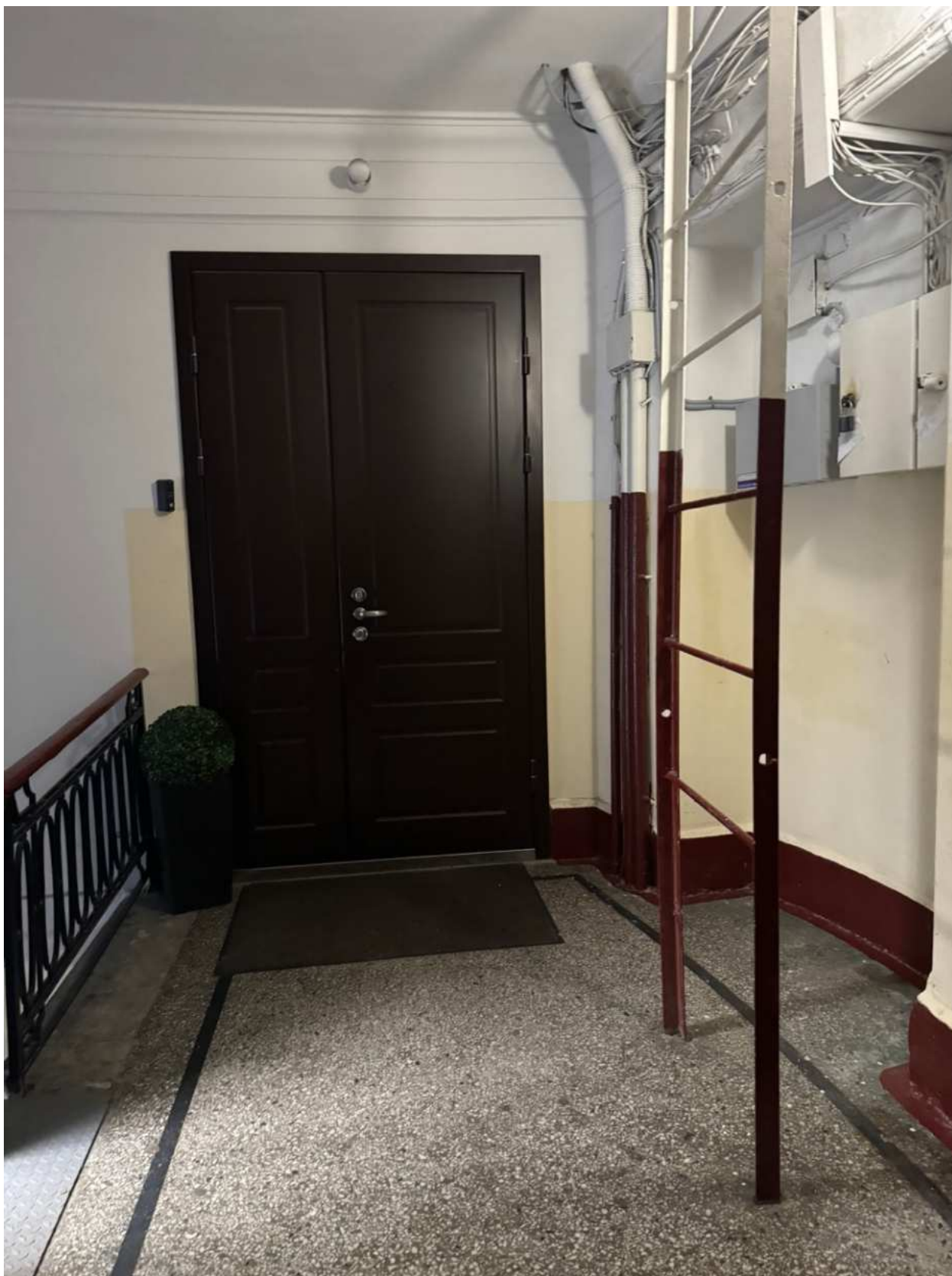
Фото 34. Вид на интерьер лестницы 1ЛК объекта культурного наследия.
