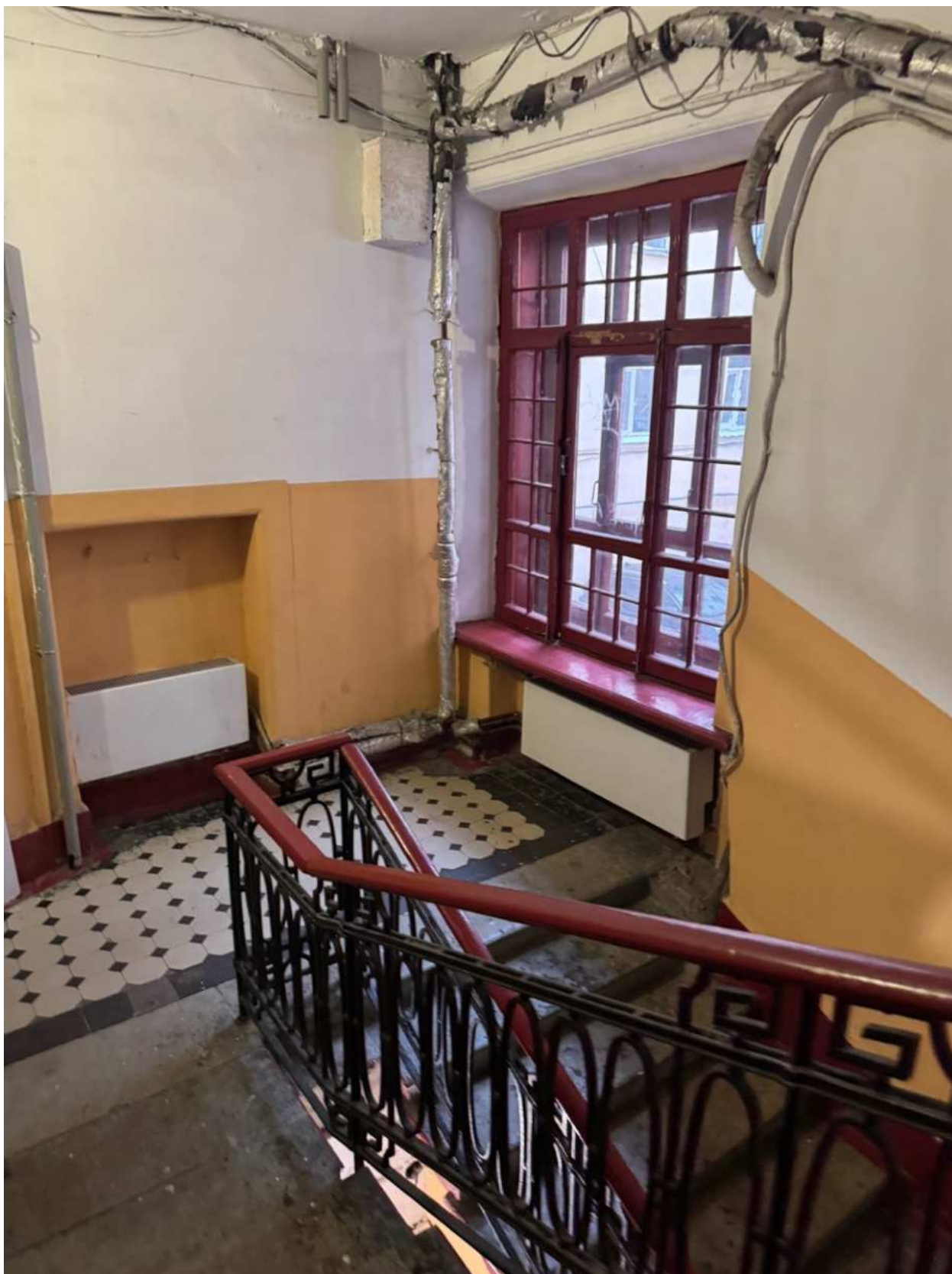
Фото 43. Вид на интерьер лестницы 2ЛК объекта культурного наследия.
