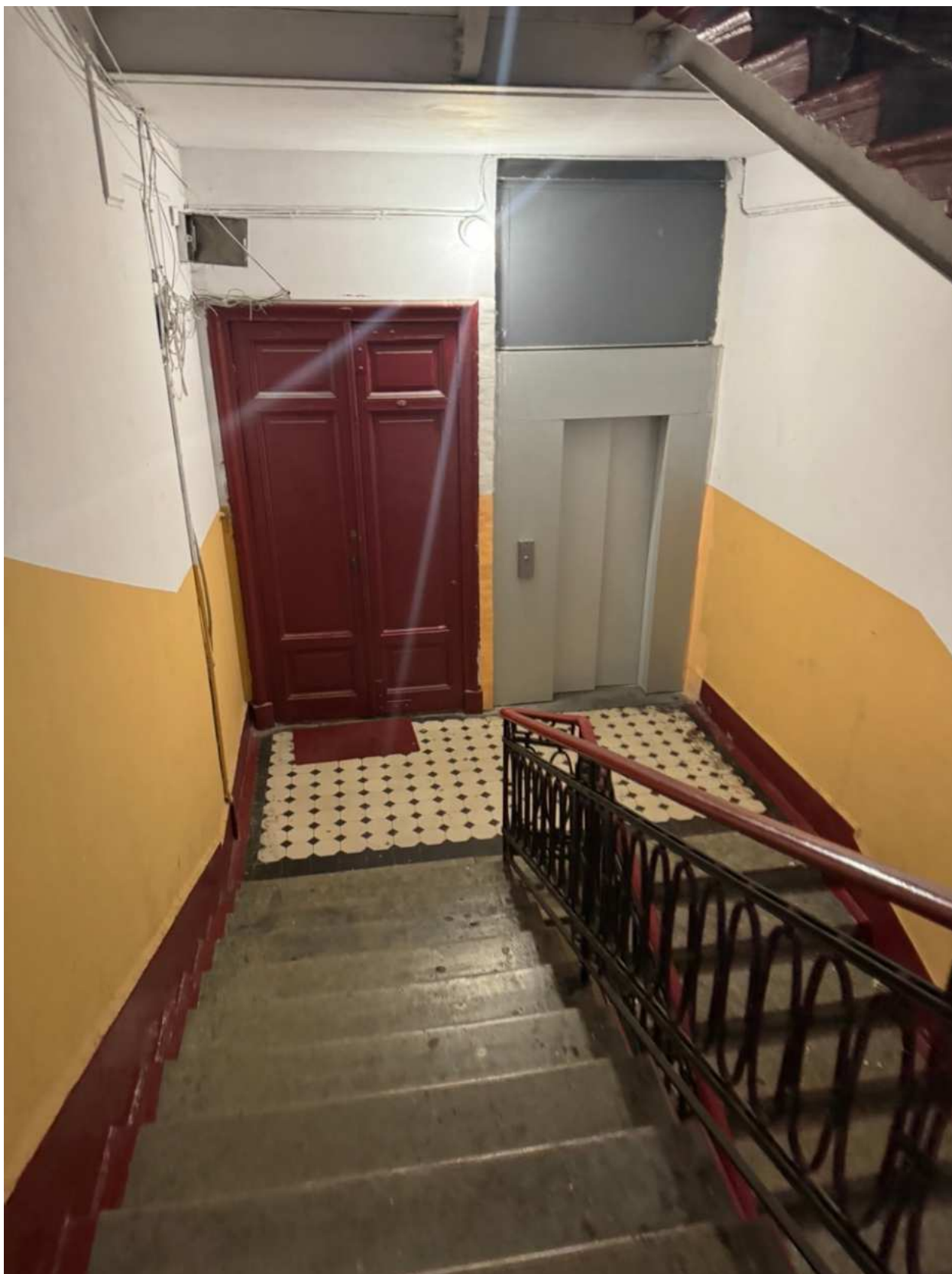
Фото 47. Вид на интерьер лестницы 2ЛК объекта культурного наследия.
