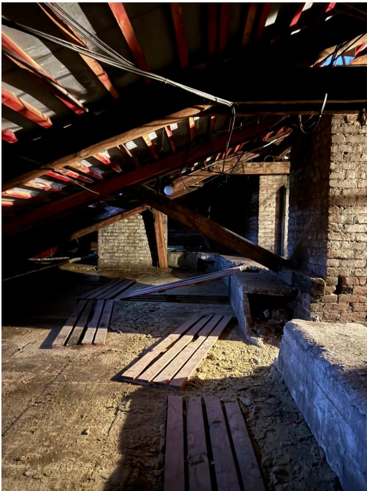
Фото 81. Вид на чердачное помещение объекта культурного наследия.
