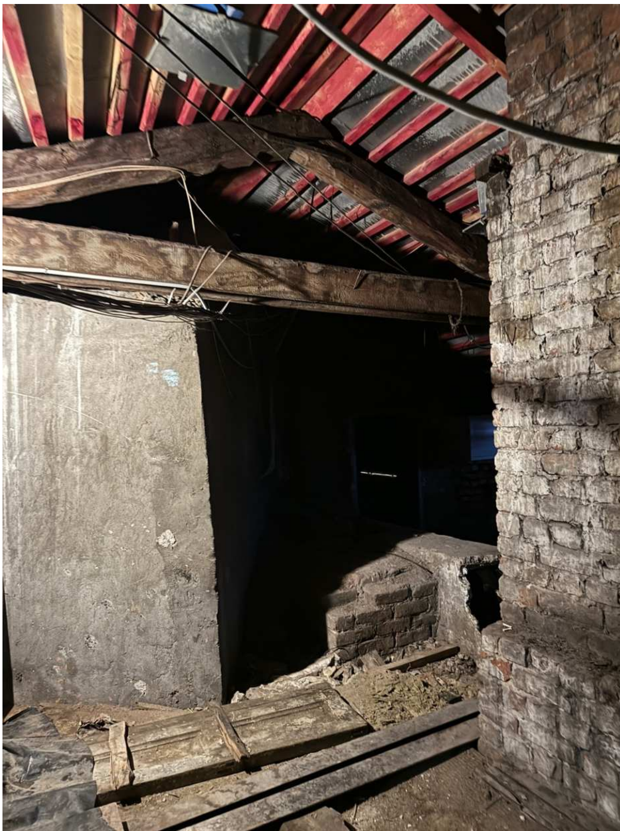
Фото 79. Вид на чердачное помещение объекта культурного наследия.
