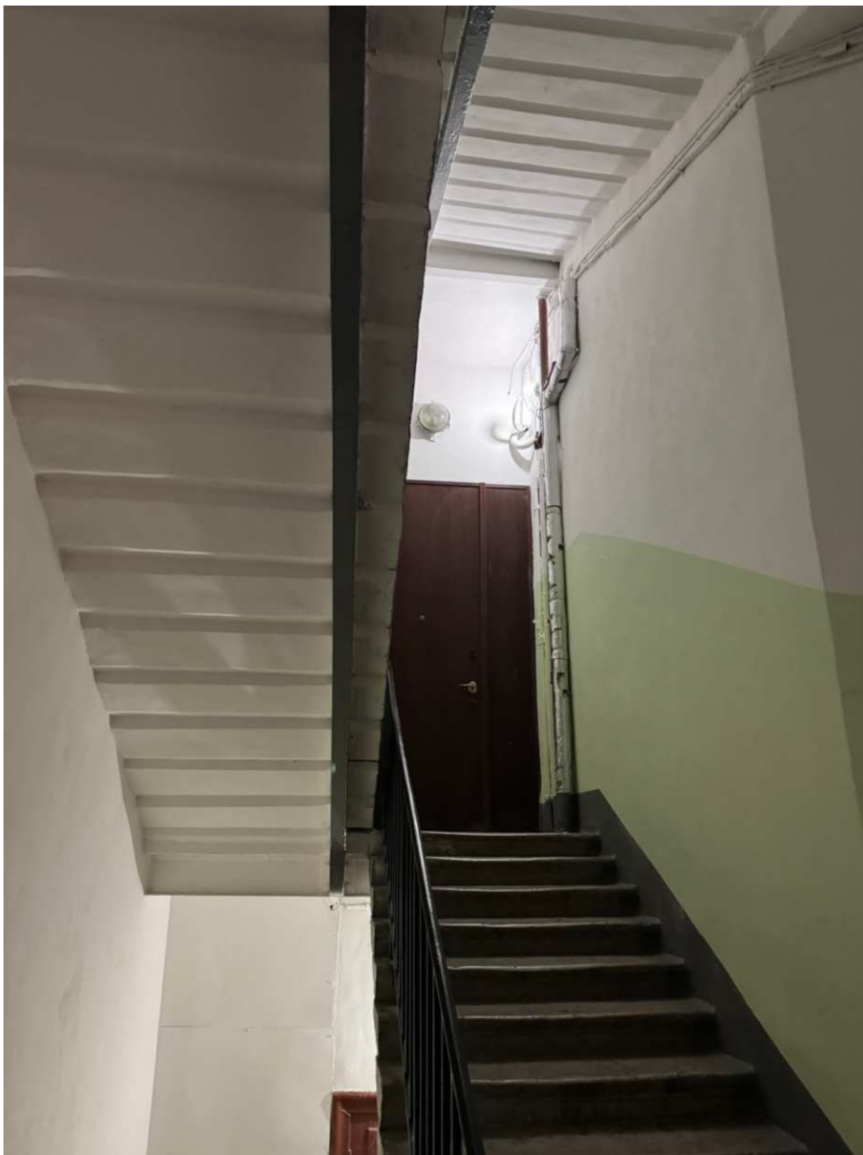
Фото 88. Вид на интерьер лестницы 4ЛК объекта культурного наследия.
