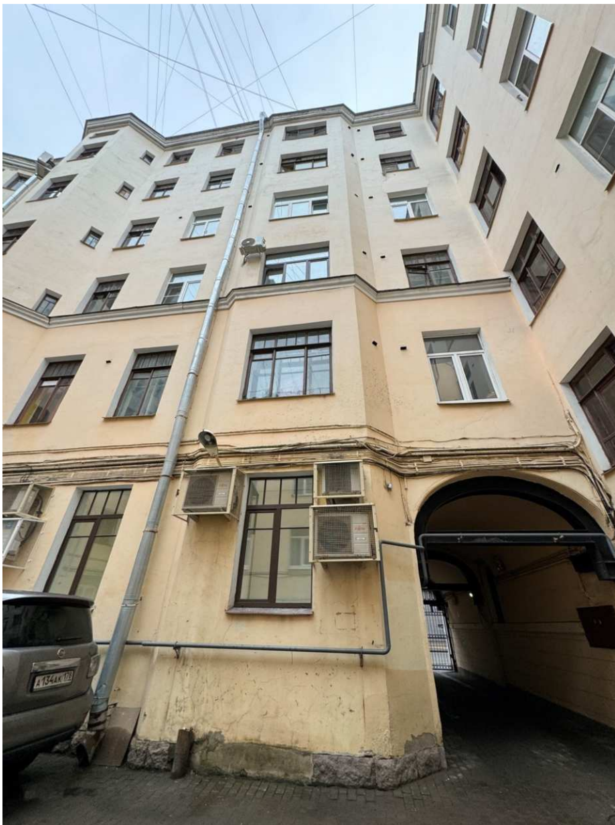
Фото 11. Вид на дворовые фасады объекта культурного наследия.
