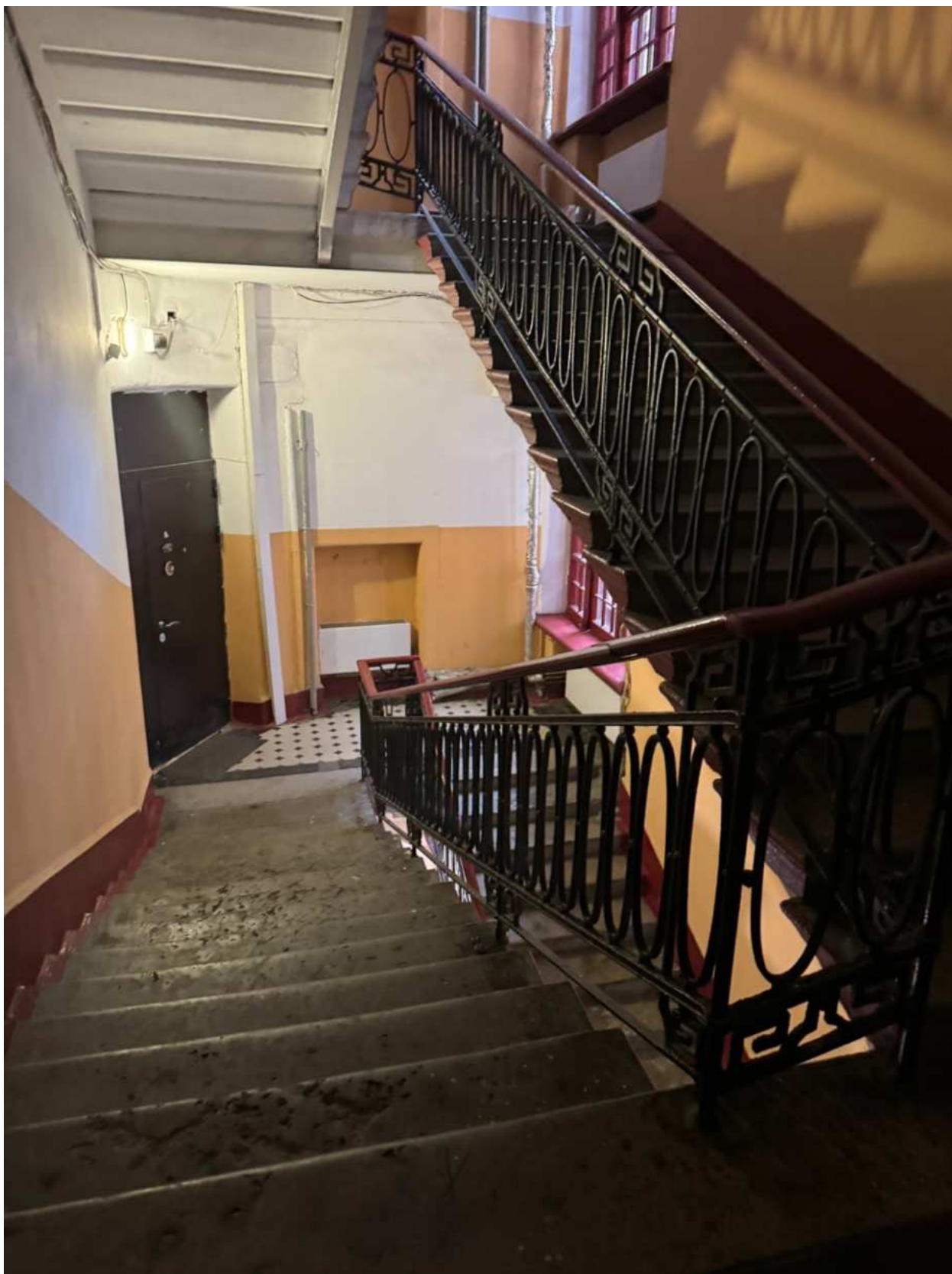
Фото 44. Вид на интерьер лестницы 2ЛК объекта культурного наследия.
