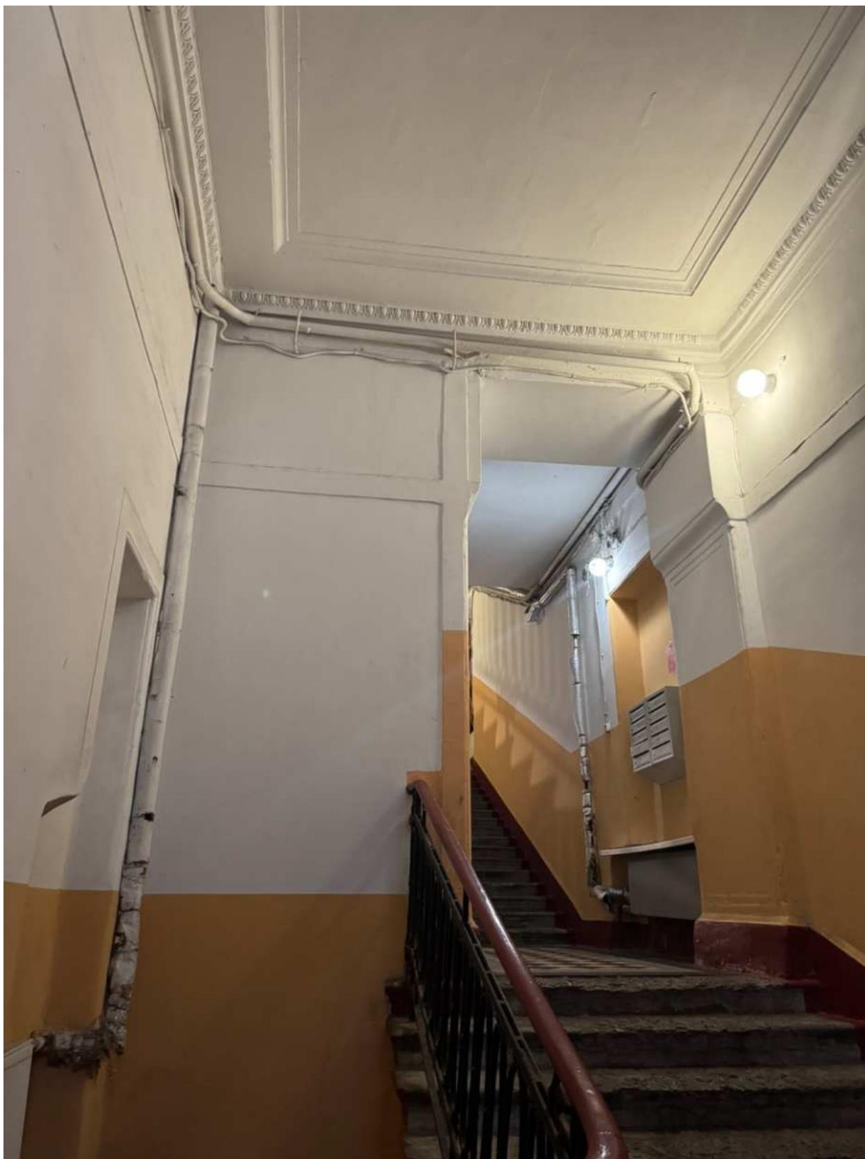
Фото 37. Вид на интерьер лестницы 2ЛК объекта культурного наследия.
