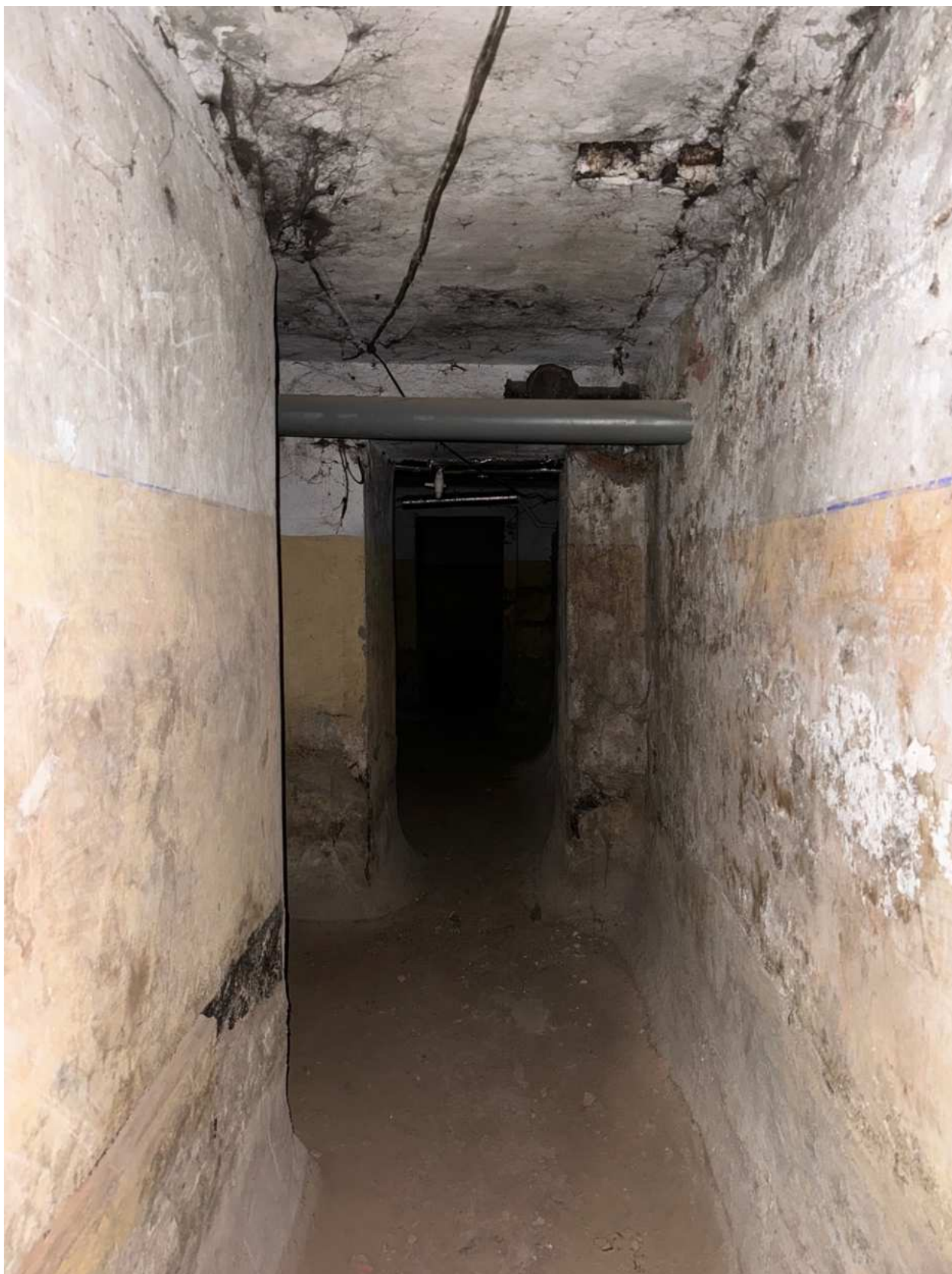
Фото 89. Вид на подвальное помещение объекта культурного наследия.
