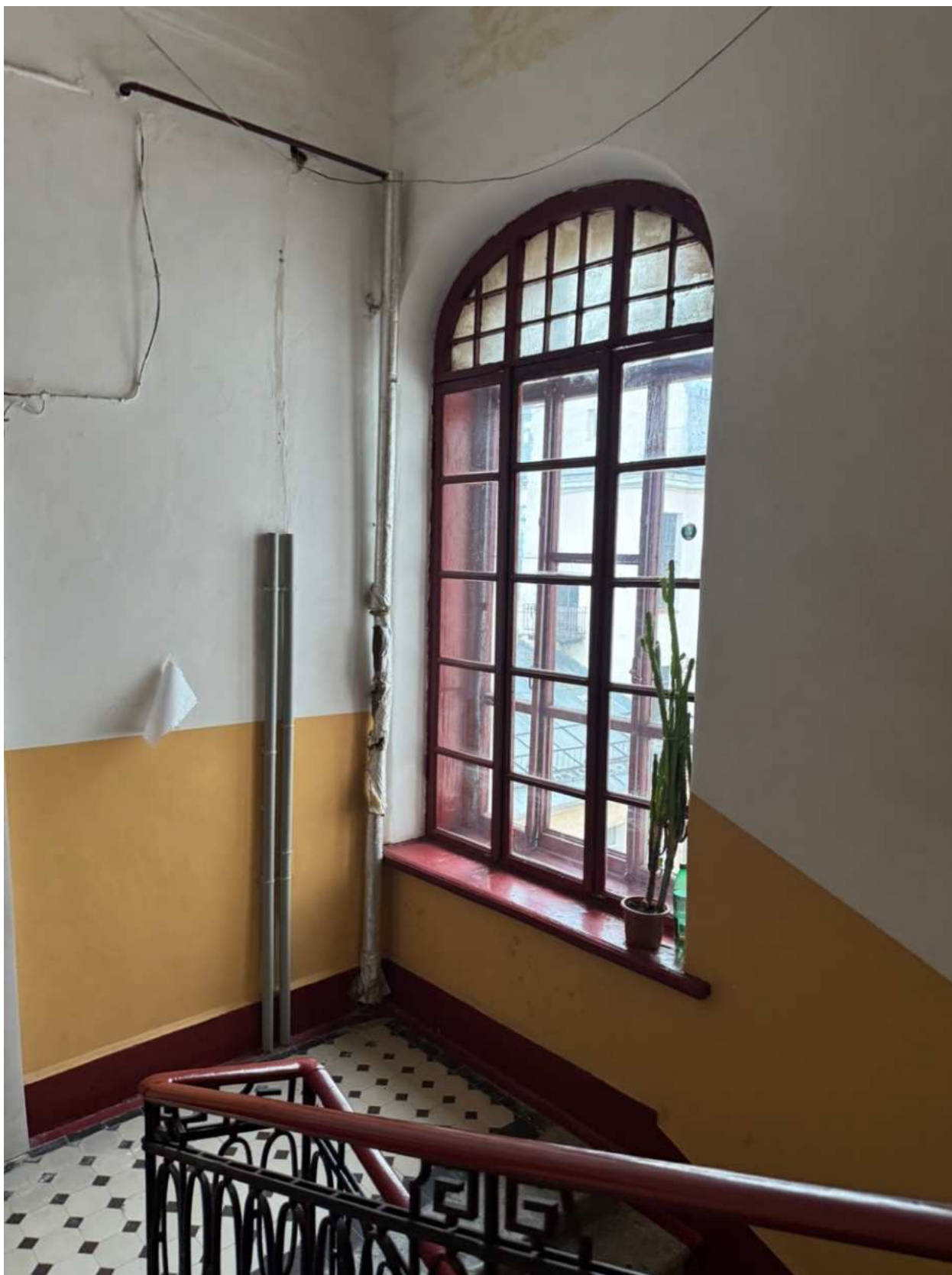
Фото 56. Вид на интерьер лестницы 2ЛК объекта культурного наследия.
