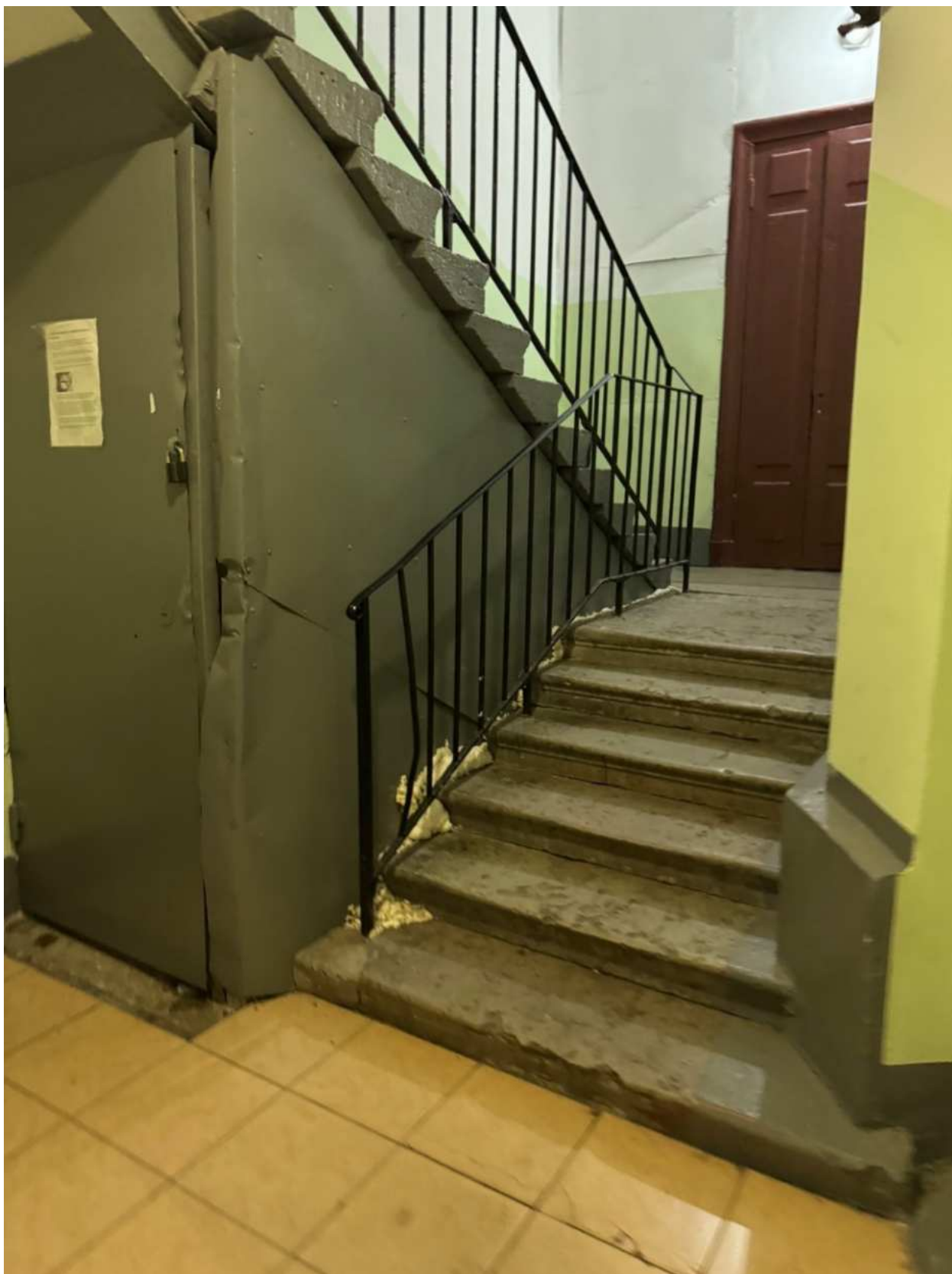
Фото 83. Вид на интерьер лестницы 4ЛК объекта культурного наследия.
