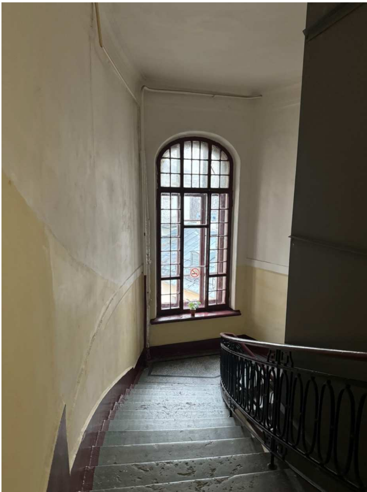
Фото 35. Вид на интерьер лестницы 1ЛК объекта культурного наследия.
