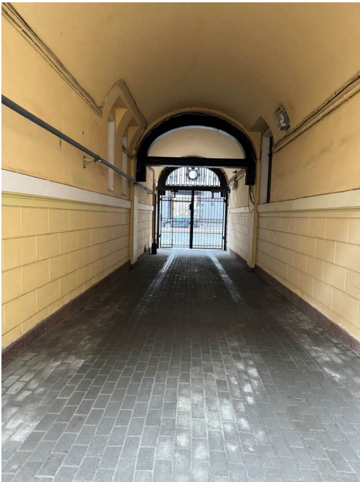
Фото 8. Вид на арку проезда объекта культурного наследия.
