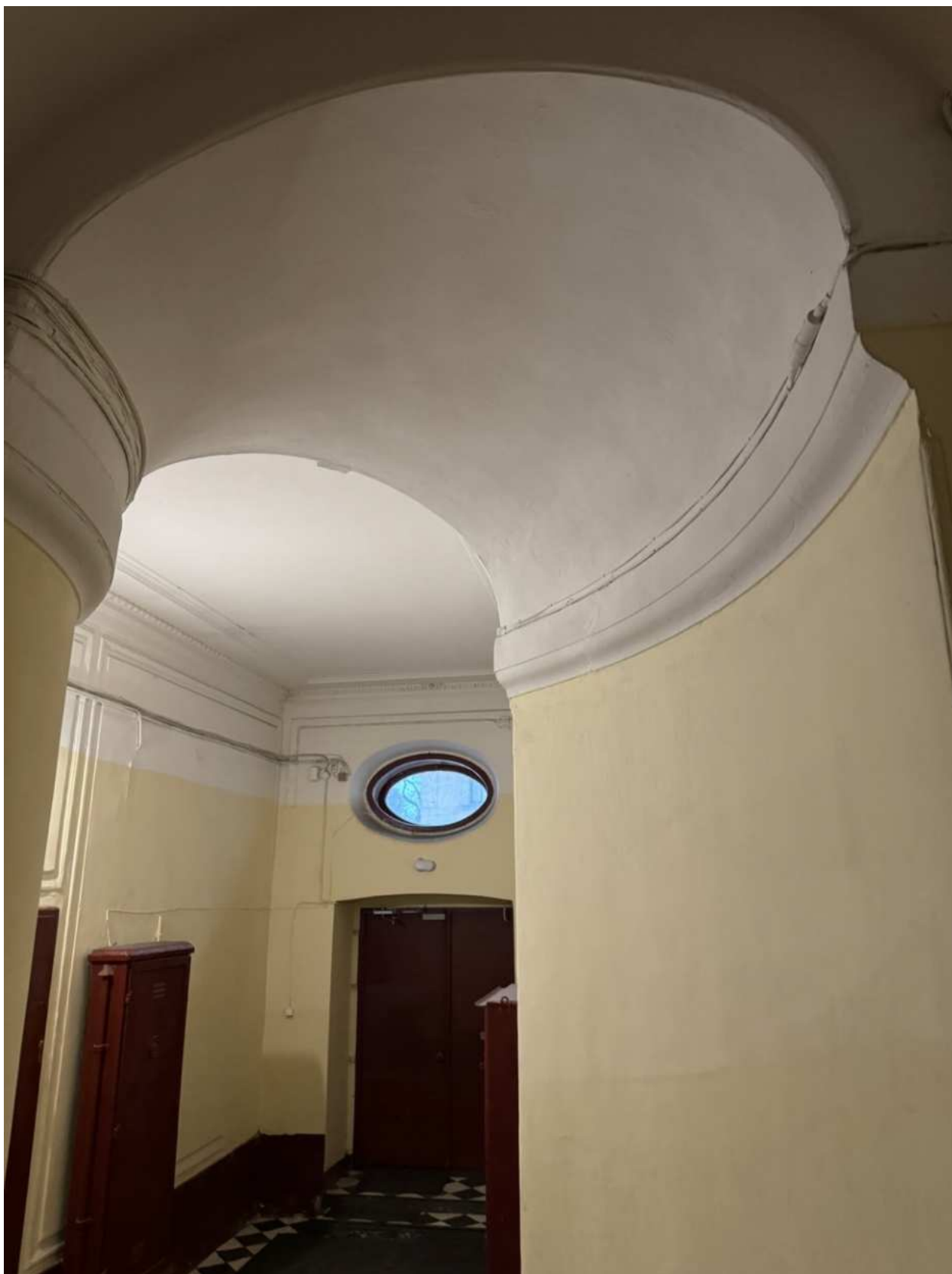
Фото 17. Вид на интерьер лестницы 1ЛК объекта культурного наследия.
