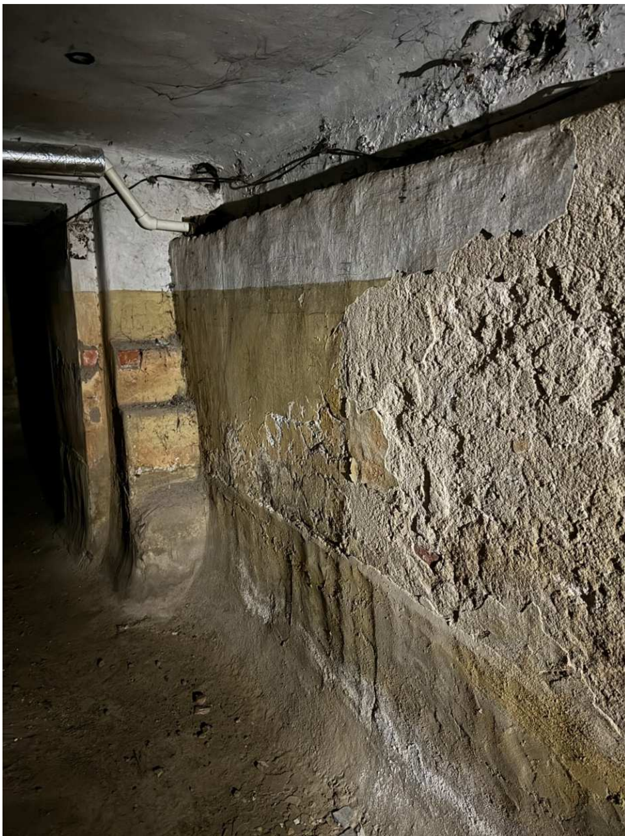
Фото 92. Вид на подвальное помещение объекта культурного наследия.
