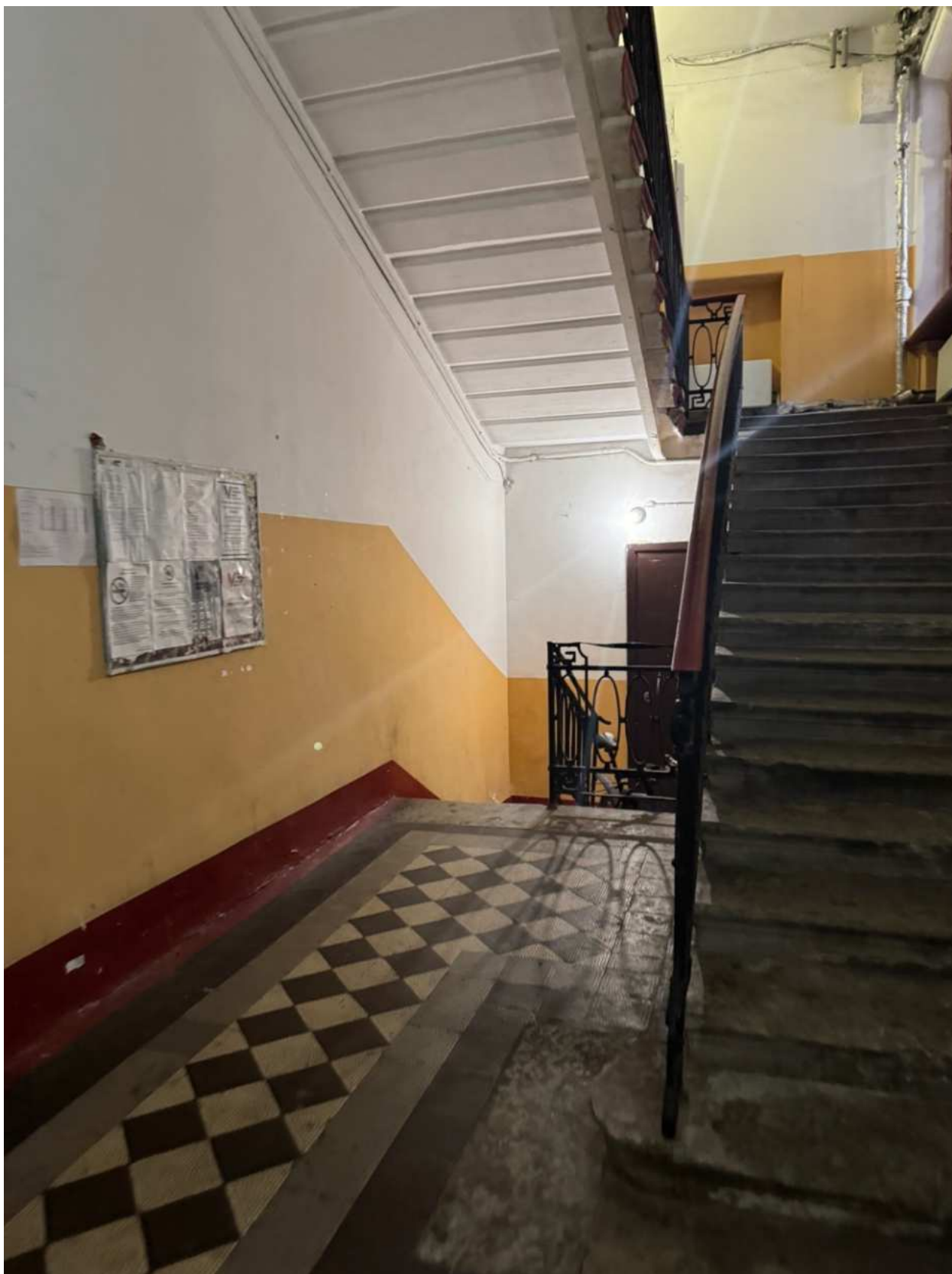
Фото 40. Вид на интерьер лестницы 2ЛК объекта культурного наследия.
