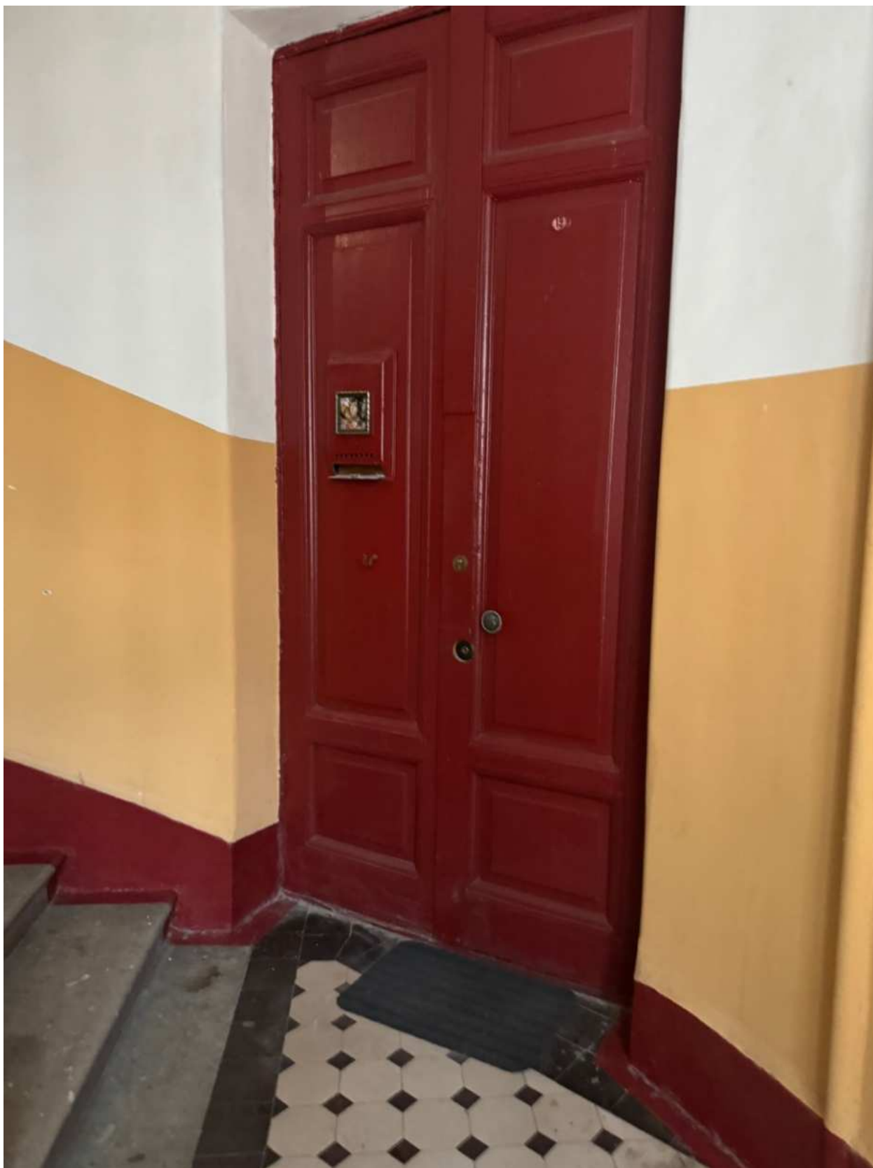
Фото 51. Вид на интерьер лестницы 2ЛК объекта культурного наследия.
