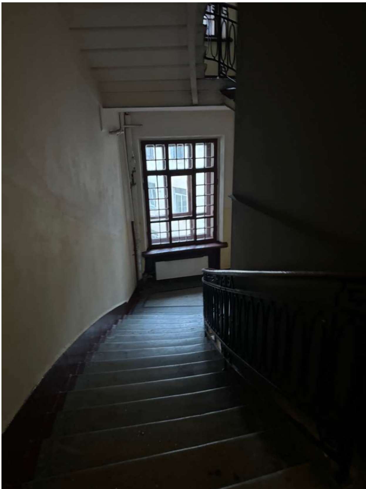
Фото 25. Вид на интерьер лестницы 1ЛК объекта культурного наследия.
