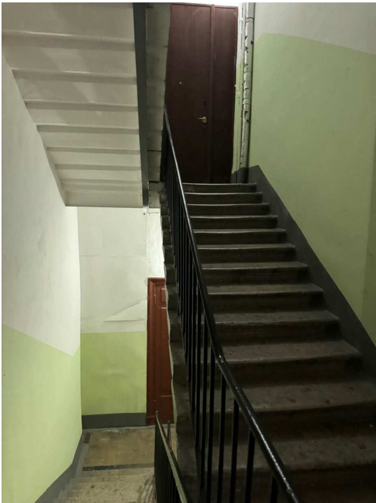
Фото 87. Вид на интерьер лестницы 4ЛК объекта культурного наследия.
