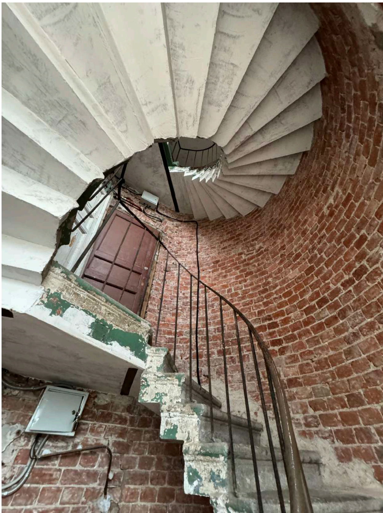
Фото 40. Интерьер черной лестницы объекта культурного наследия в уровне 2-го этажа.
