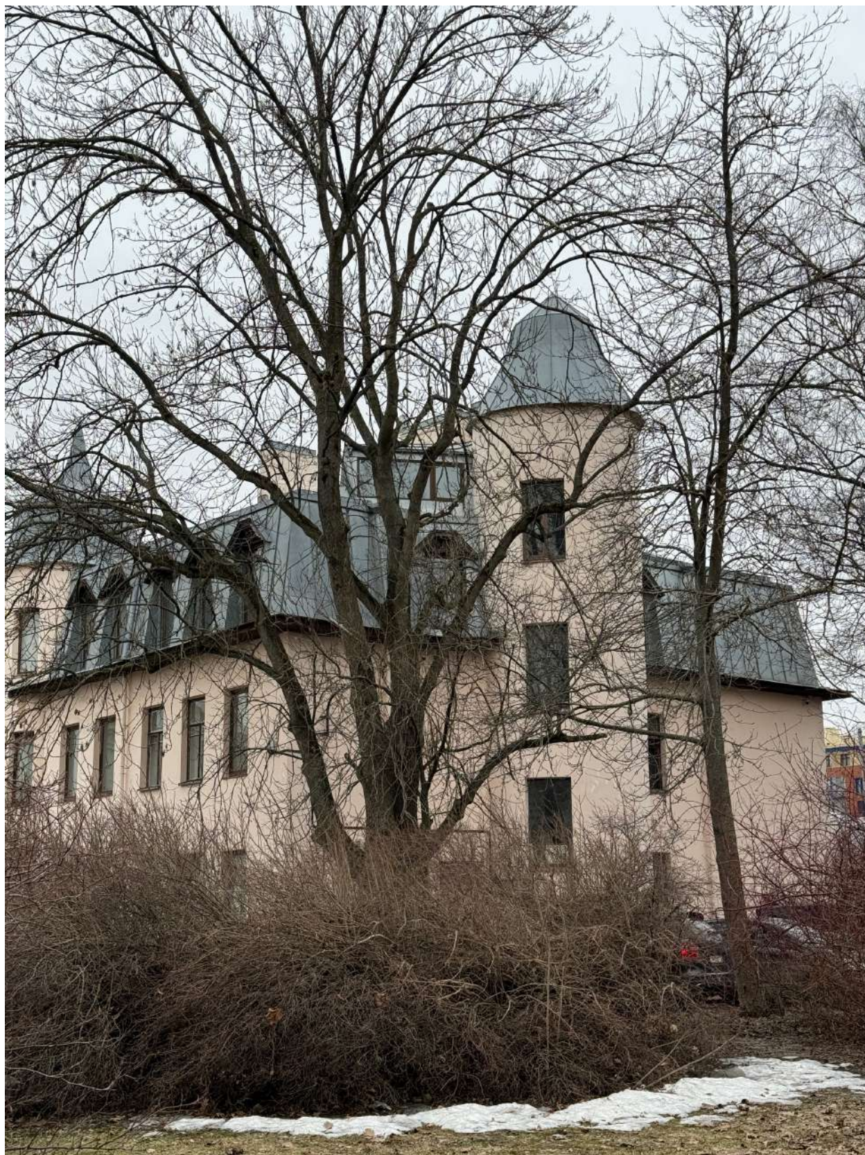
Фото 10. Общий вид северного дворового фасада объекта культурного наследия.
