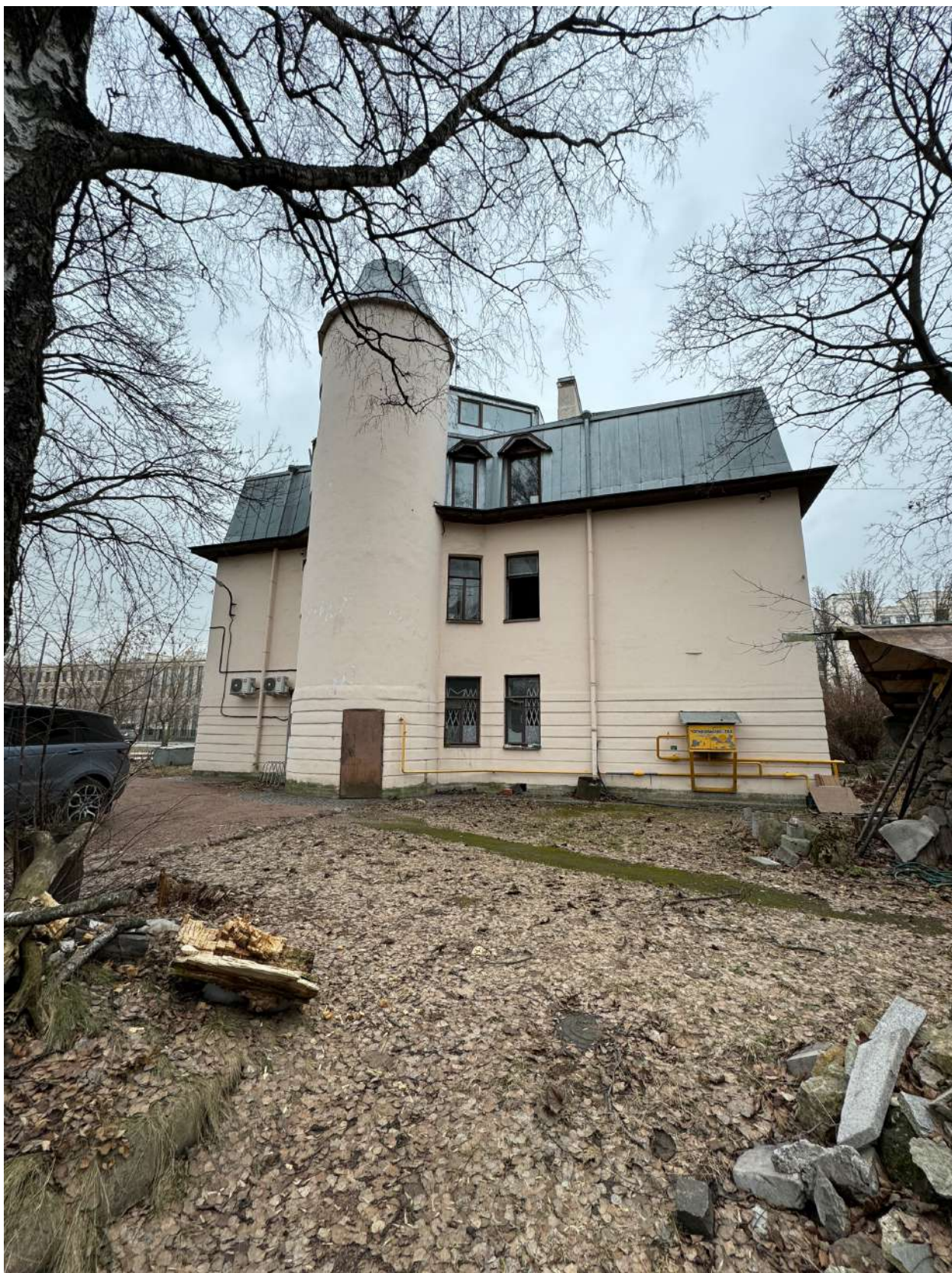
Фото 11. Общий вид северного дворового фасада объекта культурного наследия.
