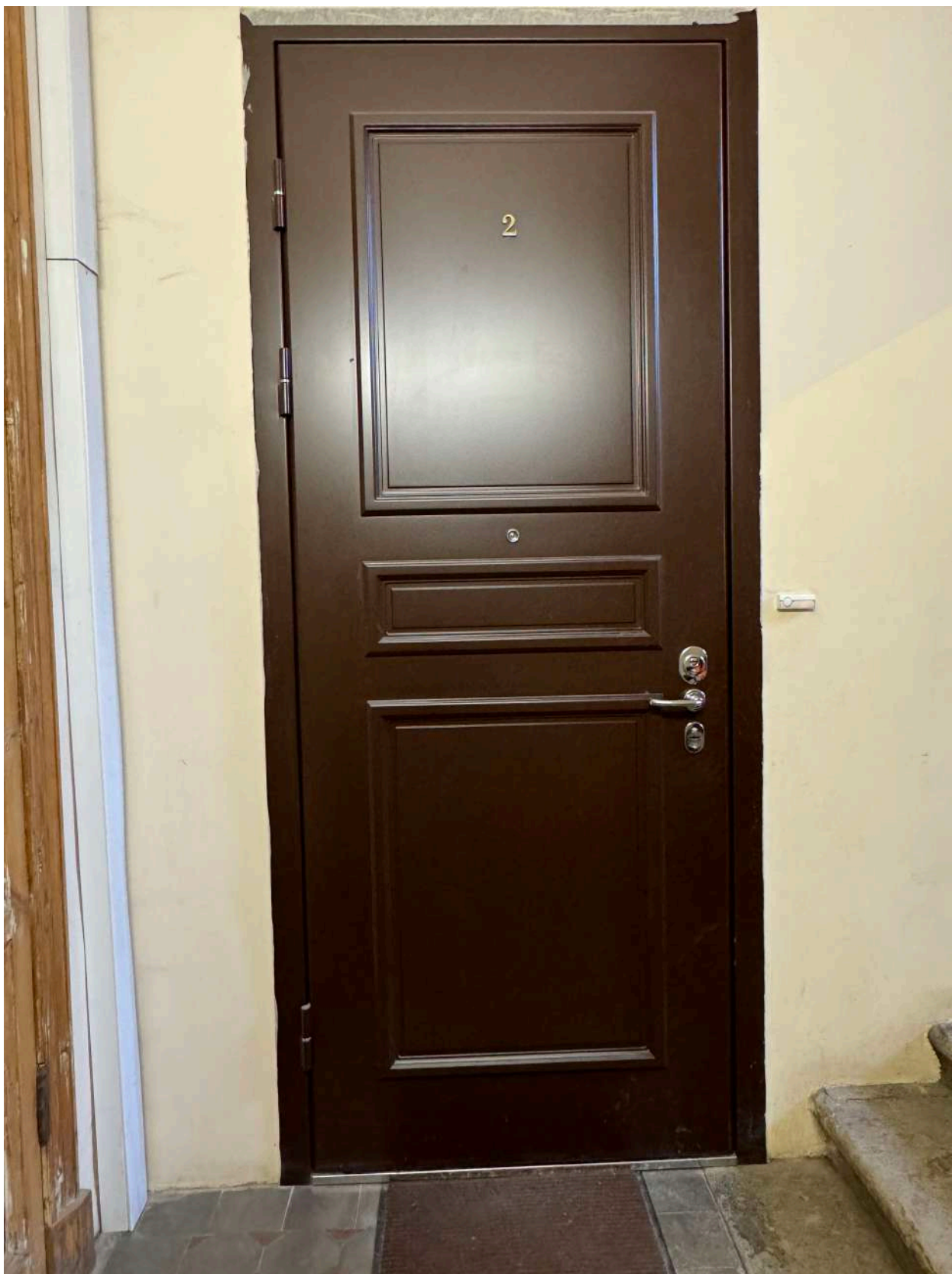
Фото 20. Дверное заполнение квартиры с парадной лестницы объекта культурного наследия в уровне 1-го этажа.
