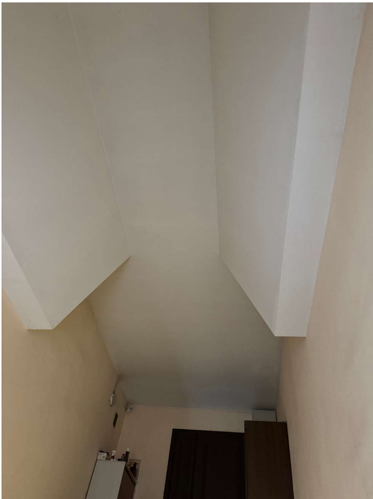
Фото 32. Верхнее перекрытие парадной лестницы объекта культурного наследия.
