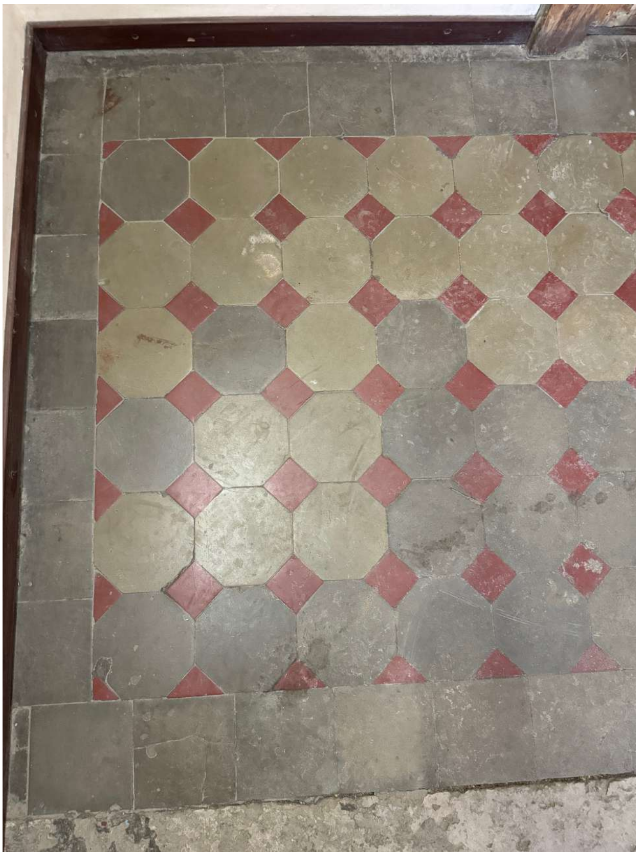
Фото 16. Покрытие метлахской плиткой парадной лестницы объекта культурного наследия в уровне 1-го этажа.
