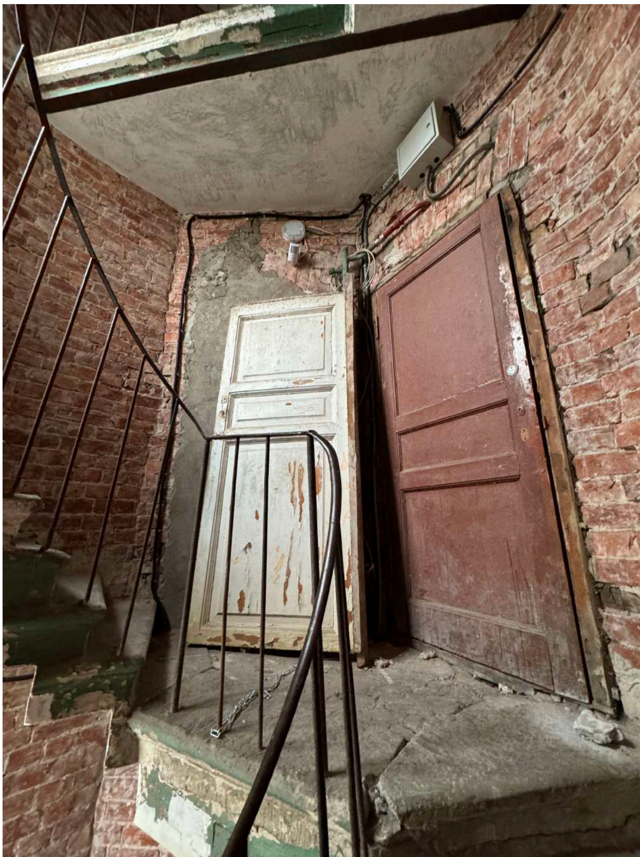
Фото 41. Интерьер черной лестницы объекта культурного наследия в уровне 2-го этажа.
