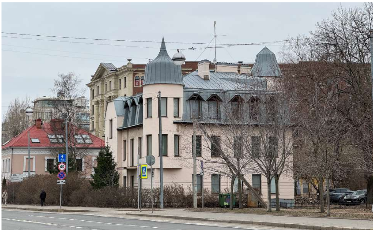
Фото 7. Общий вид лицевых фасадов объекта культурного наследия с перекрестка Морского проспекта и Еленинской улицы.
