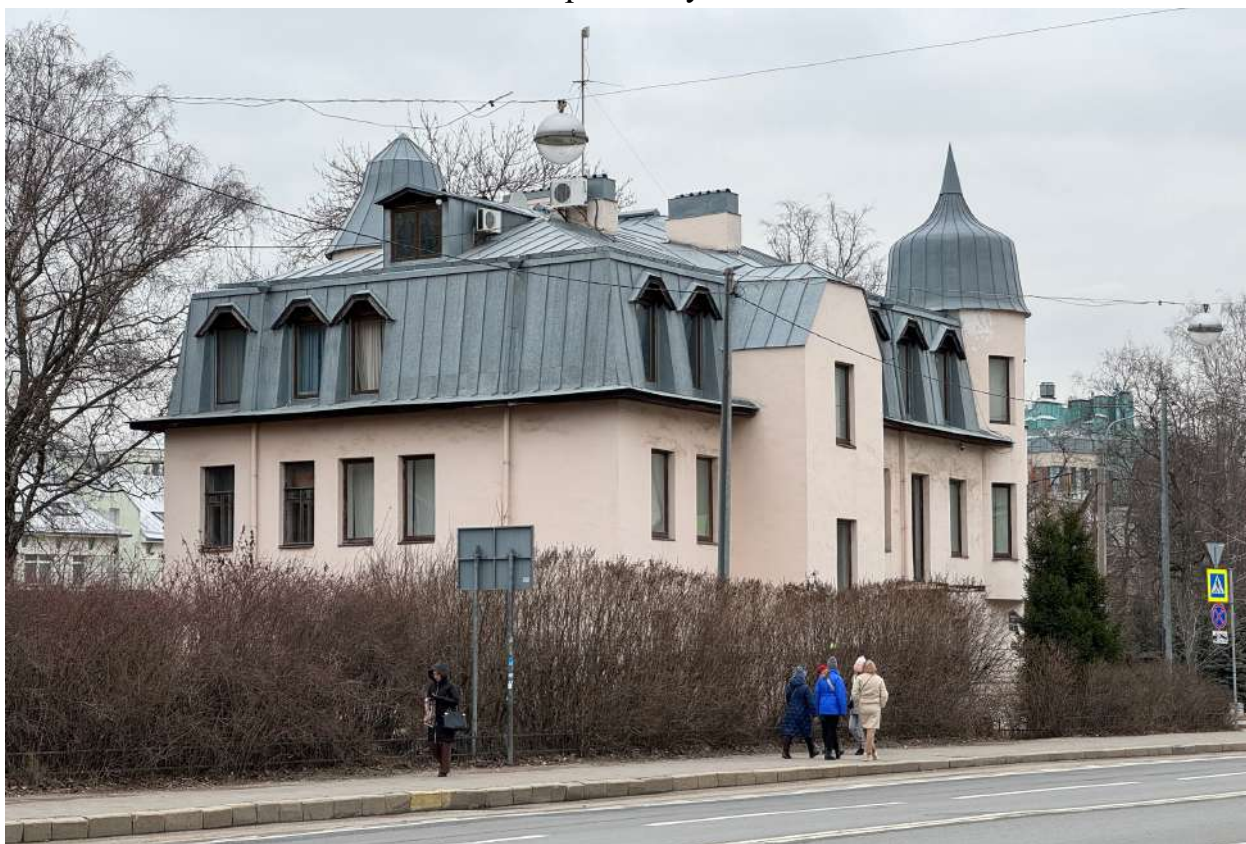
Фото 2. Общий вид с юго-запада на объект культурного наследия по Морскому проспекту.
