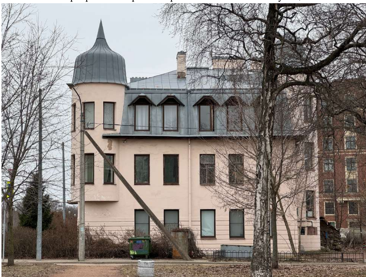
Фото 8. Общий вид восточного лицевого фасада объекта культурного наследия с Еленинской улицы.
