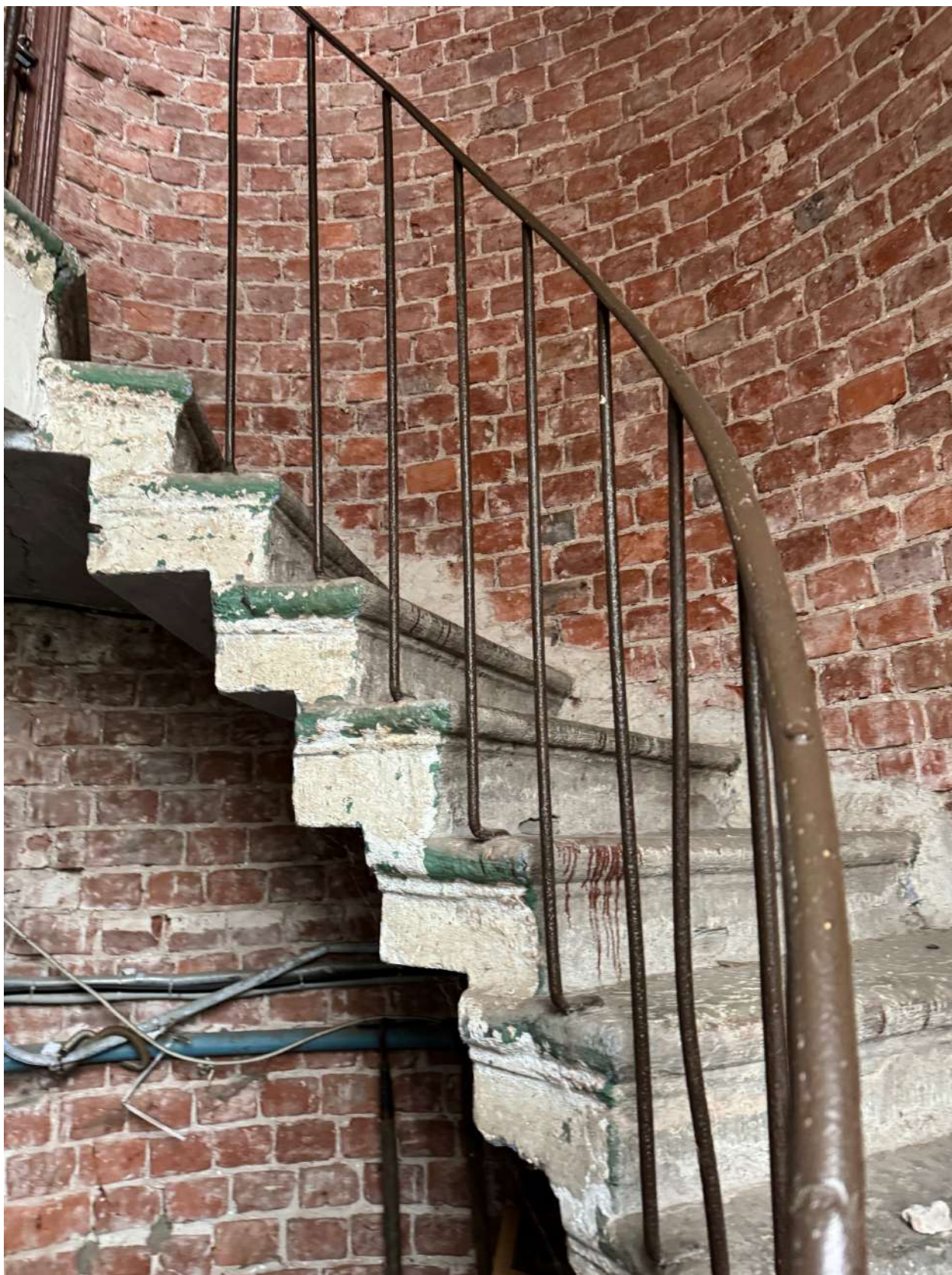
Фото 35. Интерьер черной лестницы объекта культурного наследия в уровне 1-го этажа.
