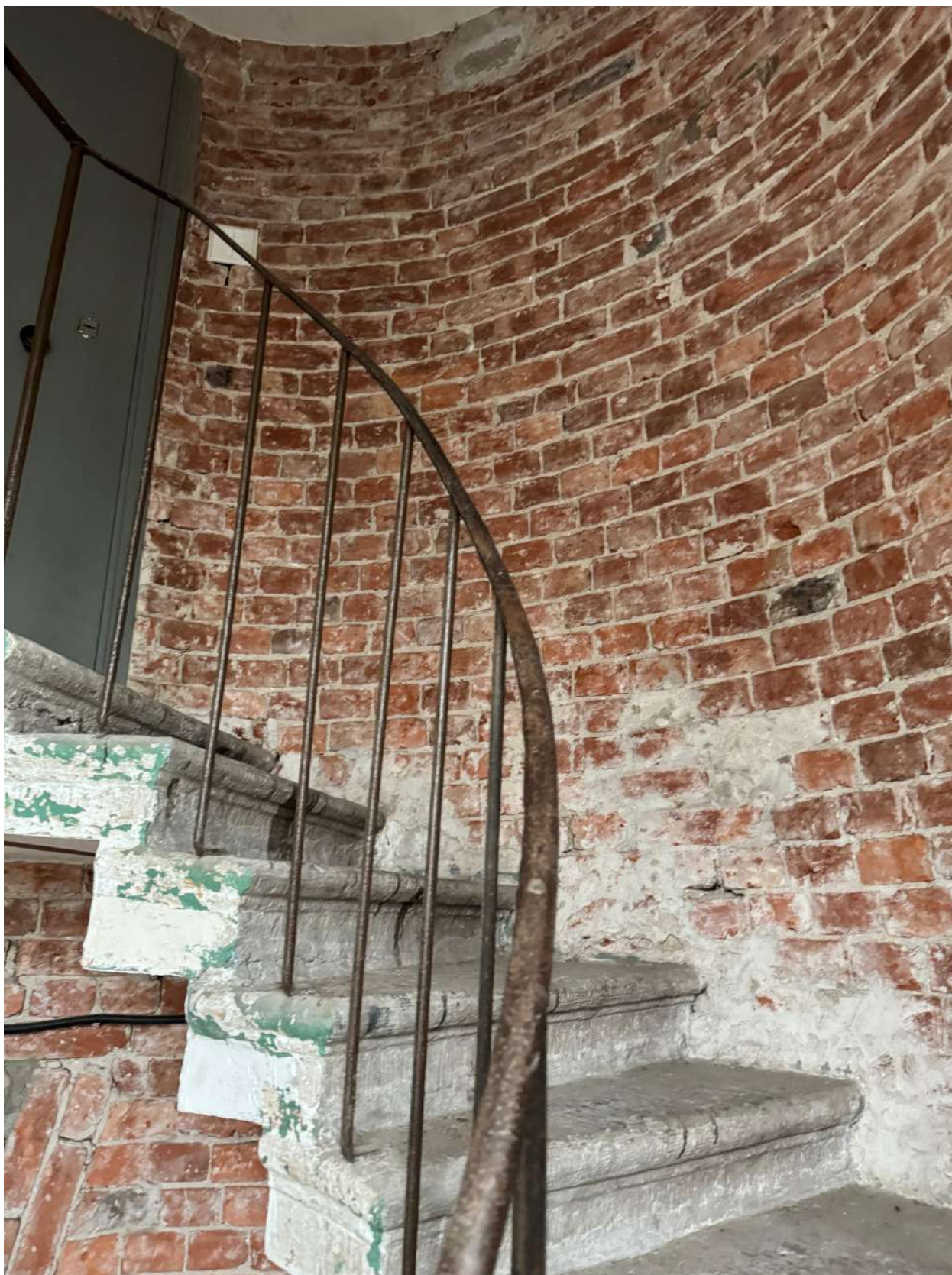
Фото 43. Интерьер черной лестницы объекта культурного наследия в уровне 2-го этажа.
