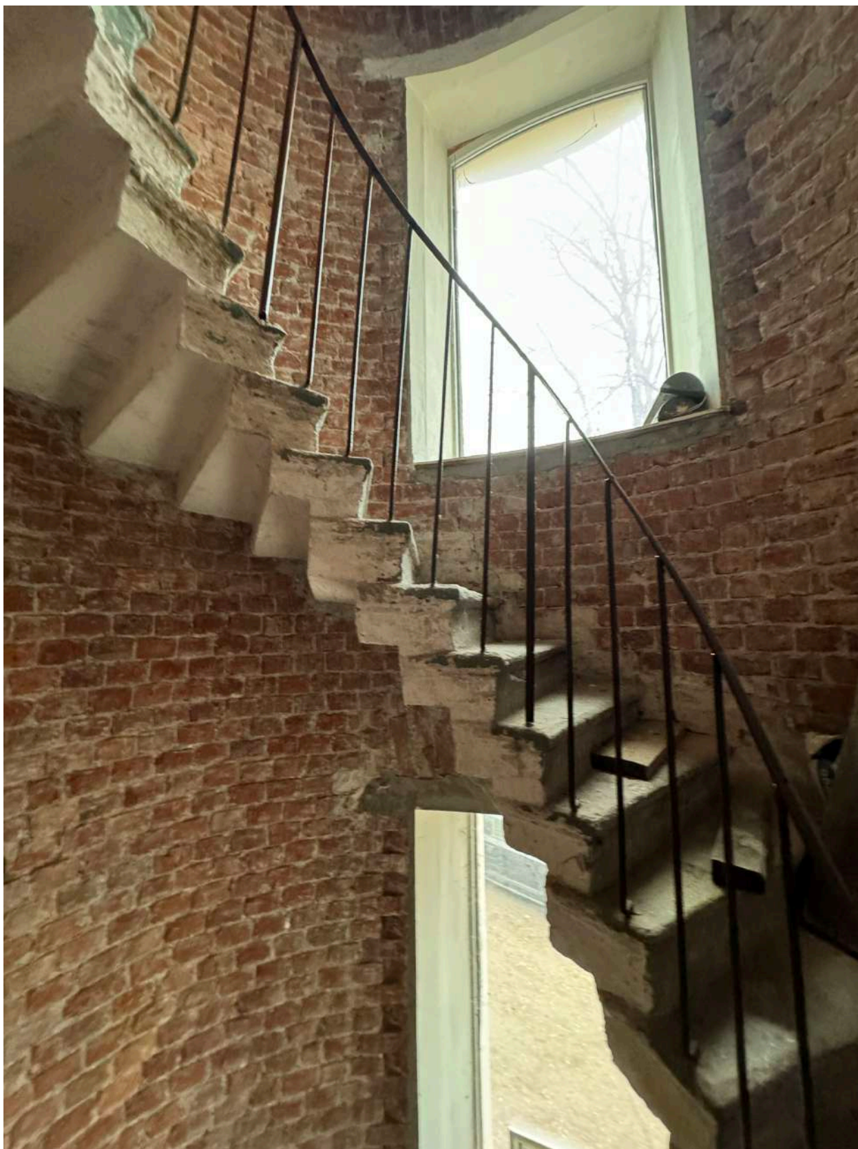
Фото 38. Интерьер черной лестницы объекта культурного наследия в уровне 1-го этажа.
