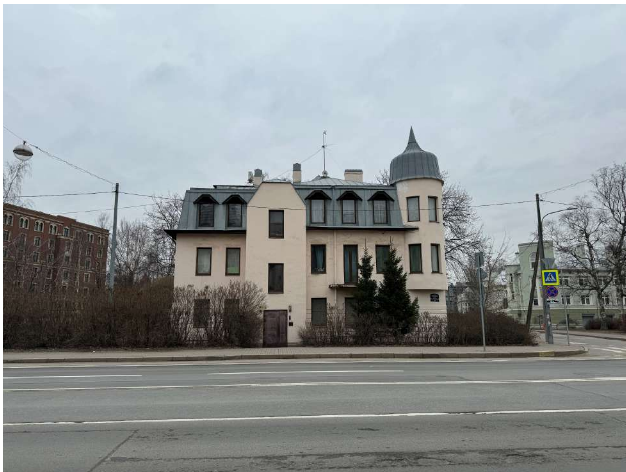
Фото 3. Общий вид с юга на лицевой фасад объекта культурного наследия по Морскому проспекту.
