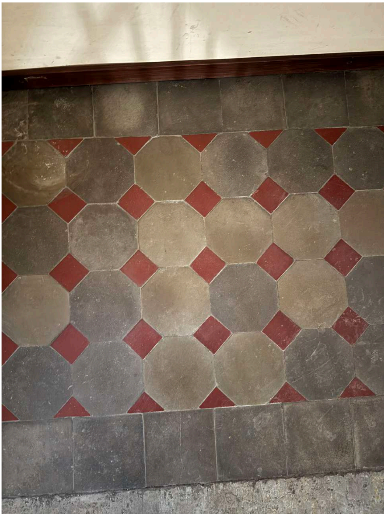
Фото 29. Покрытие метлахской плиткой парадной лестницы объекта культурного наследия в уровне 2-го этажа.
