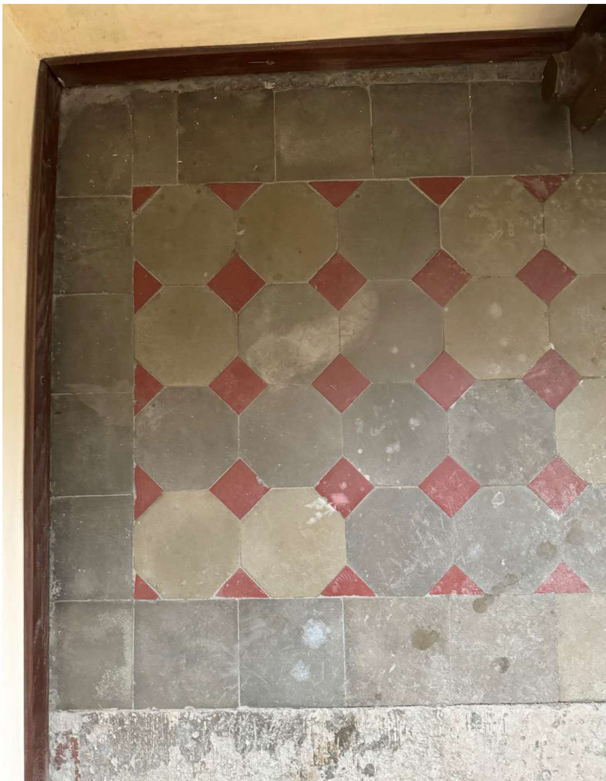
Фото 22. Покрытие метлахской плиткой парадной лестницы объекта культурного наследия в уровне 1-го этажа.
