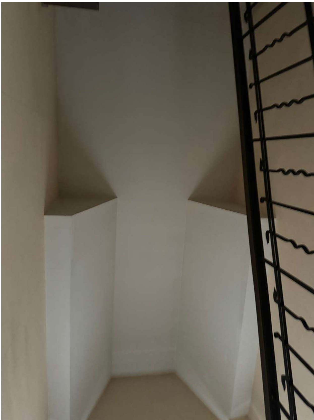
Фото 28. Верхнее перекрытие парадной лестницы объекта культурного наследия.
