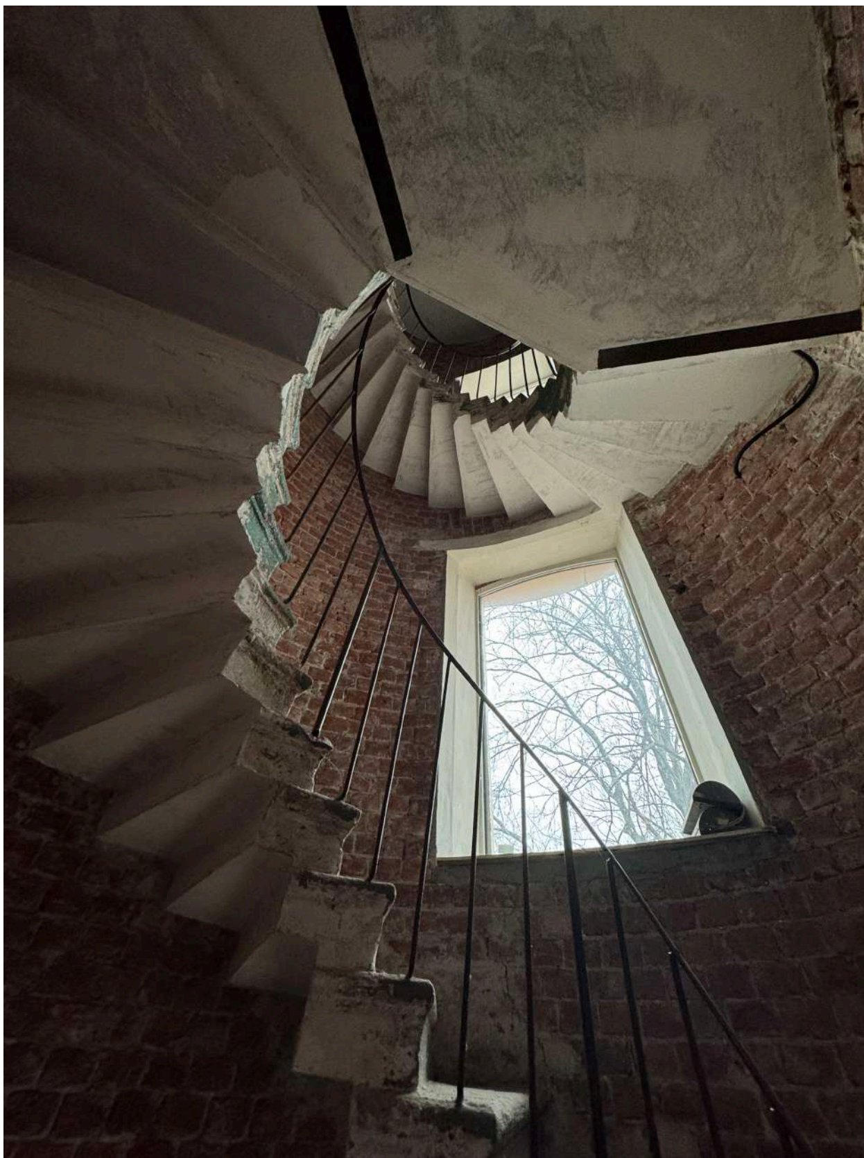
Фото 39. Интерьер черной лестницы объекта культурного наследия в уровне 1-го этажа.
