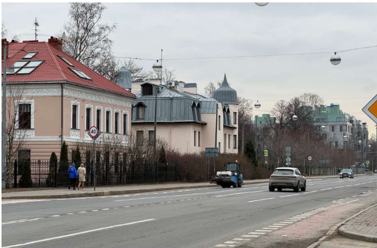
Фото 1. Общий вид с юго-запада на объект культурного наследия по Морскому проспекту.
