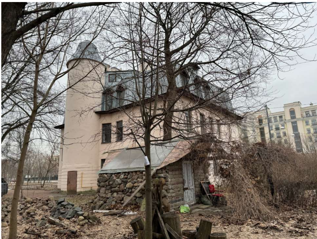
Фото 12. Общий вид дворовых фасадов объекта культурного наследия с северо-запада.
