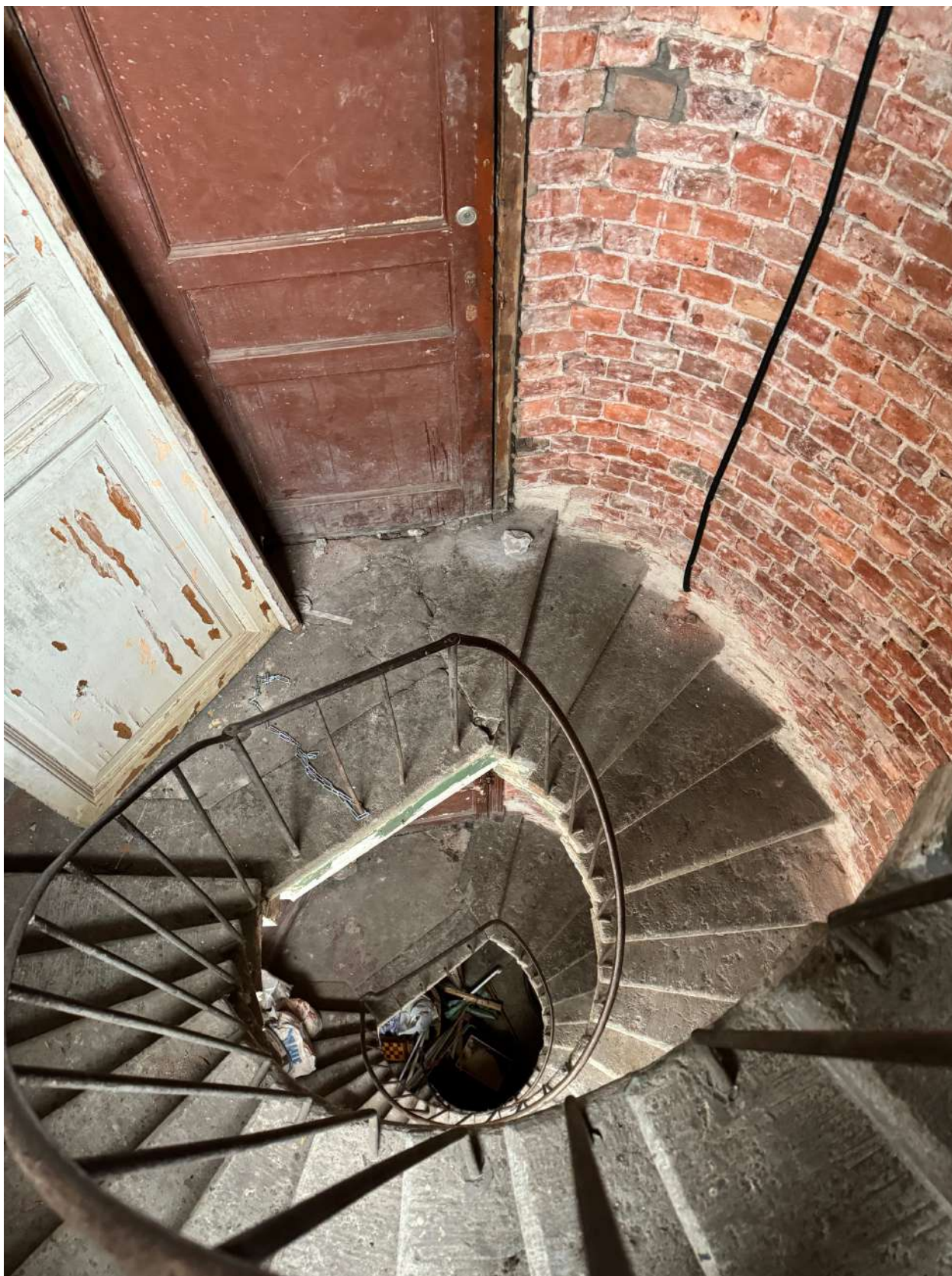
Фото 44. Интерьер черной лестницы объекта культурного наследия в уровне 2-го этажа.
