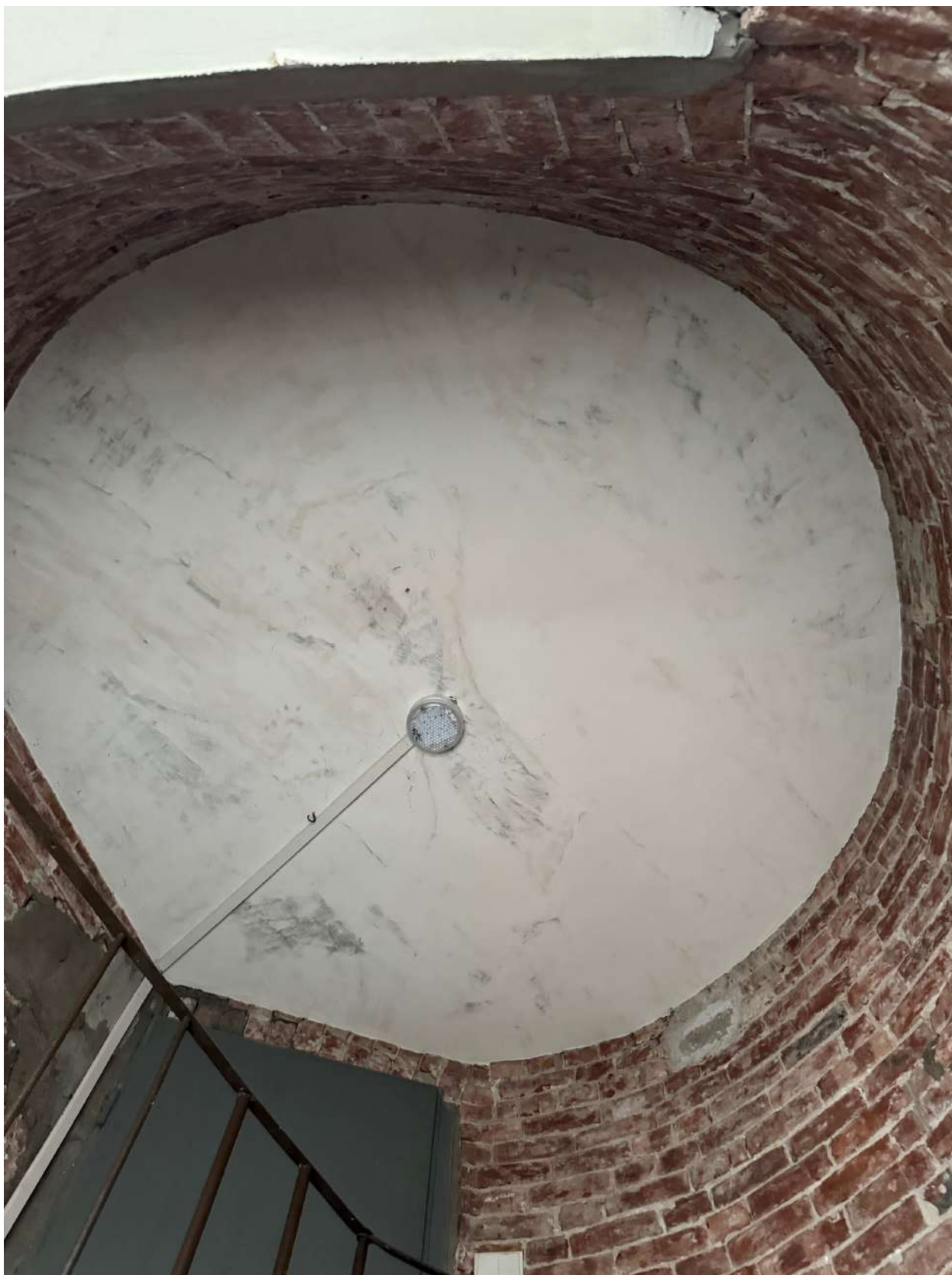
Фото 42. Вид на верхнее перекрытие черной лестницы объекта культурного наследия в уровне 2-го этажа.
