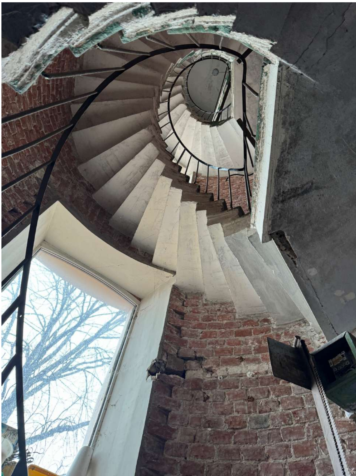
Фото 33. Интерьер черной лестницы объекта культурного наследия в уровне 1-го этажа.
