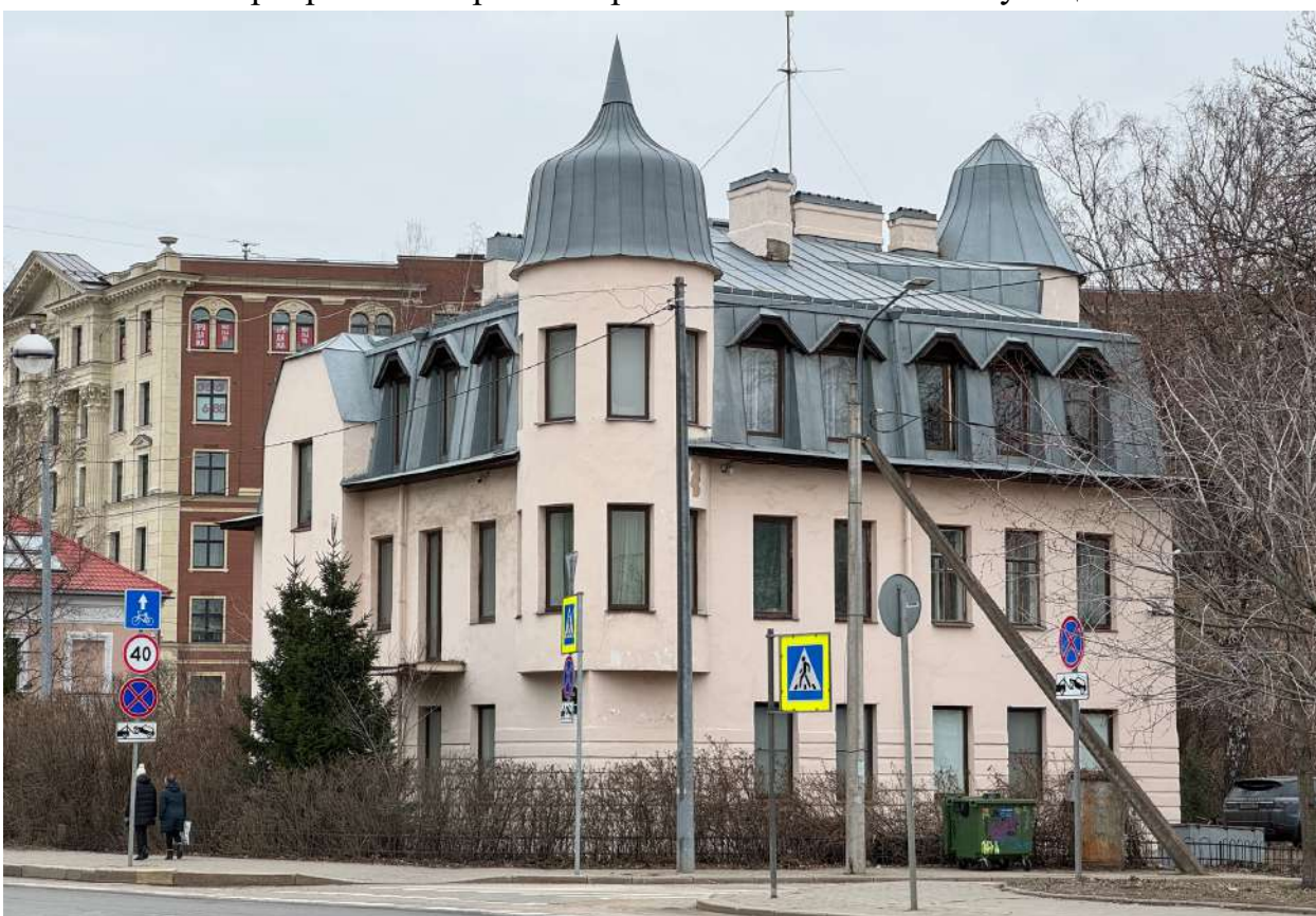
Фото 6. Общий вид лицевых фасадов объекта культурного наследия с перекрестка Морского проспекта и Еленинской улицы.
