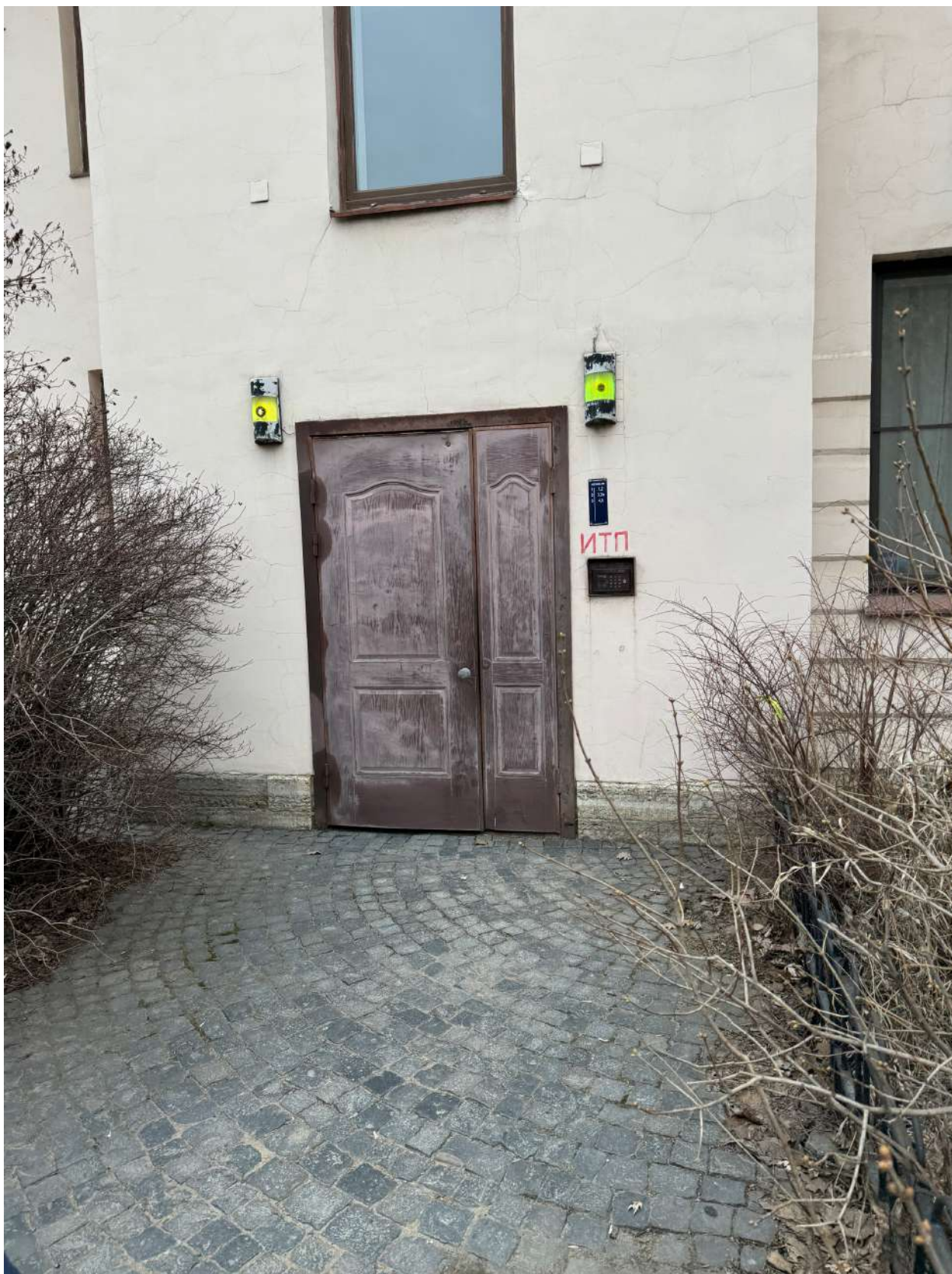
Фото 14. Вход в парадную объекта культурного наследия с лицевого фасада по Морскому проспекту.
