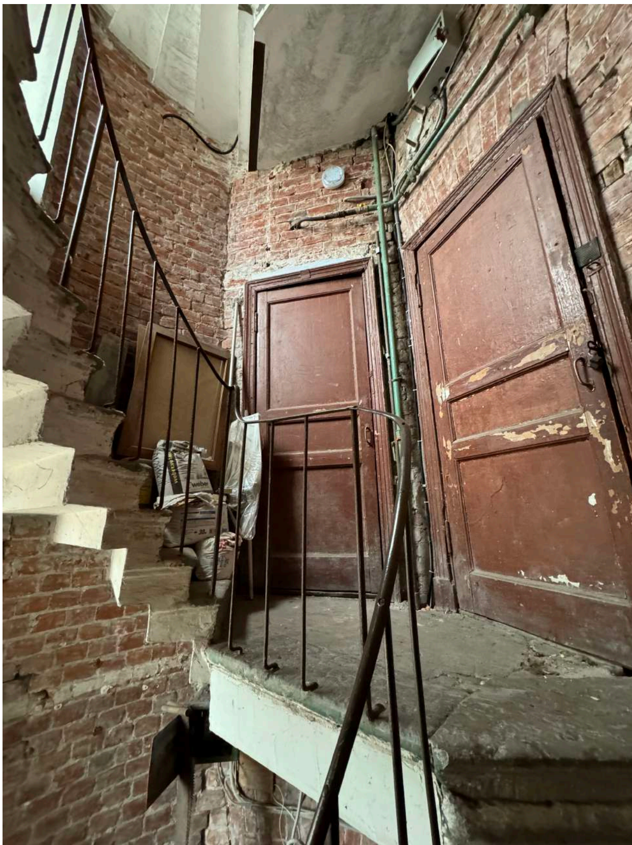
Фото 37. Интерьер черной лестницы объекта культурного наследия в уровне 1-го этажа.
