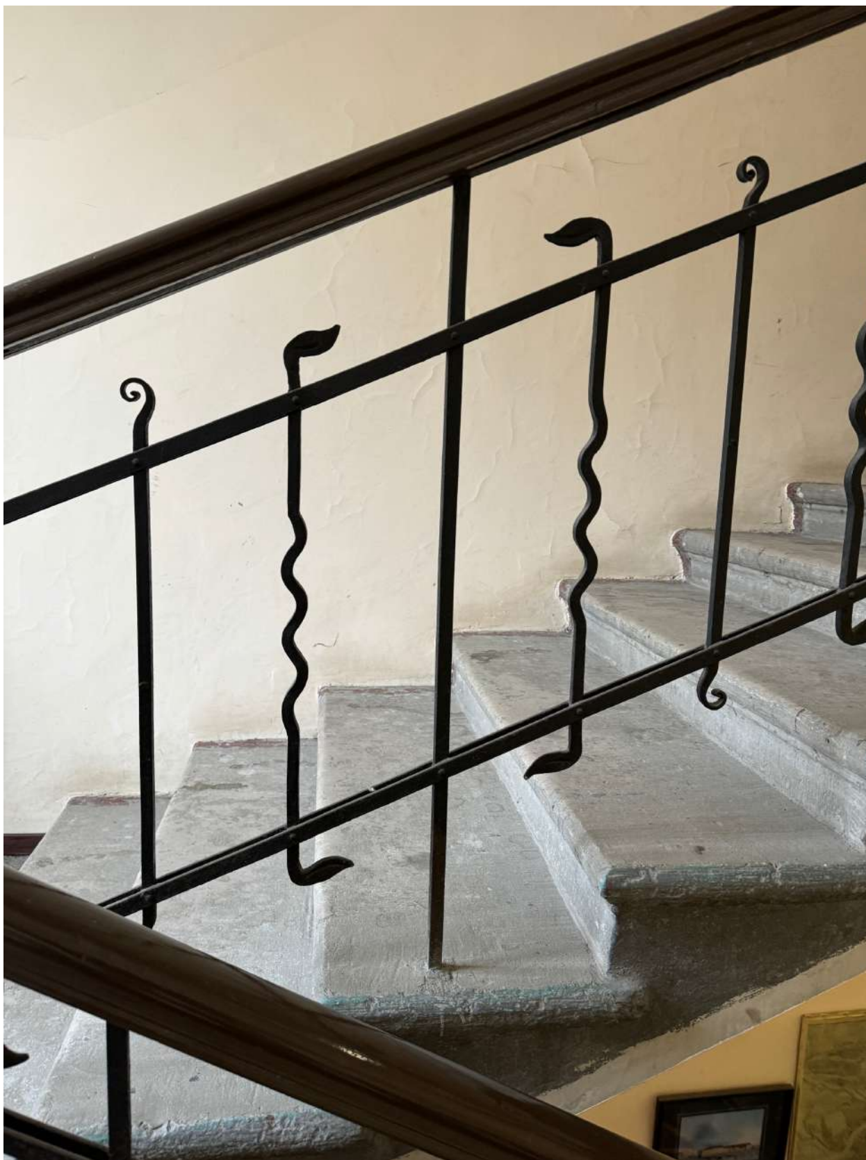
Фото 23. Фрагмент ограждения парадной лестницы объекта культурного наследия в уровне 1-го этажа.
