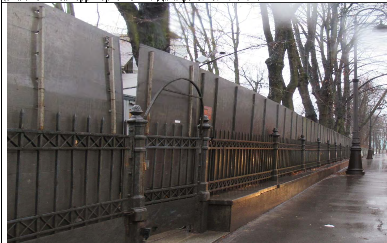
2. Вид на ОКН «Ограда», входящий в состав ОКН «Дом Голицынского с участком парка и оградой», по адресу: Санкт-Петербург, набережная реки Малой Невки, д. 12, лит. А. Вид на северную ограду с точки за территорией ОКН. Дата фото: 23.12.2020 г.
