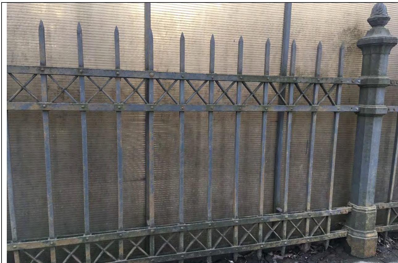
3. Вид на ОКН «Ограда», входящий в состав ОКН «Дом Голицынского с участком парка и оградой», по адресу: Санкт-Петербург, набережная реки Малой Невки, д. 12, лит. А. Вид на северную ограду с точки за территорией ОКН. Дата фото: 23.12.2020 г.
