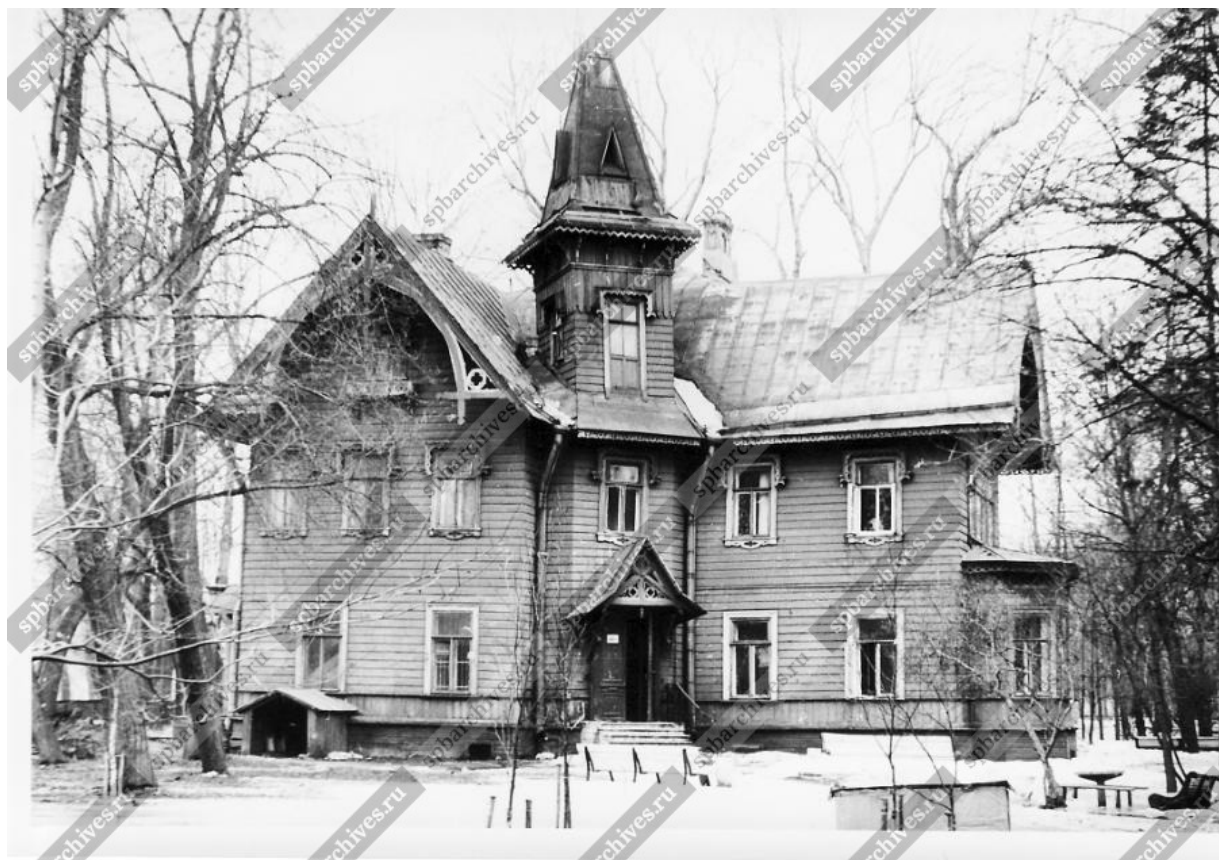
28. 1980г. Вид восточного фасада с башней и главным входом деревянного дачного дома по набережной Малой Невки 12 (бывшая дача П. С. Петровой). Фото Овчинникова К. В. ЦГАКФФД.
