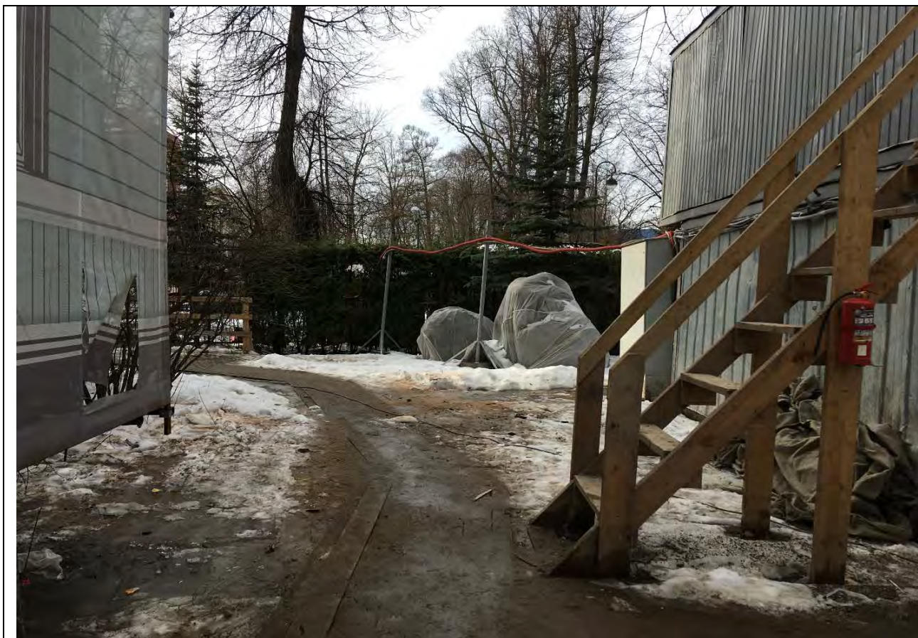
5. Вид на ОКН «Дом Голицынского с участком парка и оградой», по адресу: Санкт-Петербург, набережная реки Малой Невки, д. 12, лит. А. Вид на северный фасад. Дата фото: 23.12.2020 г.
