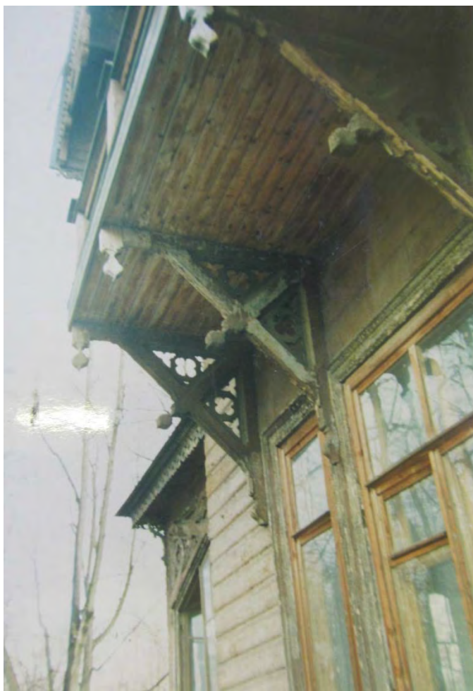
45. 2001г. Бывший дом П. С. Петровой. Фрагмент западного фасада. Архив КГИОП.
