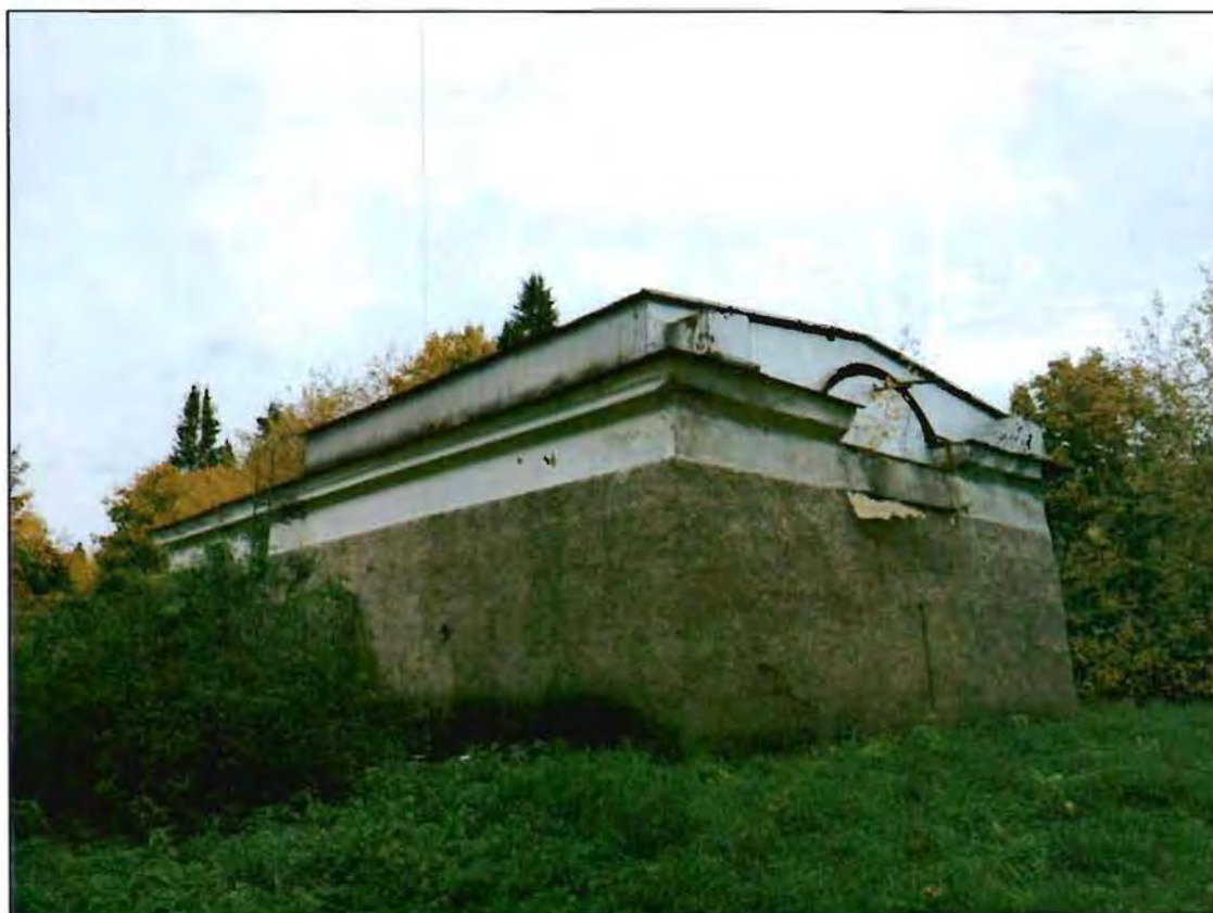
2. Общий вид с юго-запада.
