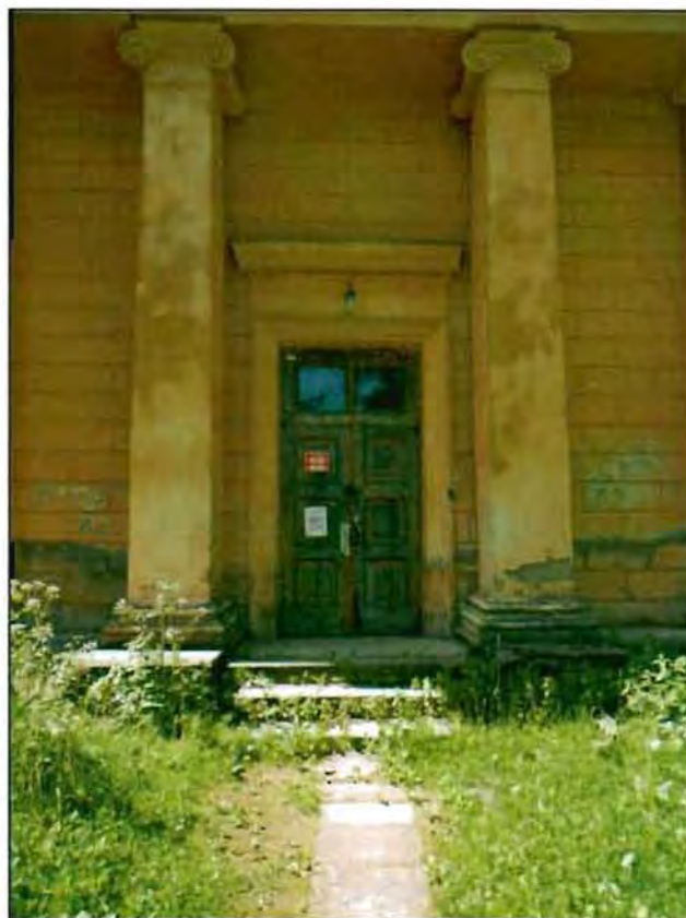
2. «Павильон 26-дюймового рефрактора». Восточный фасад. Фрагмент.
