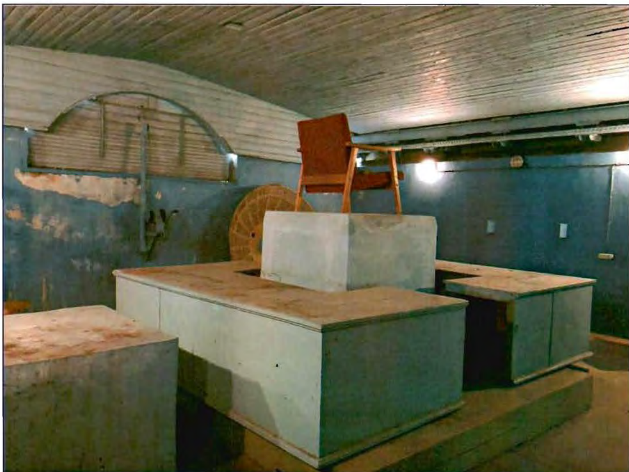
4. Помещение в уровне 2-го этажа.
