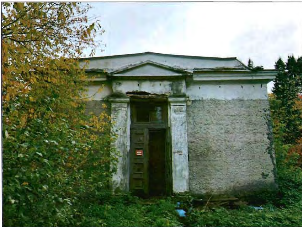
1. Северный фасад. Общий вид.
