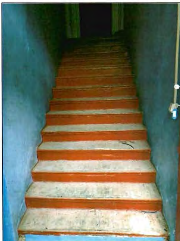
3. Лестница. Общий вид.
