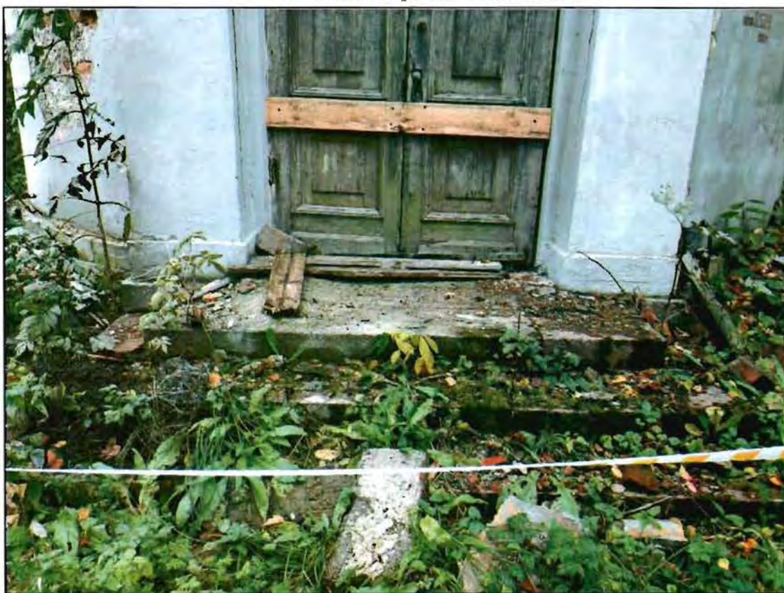
3. Восточный фасад. Крыльцо.
