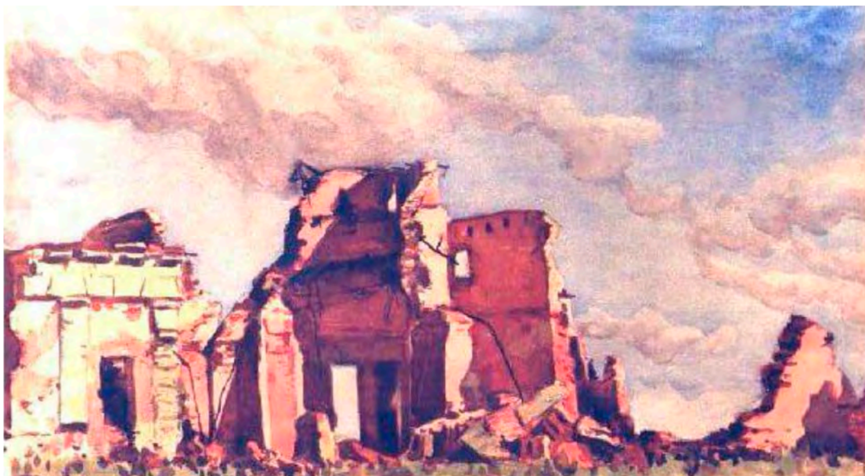
25. Руины Главного здания Пулковской обсерватории. 1944 г. Худ. В.А. Кочегура. Музей ГАО РАН // Толбин С.В., Семенова Г.В. История основания и послевоенного восстановления Пулковской обсерватории
