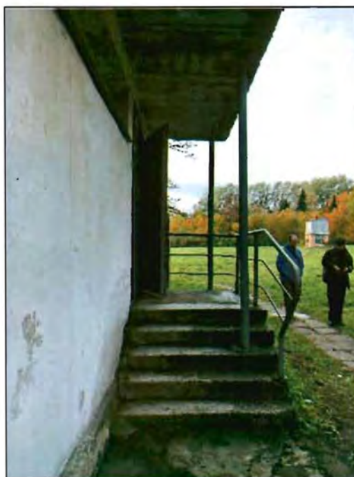
3. Северный фасад. Фрагмент. Крыльцо.
