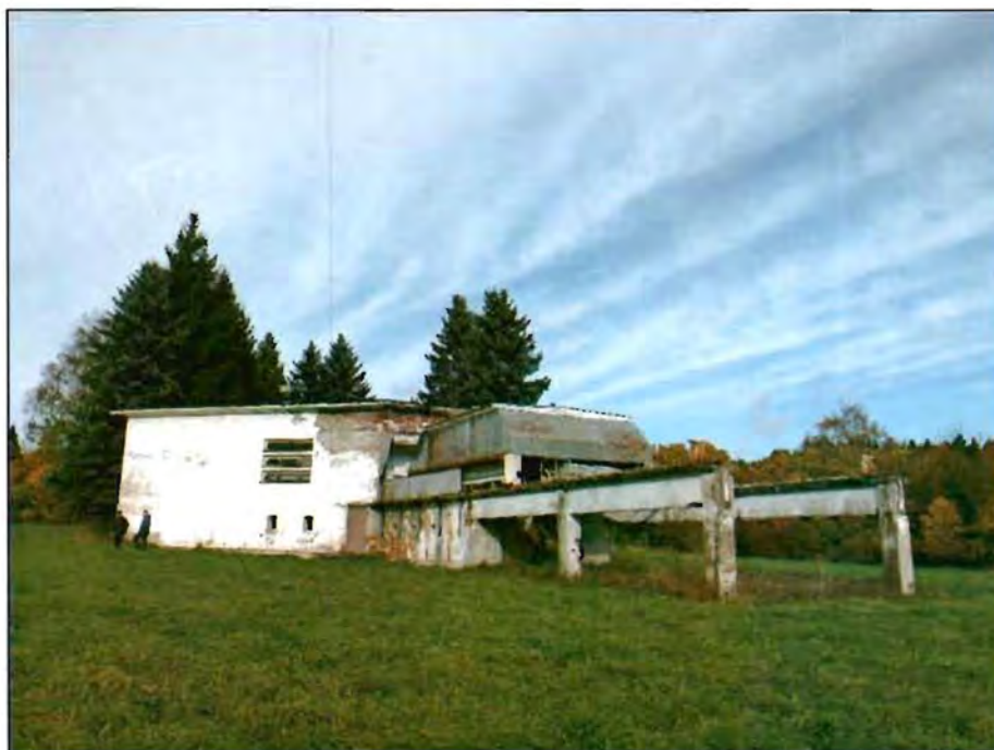
2. Общий вид с юго-запада.
