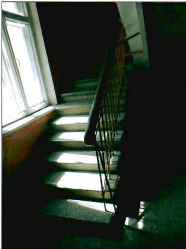
4. Межэтажная лестница. Общий вид.
