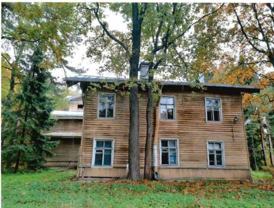
4. Вид на южный фасад объекта культурного наследия
