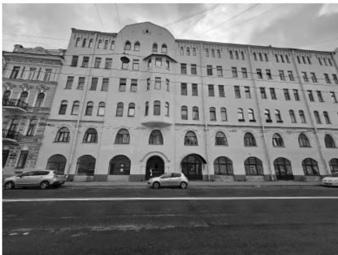
5. Объект культурного наследия регионального значения «Дом П.М. Станового», по адресу: г. Санкт-Петербург, Мытнинская ул., д. 5/2, лит. А. Фрагмент северо-западного лицевого фасада (северная часть).
