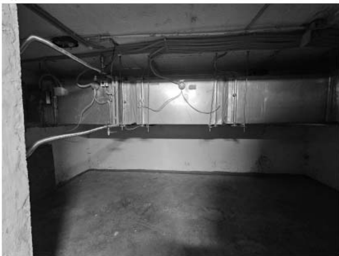
12. Объект культурного наследия регионального значения «Дом П.М. Станового», по адресу: г. Санкт-Петербург, Мытнинская ул., д. 5/2, лит. А. Общий вид пом. 8-Н (2) в уровне подвала.
