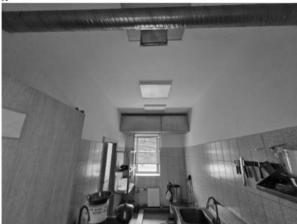
35. Объект культурного наследия регионального значения «Дом П.М. Станового», по адресу: г. Санкт-Петербург, Мытнинская ул., д. 5/2, лит. А. Общий вид пом. 2-Н (14) в уровне 1-го этажа.
