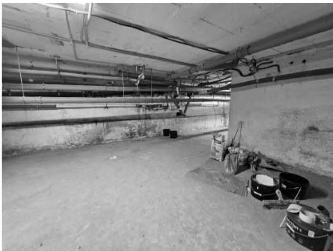
9. Объект культурного наследия регионального значения «Дом П.М. Станового», по адресу: г. Санкт-Петербург, Мытнинская ул., д. 5/2, лит. А. Фрагмент пом. 8-Н (1) в уровне подвала.
