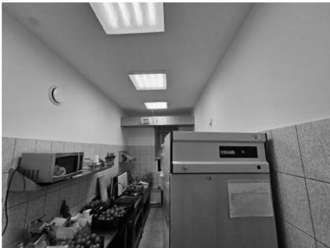
33. Объект культурного наследия регионального значения «Дом П.М. Станового», по адресу: г. Санкт-Петербург, Мытнинская ул., д. 5/2, лит. А. Общий вид пом. 2-Н (16) в уровне 1-го этажа.
