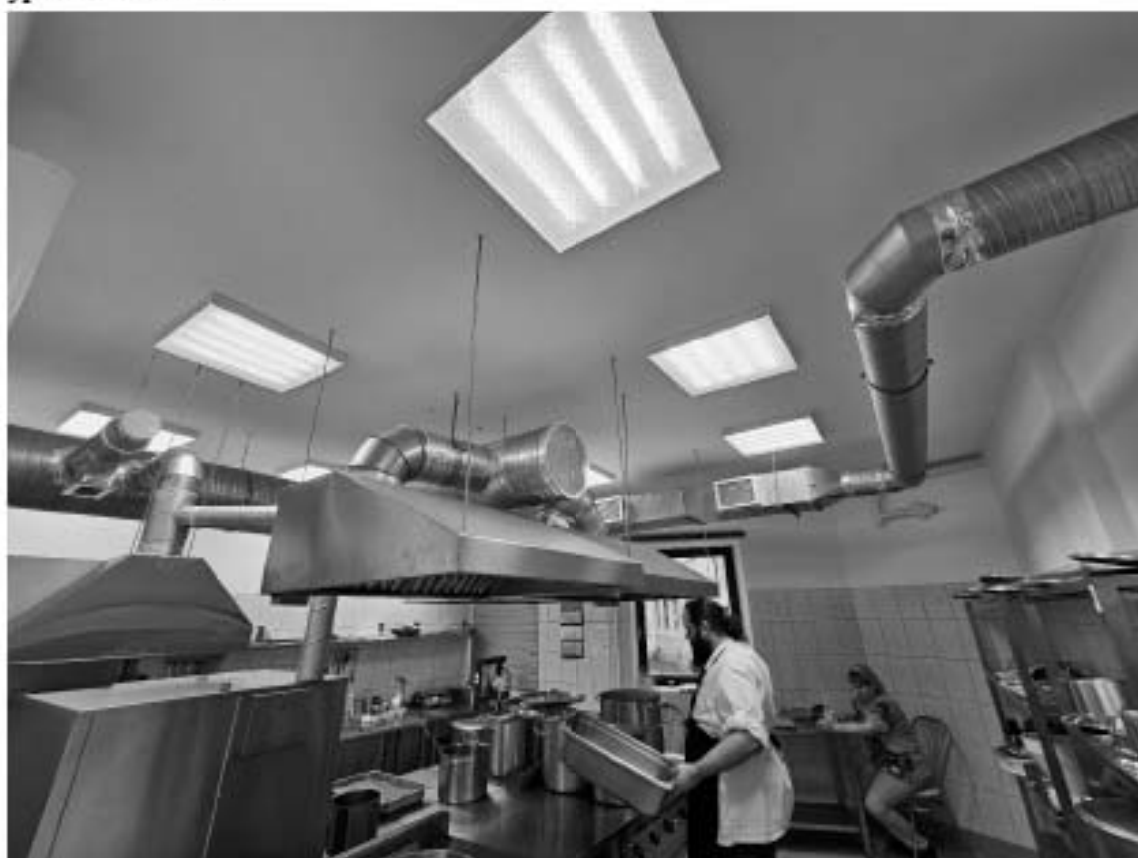
31. Объект культурного наследия регионального значения «Дом П.М. Станового», по адресу: г. Санкт-Петербург, Мытнинская ул., д. 5/2, лит. А. Общий вид пом. 2-Н (17) в уровне 1-го этажа.
