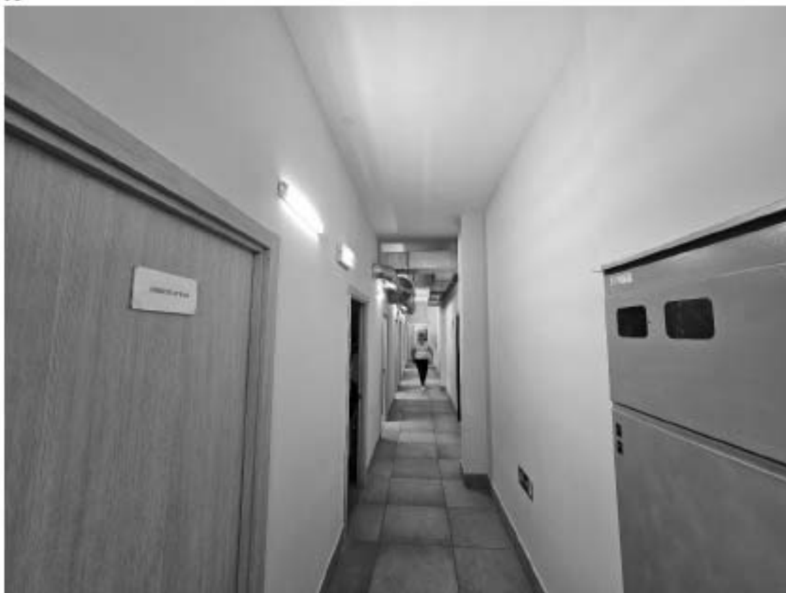
37. Объект культурного наследия регионального значения «Дом П.М. Станового», по адресу: г. Санкт-Петербург, Мытнинская ул., д. 5/2, лит. А. Общий вид пом. 2-Н (5) в уровне 1-го этажа.
