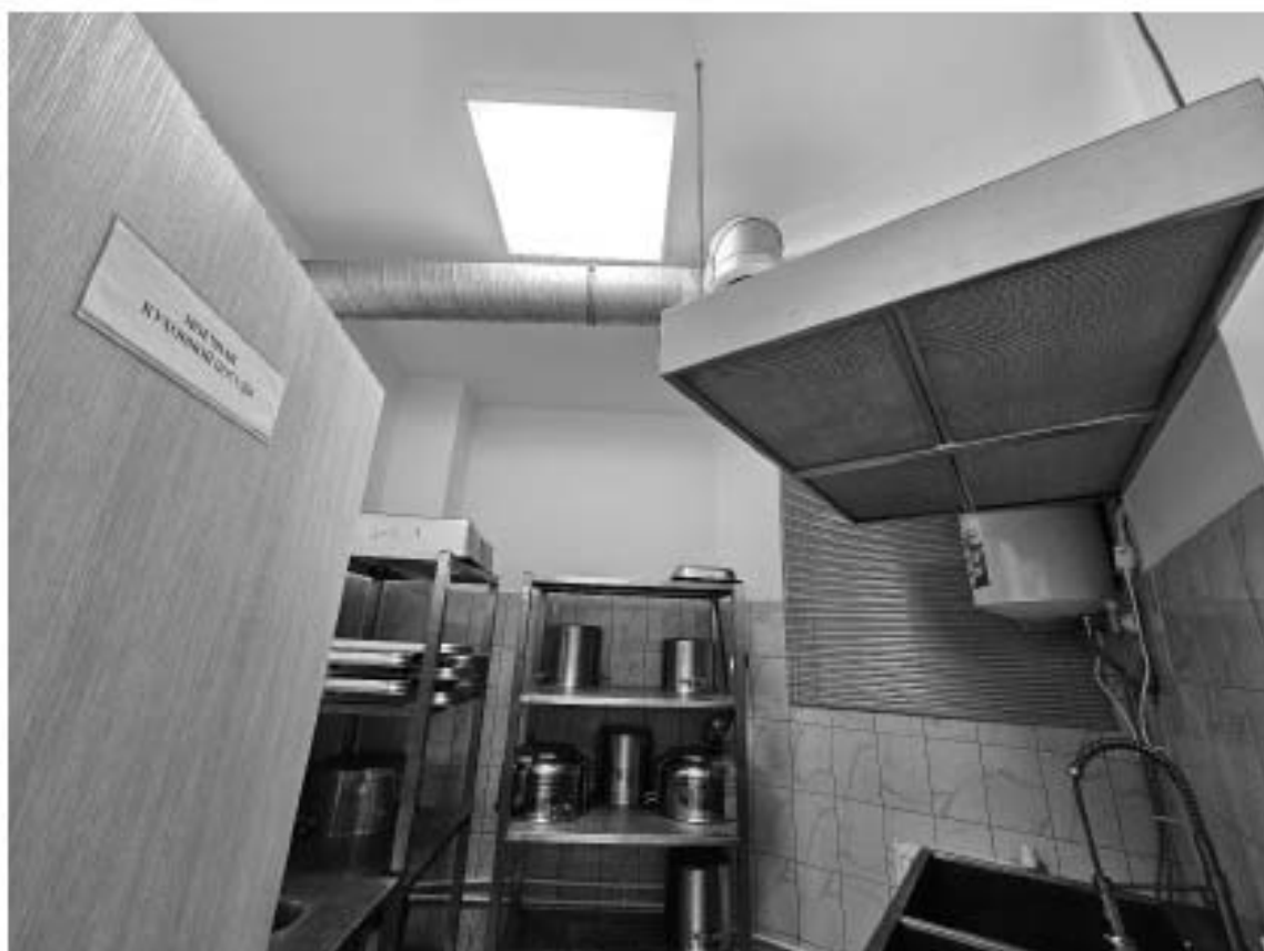
30. Объект культурного наследия регионального значения «Дом П.М. Станового», по адресу: г. Санкт-Петербург, Мытнинская ул., д. 5/2, лит. А. Общий вид пом. 2-Н (18) в уровне 1-го этажа.
