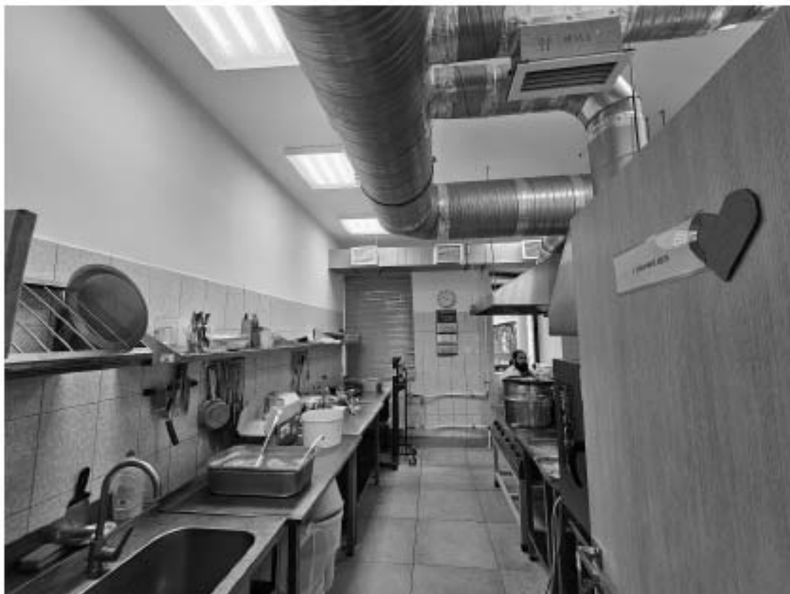
32. Объект культурного наследия регионального значения «Дом П.М. Станового», по адресу: г. Санкт-Петербург, Мытнинская ул., д. 5/2, лит. А. Общий вид пом. 2-Н (17) в уровне 1-го этажа.
