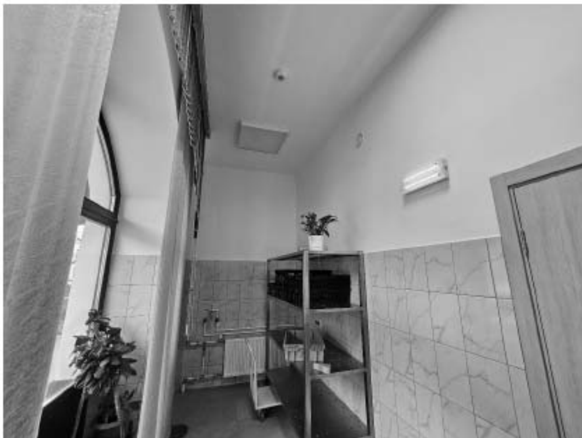
14. Объект культурного наследия регионального значения «Дом П.М. Станового», по адресу: г. Санкт-Петербург, Мытнинская ул., д. 5/2, лит. А. Общий вид пом. 2-Н (1) в уровне 1-го этажа.
