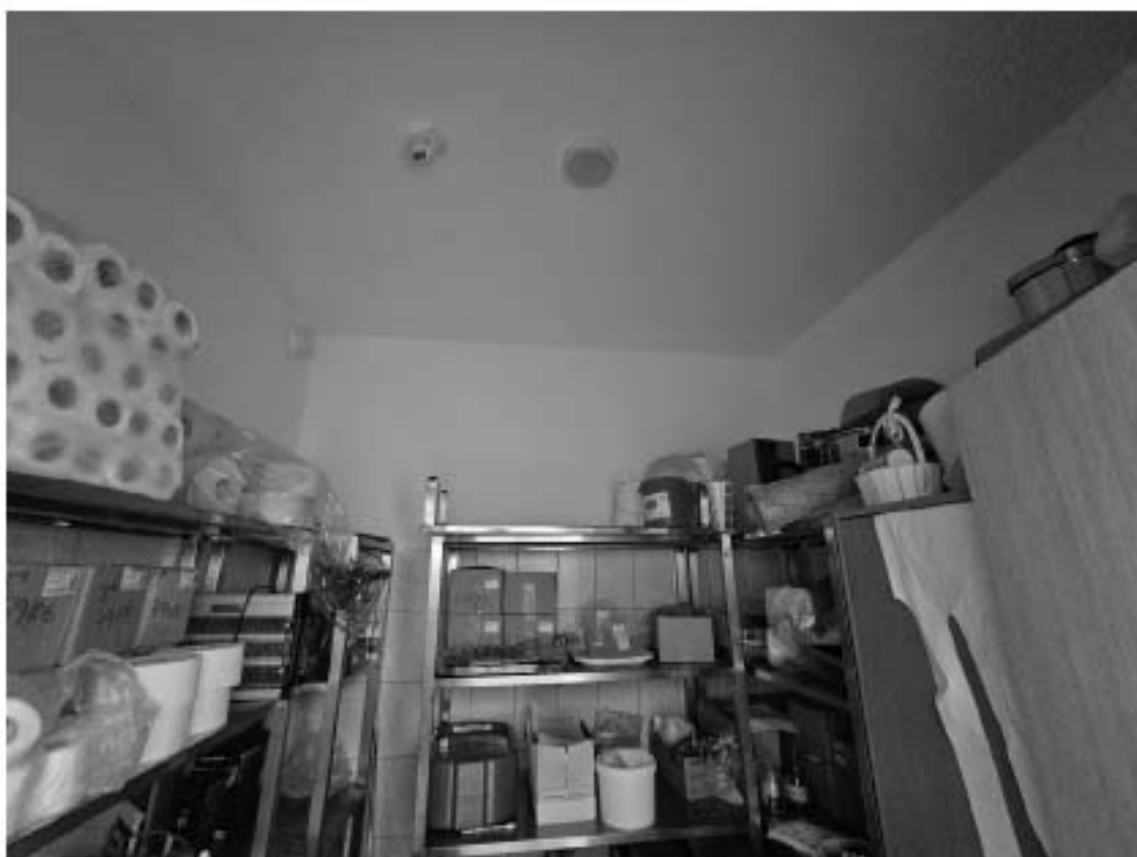
36. Объект культурного наследия регионального значения «Дом П.М. Станового», по адресу: г. Санкт-Петербург, Мытнинская ул., д. 5/2, лит. А. Общий вид пом. 2-Н (13) в уровне 1-го этажа.
