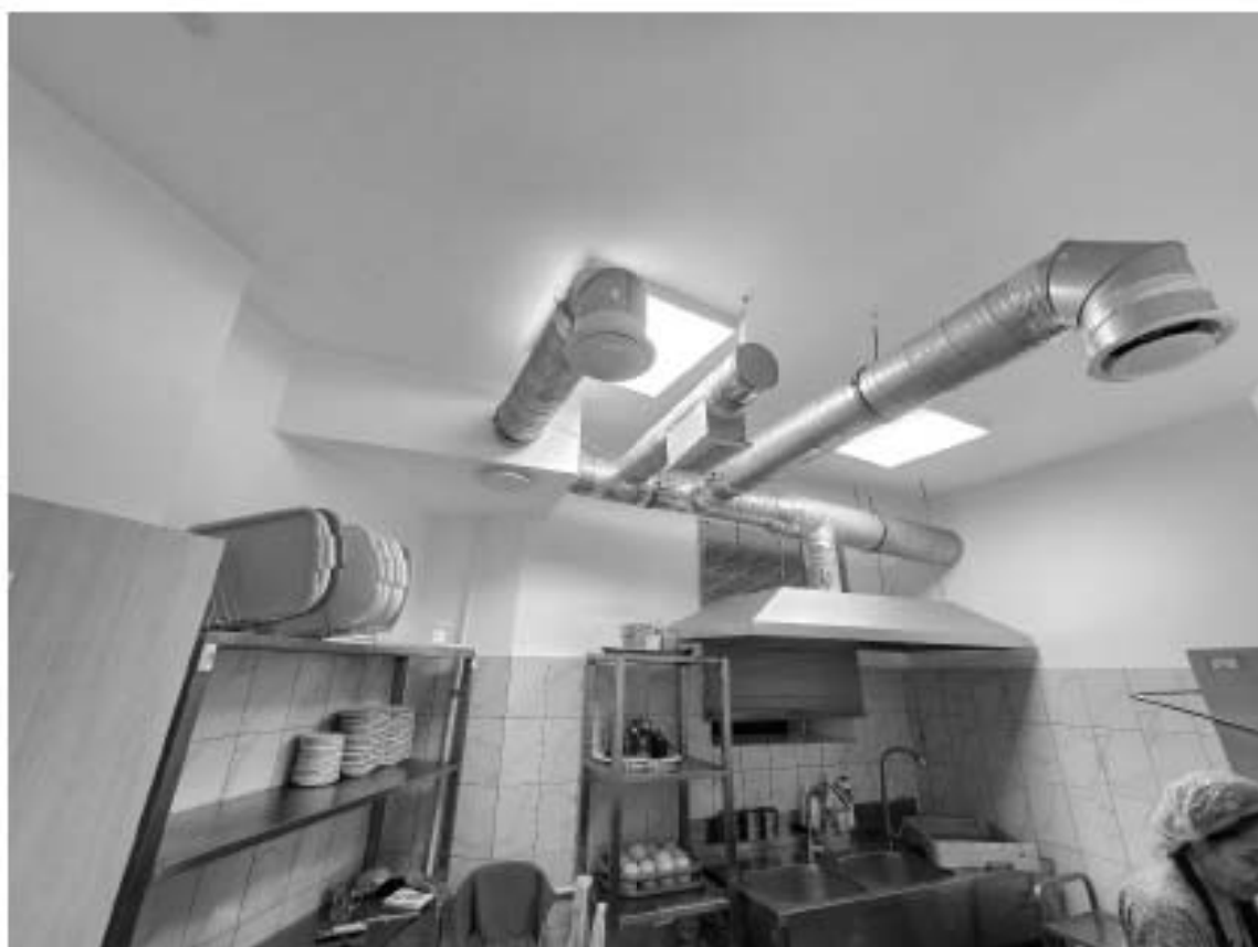
28. Объект культурного наследия регионального значения «Дом П.М. Станового», по адресу: г. Санкт-Петербург, Мытнинская ул., д. 5/2, лит. А. Общий вид пом. 2-Н (19) в уровне 1-го этажа.
