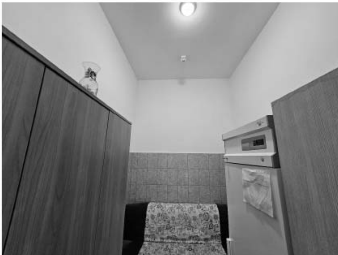
16. Объект культурного наследия регионального значения «Дом П.М. Станового», по адресу: г. Санкт-Петербург, Мытнинская ул., д. 5/2, лит. А. Общий вид пом. 2-Н (3) в уровне 1-го этажа.
