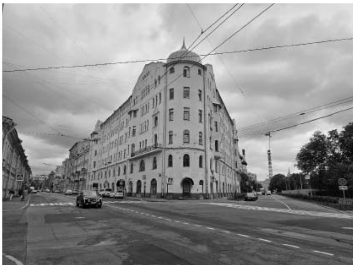
1. Объект культурного наследия регионального значения «Дом П.М. Станового», по адресу: г. Санкт-Петербург, Мытнинская ул., д. 5/2, лит. А. Общий вид здания от пересечения Мытнинской и Старорусской улиц.
