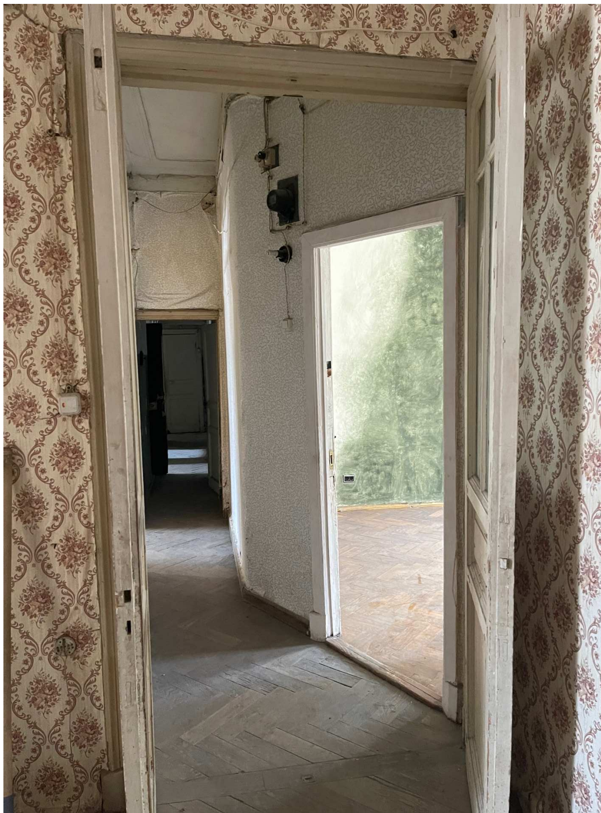
8. Фрагмент интерьера коридора (помещение 14/4.9);
