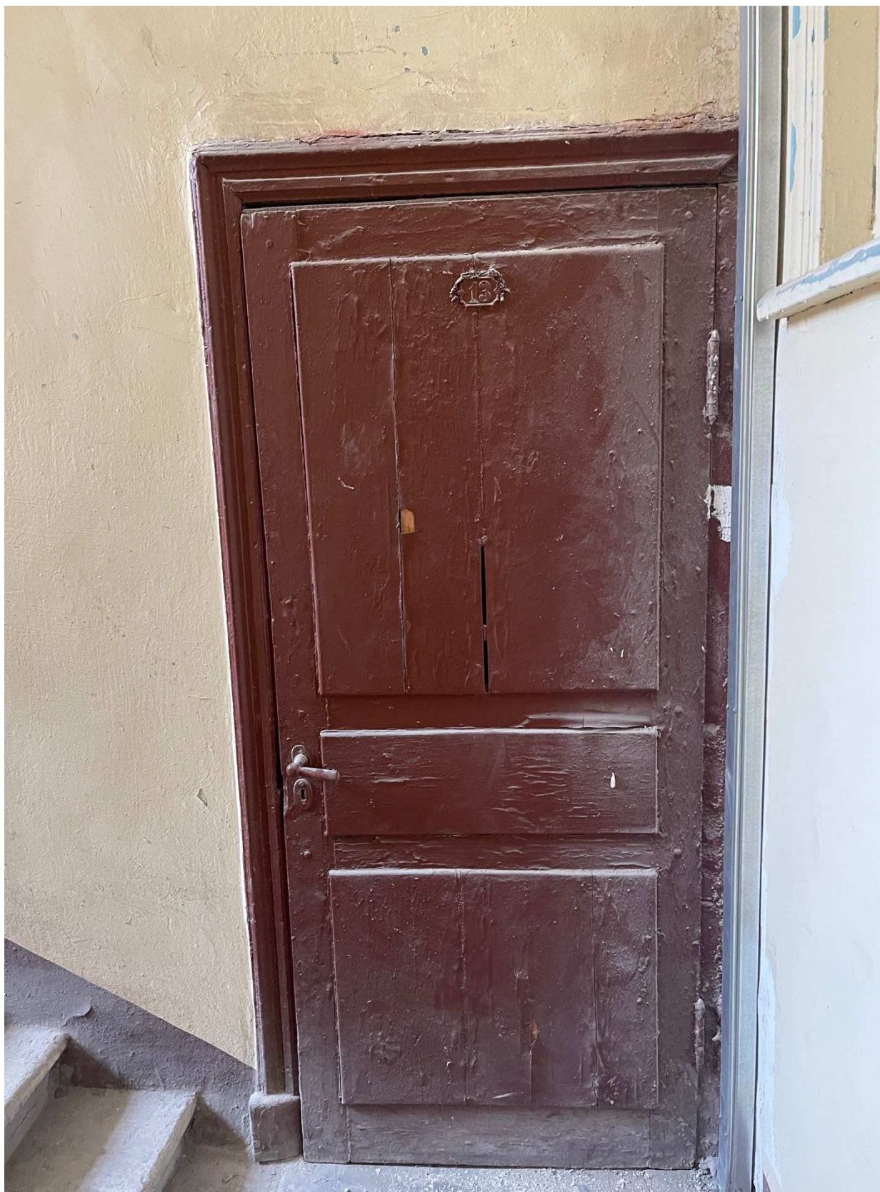
26. Вид на входную дверь в квартиру.
