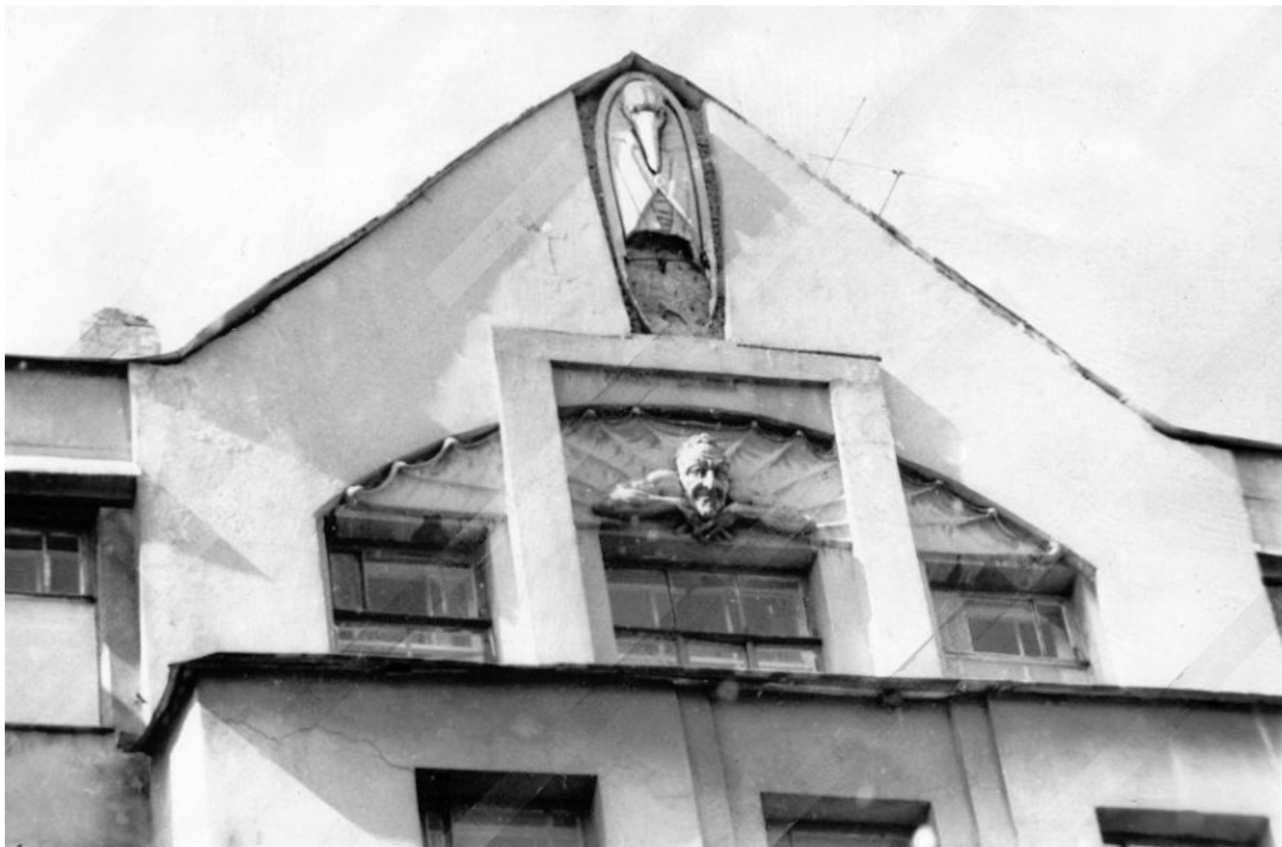
26. Вид треугольного фронтона центрального фасада, с трехчастным окном в полуциркулярной части оконной рамы помещен барельеф "паук" дома № 24 по Лахтинской улице ( архитектор А.Л.Лишневский, 1910 -1911 гг.). Автор фото – Овчинников Кирилл Владимирович. 17 июня 1984 г. // Источник: ЦГАКФФД СПб Ар 215841.
