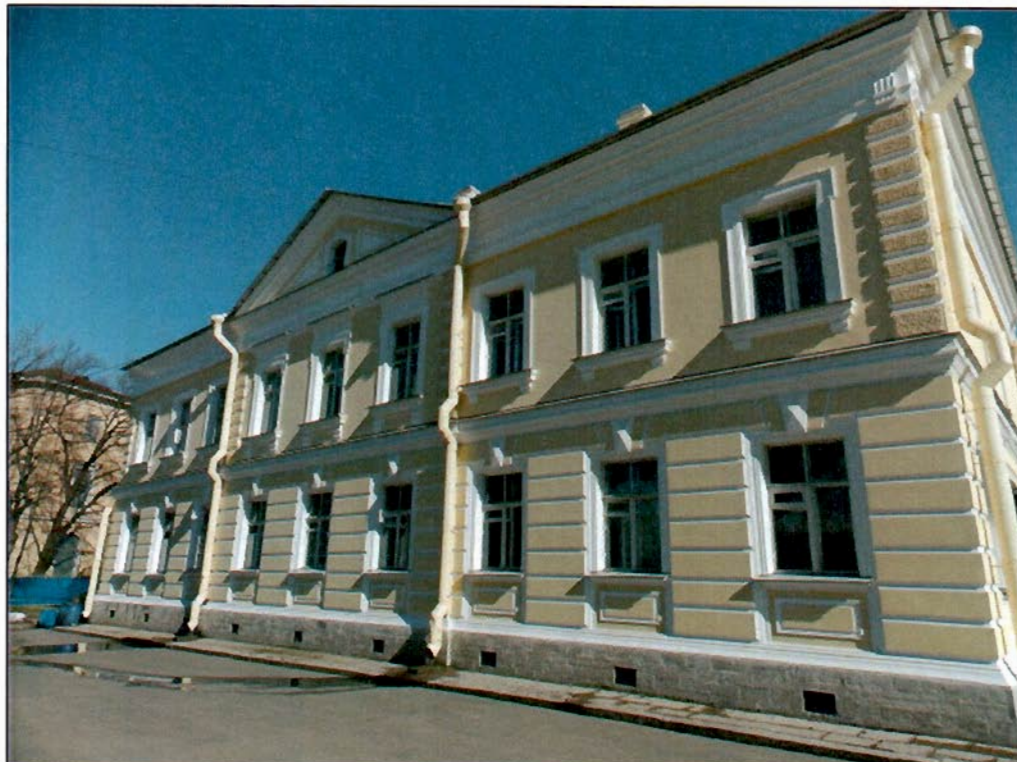
21. Северо-западный фасад здания.
