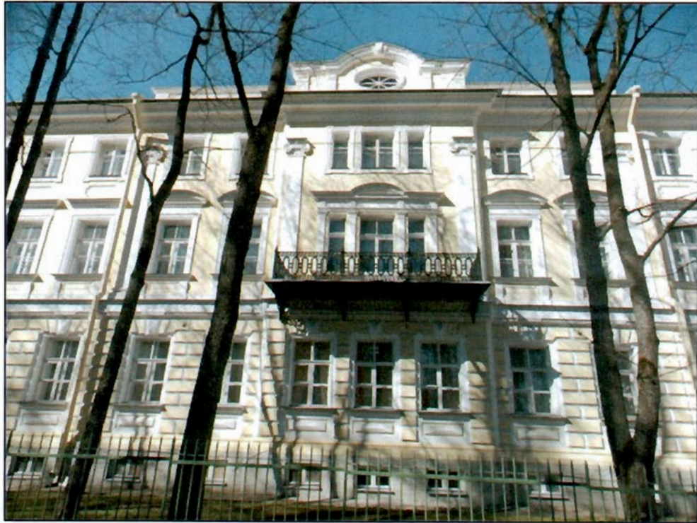
3. Юго-восточный фасад здания. Фрагмент.
