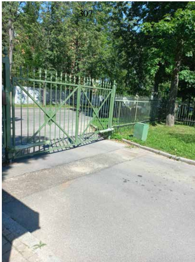
Фото 25. «Ограждение ФГКОУ «Первый пограничный кадетский военный корпус ФСБ РФ». Вид на Советский переулок. Дата 27.06.2024 г.
