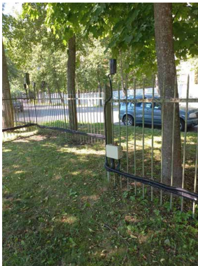
Фото 24. «Ограждение ФГКОУ «Первый пограничный кадетский военный корпус ФСБ РФ». Вид на Советский переулок. Дата 27.06.2024 г.
