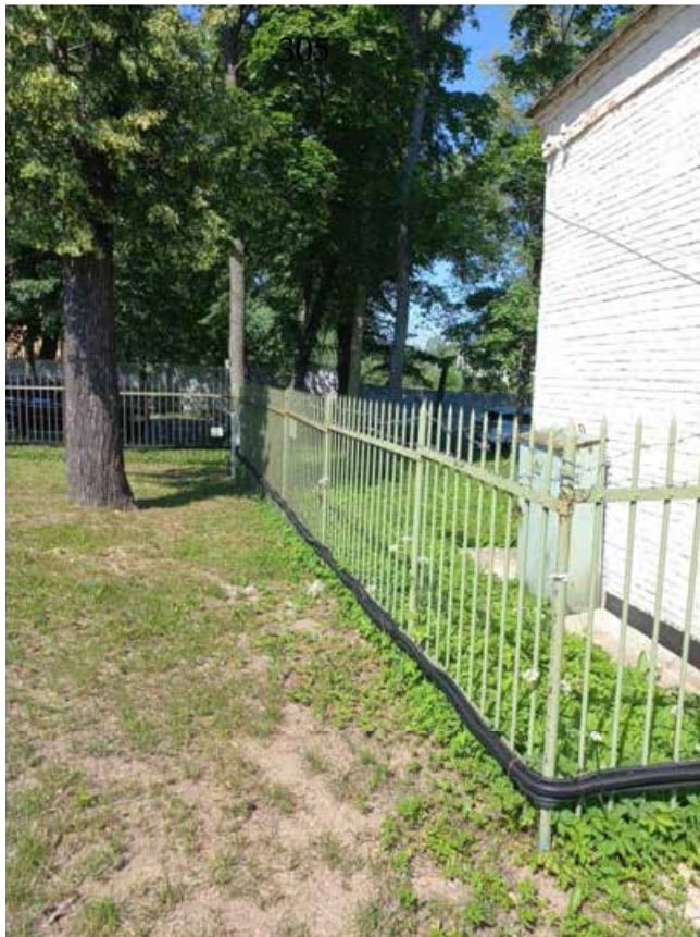
Фото 21. «Ограждение ФГКОУ «Первый пограничный кадетский военный корпус ФСБ РФ». Вид на Советский переулок. Дата 27.06.2024 г.
