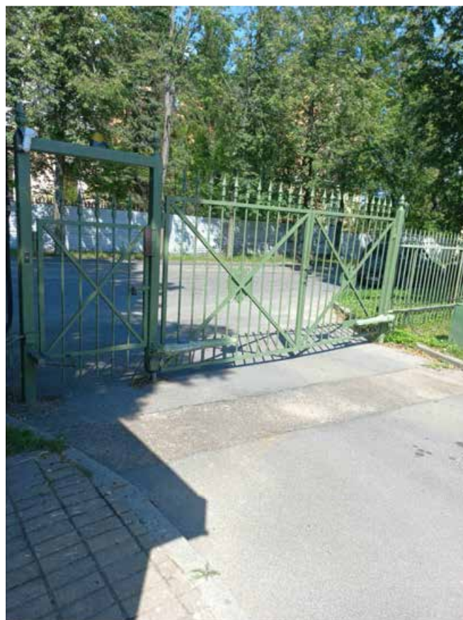
Фото 26. «Ограждение ФГКОУ «Первый пограничный кадетский военный корпус ФСБ РФ». Вид на Советский переулок. Дата 27.06.2024 г.
