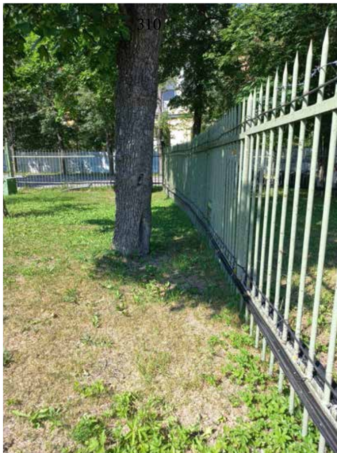
Фото 31. «Ограждение ФГКОУ «Первый пограничный кадетский военный корпус ФСБ РФ». Вид на Советский переулок. Дата 27.06.2024 г.
