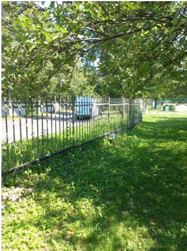
Фото 28. «Ограждение ФГКОУ «Первый пограничный кадетский военный корпус ФСБ РФ». Вид на Советский переулоч. Дата 27.06.2024 г.
