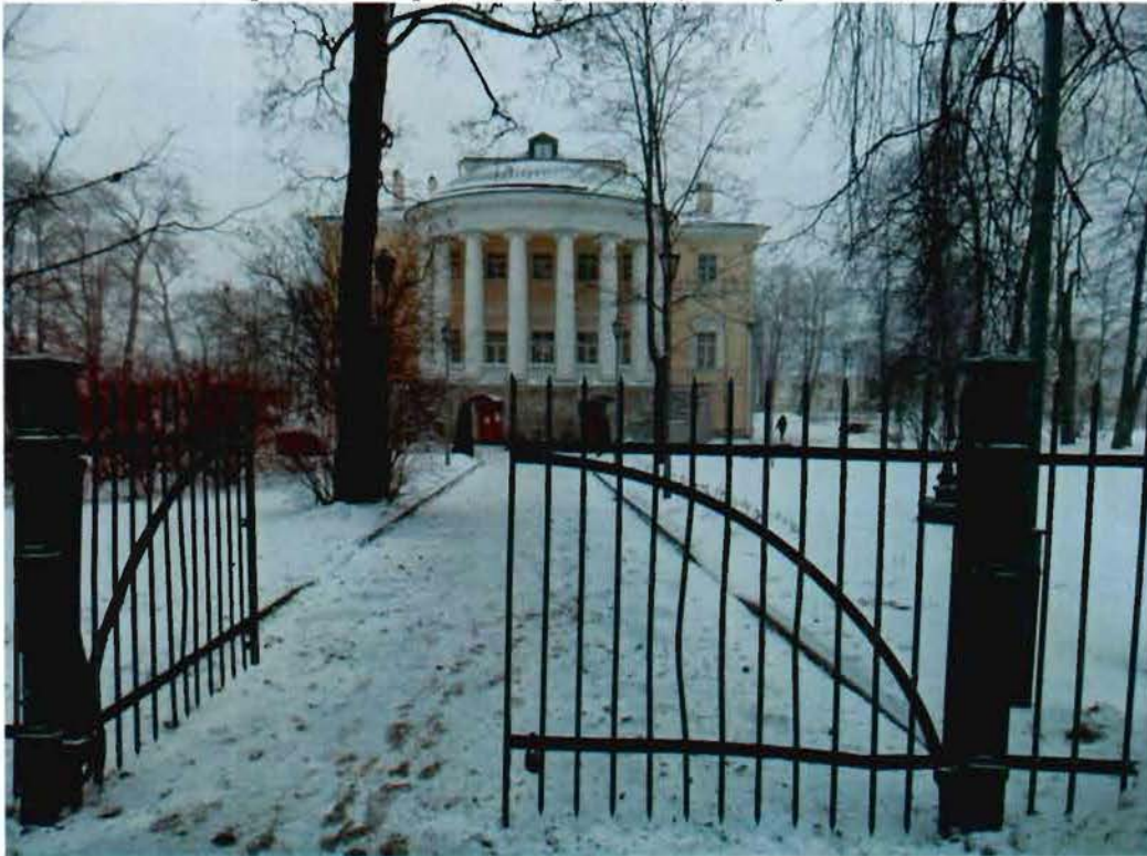
Фото 1. Фрагмент ограды с воротами (со стороны Садовой ул.)
