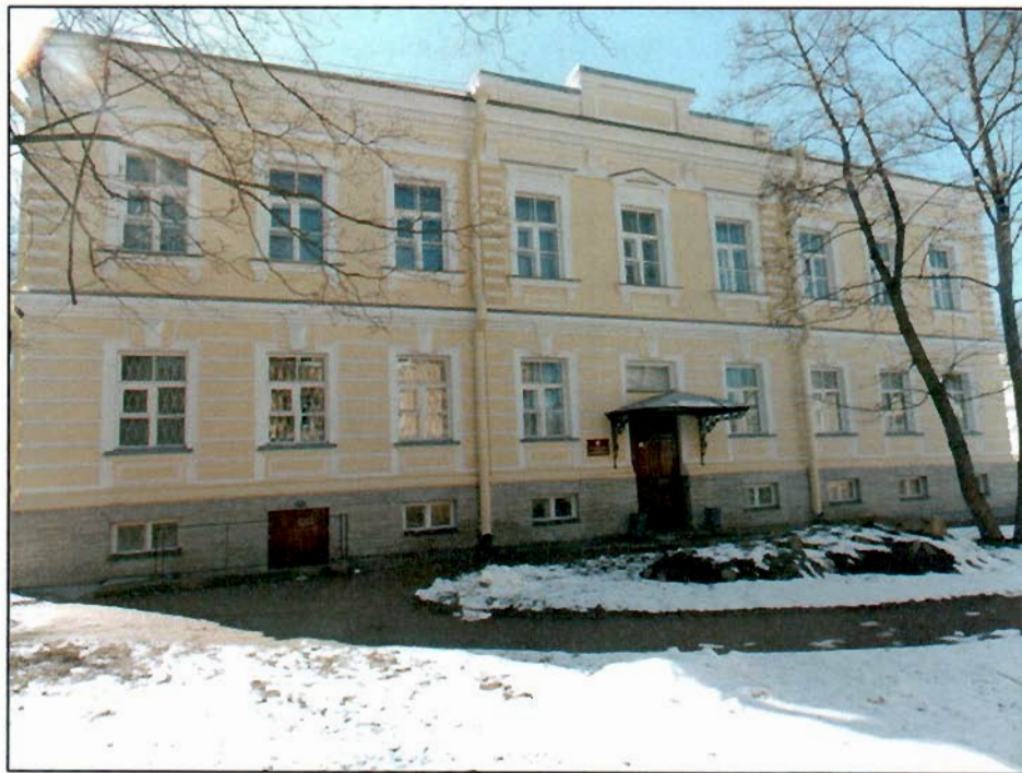
7. Восточный фасад здания.
