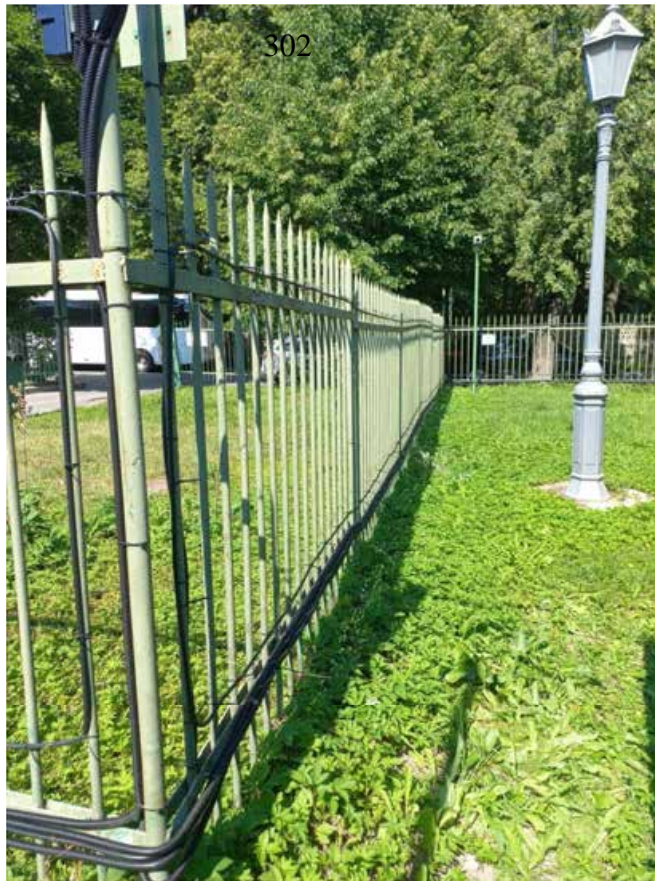
Фото 15. «Ограждение ФГКОУ «Первый пограничный кадетский военный корпус ФСБ РФ». Вид на Советский переулок. Дата 27.06.2024 г.
