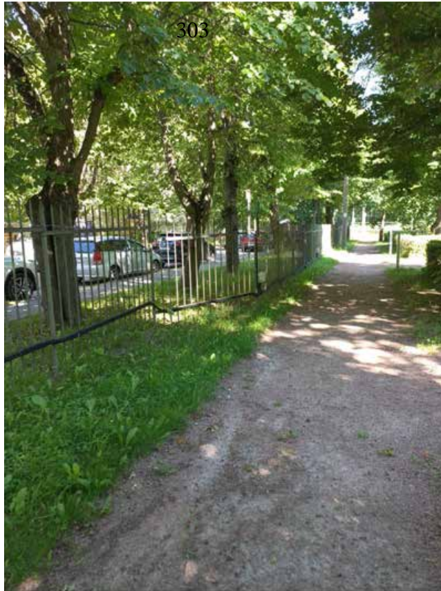
Фото 17. «Ограждение ФГКОУ «Первый пограничный кадетский военный корпус ФСБ РФ». Вид на Советский переулочек и Софийский бульвар. Дата 27.06.2024 г.
