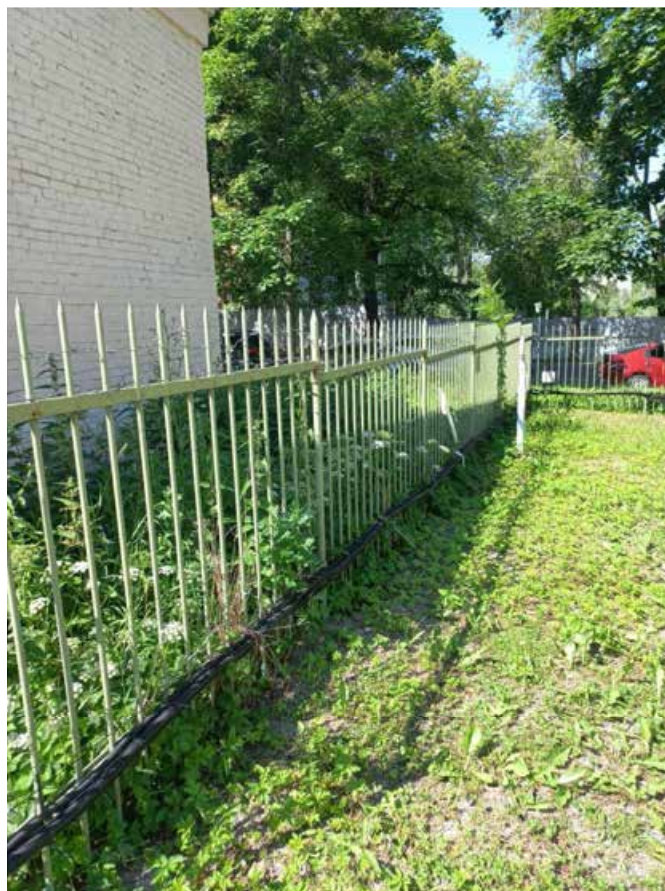
Фото 20. «Ограждение ФГКОУ «Первый пограничный кадетский военный корпус ФСБ РФ». Вид на Советский переулок. Дата 27.06.2024 г.
