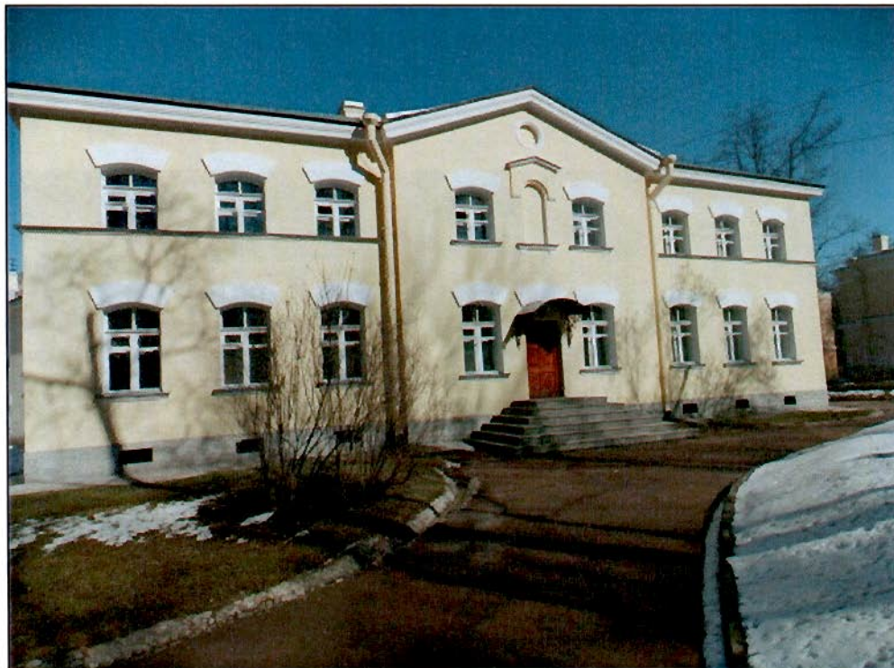
14. Юго-западный фасад здания.
