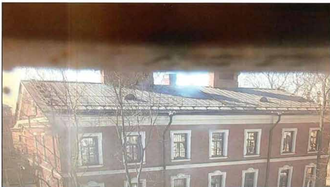
5. Кровля объекта культурного наследия.
