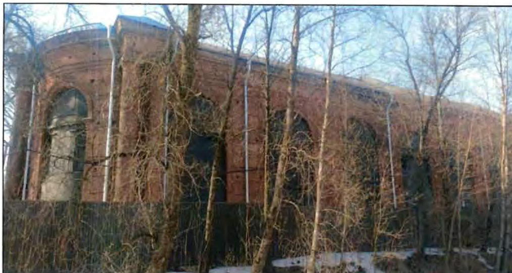
15. Фрагмент восточного фасада объекта культурного наследия.
