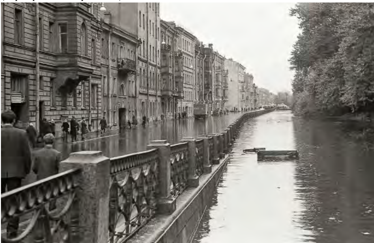
Илл. 42. Фотография набережной после реконструкции. Наводнение 18 октября 1967 г. ( https://pastvu.com/p/114544 )
