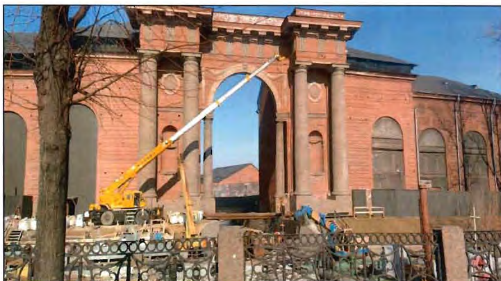
16. Вид на арку объекта культурного наследия между корпусами литеры О и литеры Н.
