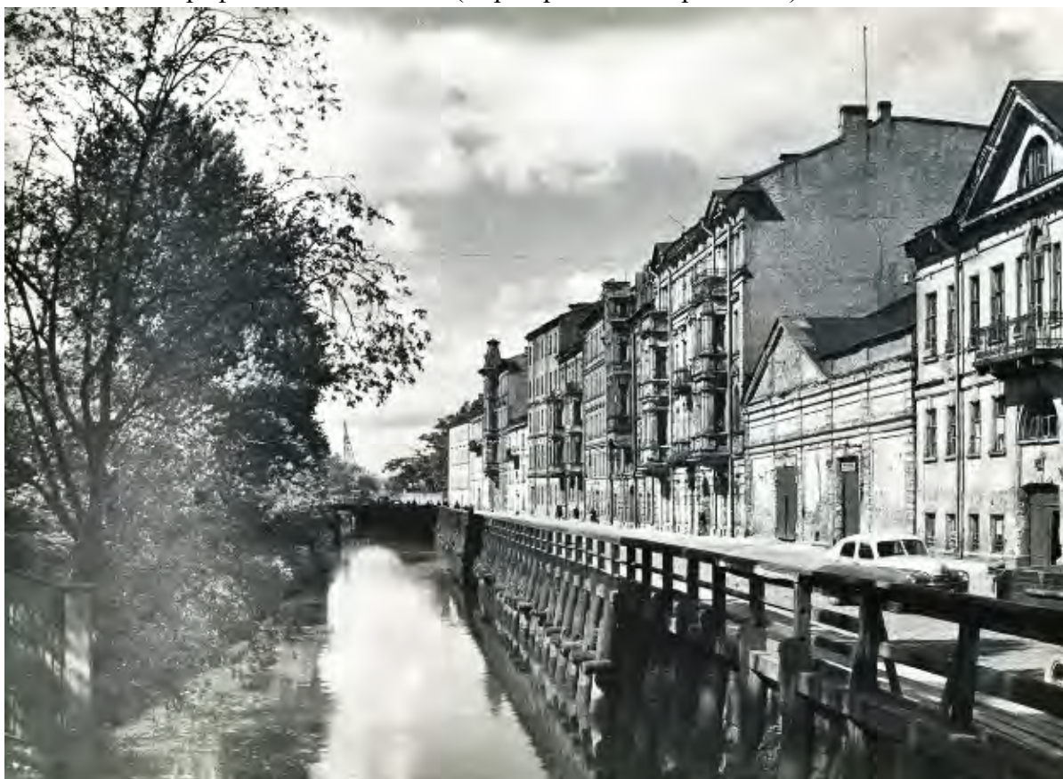
Илл. 38. Фотография от 1-го моста Круштейна 1957 года до реконструкции ( https://pastvu.com/p/336903 )
