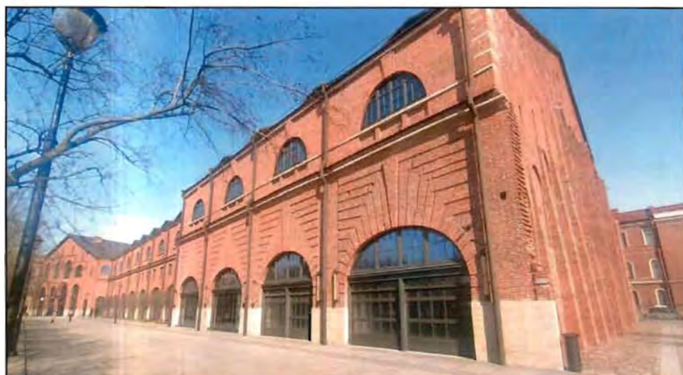
4. Западный фасад объекта культурного наследия.
