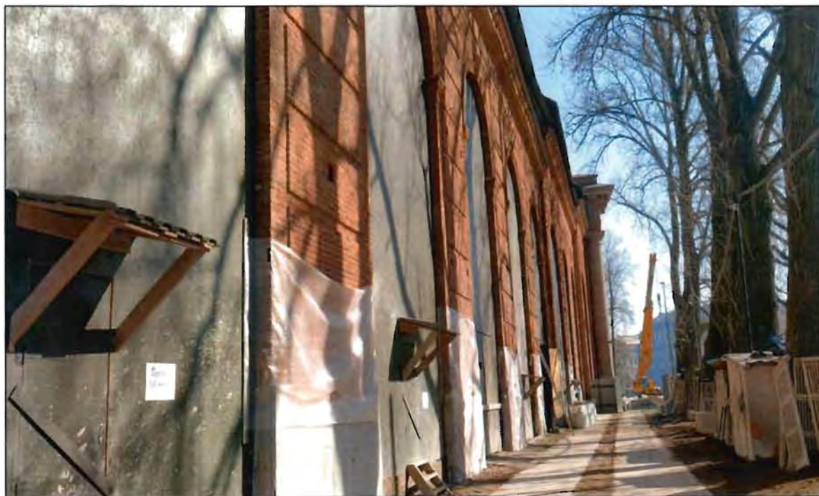
27. Фрагмент южного дворового фасада объекта культурного наследия.
