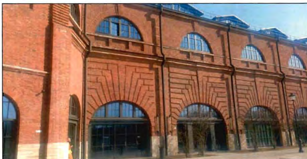
5. Фрагмент западного фасада объекта культурного наследия.
