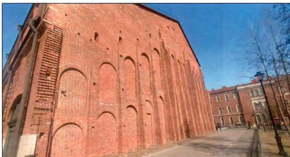
7. Южный фасад объекта культурного наследия.
