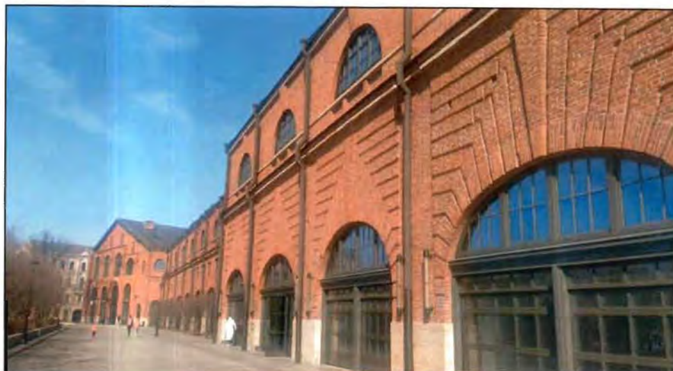
3. Западный фасад объекта культурного наследия.
