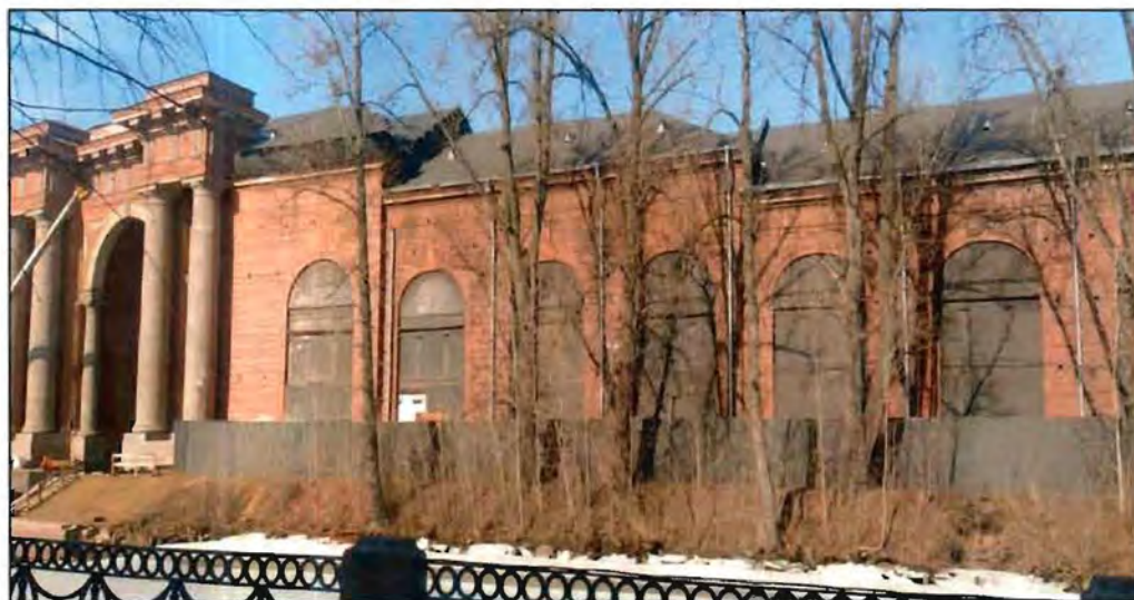
14. Фрагмент южного лицевого фасада объекта культурного наследия.
