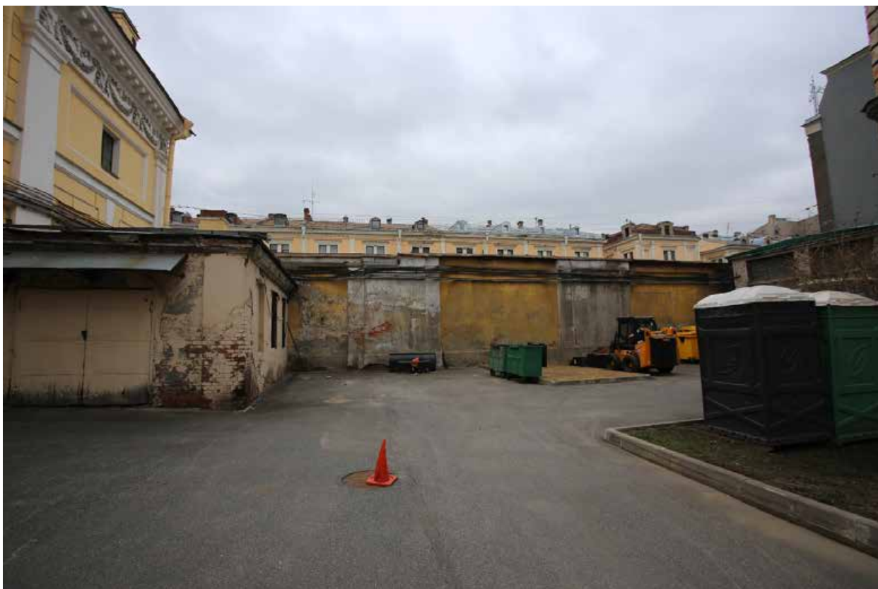
11. Объект культурного наследия федерального значения «Банк Ассигнационный», расположенный по адресу: г. Санкт-Петербург, Центральный район, наб. кан. Грибоедова, д. 30, 32, лит. А. Фото от 20 марта 2024 г.
