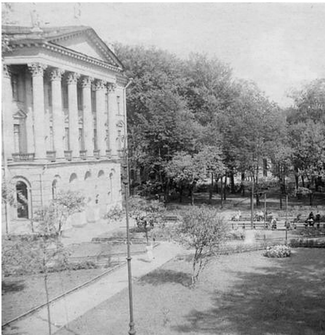
23. Сквер Ленинградского Финансово-Экономического института (ЛФЭИ). 1933 г. Электронный портал citywalls.ru .
