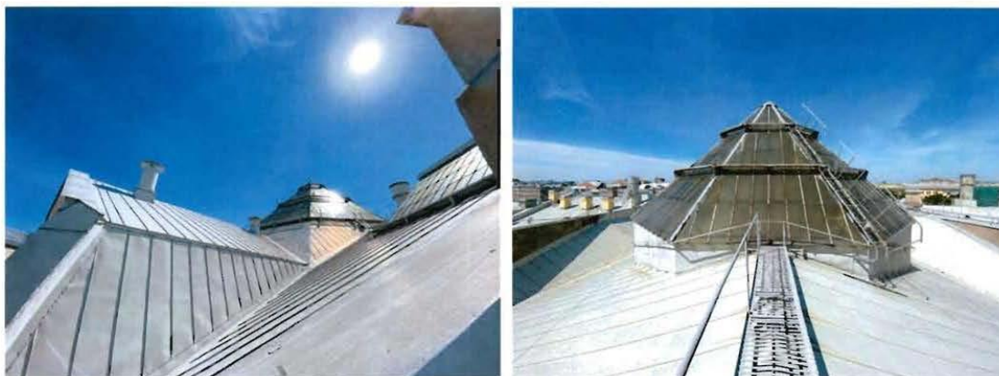
32-34. Конструкции световых фонарей.
