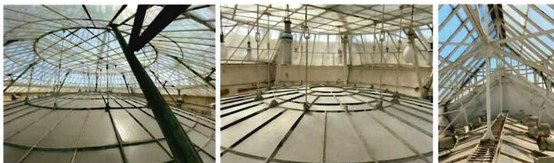
32-34. Конструкции световых фонарей.
