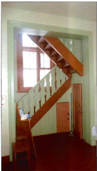
12. Лестница, в западной части здания.
