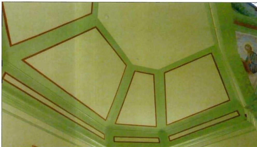
8. Перекрытие над алтарной частью церкви.
