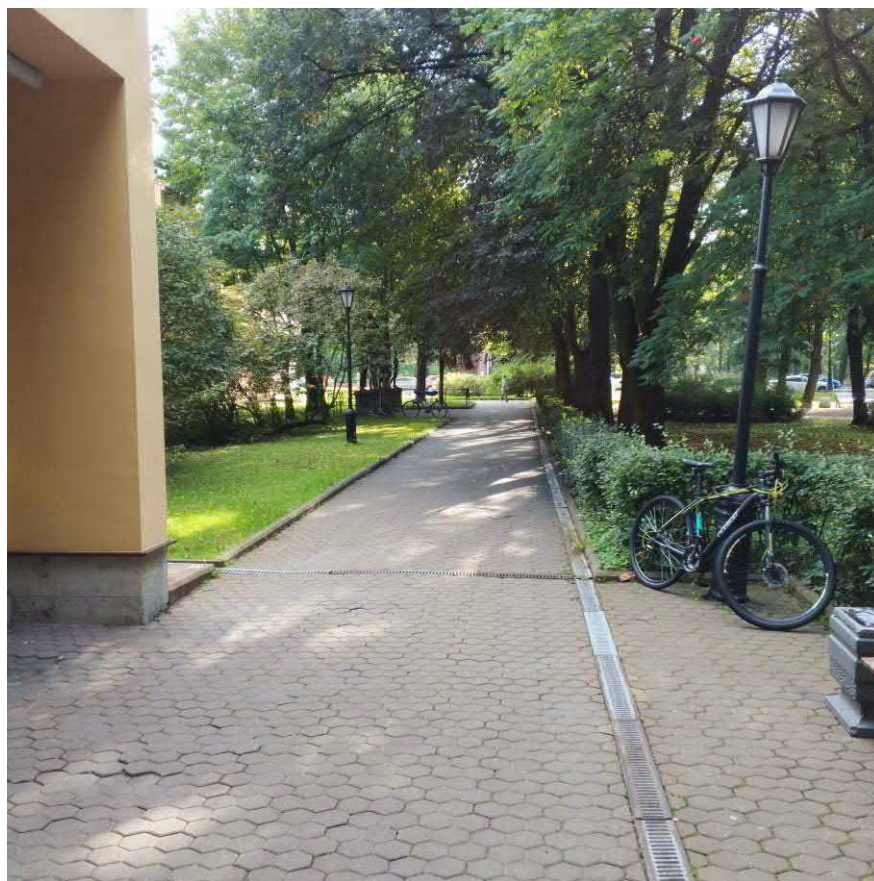
19. Фото. Фрагмент тротуара и дренажной системы. Дата съемки: 05.08.2024 г.
