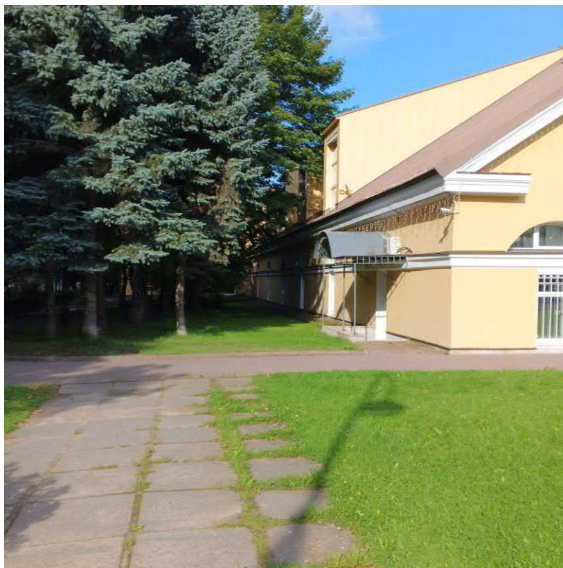
25. Фото. Фрагмент дворового и торцевого (юго-восточный) фасада и фрагмент тротуара. Дата съемки: 05.08.2024 г.
