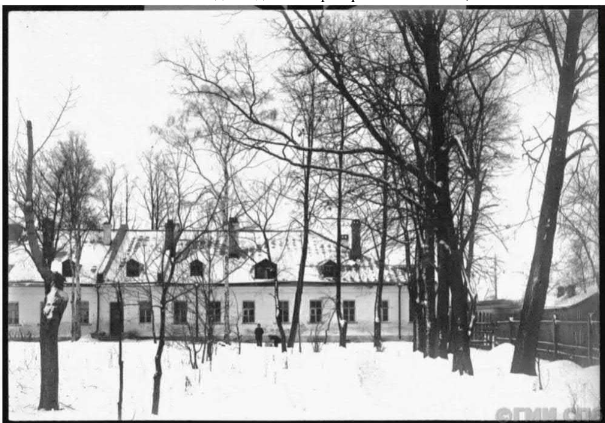
6. Вид на часть правого фасада Инвалидного дома. На первом плане – сад. 1927 г. ГМИ СПб.
