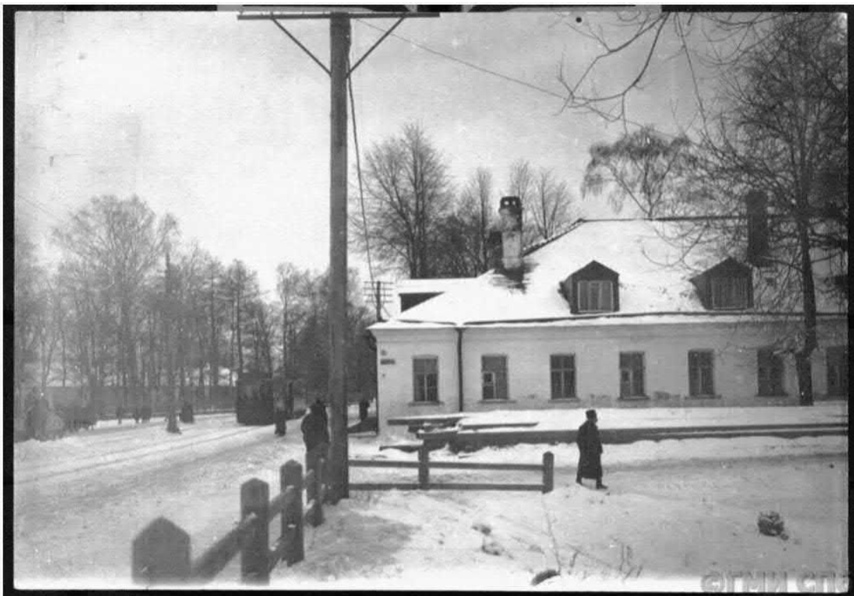
7. Вид на часть левого фасада Инвалидного дома. На первом плане – сад. 1927 г. ГМИ СПб.
