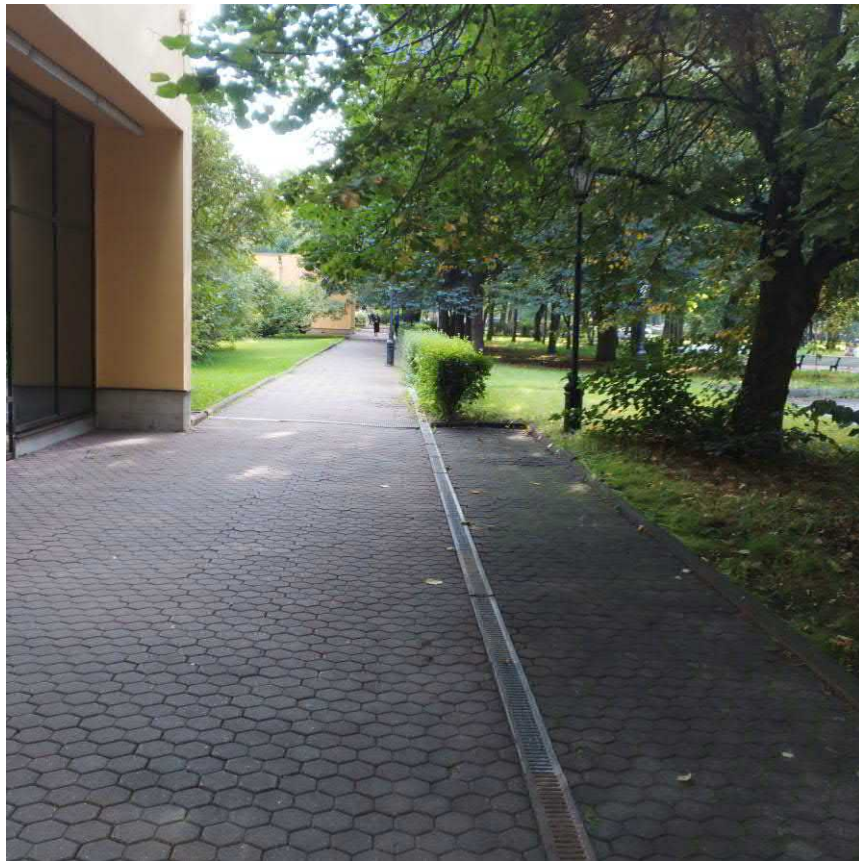
17. Фото. Дворовая территория, тротуар, дренажная система и сохраняемые деревья. Дата съемки: 05.08.2024 г.
