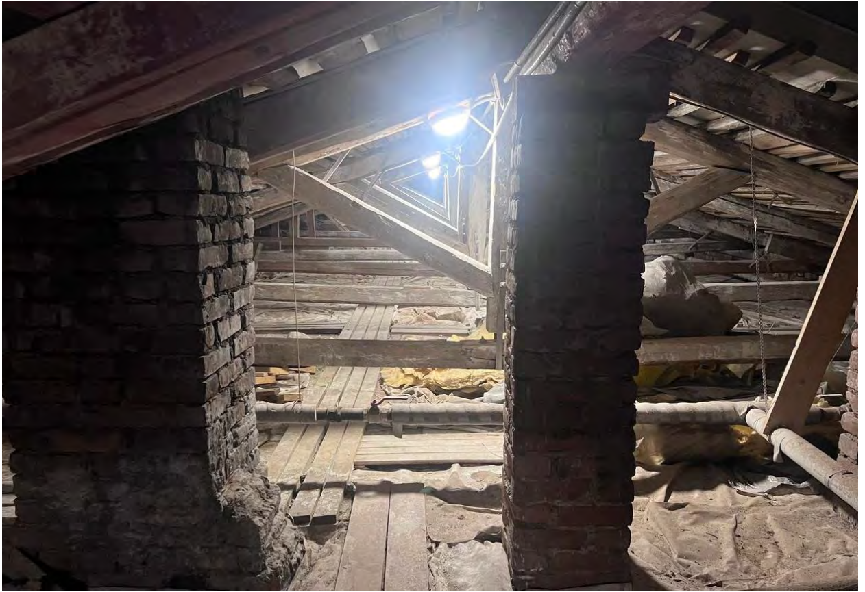
Фото 07. Выявленный ОКН «Гидротехнический институт им. Б.Е. Веденеева (лицевой корпус с примыкающими дворовыми флигелями)», расположенного по адресу: Санкт-Петербург, Гжатская д. 21, лит. А. Крыша. Стропильная система. Фрагмент. Съёмка 16.08.2024 г.
