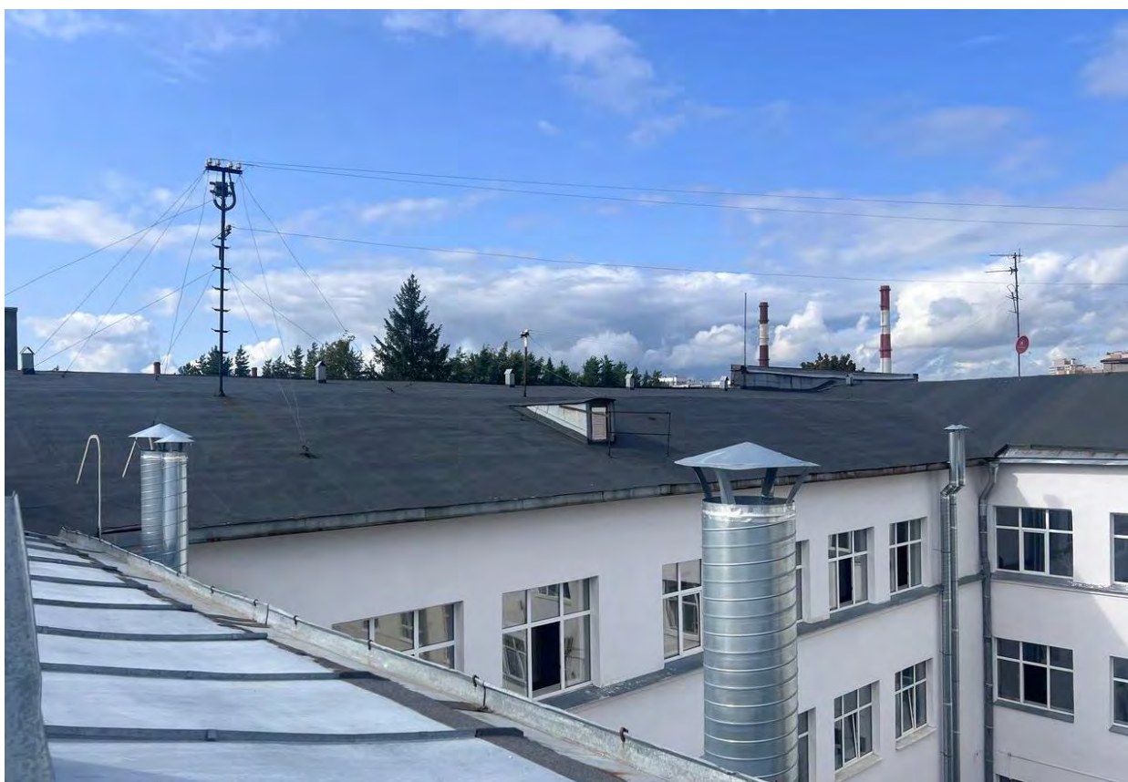
Фото 01. Выявленный ОКН «Гидротехнический институт им. Б.Е. Веденеева (лицевой корпус с примыкающими дворовыми флигелями)», расположенного по адресу: Санкт-Петербург, Гжатская д. 21, лит. А. Кровля. Фрагмент. Съёмка 16.08.2024 г.
