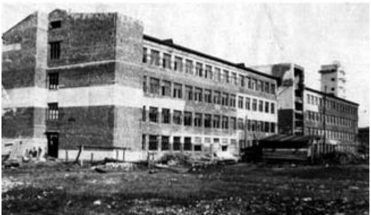
60. Учебный корпус в процессе строительства. 1934 г.
