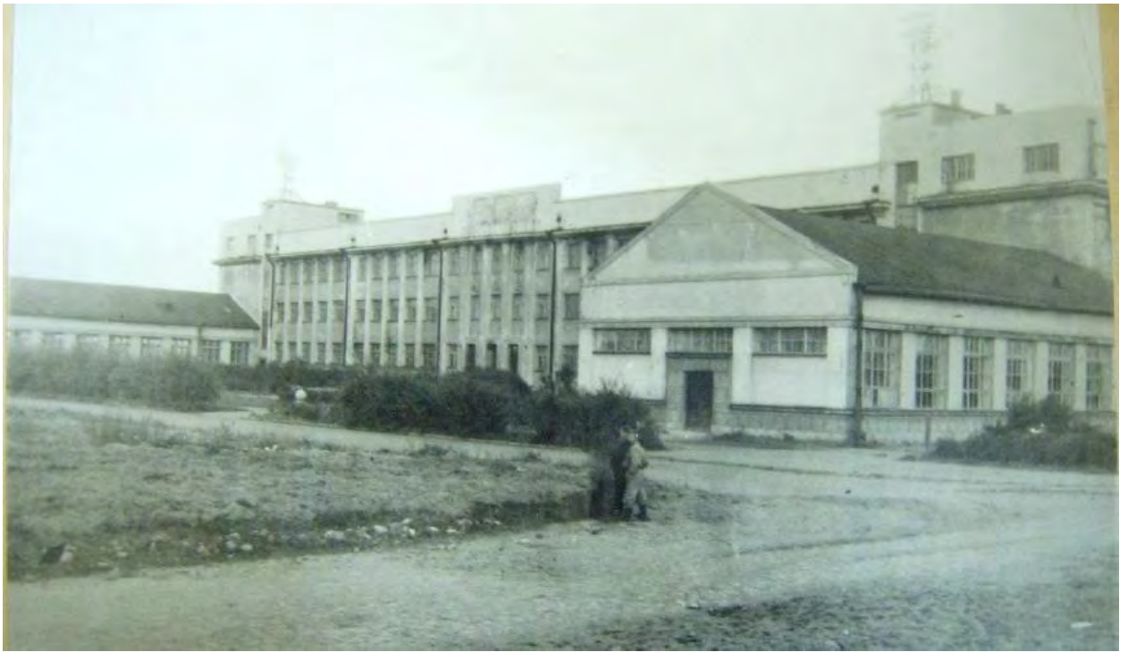
31. ВНИИГ им. Веденеева. Лицевой корпус. Фото 1950-х.гг. По материалам музея ОАО ВНИИГ им. Б.Е. Веденеева
