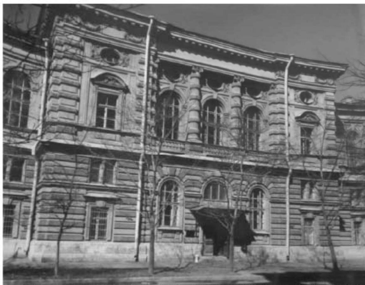
57. Центральное училище технического рисования барона Шеголева (ЛВХПУ им. В.И. Мухомов). Главный фасад здания Училища. 1981 г. // Источник: архив КГИОП. Фотография № 127130/3.
