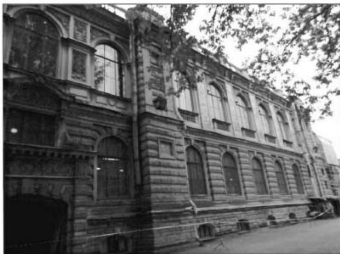
7. Северный дворовый фасад. Общий вид.
