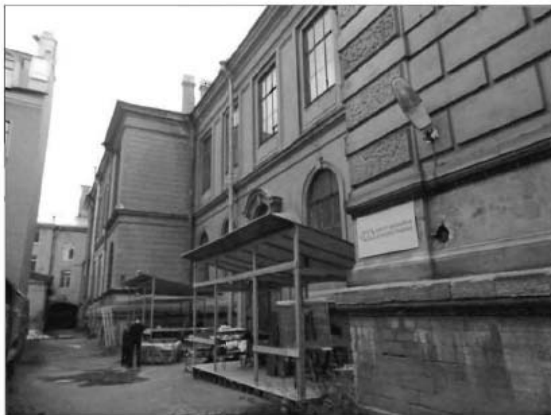
6. Южный дворовый фасад. Общий вид.
