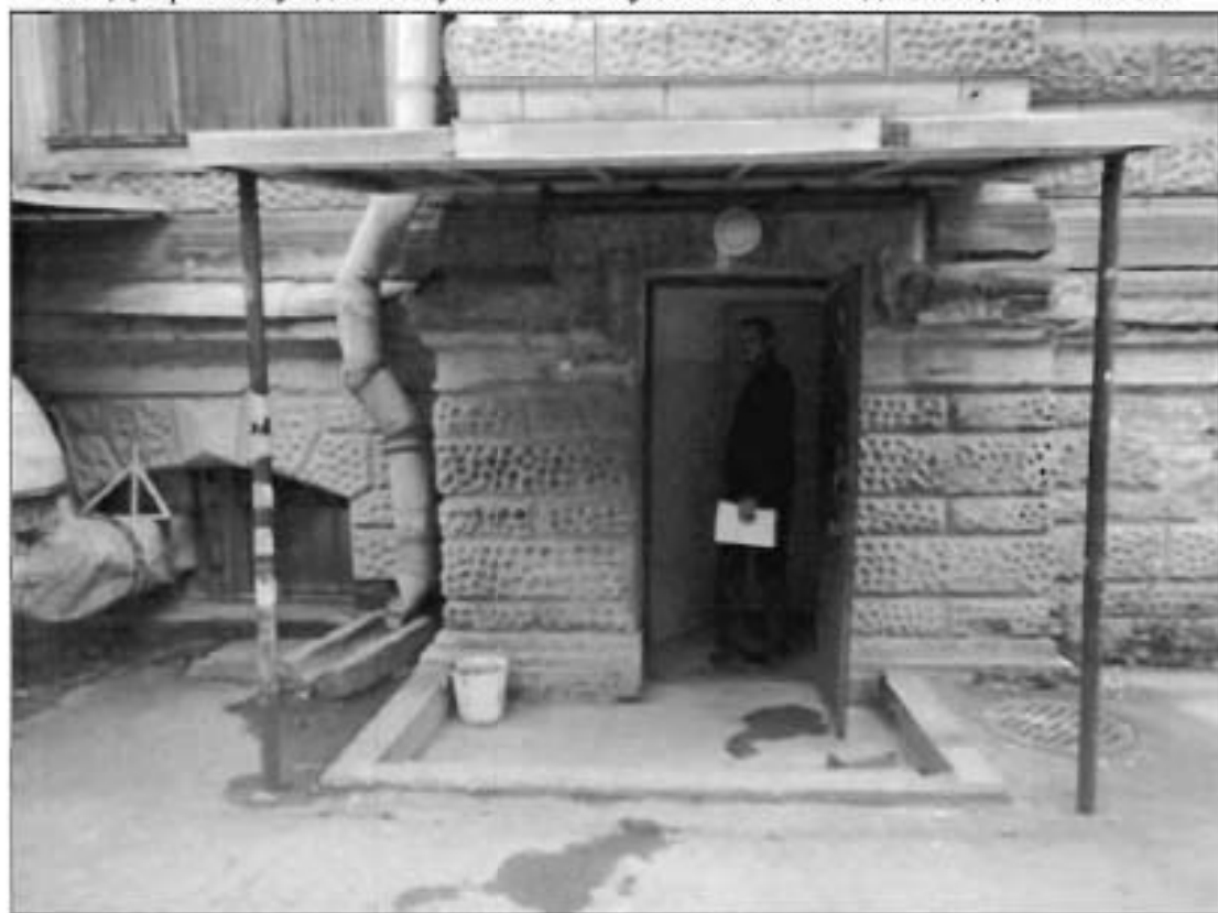
9. Северный дворовый фасад. Фрагмент.
