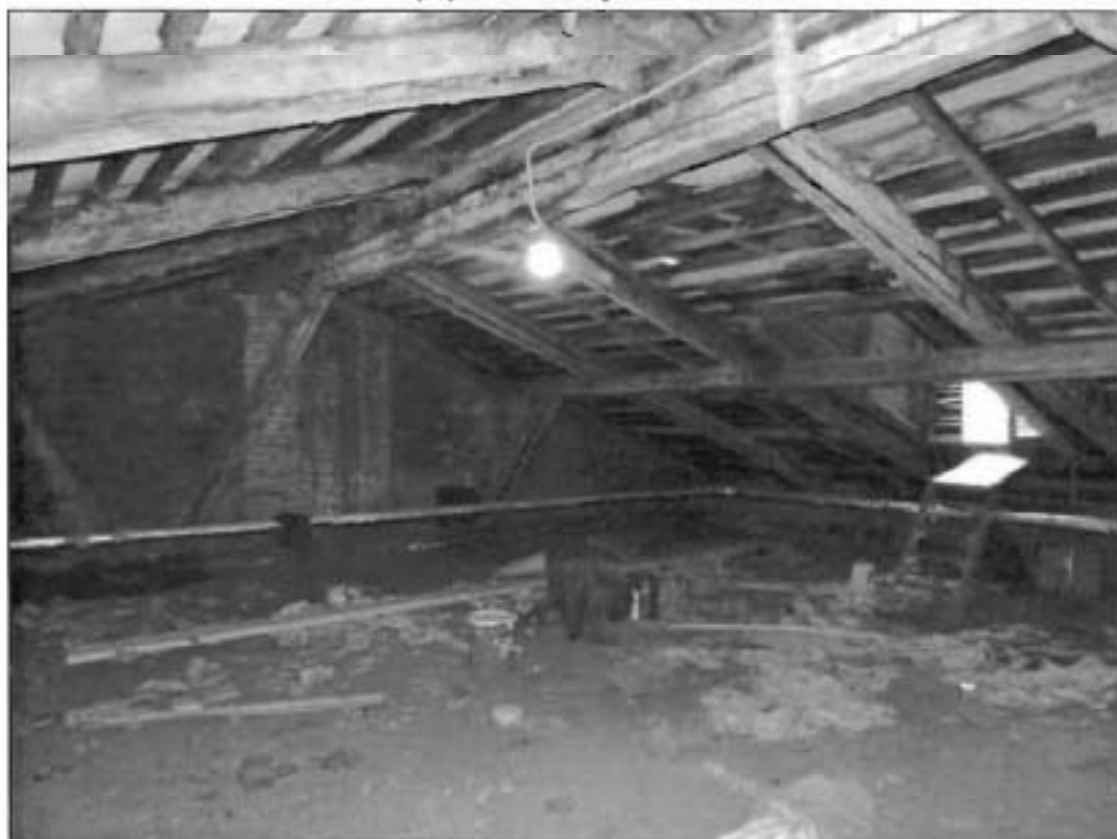
35. Стропильная система. Общий вид.
