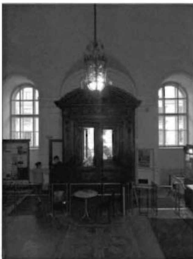
40. Вестибюль. Деревянный тамбур.
