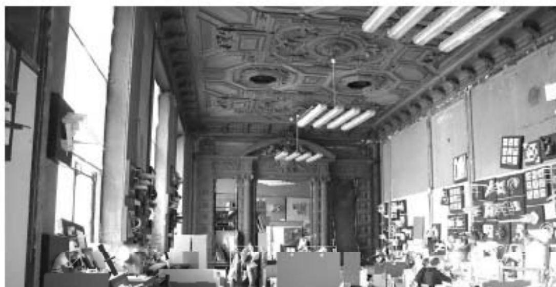
22. Филлиадский зал (помещение 302 по ПИБ). Объект культурного наследия федерального значения «Музей», входящий в состав объекта культурного наследия федерального значения «Центральное училище технического рисования и музей Штиглица А.Л.». Санкт-Петербург, Солжыной переулок, дом 13-15, литера В. Дата съемки: 15.06.2024.
