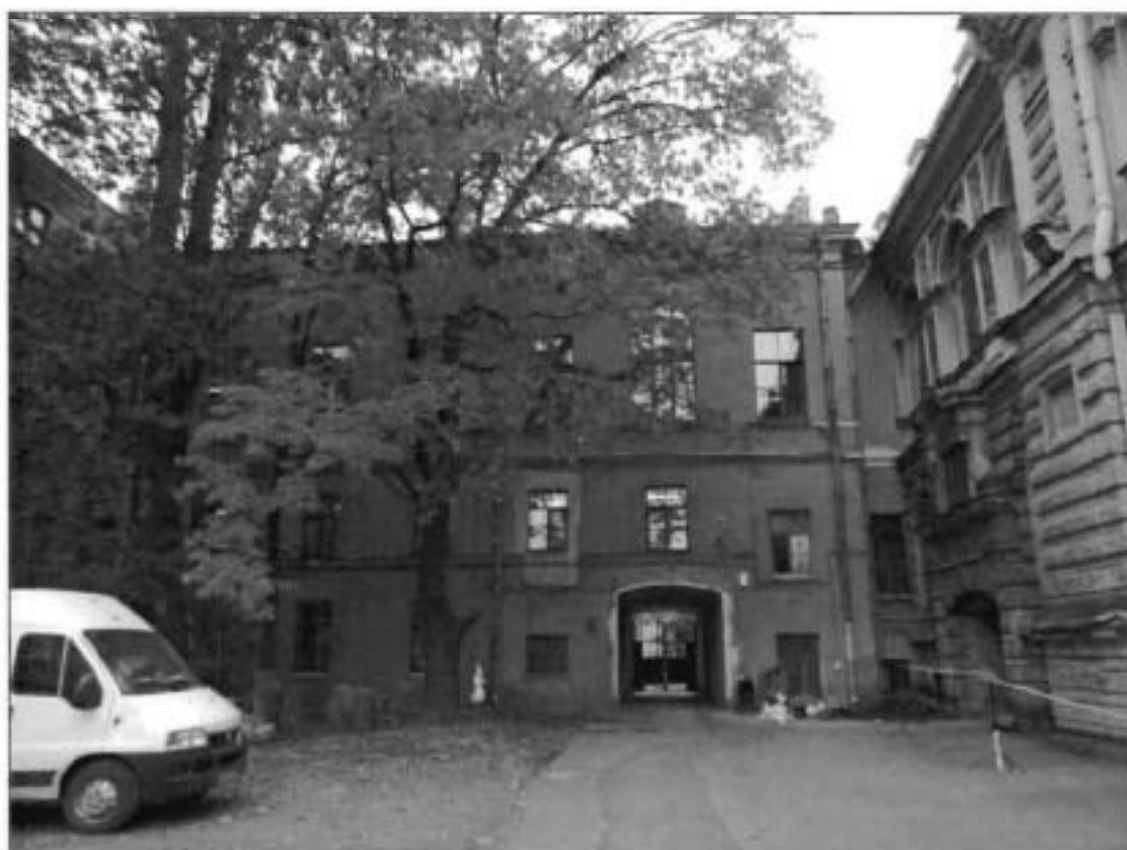
31. Восточный дворовый фасад. Общий вид.
