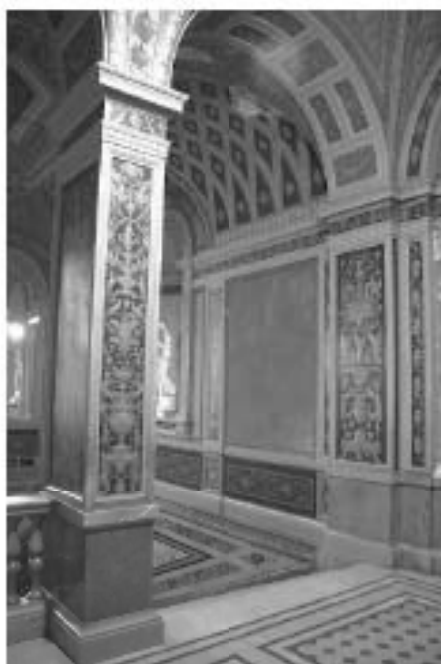
53. Помещение 282 по ПИБ. Объект культурного наследия федерального значения «Музей», входящий в состав объекта культурного наследия федерального значения «Центральное училище технического рисования и музей Штакельбергера А.Д.». Санкт-Петербург, Солтвой переулок, дом 13-15, литера В. Дата съемки: 15.06.2024.
