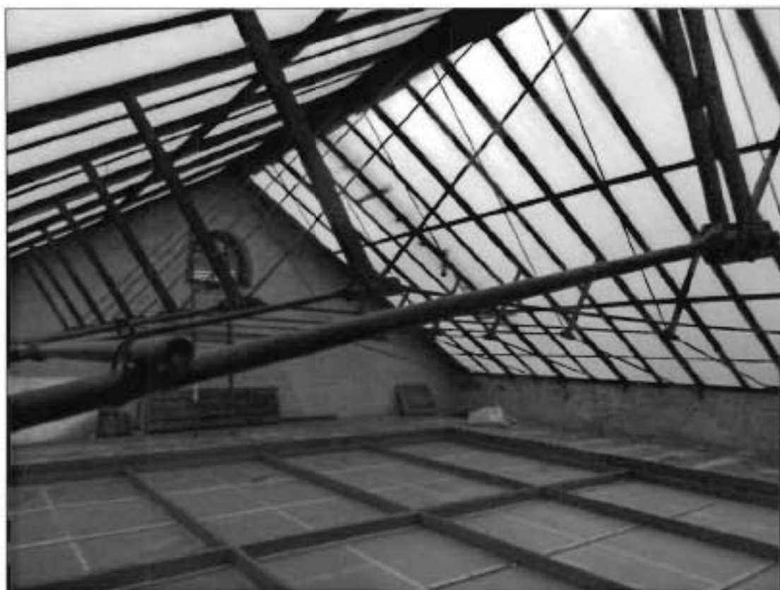
36. Металлические фермы над световым фонарем парадной лестницы.
