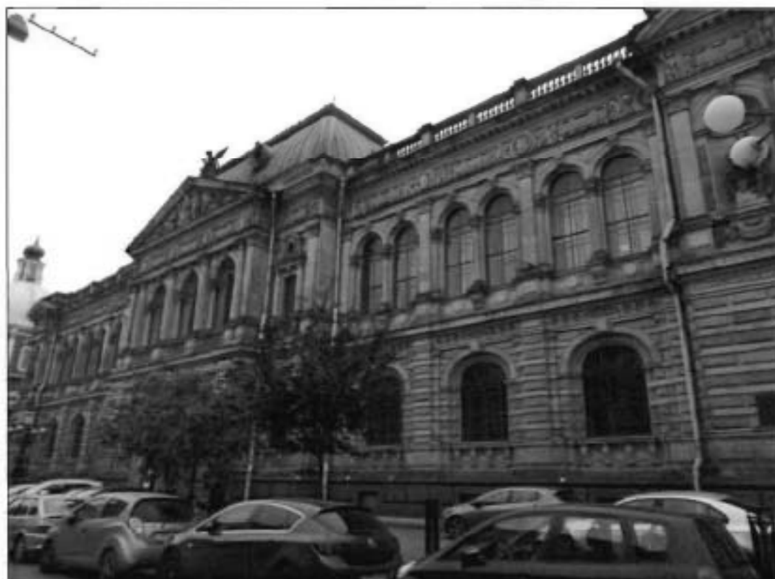
1. Общий вид с северо-востока.
