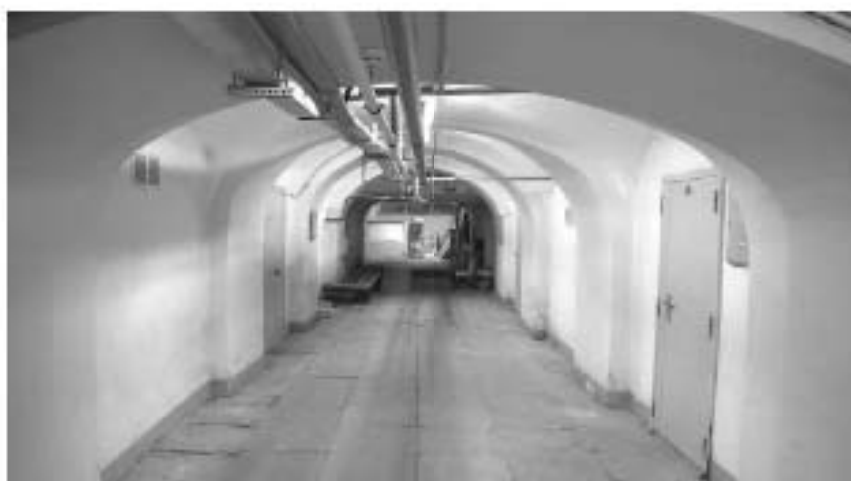
52. Помещение 423 по ПИБ. Объект культурного наследия федерального значения «Музей», входящий в состав объекта культурного наследия федерального значения «Центральное училище технического рисования и музей Штакелца А.Л.». Санкт-Петербург, Солжыной переулок, дом 13-15, литера В. Дата съемки: 15.06.2024.
