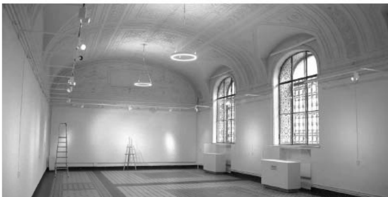
44. Античный зал (помещение 344 по ПИБ). Объект культурного наследия федерального значения «Музей», входящий в состав объекта культурного наследия федерального значения «Центральное училище технического рисования и музей Штакельмана А.Л.». Санкт-Петербург, Солжыной переулок, дом 13-15, литера В. Дата съемки: 15.06.2024.
