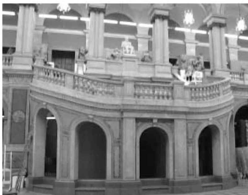
33. Лестница в Большом выставочном зале (помещения 385 по ПИБ). Объект культурного наследия федерального значения «Музей», входящий в состав объекта культурного наследия федерального значения «Центральное училище технического рисования и музей Штиглица А.Л.». Санкт-Петербург, Солжыной переулок, дом 13-15, литера В. Дата съемки: 15.06.2024.
