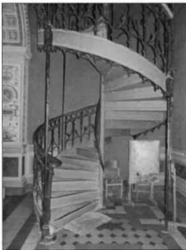
18. Помещение № 1-Н (285). Лестница.
