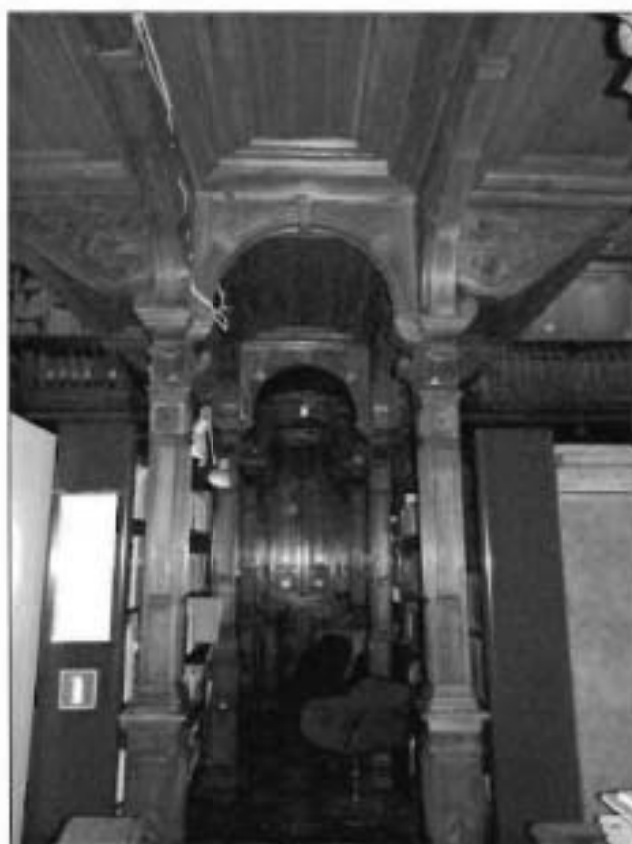
39. Помещение № 1-Н (271), Деревянные колонны.
