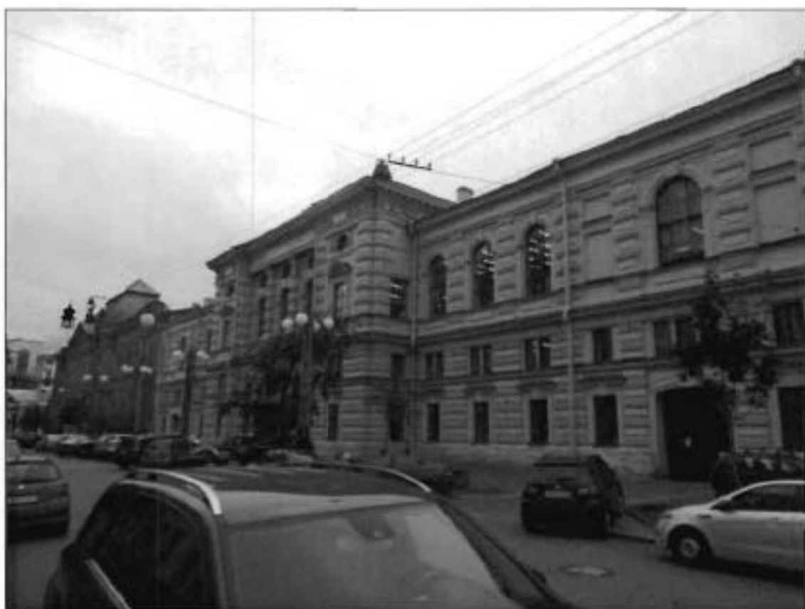
28. Лицевой фасад. Общий вид.
