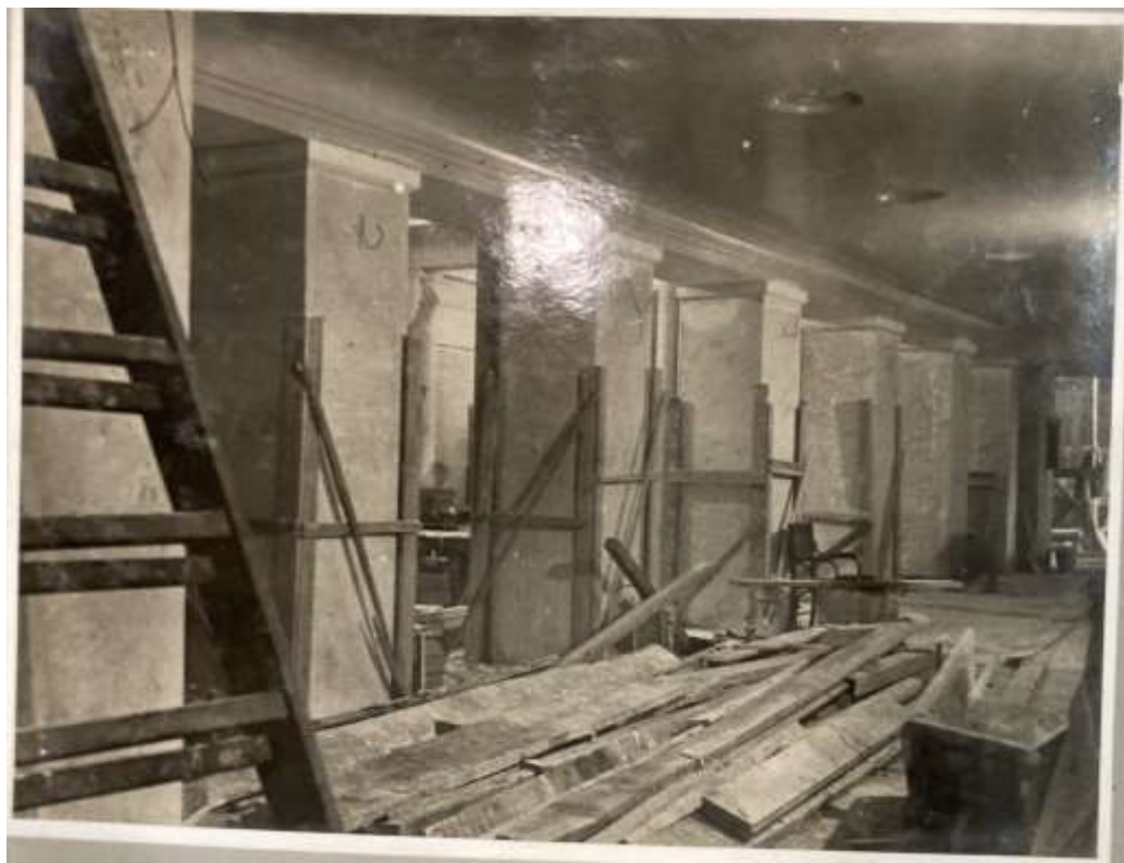
89. Кинотеатр "Аврора". Проход в главное фойе. Начало отделочных работ. 1936-1937 гг. // Альбом «Реконструкция кино-театра «Аврора». 1936-1937». /Материал предоставлен заказчиком/.
