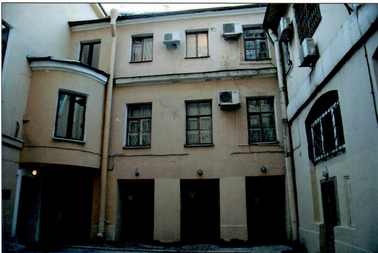
4. Общий вид. Дворовые фасады.
