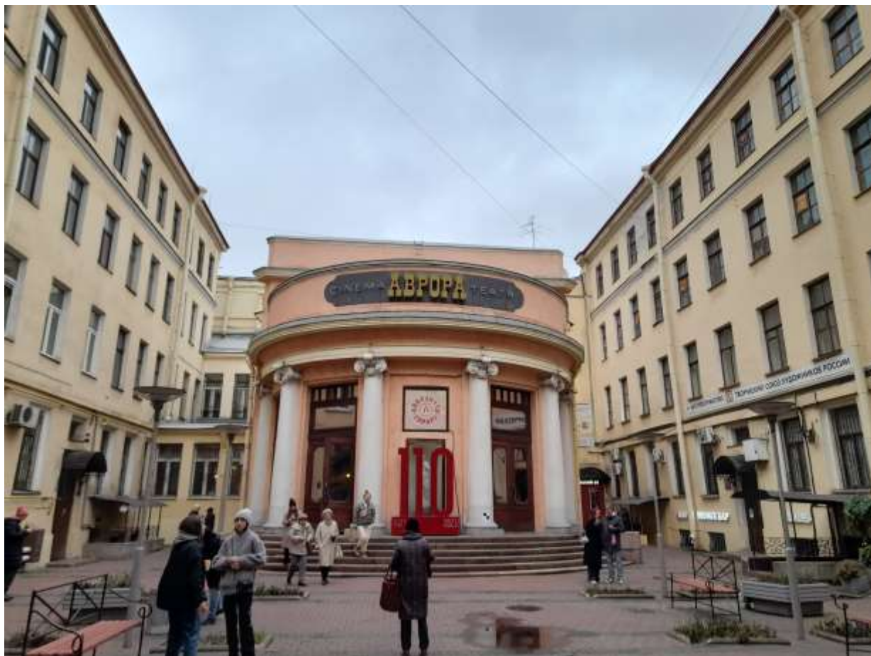
141. Здание по адресу: г. Санкт-Петербург, Невский пр., 60, Литер И. Кинотеатр «Аврора». Южный фасад с входным тамбуром в виде полуротонды. Фото 11.11.2023 г.
