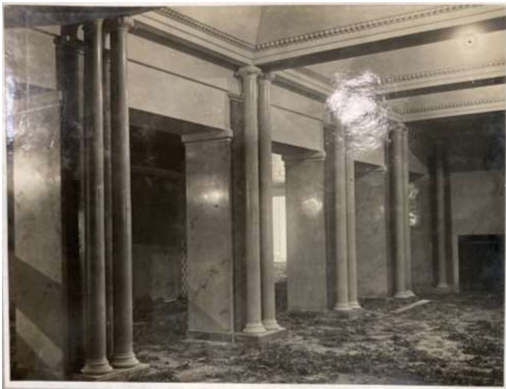
88. Кинотеатр "Аврора". Помещение кафе. Окончание отделочных работ. 1936-1937 гг. // Альбом «Реконструкция кино-театра «Аврора». 1936-1937». /Материал предоставлен заказчиком/.
