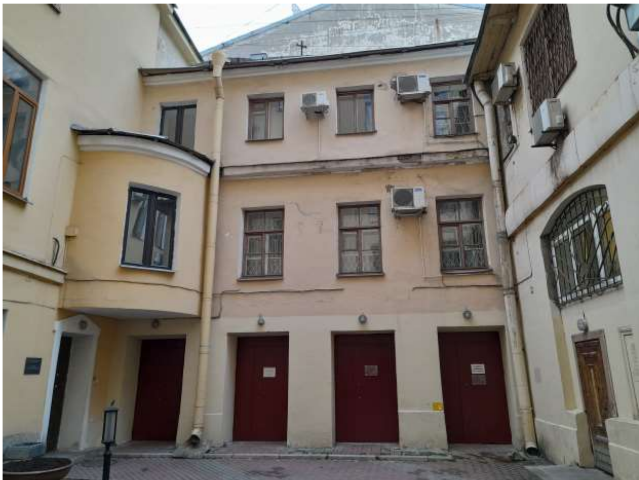
175. Здание по адресу: г. Санкт-Петербург, Караванная ул., 9. Западный дворový флигель. Общий вид с востока. Фото 11.11.2023 г.
