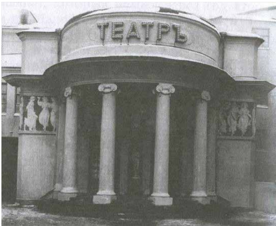
59. Кинематограф «Пикадилли». Вид на главный вход. 1913 г.
