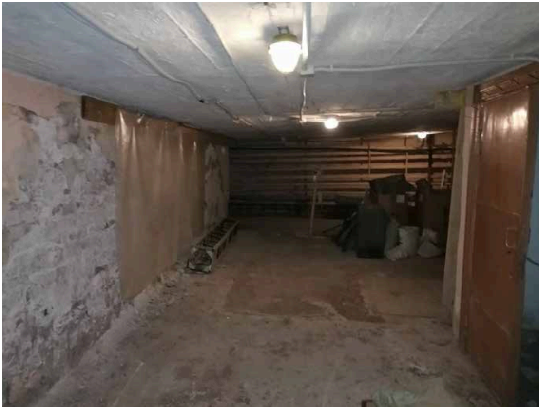
19. Объект культурного наследия регионального значения «Дом Глазуновых» по адресу: Невский пр., д. 60, лит. И. Помещение. Дата съемки: 12.08.2024 г.
