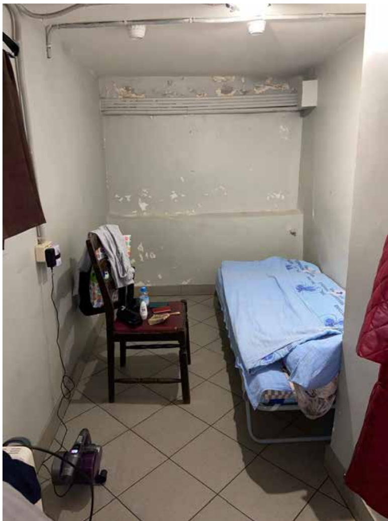
17. Объект культурного наследия регионального значения «Дом Глазуновых» по адресу: Невский пр., д. 60, лит. И. Помещение. Дата съемки: 12.08.2024 г.
