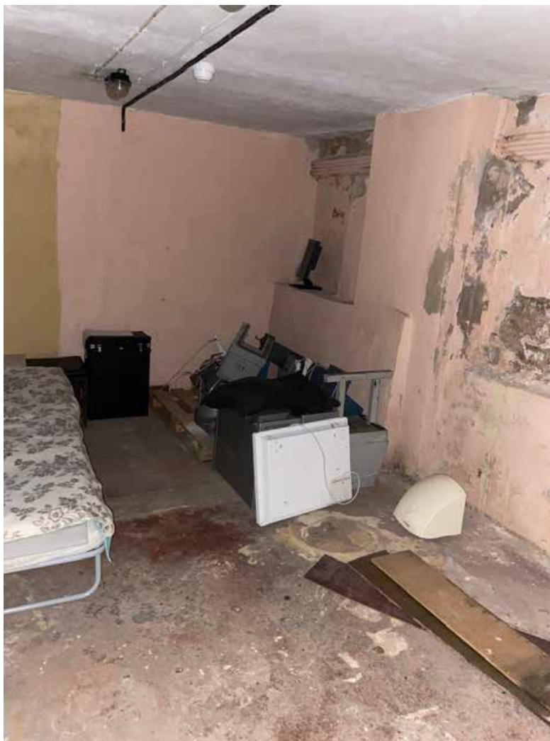
16. Объект культурного наследия регионального значения «Дом Глазуновых» по адресу: Невский пр., д. 60, лит. И. Помещение. Дата съемки: 12.08.2024 г.
