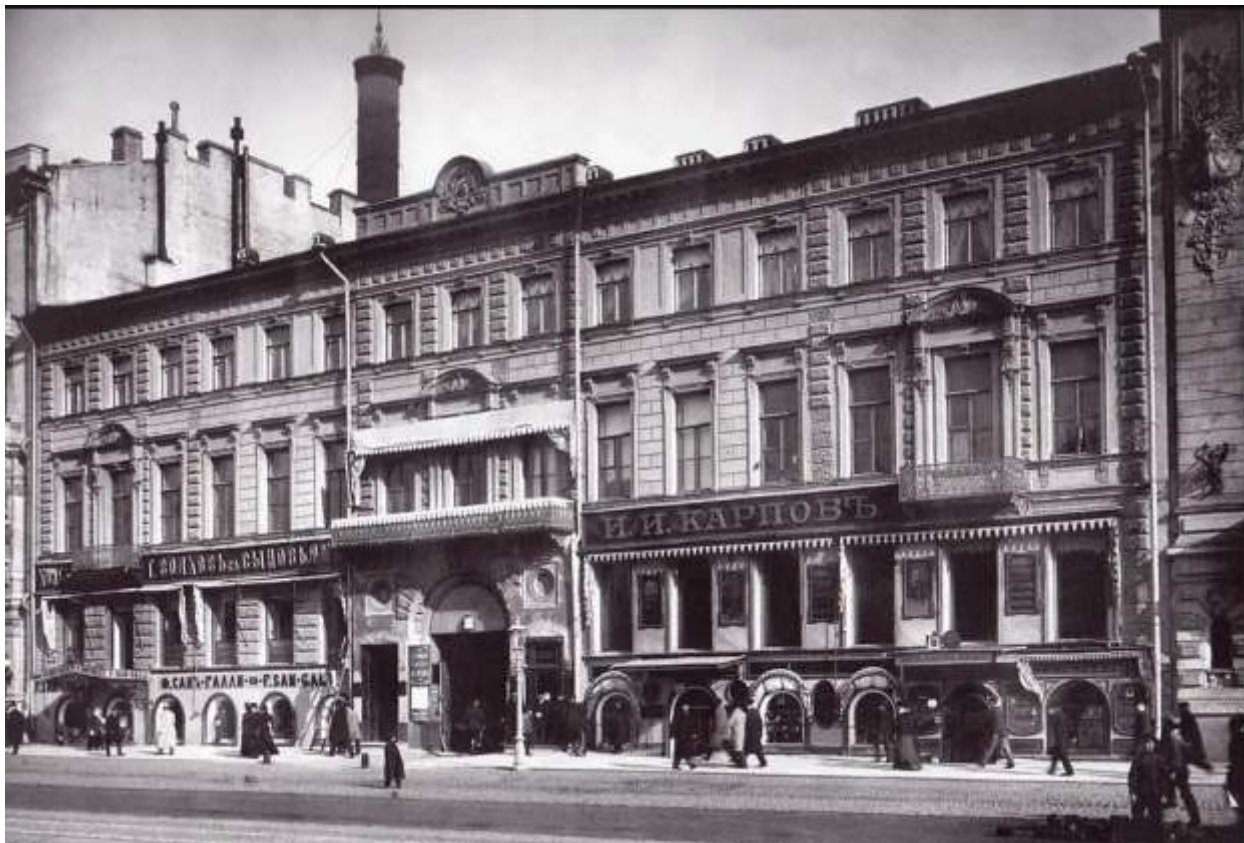
42. Фасад дома № 60 по Невскому проспекту. Автор съёмки: Фотография ателье Буллы. 1900 г. // ЦГАКФФД СПб. Е 14674.
