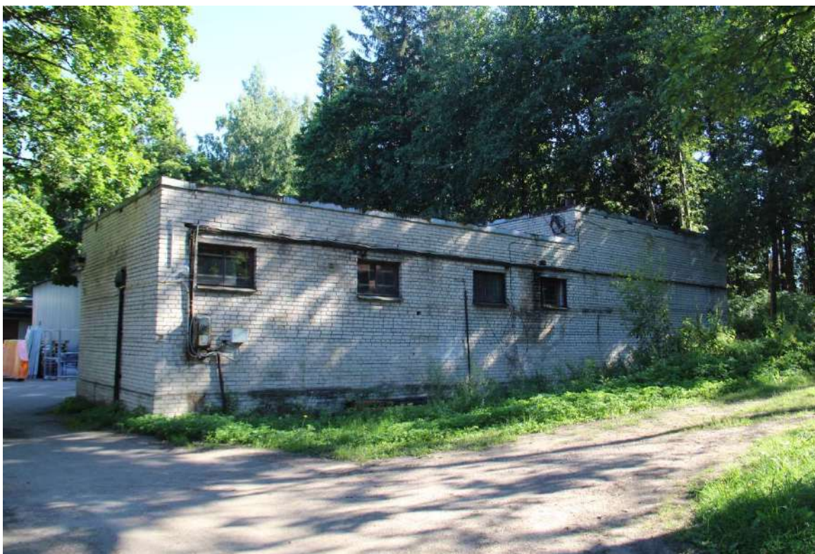
15. Объект культурного наследия федерального значения «Парк Шуваловский с двенадцатью прудами и гидросооружениями», входящий в состав объекта культурного наследия «Усадьба Шуваловых (Воронцовой-Дашковой Е.А.) «Парголово» по адресу: Санкт-Петербург, посёлок Парголово, Шуваловский парк.
