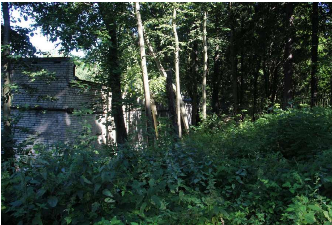
16. Объект культурного наследия федерального значения «Парк Шуваловский с двенадцатью прудами и гидросооружениями», входящий в состав объекта культурного наследия «Усадьба Шуваловых (Воронцовой-Дашковой Е.А.) «Парголово» по адресу: Санкт-Петербург, посёлок Парголово, Шуваловский парк.
