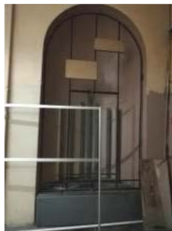
вестибюль при входе с северной стороны
