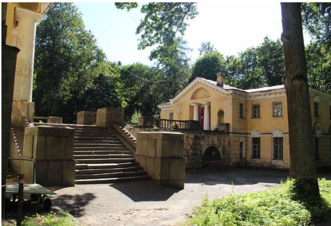
35. Объект культурного наследия федерального значения «Парк Шуваловский с двенадцатью прудами и гидросооружениями», входящий в состав объекта культурного наследия «Усадьба Шуваловых (Воронцовой-Дашковой Е.А.) «Парголово» по адресу: Санкт-Петербург, посёлок Парголово, Шуваловский парк.
