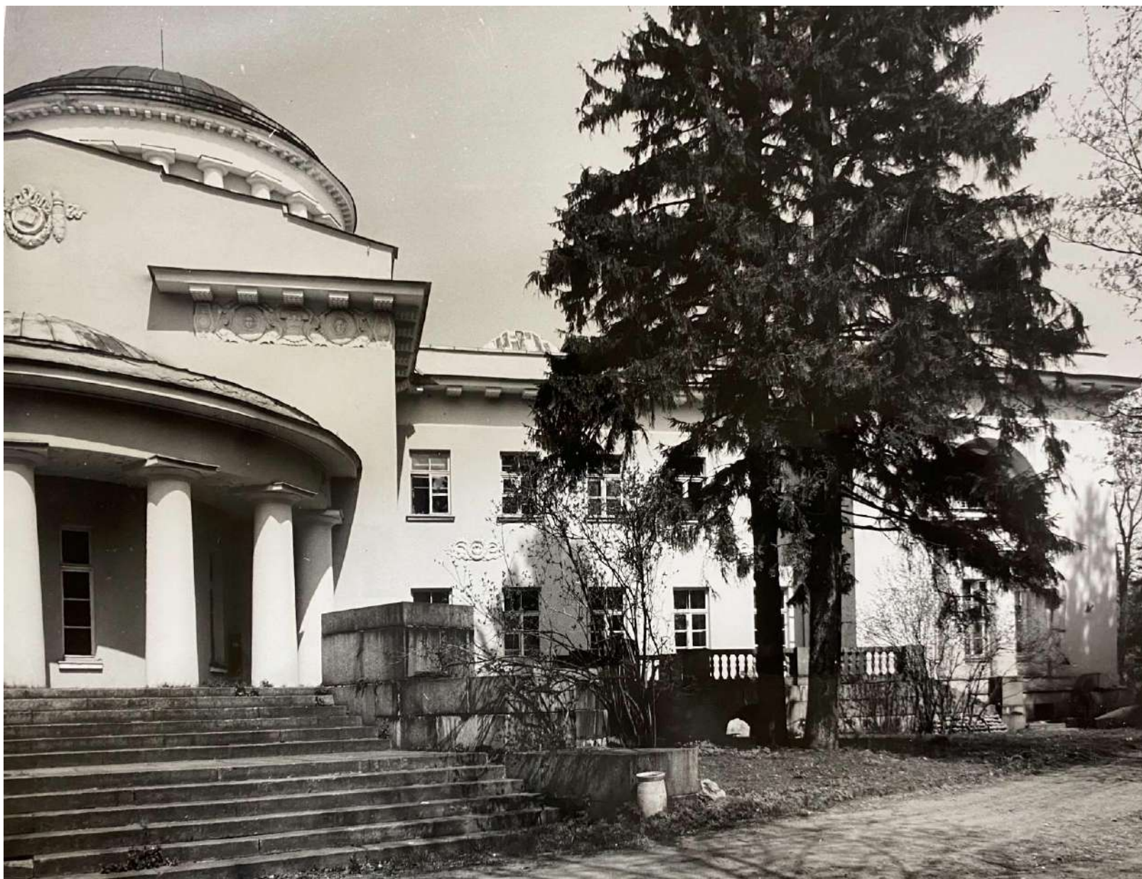
55. Ансамбль усадьбы Шуваловых (Е.А. Воронцовой-Дашковой). Большой дворец. Южный фасад. Фрагмент. Дата: 1985 г. Автор: В.И. Шлакан // Архив КГИОП, № 55302/1-Н.
