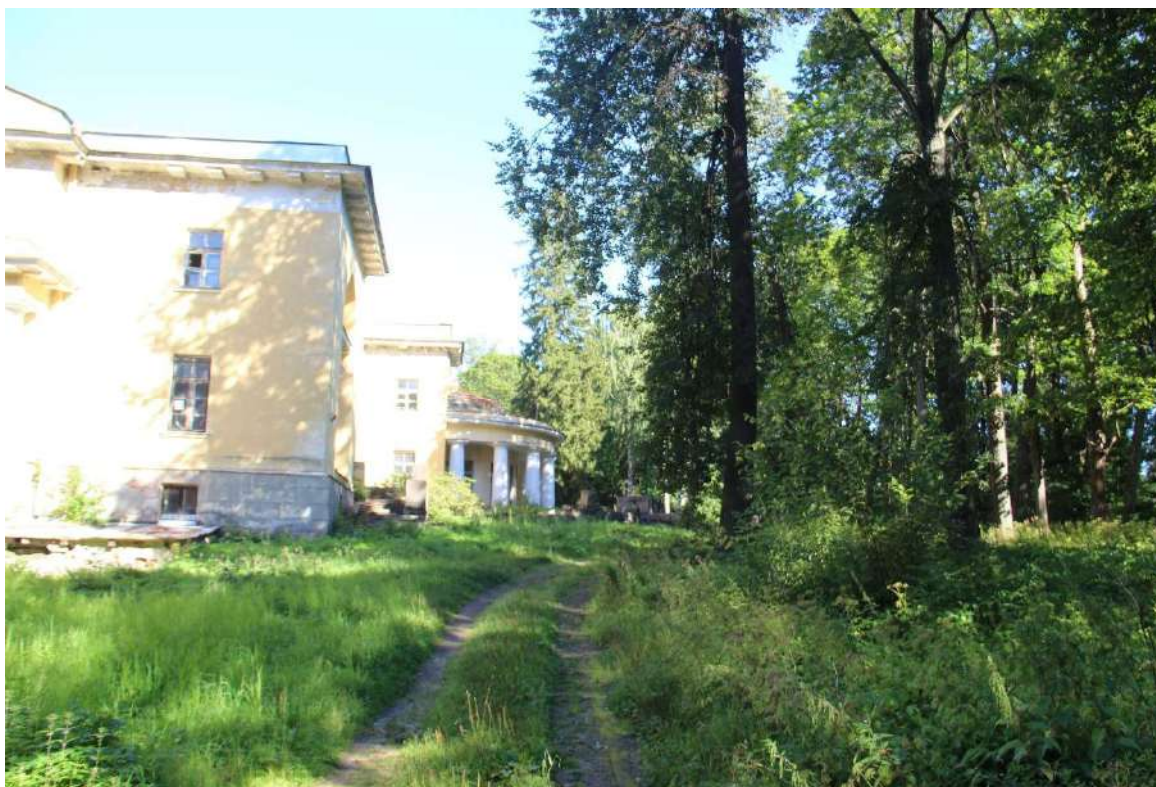
39. Объект культурного наследия федерального значения «Парк Шуваловский с двенадцатью прудами и гидросооружениями», входящий в состав объекта культурного наследия «Усадьба Шуваловых (Воронцовой-Дашковой Е.А.) «Парголово» по адресу: Санкт-Петербург, посёлок Парголово, Шуваловский парк.
