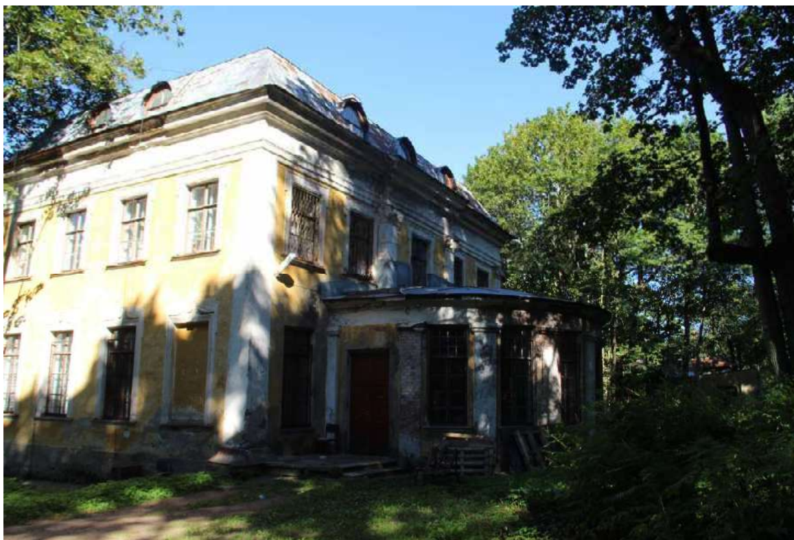
25. Объект культурного наследия федерального значения «Парк Шуваловский с двенадцатью прудами и гидросооружениями», входящий в состав объекта культурного наследия «Усадьба Шуваловых (Воронцовой-Дашковой Е.А.) «Парголово» по адресу: Санкт-Петербург, посёлок Парголово, Шуваловский парк.
