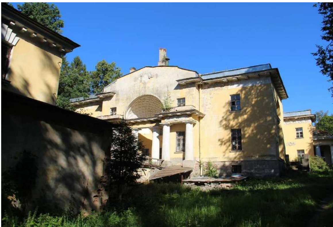
37. Объект культурного наследия федерального значения «Парк Шуваловский с двенадцатью прудами и гидросооружениями», входящий в состав объекта культурного наследия «Усадьба Шуваловых (Воронцовой-Дашковой Е.А.) «Парголово» по адресу: Санкт-Петербург, посёлок Парголово, Шуваловский парк.
