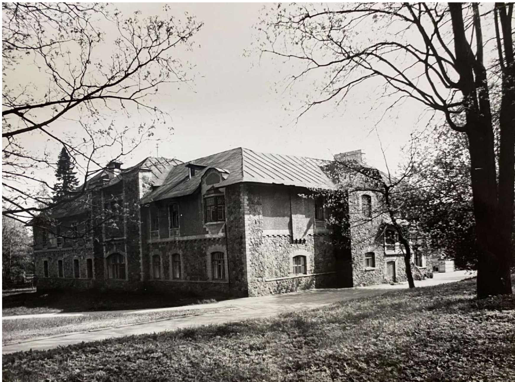
124. Ансамбль усадьбы Щуваловых. Ферма. Общий вид с юго-запада. Дата: 1985 г. Автор: В.И. Шлакан // Архив КГИОП, № 55341.
