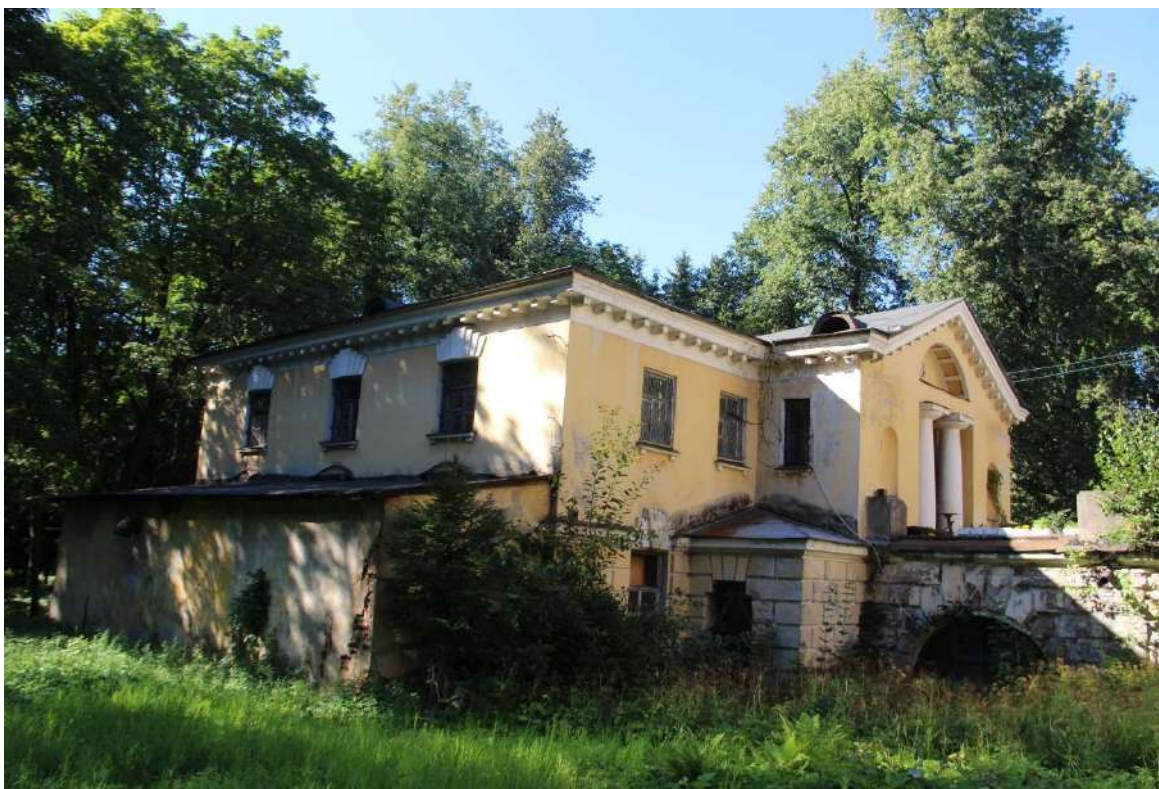
36. Объект культурного наследия федерального значения «Парк Шуваловский с двенадцатью прудами и гидросооружениями», входящий в состав объекта культурного наследия «Усадьба Шуваловых (Воронцовой-Дашковой Е.А.) «Парголово» по адресу: Санкт-Петербург, посёлок Парголово, Шуваловский парк.
