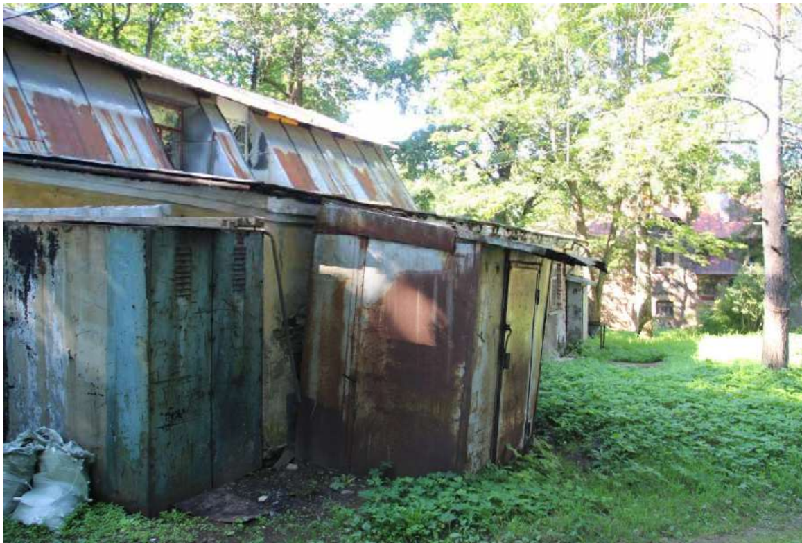
21. Объект культурного наследия федерального значения «Парк Шуваловский с двенадцатью прудами и гидросооружениями», входящий в состав объекта культурного наследия «Усадьба Шуваловых (Воронцовой-Дашковой Е.А.) «Парголово» по адресу: Санкт-Петербург, посёлок Парголово, Шуваловский парк.
