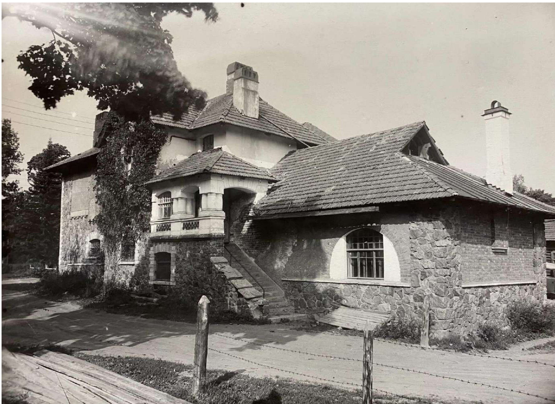
119. Шуваловский парк. Ферма. Южный фасад. Дата: 1953 г. // Архив КГИОП, № 45208.
