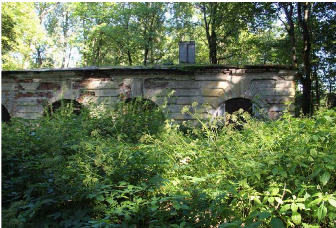
45. Объект культурного наследия федерального значения «Парк Шуваловский с двенадцатью прудами и гидросооружениями», входящий в состав объекта культурного наследия «Усадьба Шуваловых (Воронцовой-Дашковой Е.А.) «Парголово» по адресу: Санкт-Петербург, посёлок Парголово, Шуваловский парк.
