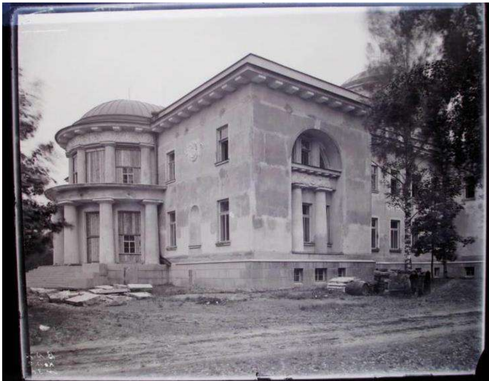
25. Усадьба Лигово. Главный дом. СПб, Красносельский р-н, Урицк, кон. XVIII в. г. Санкт-Петербург (Ленинград), Красносельский р-н, Урицк (населенный пункт, вошедший в город). Усадьба Лигово. Главный дом. Передний фасад. Дата: 1900-1905 гг. // https://goskatalog.ru/portal/#/collections?id=14207058 . Номер в Госкаталоге: 14088266.
