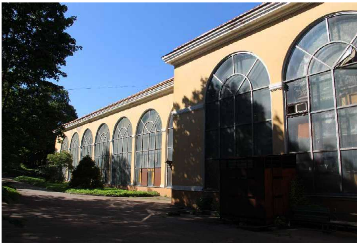
10. Объект культурного наследия федерального значения «Парк Шуваловский с двенадцатью прудами и гидросооружениями», входящий в состав объекта культурного наследия «Усадьба Шуваловых (Воронцовой-Дашковой Е.А.) «Парголово» по адресу: Санкт-Петербург, посёлок Парголово, Шуваловский парк.
