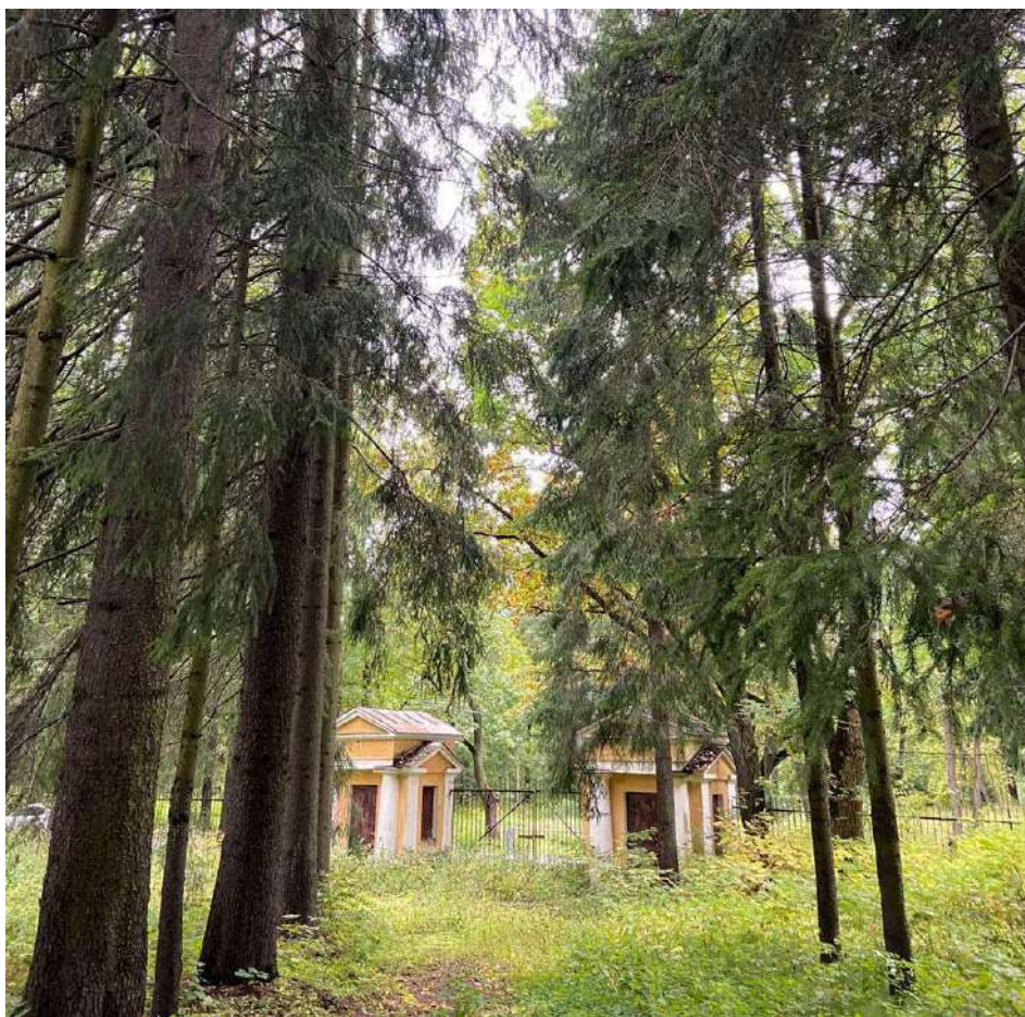
46. Объект культурного наследия федерального значения «Парк Шуваловский с двенадцатью прудами и гидросооружениями», входящий в состав объекта культурного наследия «Усадьба Шуваловых (Воронцовой-Дашковой Е.А.) «Парголово» по адресу: Санкт-Петербург, посёлок Парголово, Шуваловский парк.
