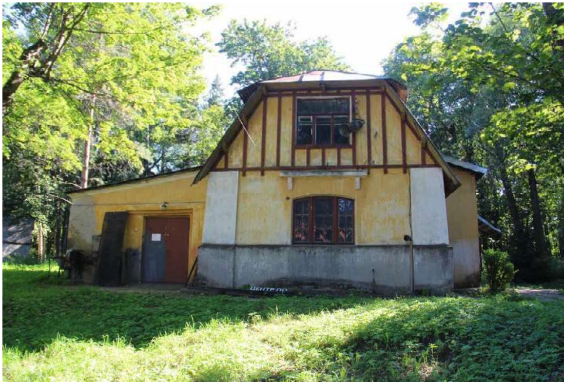
20. Объект культурного наследия федерального значения «Парк Шуваловский с двенадцатью прудами и гидросооружениями», входящий в состав объекта культурного наследия «Усадьба Шуваловых (Воронцовой-Дашковой Е.А.) «Парголово» по адресу: Санкт-Петербург, посёлок Парголово, Шуваловский парк.
