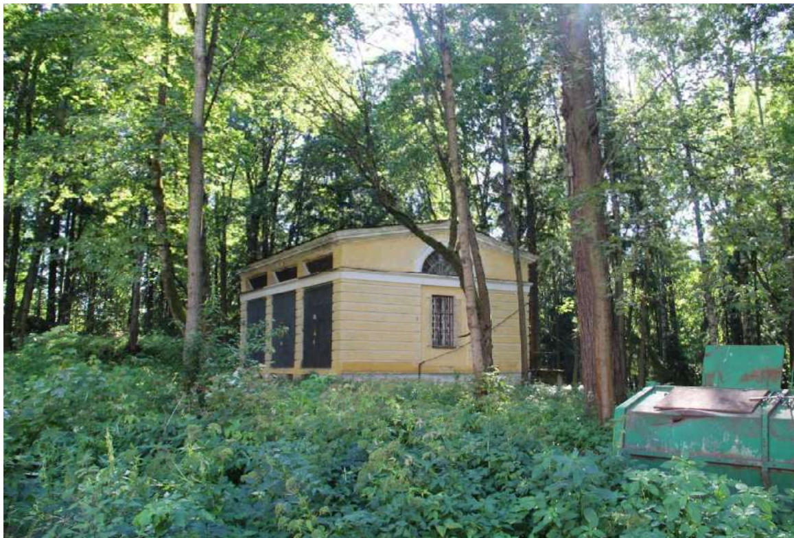
42. Объект культурного наследия федерального значения «Парк Шуваловский с двенадцатью прудами и гидросооружениями», входящий в состав объекта культурного наследия «Усадьба Шуваловых (Воронцовой-Дашковой Е.А.) «Парголово» по адресу: Санкт-Петербург, посёлок Парголово, Шуваловский парк.
