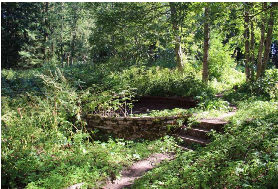
12. Объект культурного наследия федерального значения «Парк Шуваловский с двенадцатью прудами и гидросооружениями», входящий в состав объекта культурного наследия «Усадьба Шуваловых (Воронцовой-Дашковой Е.А.) «Парголово» по адресу: Санкт-Петербург, посёлок Парголово, Шуваловский парк.
