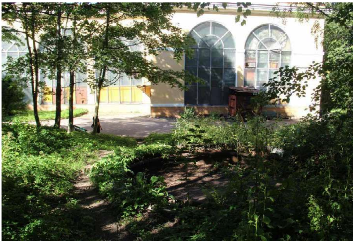
11. Объект культурного наследия федерального значения «Парк Шуваловский с двенадцатью прудами и гидросооружениями», входящий в состав объекта культурного наследия «Усадьба Шуваловых (Воронцовой-Дашковой Е.А.) «Парголово» по адресу: Санкт-Петербург, посёлок Парголово, Шуваловский парк.
