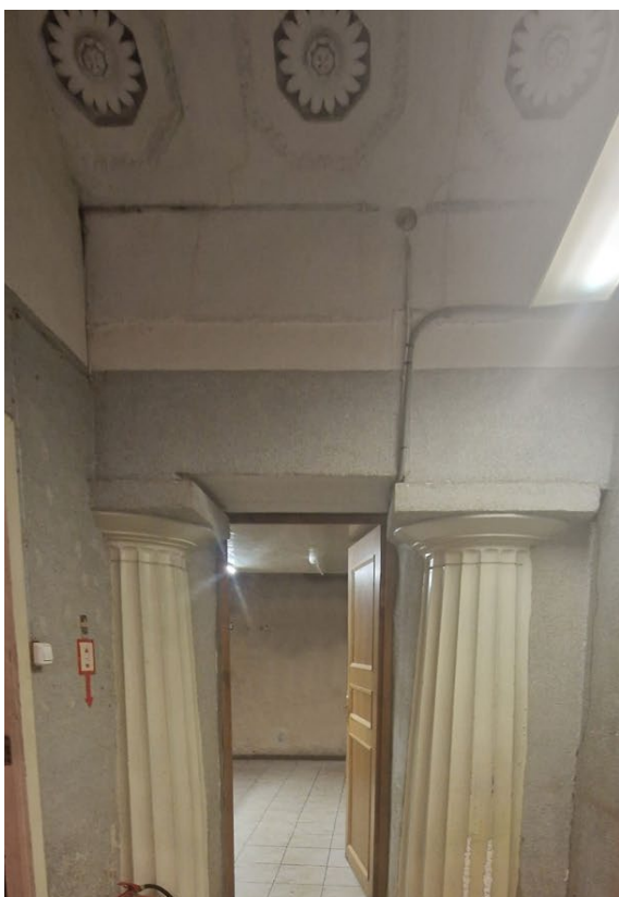
Фото 2. Общий вид помещения
