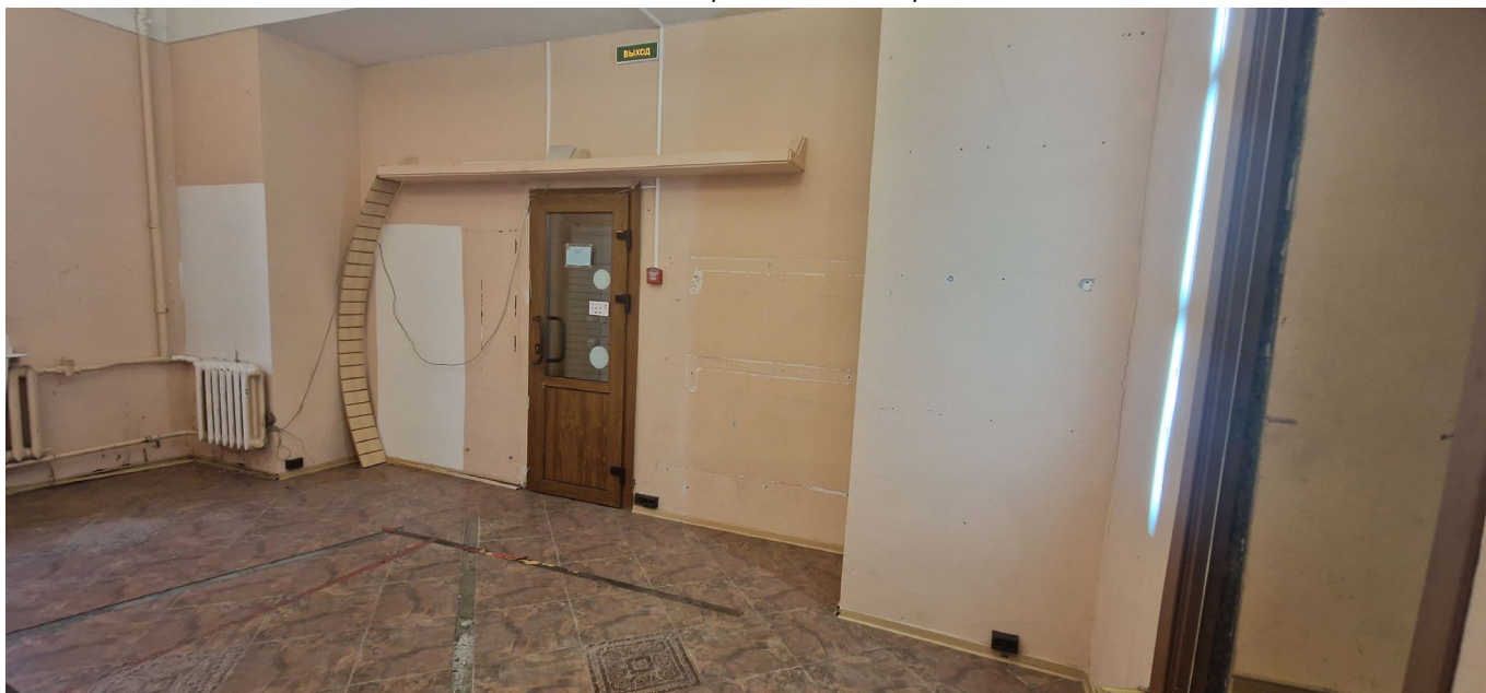
Фото 41. Общий вид помещения
