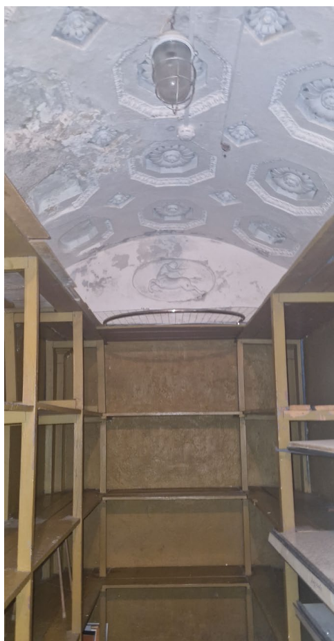
Фото 16. Фрагмент помещения. Вид на потолок.
