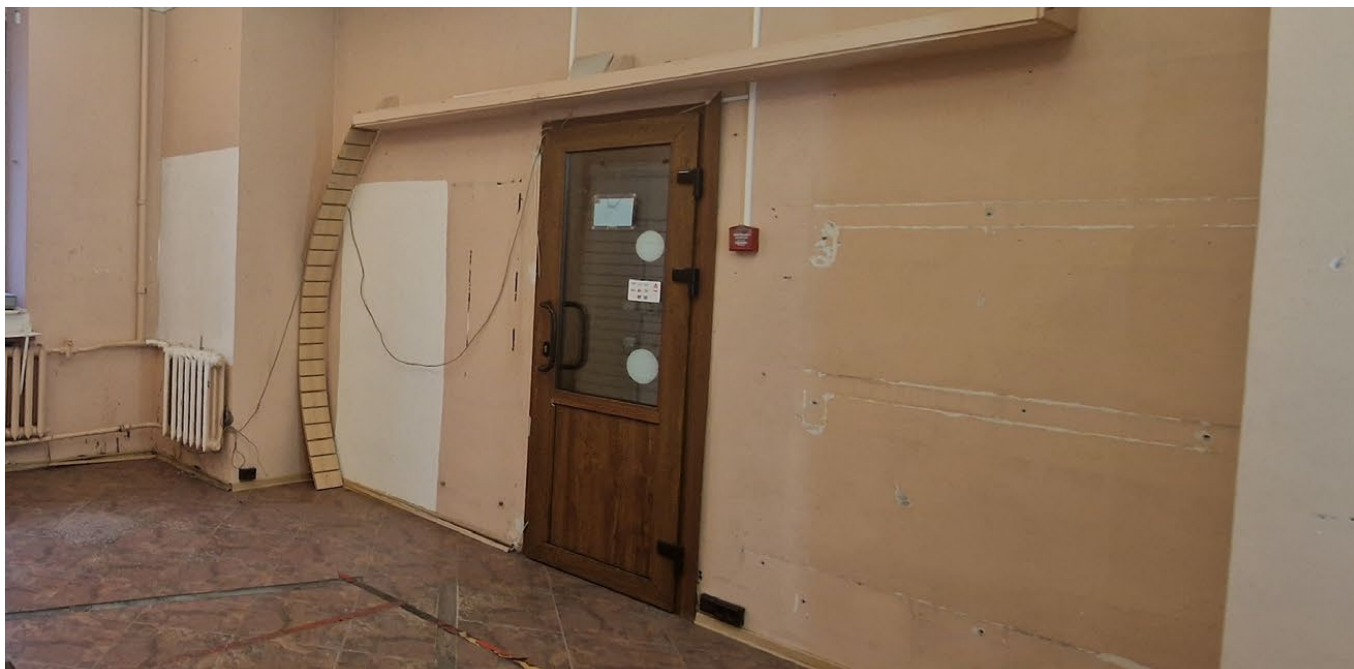
Фото 40. Общий вид помещения
