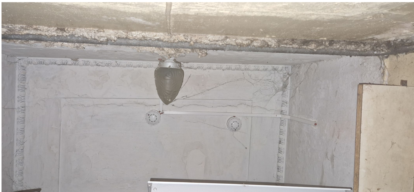
Фото 27. Фрагмент потолка помещения
