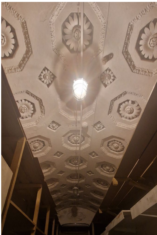
Фото 11. Общий вид помещения
