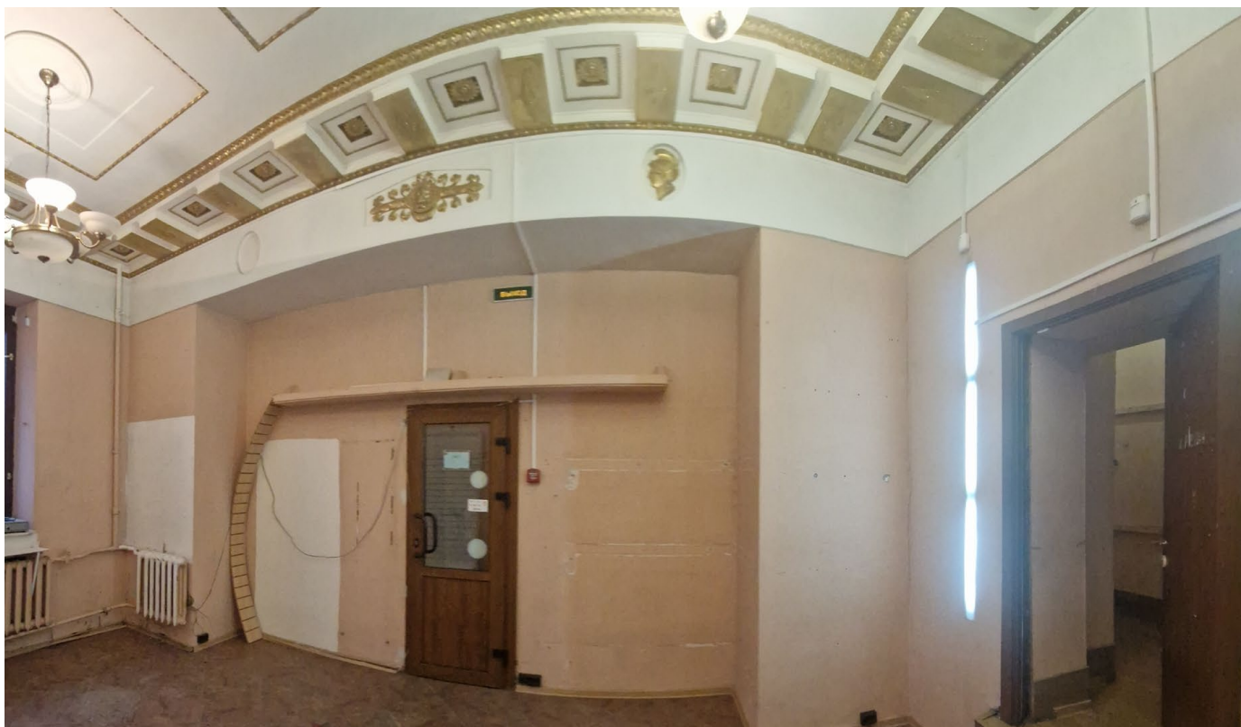
Фото 43. Общий вид помещения
