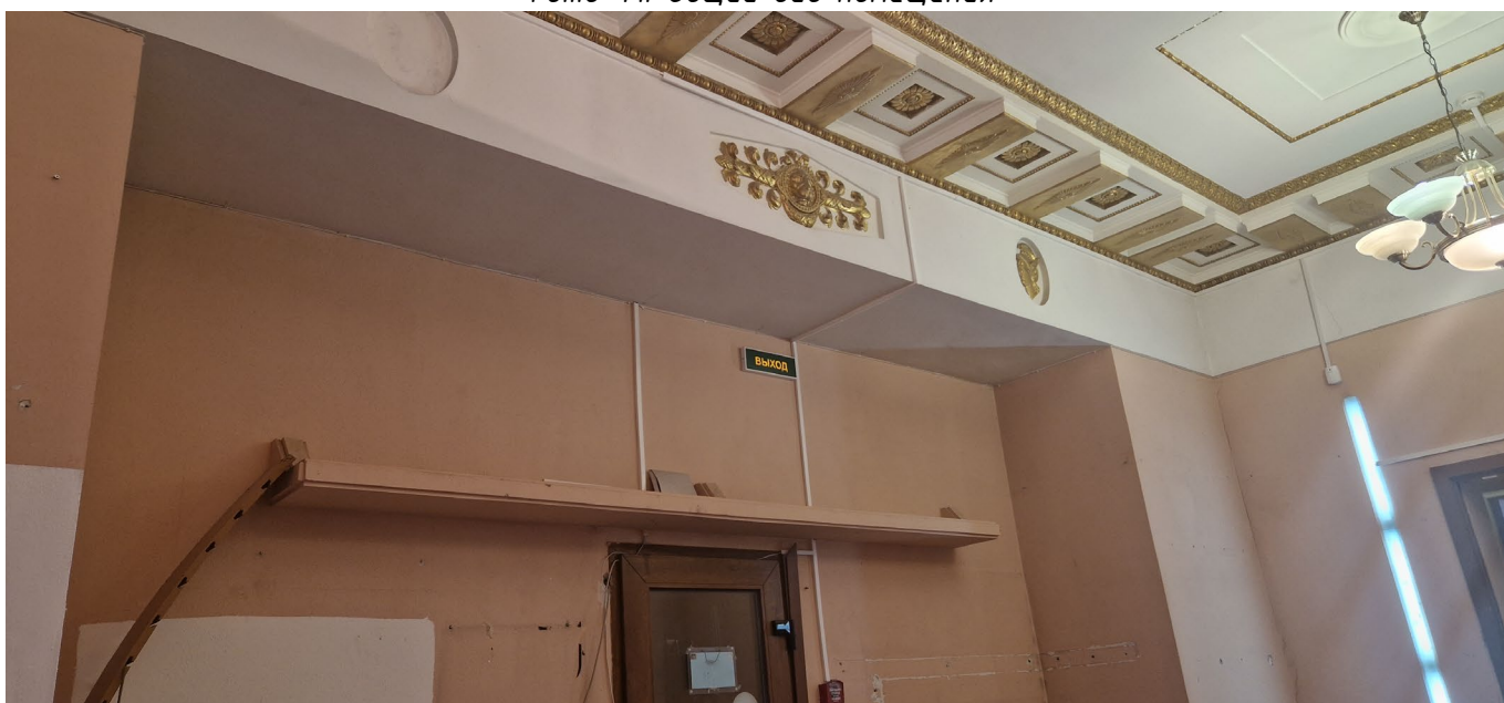
Фото 42. Общий вид помещения
