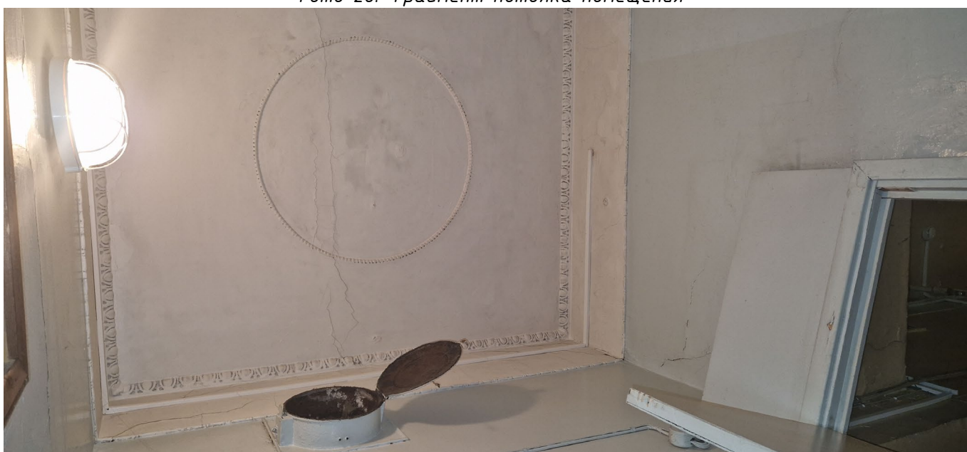
Фото 29. Фрагмент потолка помещения
