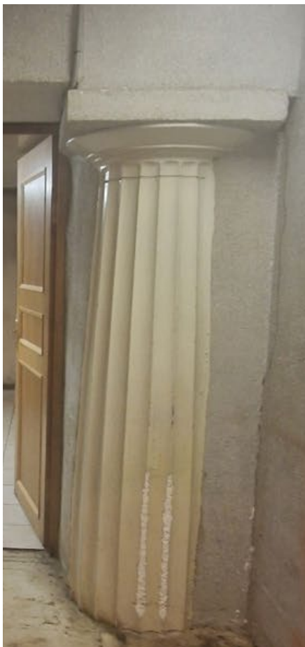
Фото 1. Общий вид помещения
