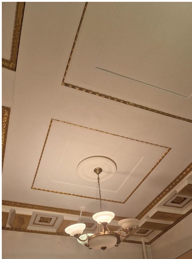
Фото 53. Фрагмент потолка помещения
