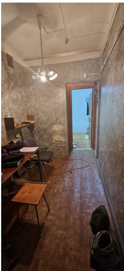
Фото 4. Общий вид помещения
