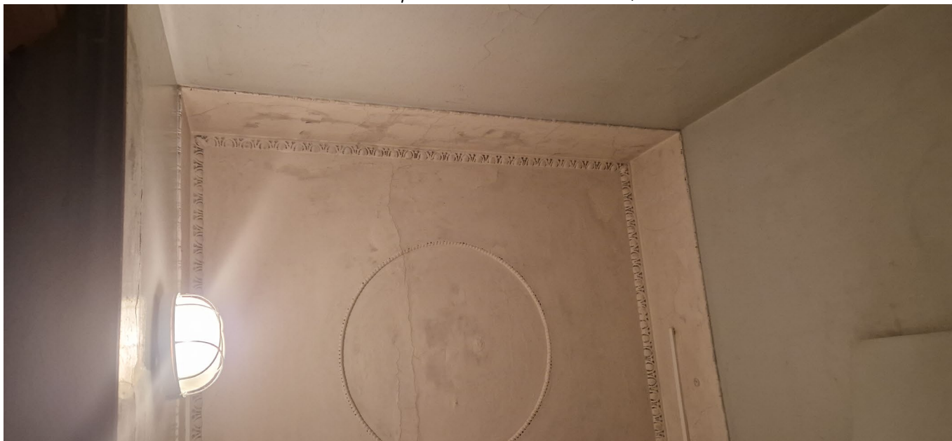
Фото 28. Фрагмент потолка помещения
