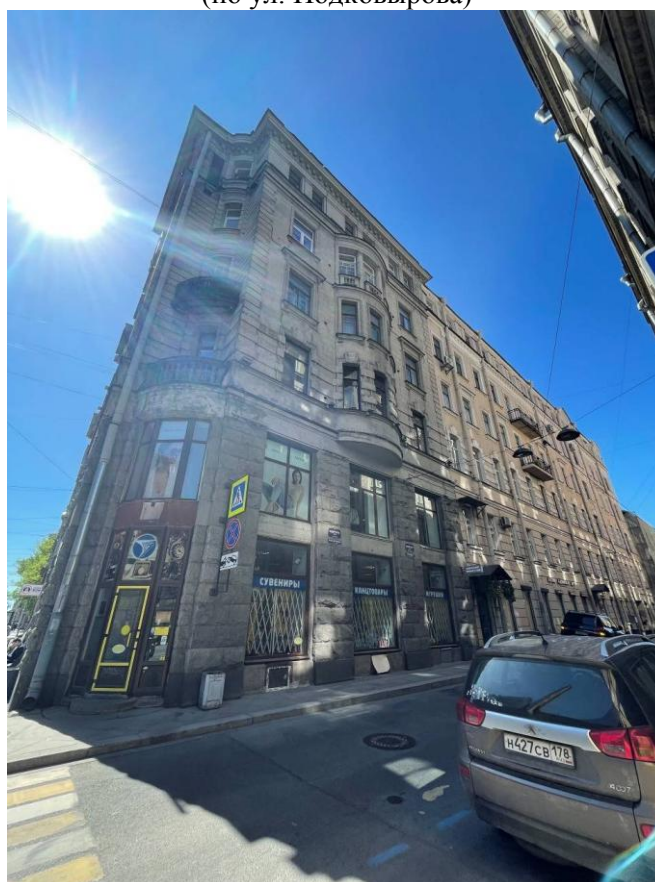
Фото 4. Лицевой фасад выявленного объекта культурного наследия «Дом Ф.Ф. Утемана» (угол Большого пр. П.С. и ул. Подрезова)
