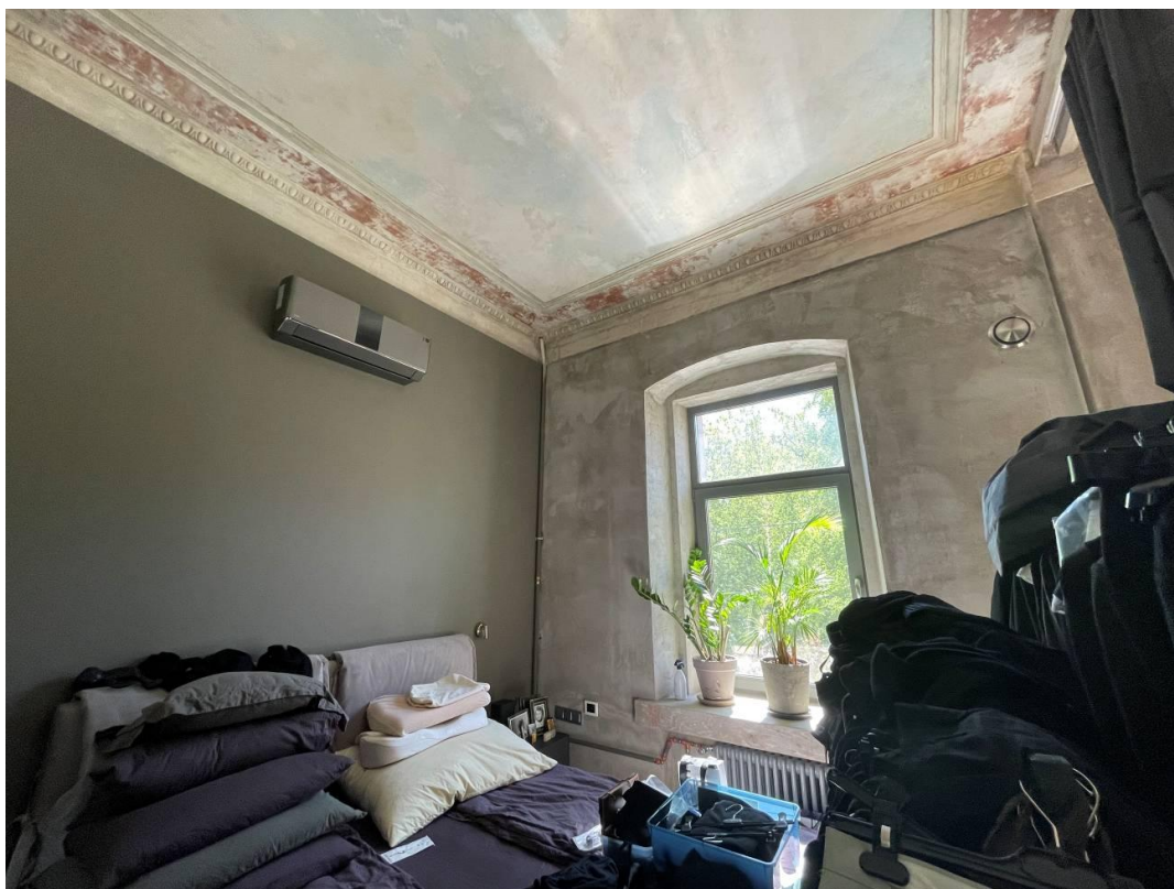
Фото 23. Интерьер квартиры № 65 выявленного объекта культурного наследия «Дом Ф.Ф. Утемана»
