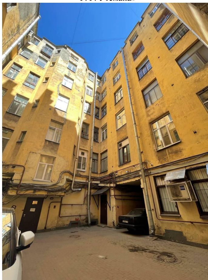
Фото 10. Фрагмент дворового фасада выявленного объекта культурного наследия «Дом Ф.Ф. Утемана»
