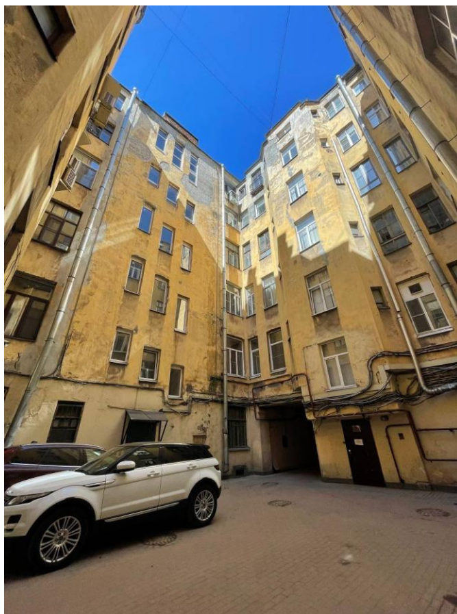
Фото 9. Фрагмент дворового фасада выявленного объекта культурного наследия «Дом Ф.Ф. Утемана»
