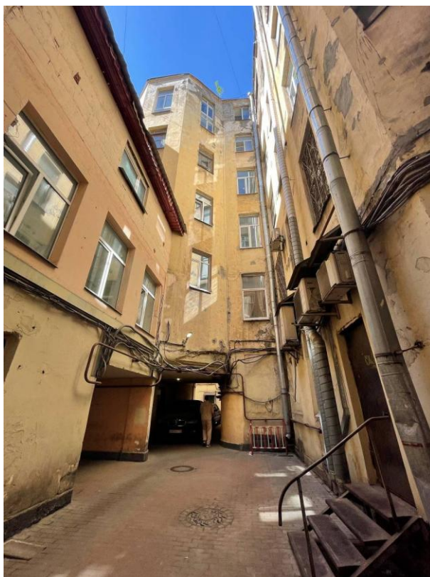
Фото 12. Фрагмент дворового фасада выявленного объекта культурного наследия «Дом Ф.Ф. Утемана»
