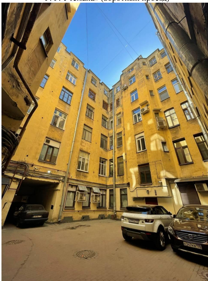
Фото 8. Фрагмент дворового фасада выявленного объекта культурного наследия «Дом Ф.Ф. Утемана»
