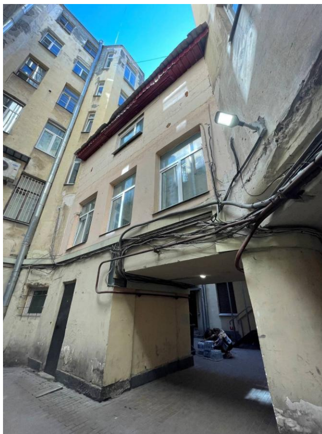
Фото 13. Фрагмент дворового фасада выявленного объекта культурного наследия «Дом Ф.Ф. Утемана»
