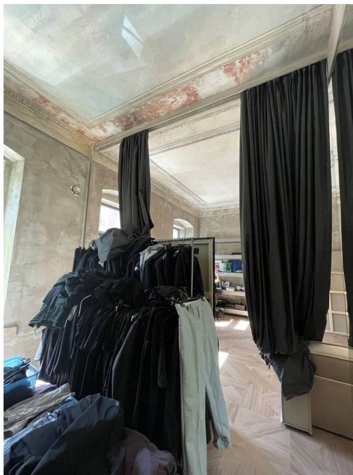
Фото 28. Интерьер квартиры № 65 выявленного объекта культурного наследия «Дом Ф.Ф. Утемана»
