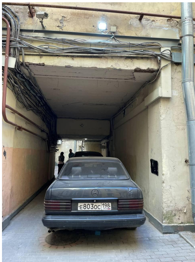
Фото 11. Фрагмент дворового фасада выявленного объекта культурного наследия «Дом Ф.Ф. Утемана»
