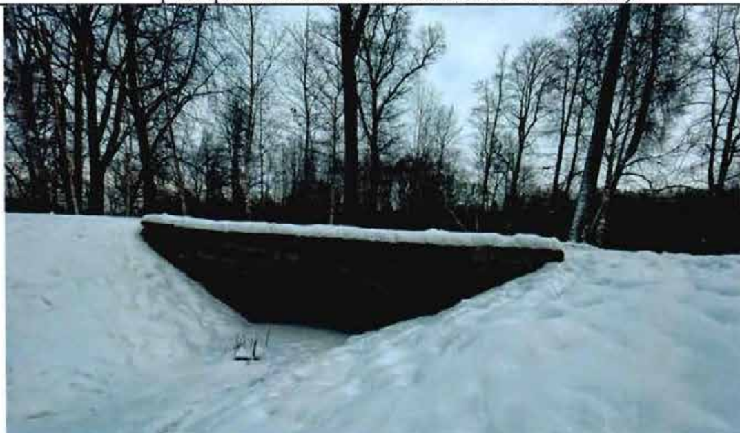
3. Общий вид фасада моста.
