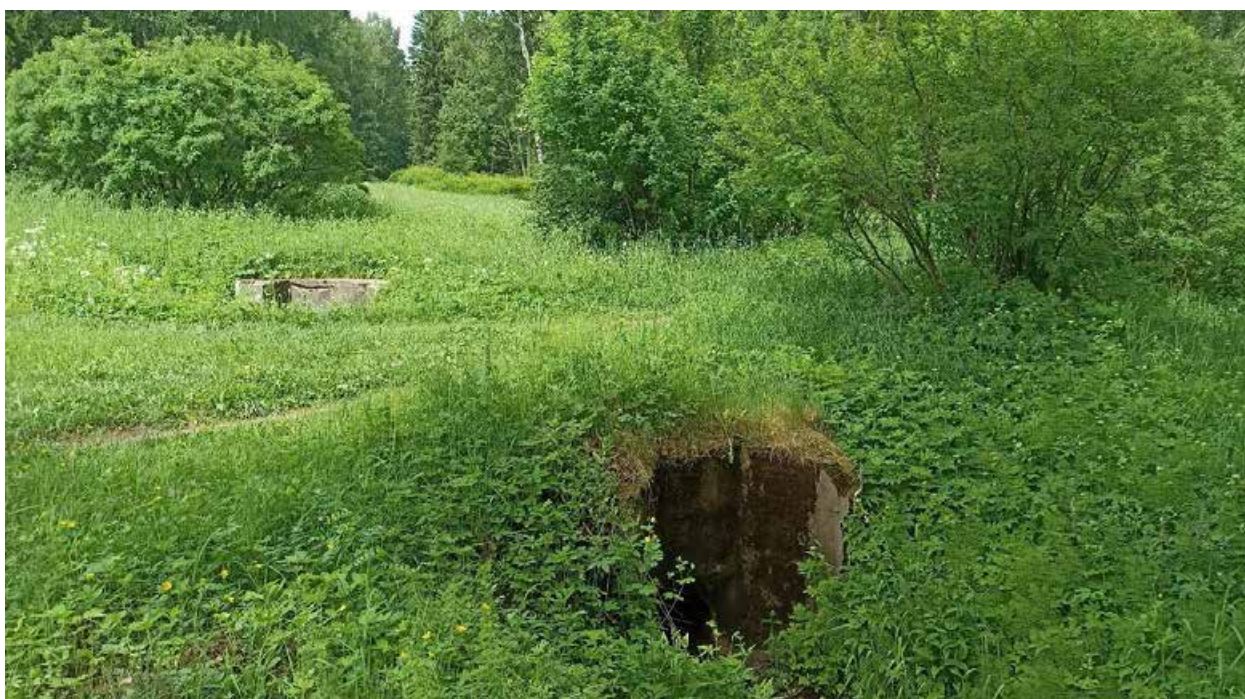
46. Объект культурного наследия федерального значения «Водовод Павловский (часть Таицкого)», входящий в состав объекта культурного наследия федерального значения «Павловский дворцово-парковый ансамбль», расположенный в г. Пушкин, от 5 Нижнего пруда по ул. Набережной до района Большой Звезды Павловского парка. Дата съемки: 15.07.2024г.
