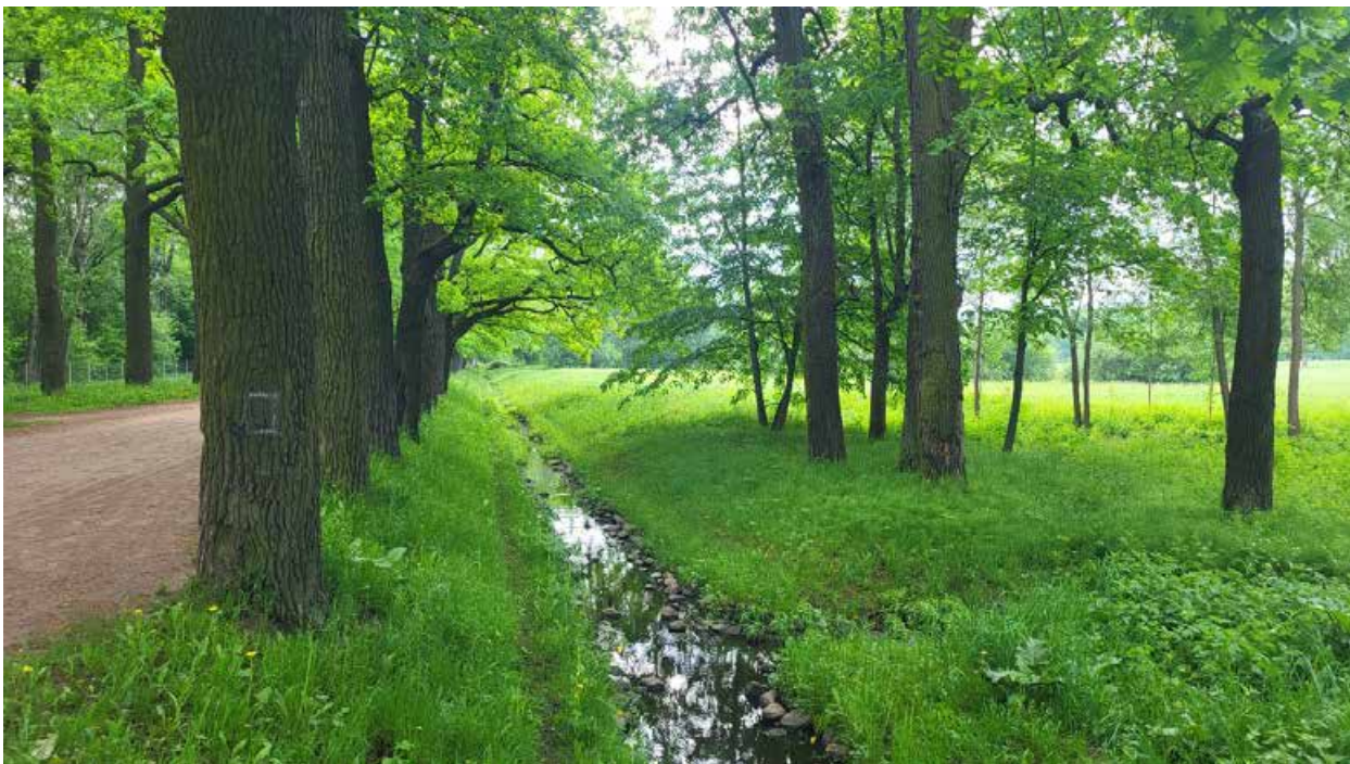
11. Объект культурного наследия федерального значения «Водовод Павловский (часть Таицкого)», входящий в состав объекта культурного наследия федерального значения «Отдельный парк», расположенный в г. Пушкин, от 5 Нижнего пруда по ул. Набережной до района Большой Звезды Павловского парка. Дата съемки: 15.07.2024г.
