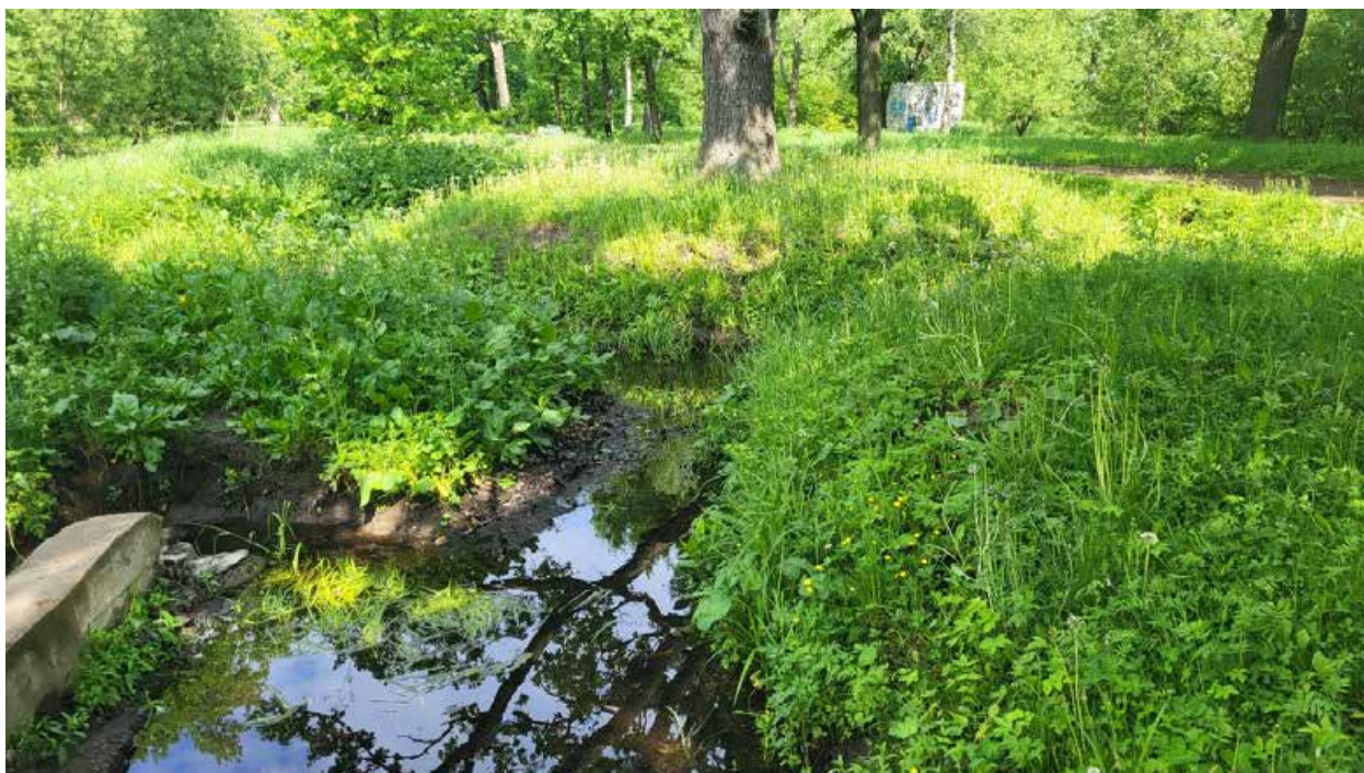
29. Объект культурного наследия федерального значения «Водовод Павловский (часть Таицкого)», входящий в состав объекта культурного наследия федерального значения «Отдельный парк», расположенный в г. Пушкин, от 5 Нижнего пруда по ул. Набережной до района Большой Звезды Павловского парка. Дата съемки: 15.07.2024г.
