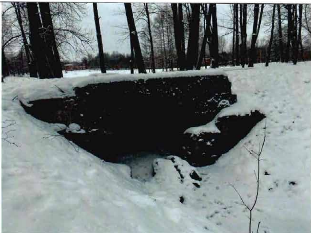
6. Общий вид фасада моста.
