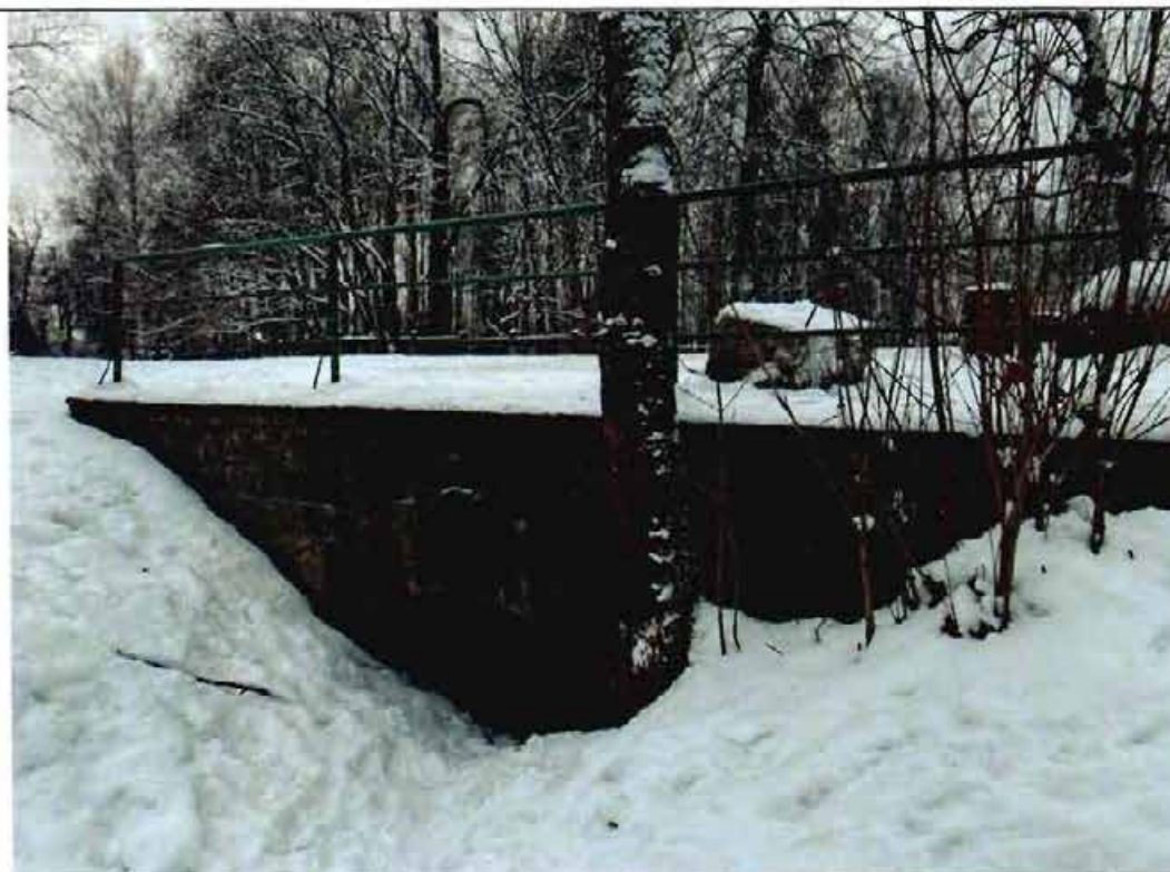
1. Общий вид восточной части моста с металлическим ограждением.
