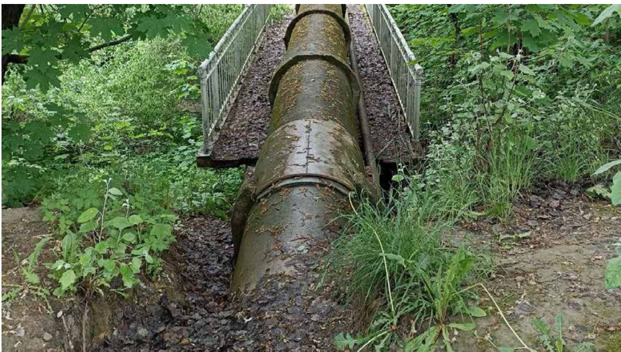
34. Акведук, часть объекта культурного наследия федерального значения «Водовод Павловский (часть Таицкого)», расположенный в г. Пушкин, от 5 Нижнего пруда по ул. Набережной до района Большой Звезды Павловского парка. Дата съемки: 15.07.2024г.
