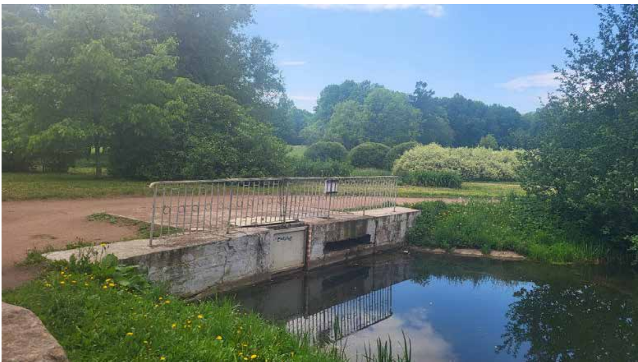
7. Объект культурного наследия федерального значения «Пруд Колонистский с плотиной-распределителем», входящий в состав объекта культурного наследия федерального значения «Отдельный парк», расположенный в г. Пушкин, в центральной части парка. Дата съемки: 15.07.2024г.
