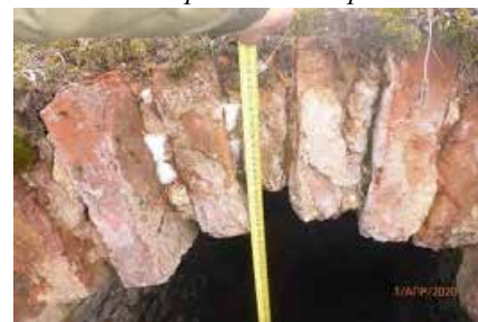
свод кирпичной галереи
