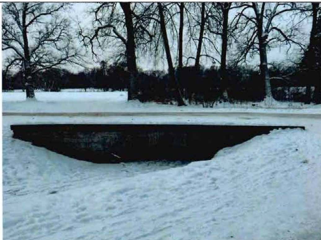
9. Общий вид фасада моста.
