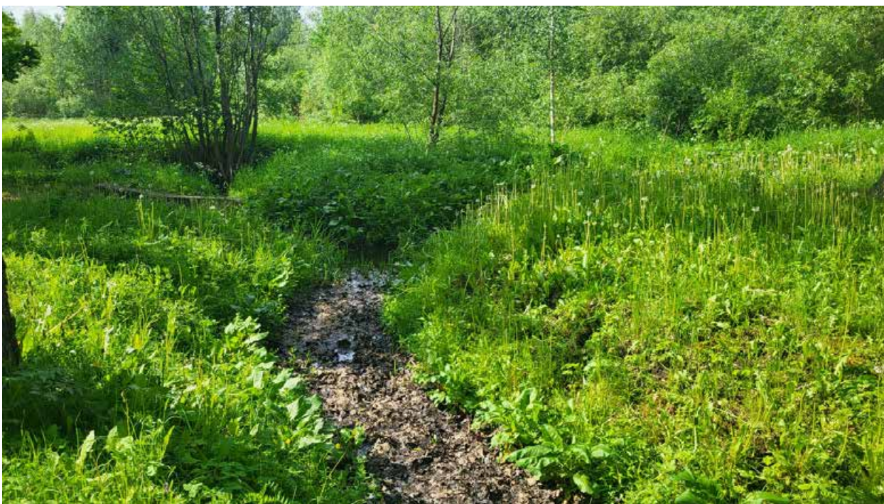
28. Объект культурного наследия федерального значения «Водовод Павловский (часть Таицкого)», входящий в состав объекта культурного наследия федерального значения «Отдельный парк», расположенный в г. Пушкин, от 5 Нижнего пруда по ул. Набережной до района Большой Звезды Павловского парка. Дата съемки: 15.07.2024г.
