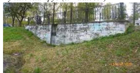
Водосливная плотина на пруду
