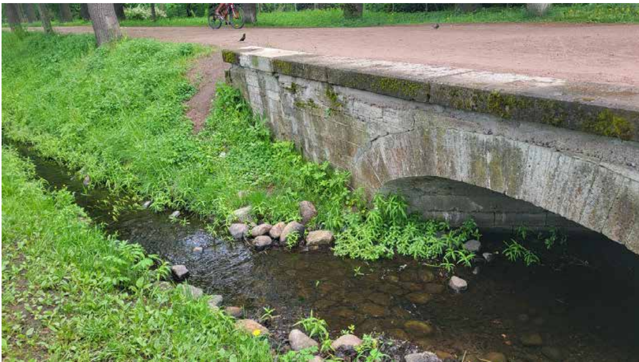
17. Объект культурного наследия федерального значения «Водовод Павловский (часть Таицкого)», входящий в состав объекта культурного наследия федерального значения «Отдельный парк», расположенный в г. Пушкин, от 5 Нижнего пруда по ул. Набережной до района Большой Звезды Павловского парка. Дата съемки: 15.07.2024г.
