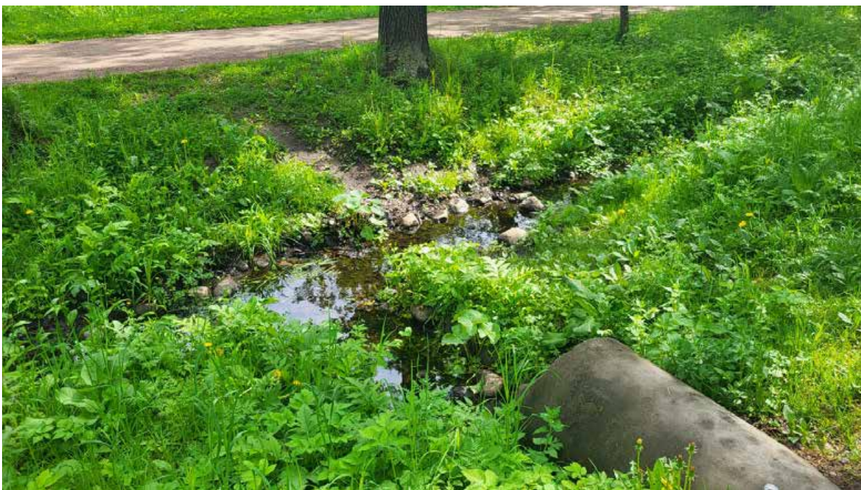
22. Объект культурного наследия федерального значения «Водовод Павловский (часть Таицкого)», входящий в состав объекта культурного наследия федерального значения «Отдельный парк», расположенный в г. Пушкин, от 5 Нижнего пруда по ул. Набережной до района Большой Звезды Павловского парка. Дата съемки: 15.07.2024г.
