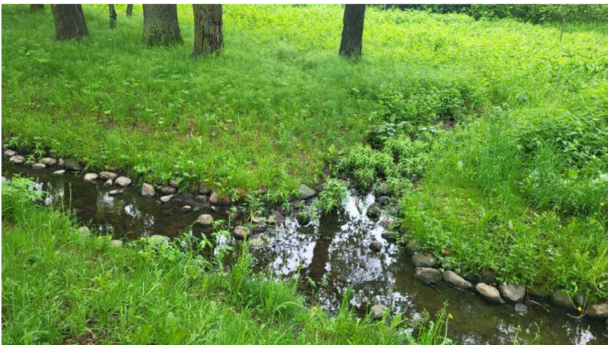
12. Объект культурного наследия федерального значения «Водовод Павловский (часть Таицкого)», входящий в состав объекта культурного наследия федерального значения «Отдельный парк», расположенный в г. Пушкин, от 5 Нижнего пруда по ул. Набережной до района Большой Звезды Павловского парка. Дата съемки: 15.07.2024г.
