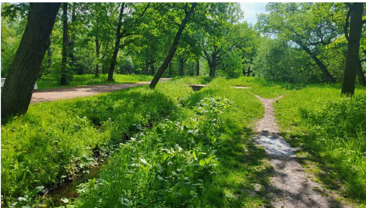
24. Объект культурного наследия федерального значения «Водовод Павловский (часть Таицкого)», входящий в состав объекта культурного наследия федерального значения «Отдельный парк», расположенный в г. Пушкин, от 5 Нижнего пруда по ул. Набережной до района Большой Звезды Павловского парка. Дата съемки: 15.07.2024г.
