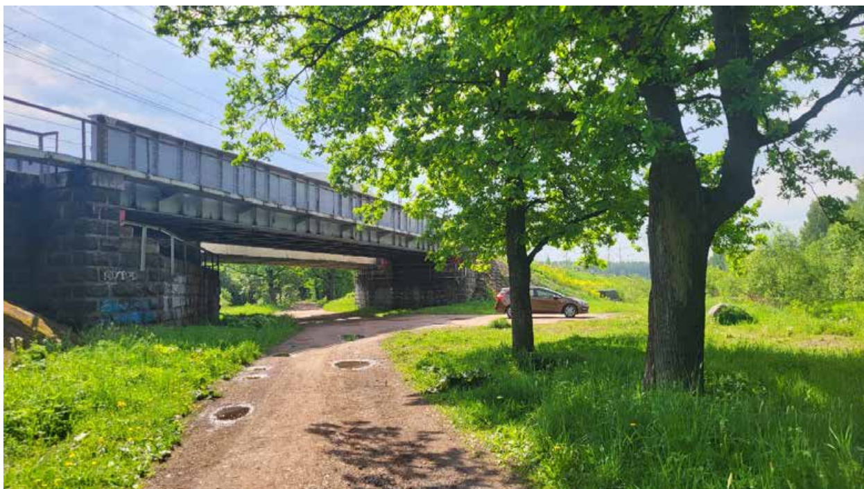
32. Объект культурного наследия федерального значения «Водовод Павловский (часть Таицкого)», входящий в состав объекта культурного наследия федерального значения «Отдельный парк», расположенный в г. Пушкин, от 5 Нижнего пруда по ул. Набережной до района Большой Звезды Павловского парка. Дата съемки: 15.07.2024г.
