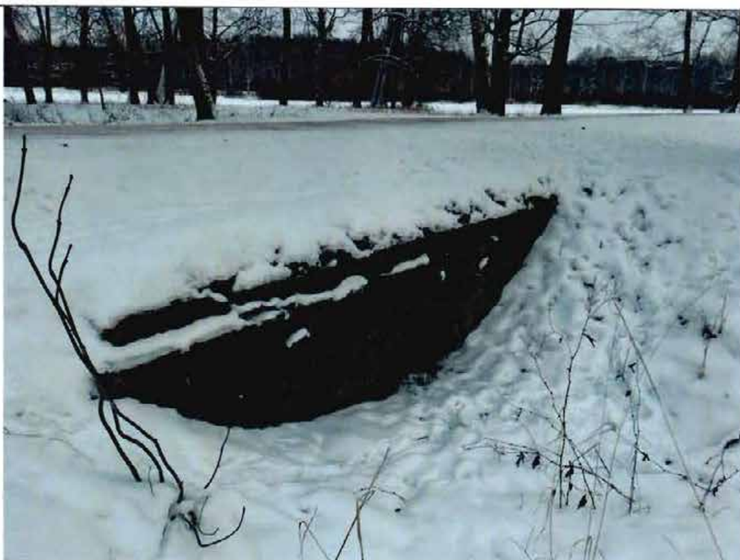
8. Общий вид фасада моста.
