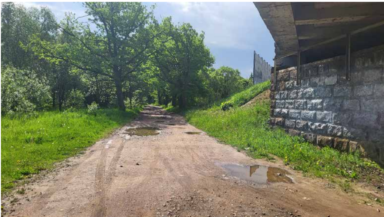
33. Объект культурного наследия федерального значения «Водовод Павловский (часть Таицкого)», входящий в состав объекта культурного наследия федерального значения «Отдельный парк», расположенный в г. Пушкин, от 5 Нижнего пруда по ул. Набережной до района Большой Звезды Павловского парка. Дата съемки: 15.07.2024г.
