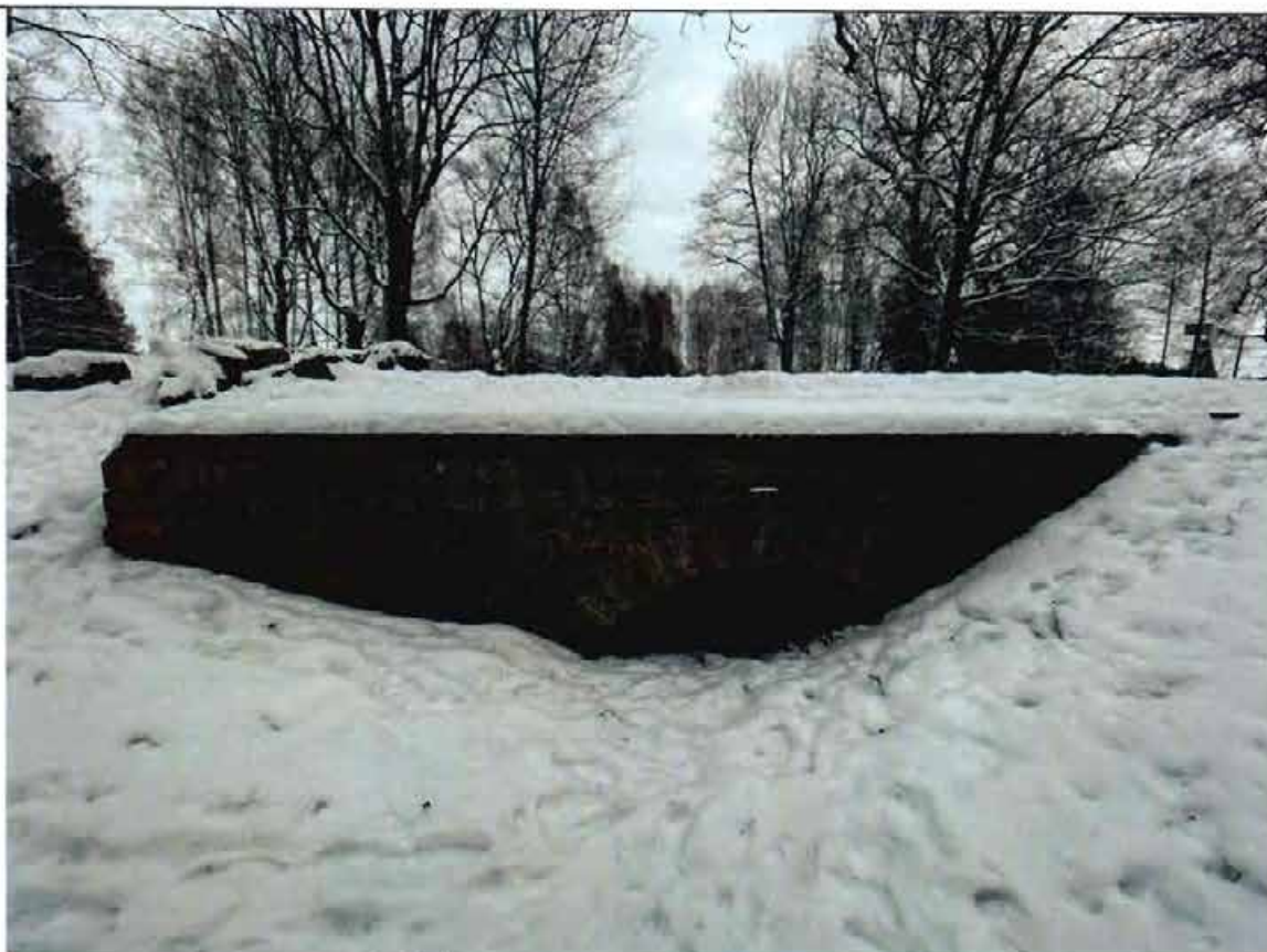
2. Общий вид западной части моста.
