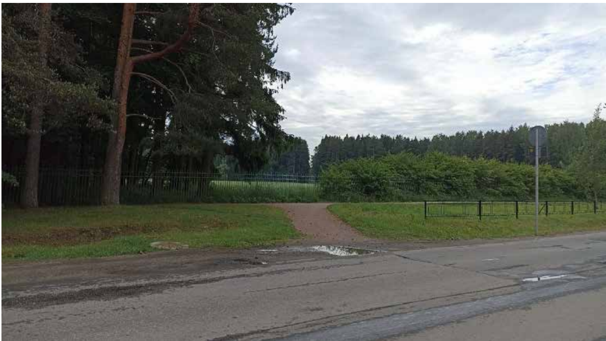
39. Объект культурного наследия федерального значения «Водовод Павловский (часть Таицкого)», входящий в состав объекта культурного наследия федерального значения «Павловский дворцово-парковый ансамбль», расположенный в г. Пушкин, от 5 Нижнего пруда по ул. Набережной до района Большой Звезды Павловского парка. Дата съемки: 15.07.2024г.
