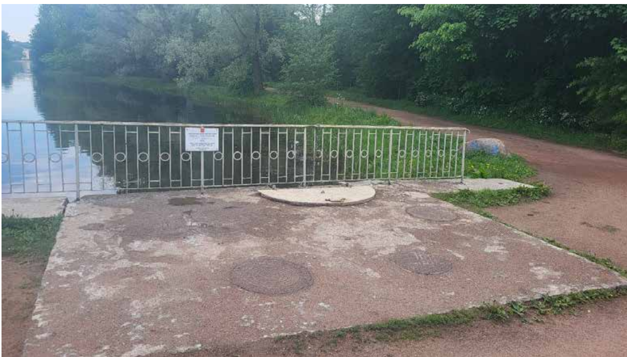
6. Объект культурного наследия федерального значения «Пруд Колонистский с плотинной-распределителем», входящий в состав объекта культурного наследия федерального значения «Отдельный парк», расположенный в г. Пушкин, в центральной части парка. Дата съемки: 15.07.2024г.
