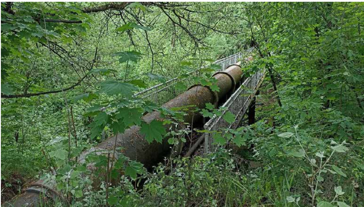
35. Акведук, часть объекта культурного наследия федерального значения «Водовод Павловский (часть Таицкого)», расположенный в г. Пушкин, от 5 Нижнего пруда по ул. Набережной до района Большой Звезды Павловского парка (поселок Тярлево). Дата съемки: 15.07.2024г.
