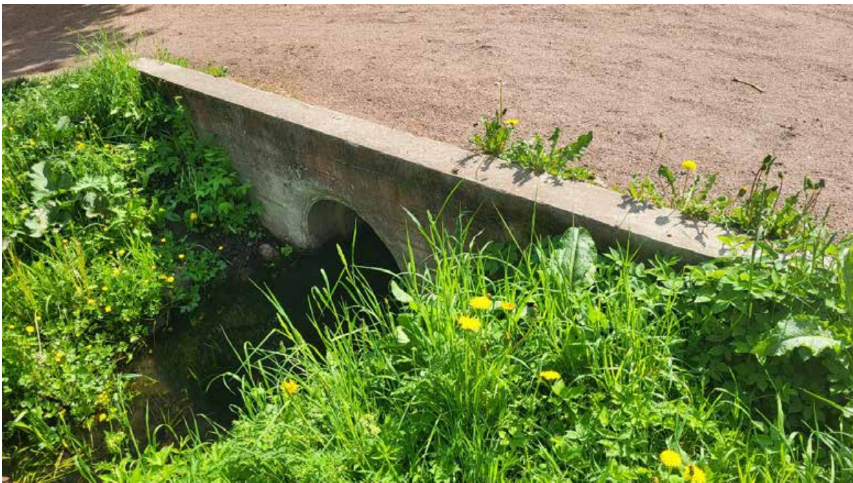
25. Объект культурного наследия федерального значения «Водовод Павловский (часть Таицкого)», входящий в состав объекта культурного наследия федерального значения «Отдельный парк», расположенный в г. Пушкин, от 5 Нижнего пруда по ул. Набережной до района Большой Звезды Павловского парка. Дата съемки: 15.07.2024г.
