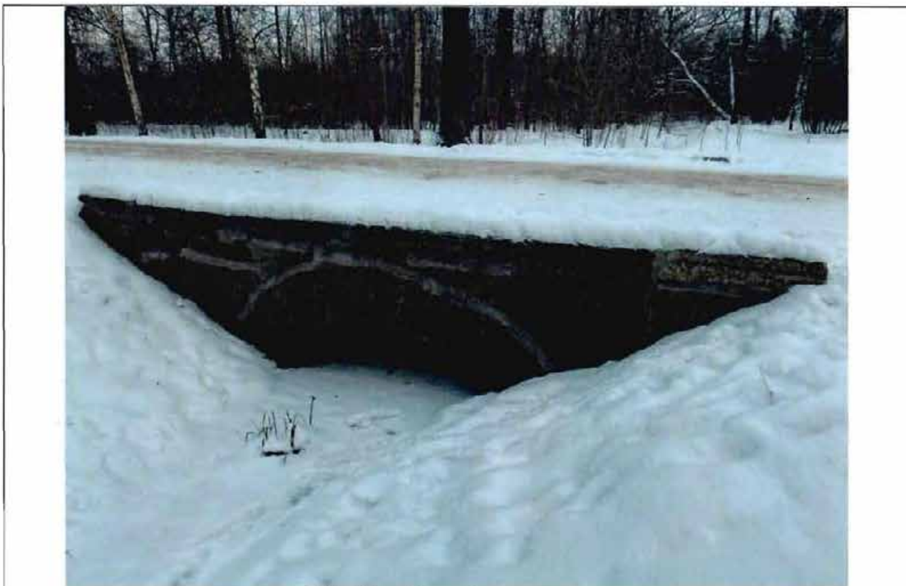
10. Общий вид фасада моста.
