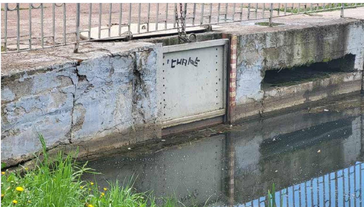
8. Объект культурного наследия федерального значения «Пруд Колонистский с плотиной-распределителем», входящий в состав объекта культурного наследия федерального значения «Отдельный парк», расположенный в г. Пушкин, в центральной части парка. Дата съемки: 15.07.2024г.
